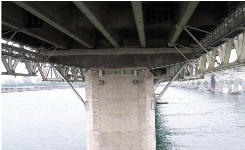
Figure 9 – Système de renfort sur les chevêtres
