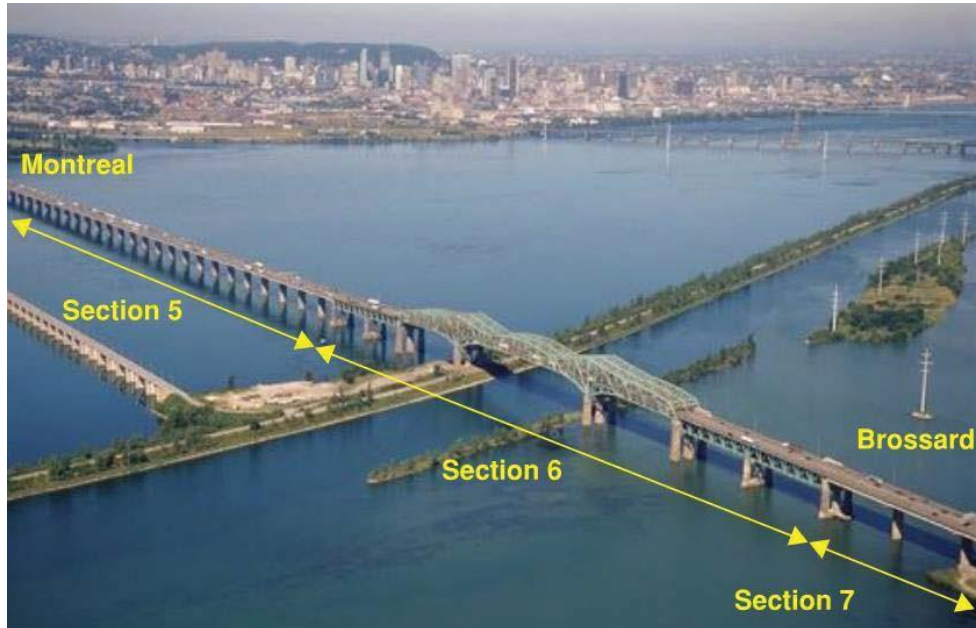
Figure 1 – Vue d'ensemble du pont Champlain
