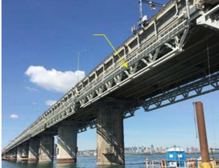
Figure 6 - Treillis modulaires installés sous les poutres de rive en béton
