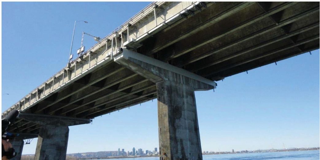
Figure A12 - Travée en béton typique dans les sections 5 & 7
