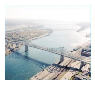
La travée principale, de type cantilever, se trouve à environ 66 mètres au-dessus de la surface du fleuve Saint-Laurent, permettant ainsi le passage des navires qui se dirigent vers le port de Montréal. Quant à la section enjambant la Voie maritime, elle se trouve à peu près à 49 mètres au-dessus de la surface du canal.
