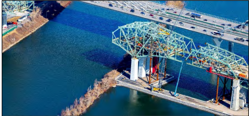
Section d'acier du pont Champlain en déconstruction
