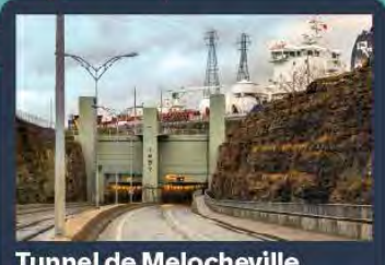
Tunnel de Melocheville
