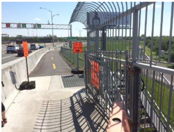
Photo 2.3 : Barrières de l'accès de la rue Saint-Charles
