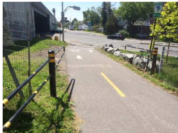
Photo 2.4 : Barrières de l'accès du boulevard Lafayette
