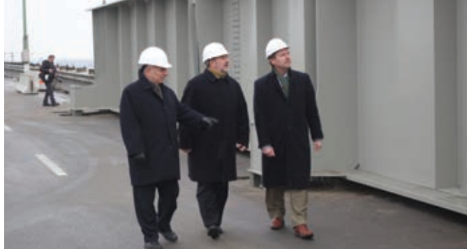
Visite du chantier de la poutre de support du pont Champlain, en novembre 2013, en présence de l'honorable Denis Lebel, ministre de l'Infrastructure, des Collectivités et des Affaires intergouvernementales, et ministre de l'Agence de développement économique du Canada pour les régions du Québec. (De gauche à droite) M. Paul T. Kefalas, Président du conseil d'administration (par intérim), l'honorable Denis Lebel et M. Glen P. Carlin, Premier dirigeant (par intérim).
