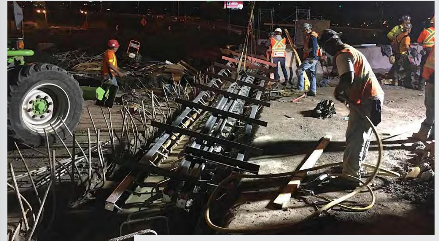
Réfection de viaduc dans une approche du pont Jacques-Cartier, à Longueuil
