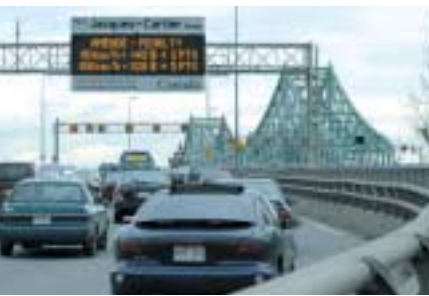
Panneau à message variable à l'entrée du pont Jacques-Cartier
