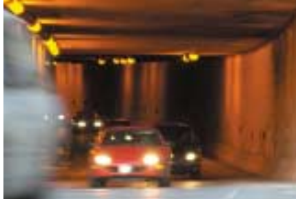
Tunnel de Melocheville
