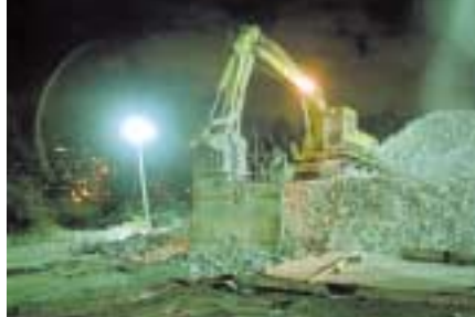
Démolition des vieilles dalles du pont pour leur recyclage en agrégats
