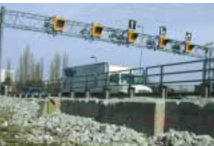
Démolition du trottoir existant pour aménager la piste cyclable
