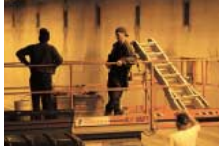
Travaux dans le tunnel de Melocheville
