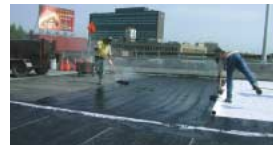
Mise en place de la première couche de bitume
