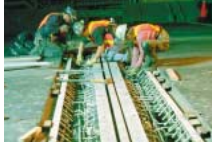
Ajustement d'une section du joint de dilatation à trois modules
