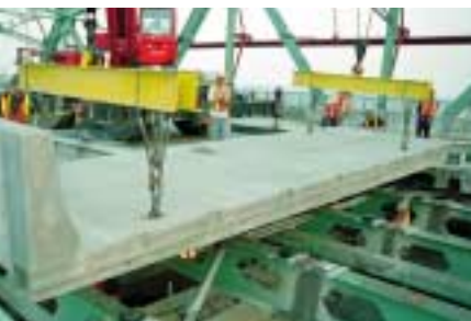
Mise en place d'une dalle de la chaussée
