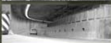
LE TUNNEL DE MELOCHEVILLE
