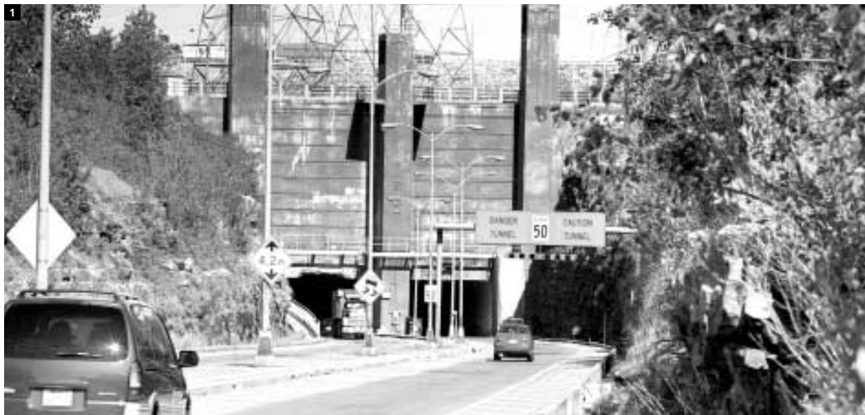
1 Le tunnel de Melocheville
