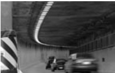
The Melocheville Tunnel
