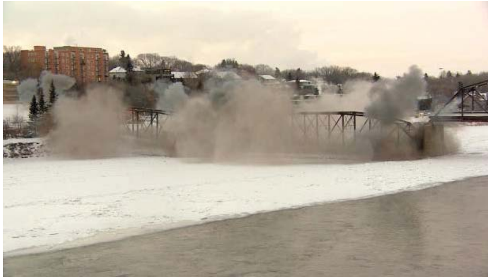
Figure 68 – Démolition du Saskatoon Traffic Bridge sur pont de glace (source : Radio-Canada 2016)
