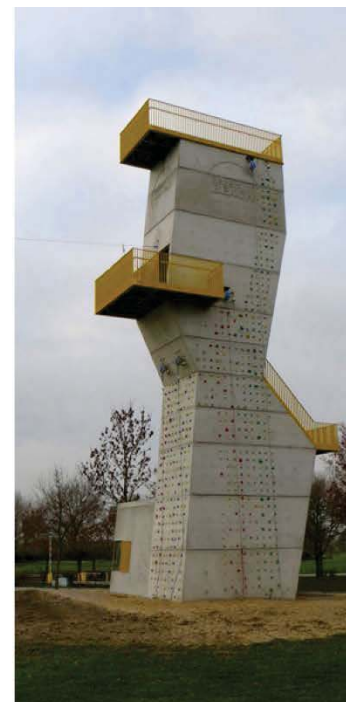
Voies d'escalade et belvédère aménagés sur une structure de béton
