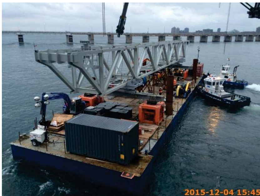
Figure 115 – Barges sectionnelles utilisées pour l'installation des treillis du pont Champlain
