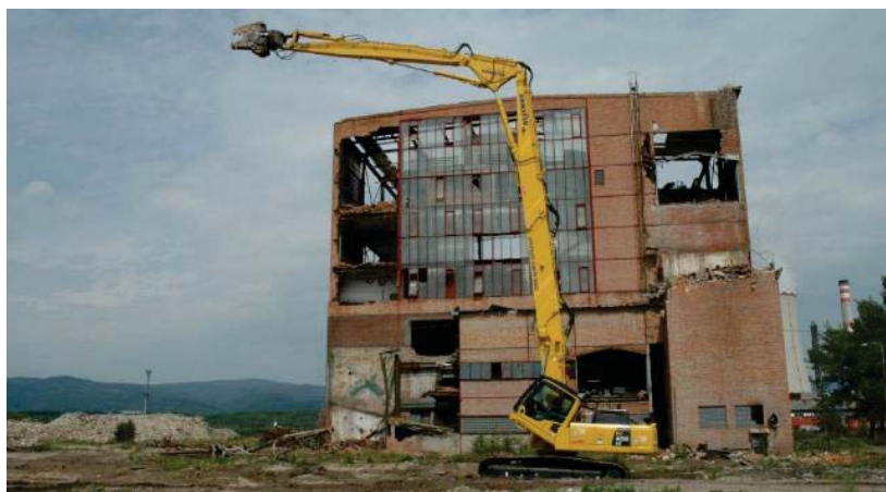
Figure 38 – Brise béton de type cisaille monté sur pelle mécanique avec bras de longue portée (source : Marubeni-Komatsu, 2016)
