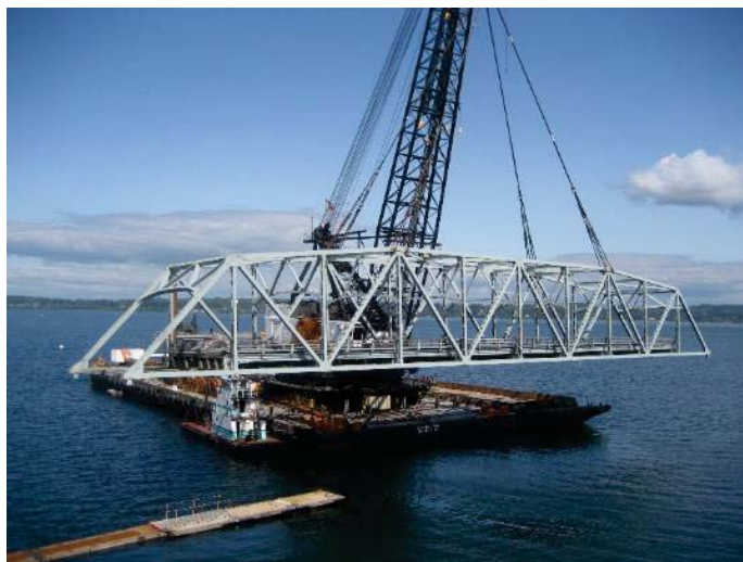
Figure 56 – Déconstruction du pont du Hood Canal (source : avec la permission de Foothills Bridge Co)
