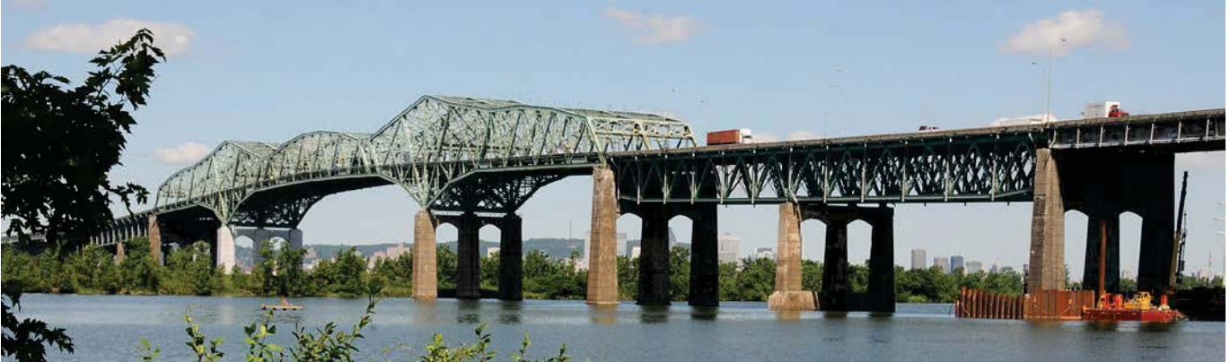
Figure 158 – Section 6 du pont Champlain avec la structure d'acier faite de poutres triangulées (source : TC Media)
