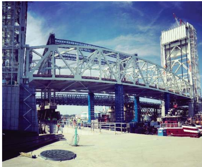
Figure 55 – Système de levage modulaire (source : avec la permission de Burkhalter Rigging)
