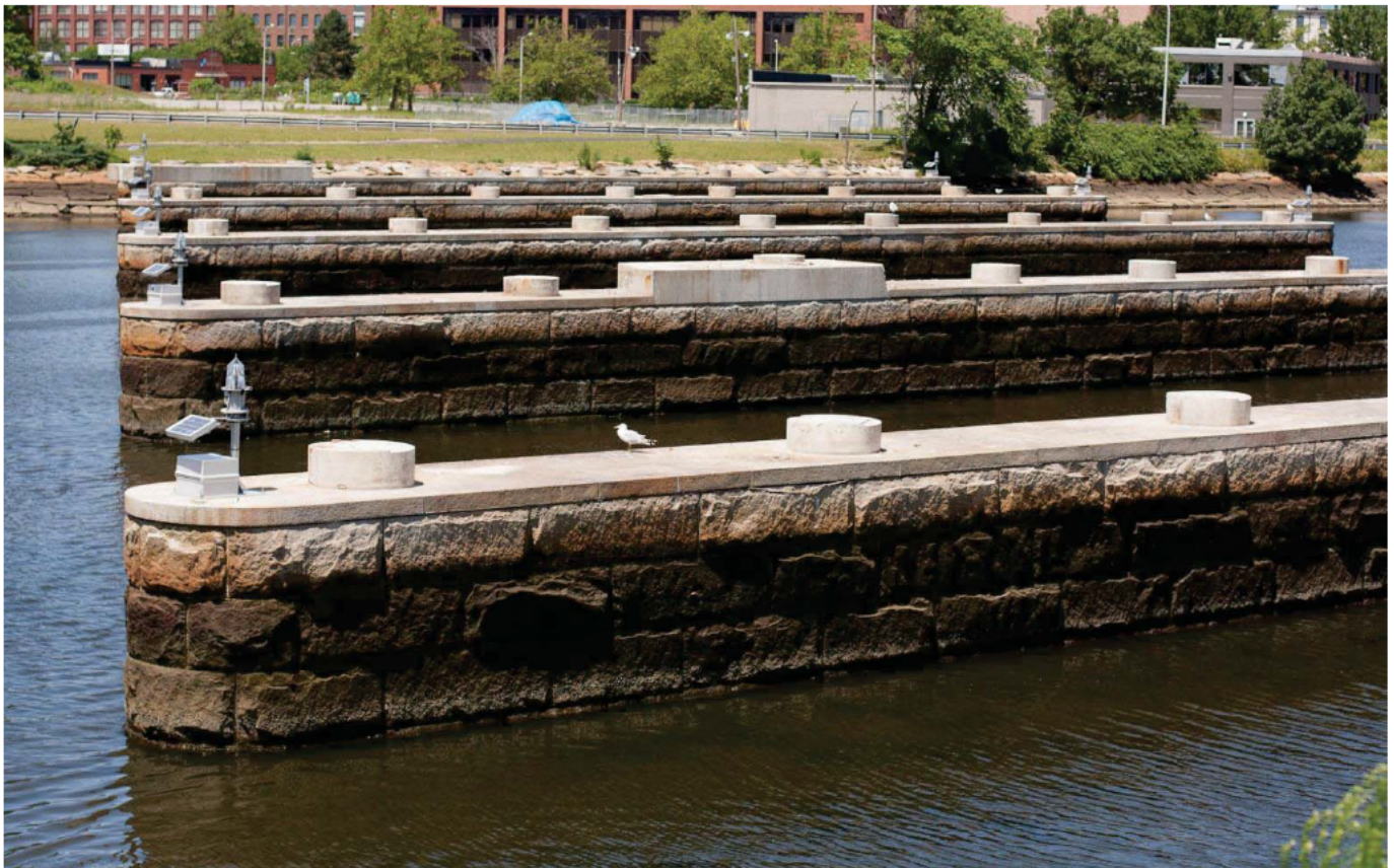
Figure 12 – Détail des piliers existants qui serviront de fondation au nouveau pont piétonnier. Source : City of Providence, 2014
