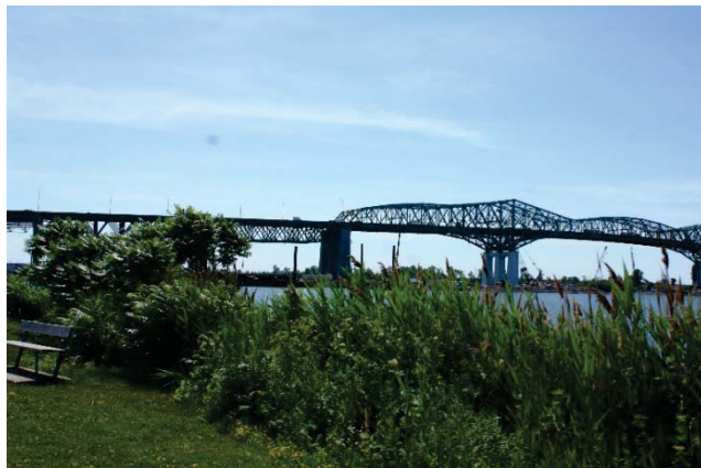
Figure 154 – Végétation en bordure de la piste cyclable de Brossard au nord du pont Champlain (source : [redacted])
