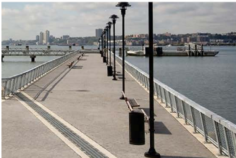
Alignement de fût d’éclairage sur quai minéral
