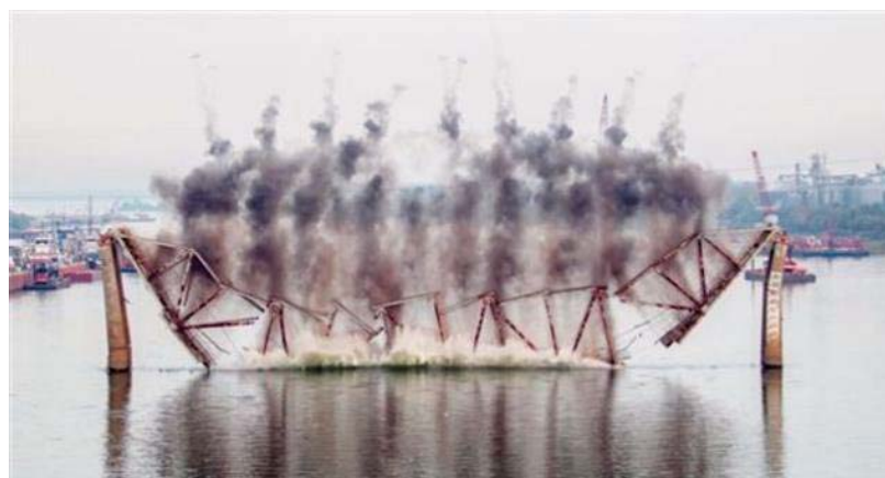
Figure 47 – Démolition à l'explosif du pont Old Ledbetter (source : www.courierpress.com )
