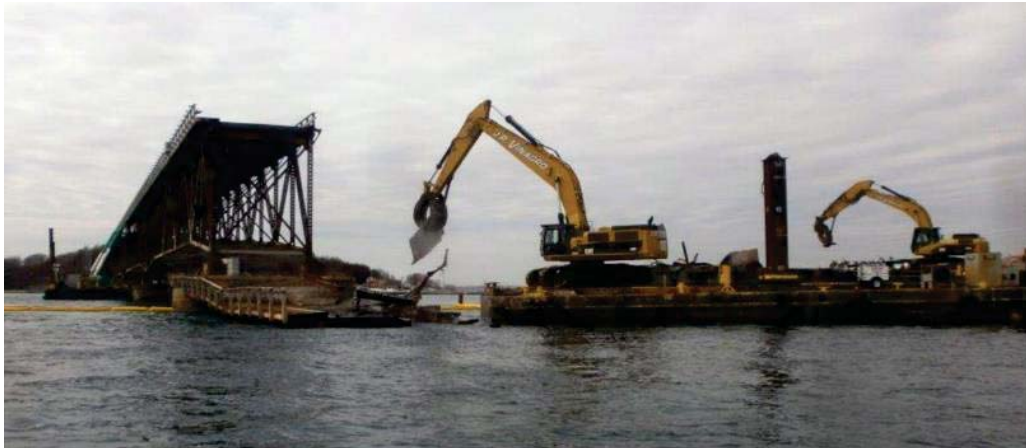
Figure 37 – Travaux de démolition par méthode conventionnelle sur barge pour le pont de Long Island au Boston Harbor (source : Walsh Construction 2016)
