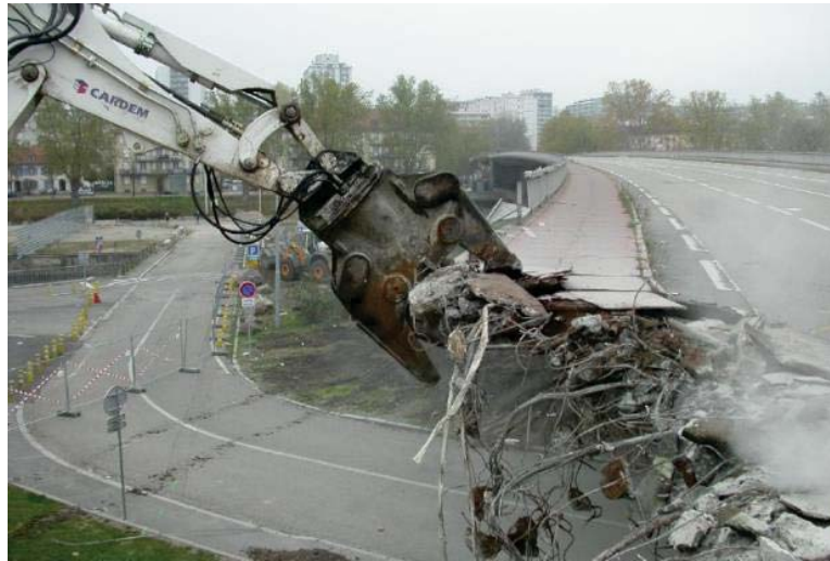
Figure 39 – Démolition de tablier de pont avec brise-béton de type cisaille
