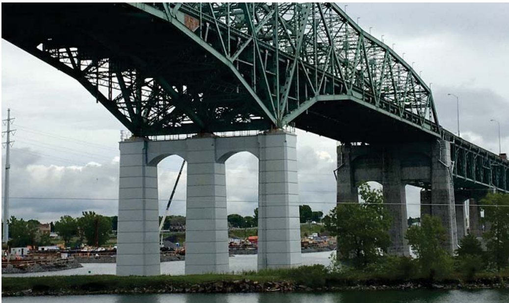
Figure 34 – Section 6 – pile 1E – chemisage en acier
