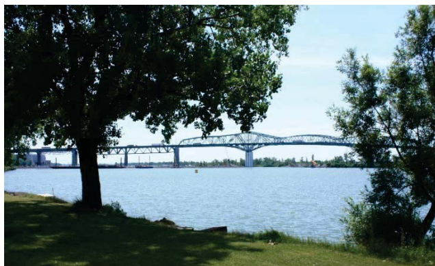
Figure 156 – Fenêtre sur le fleuve à Brossard, au nord du pont Champlain (source : [redacted])
