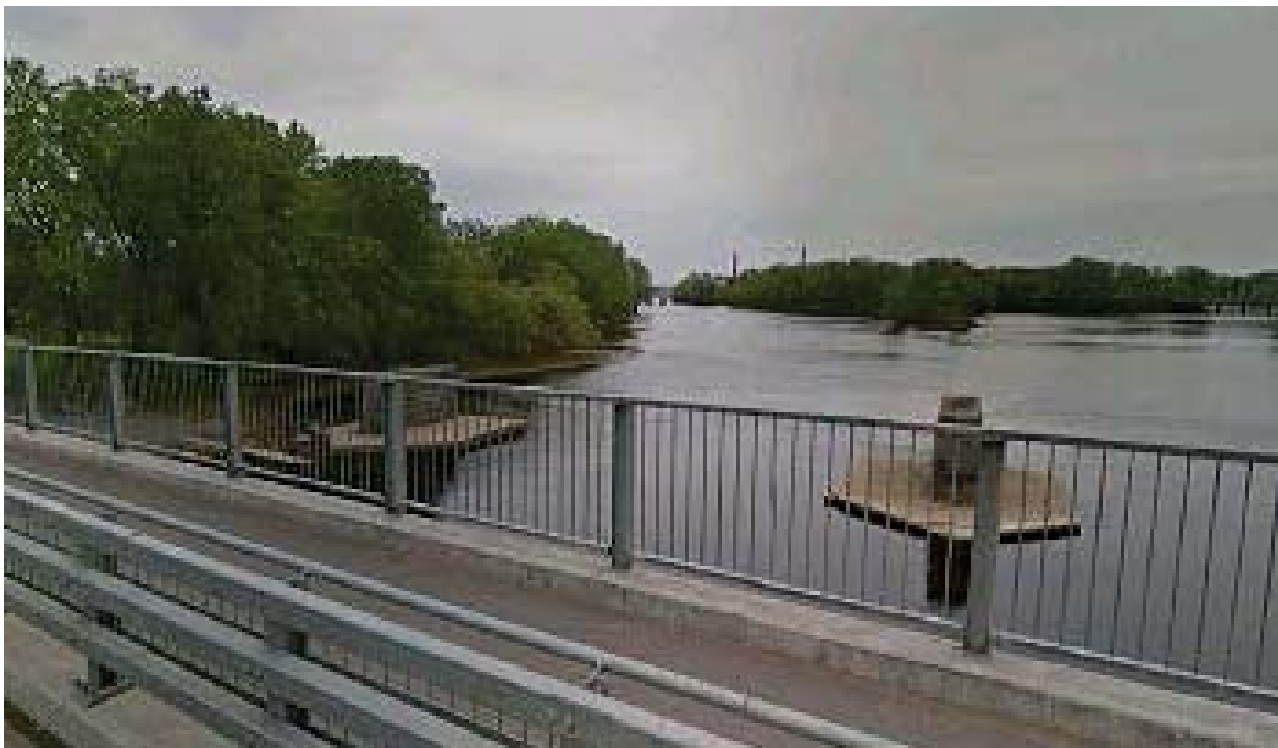
Figure 122 – Éléments de structure abandonnés à Trois-Rivières (source : Google Earth 2016)
