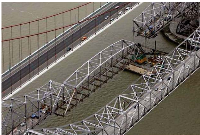
Figure 53 – Descente de la travée suspendue du pont Carquinez (source : avec la permission de Foothills Bridge Co (photo de Jakub Mosur))
