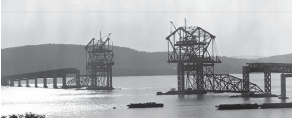
Figure 50 – Construction du pont Tappan Zee par encorbellement (source : avec la permission de la Westchester County Historical Society)
