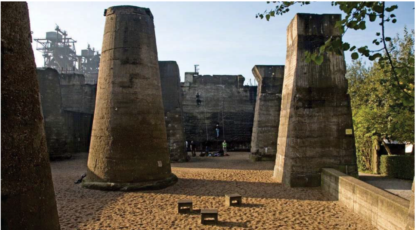
Figure 8 – Mur d'escalade aménagé sur d'anciennes structures de béton. Source : Landezine, 2011
