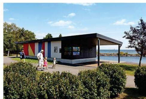
Bâtiment de service
