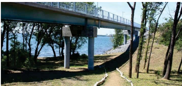
Figure 152 – Sentier informel entre la piste cyclable de la Voie maritime et les berges du fleuve (source : [redacted])
