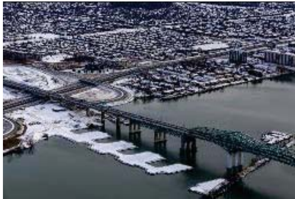
Figure 66 – Jetée côté Brossard – Nouveau pont Champlain (source : nouveauchamplain.ca)
