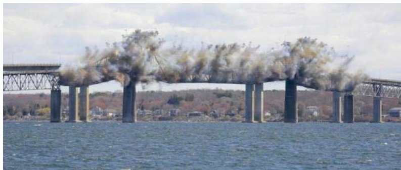
Figure 46 – Démolition du pont Jamestown (source : www.graengs.com )
