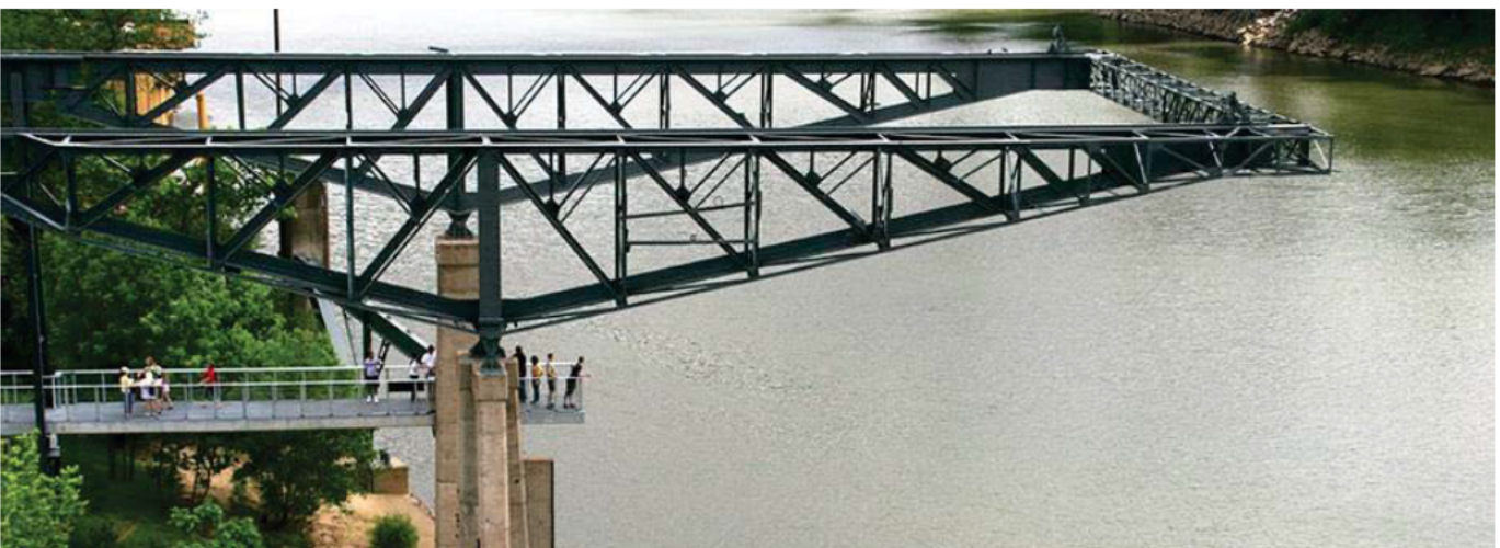
Figure 2 – Passerelle piétonne aménagée sous l'ancien pont roulant. Source : Landezine, 2013
