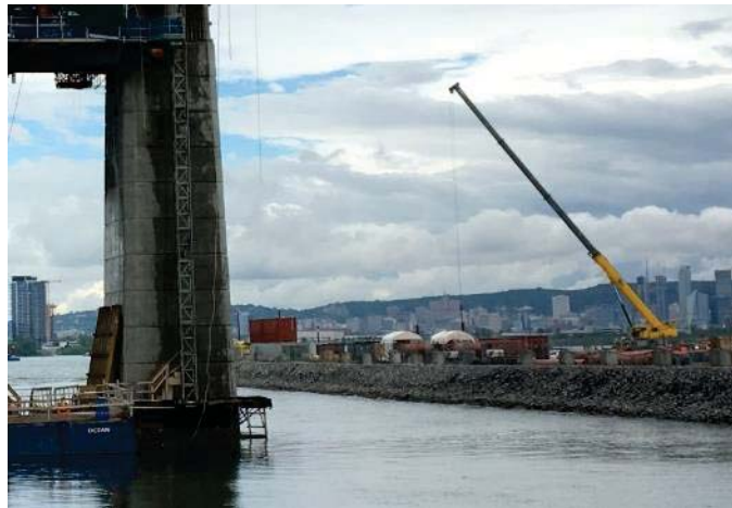
Figure 64 – Vue de jetée pour construction du nouveau pont Champlain à partir de la digue de la Voie maritime (photo prise le 22 juin 2016)
