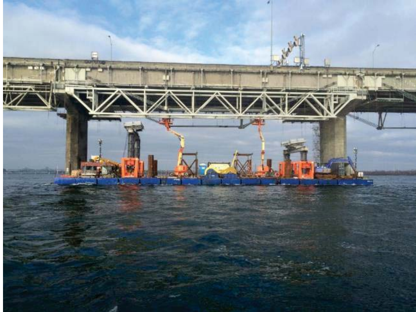
Figure 114 – Barges sectionnelles utilisées pour l'installation des treillis du pont Champlain
