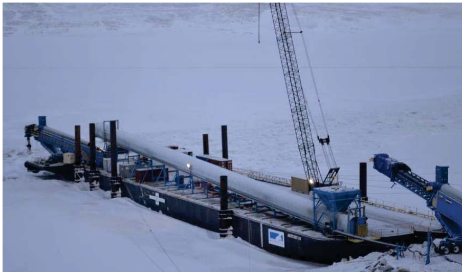
Figure 113 – Barge avec pilier ancré de type Jack-up
