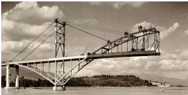
Figure 51 – Construction du pont Port Mann (source : avec la permission du Jewish Museum and Archives of BC)
