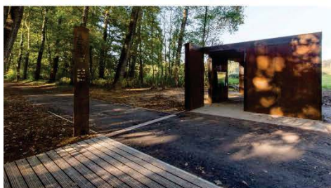
Halte cyclable avec abri et signalétique
