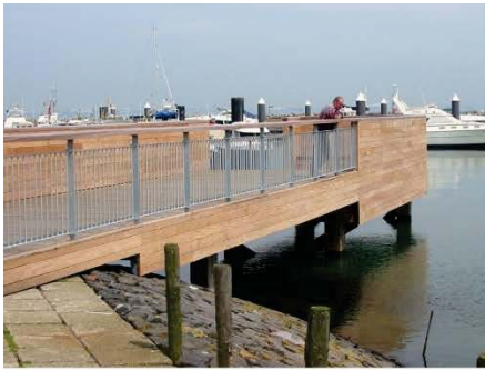
Quai avec garde-corps mixte bois-métal
