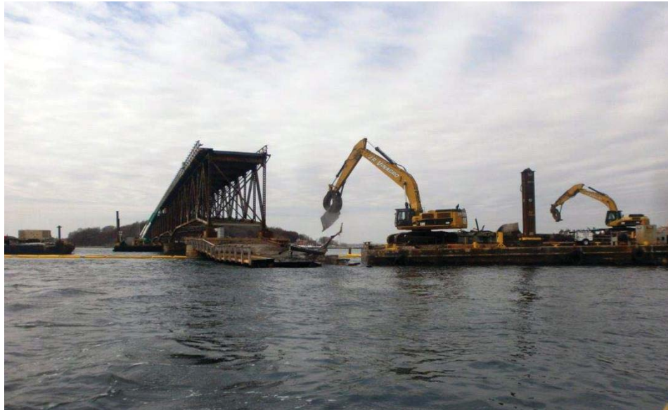
Photo 11 – Travaux de démolition par méthode conventionnelle sur barge pour le pont de Long Island au Boston Harbor
