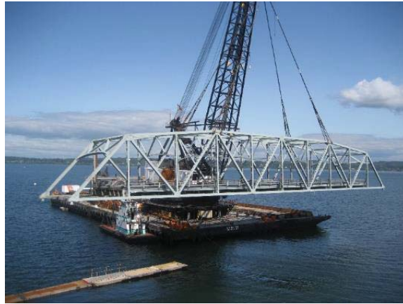
Photo 10 – Déconstruction du pont du Hood Canal
