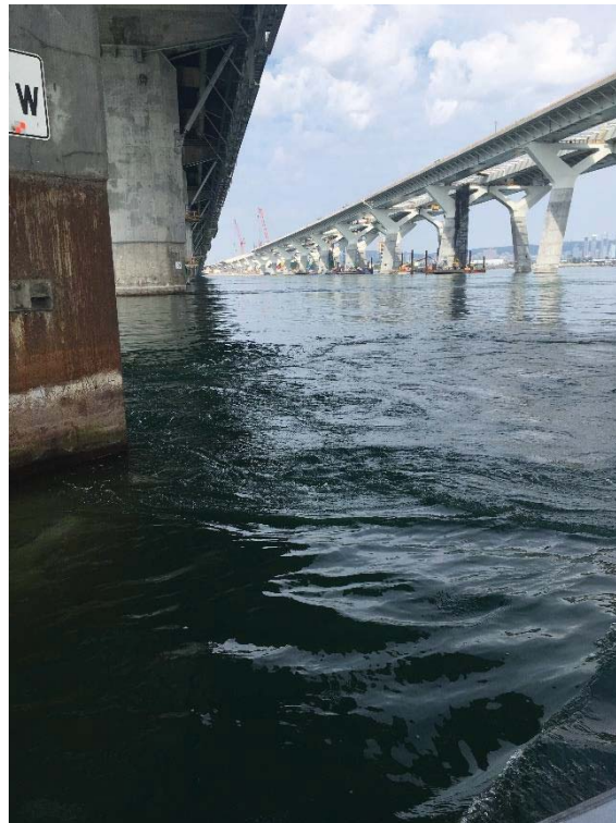
Photo 14 – Turbulence derrière une pile du pont Champlain
