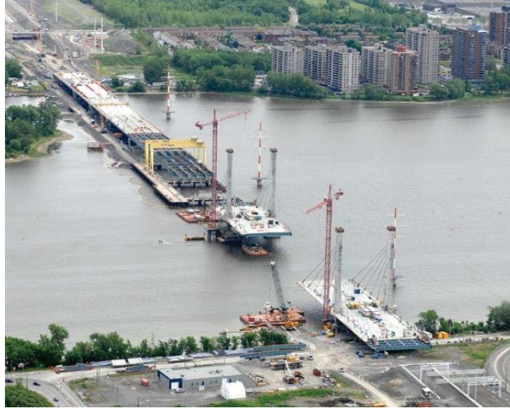
Photo 5 – Pont de l'autoroute 25 : Pont roulant pour les travées d'approche
