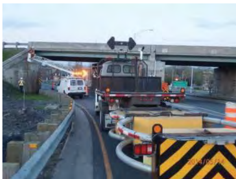
Figure 2 : Exemple d'inspection détaillée, exécutée à l'aide d'équipement de levage
