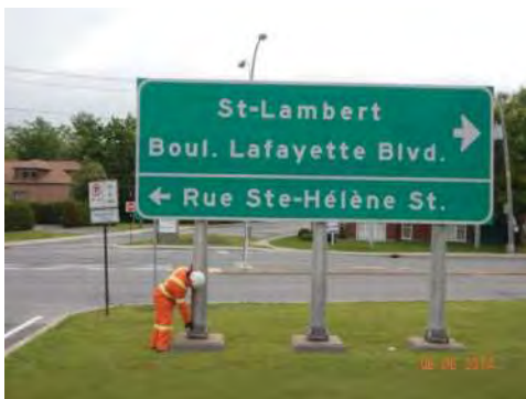
Figure 1 : Exemple d'inspection générale, exécutée à pied à partir du sol
