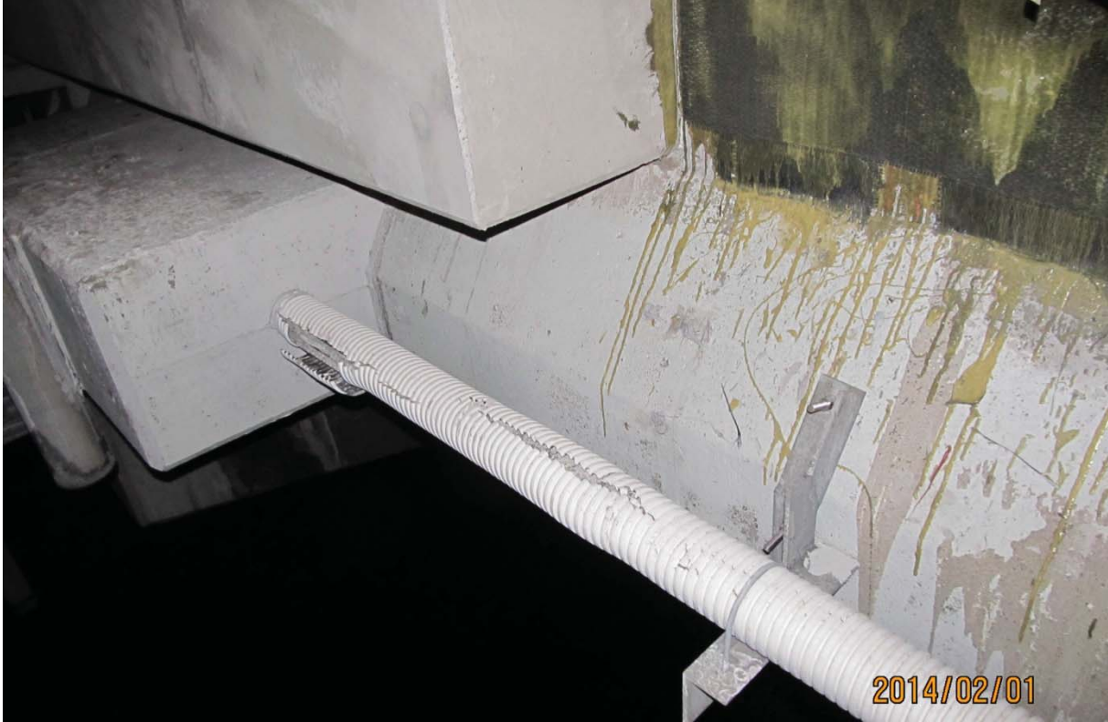
S5.PC.32W-33W.P7.c – 0212 (gaine face amont de la post tension extérieure)
