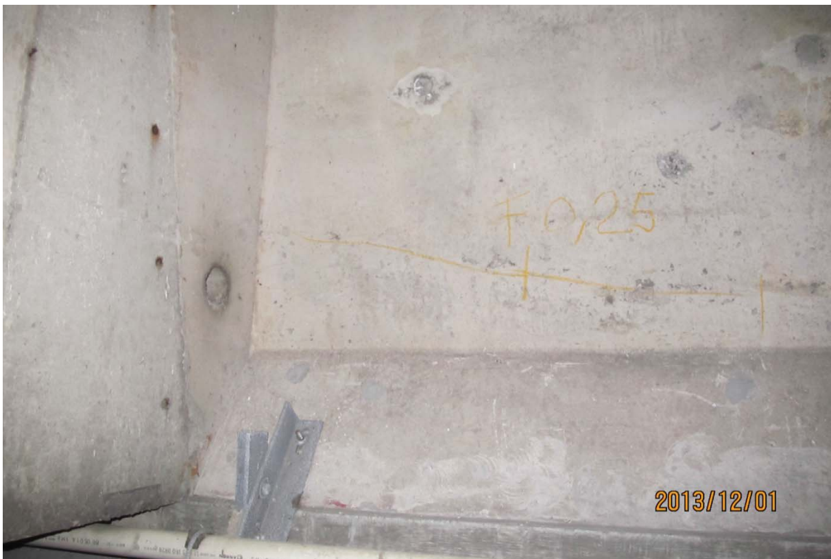
S7.PC.4E-5E.P7.d – 6543 (câble #22 – centre est face aval)
