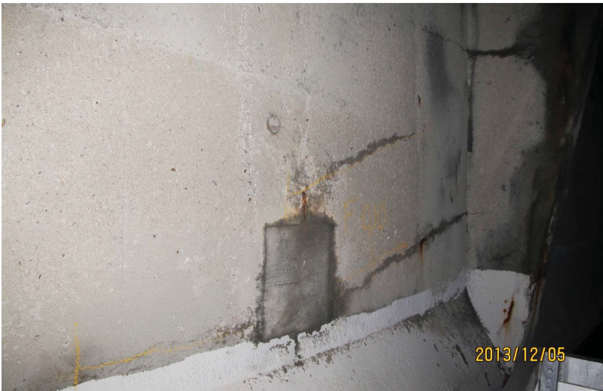
S5.PC.04W-05W.P7.d – 6600 (câbles #22 et #23 – centre est face amont)
