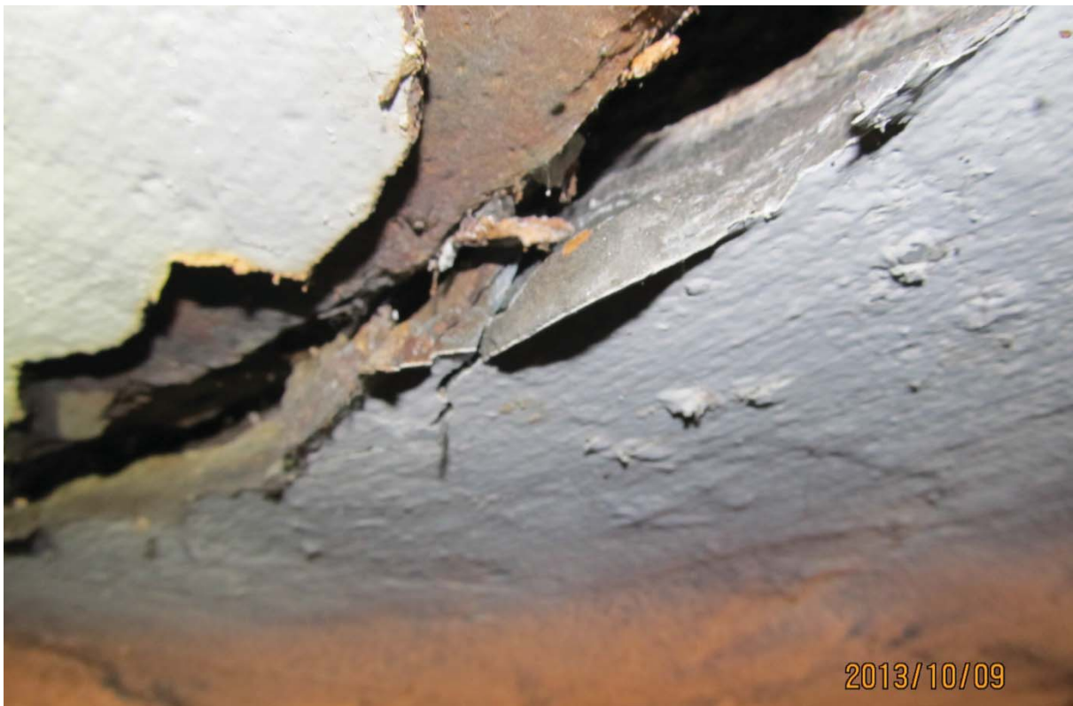
S5.PC.40W-41W.P7.k – 5691 (soffite détail - centre)
