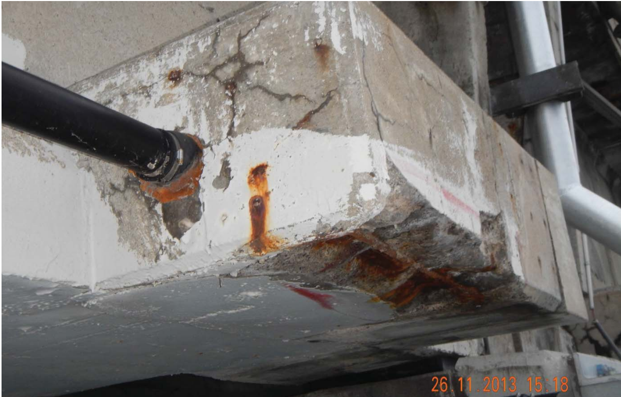
S5.PC.21W-20W.P7.j – 4384 (Bloc d'ancrage extérieur est)
