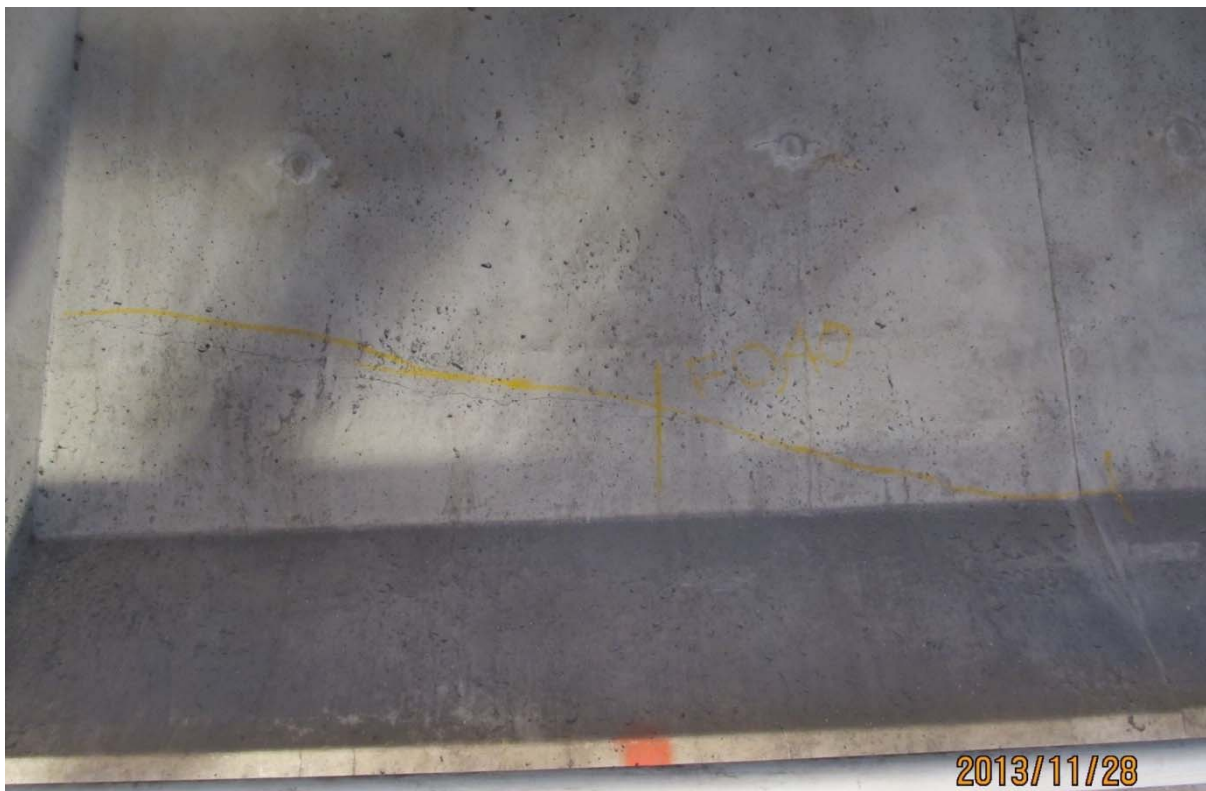
S5.PC.14W-15W.P7.j – 6480 (câble #22 – centre est face aval)
