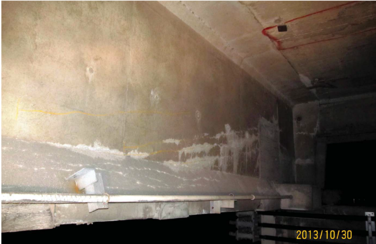
S5.PC.18W-19W.P7.j – 5987 (âme – extrémité ouest face aval)
