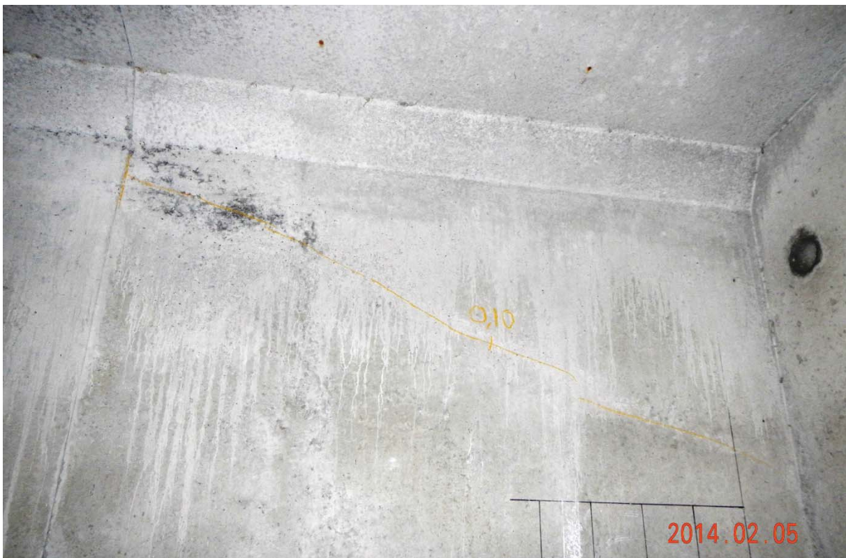
S5.PC.32W-33W.P4.f – 7515 (câble #23 – extrémité est face aval)
