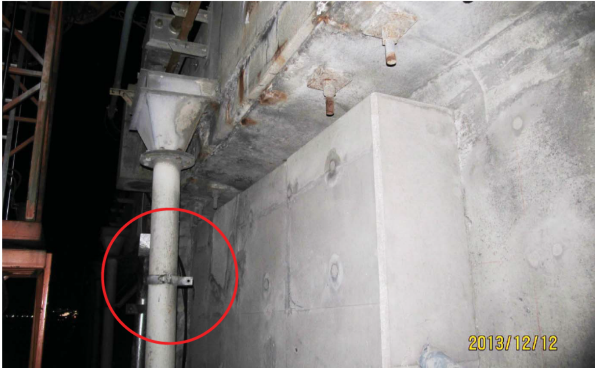
S5.PC.21W-22W.P7.a – 6762 (Drain non-attaché – extrémité ouest face amont)
