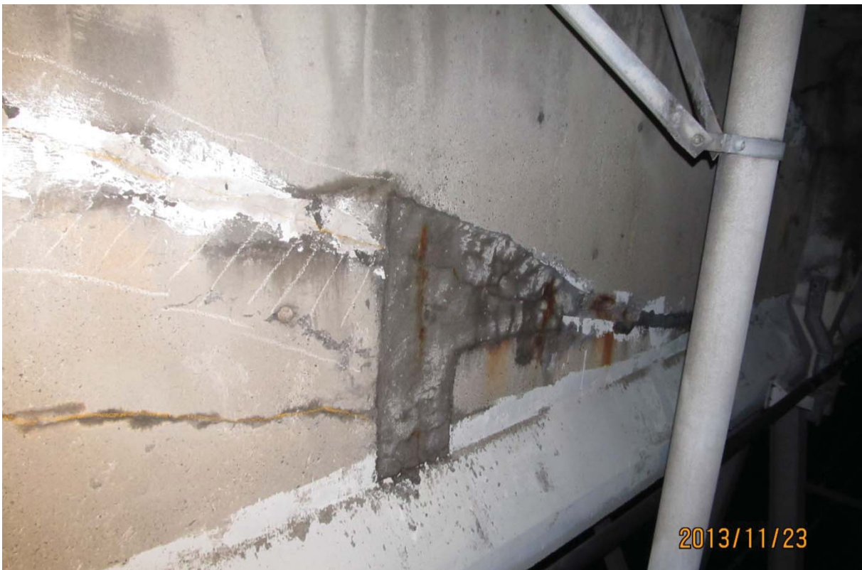
S5.PC.29W-30W.P7.d – 6388 (câbles #19 et #20 – extrémité ouest face amont)
