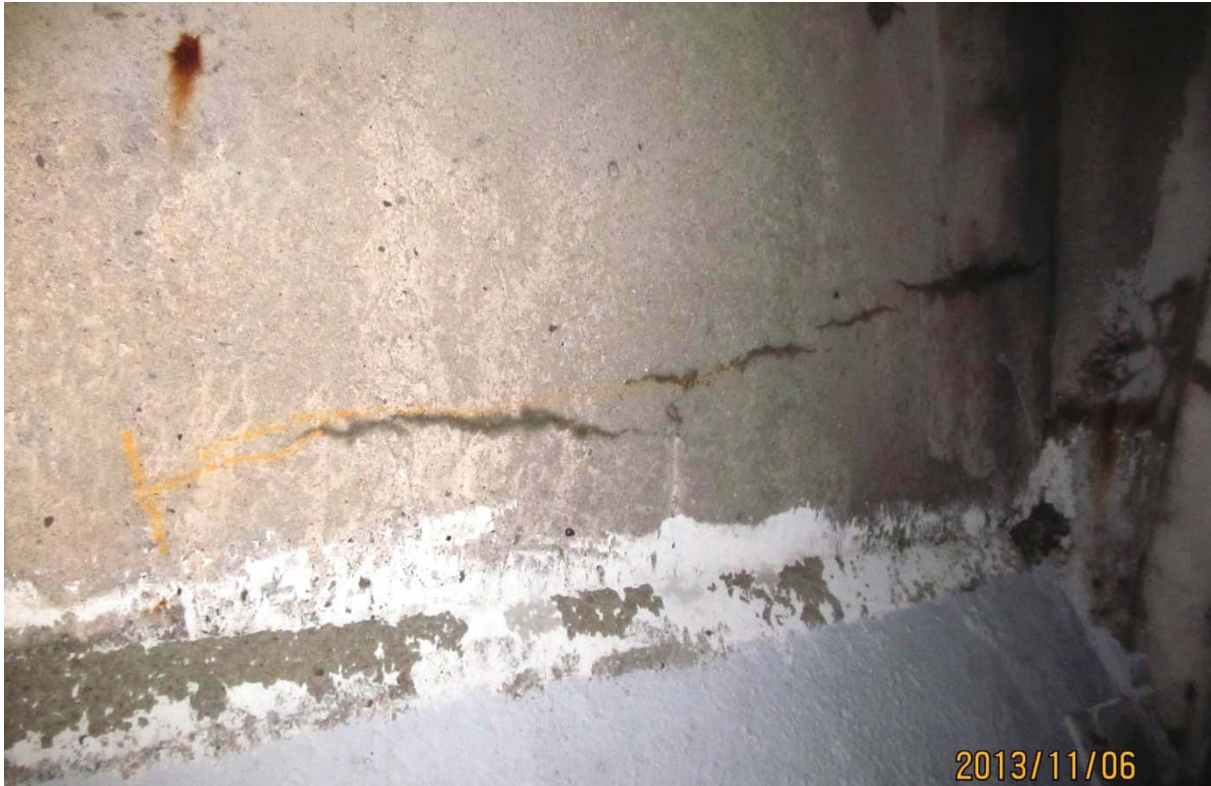
S5.PC.15W-16W.P7.e – 6154 (câble #22 – centre est face amont)
