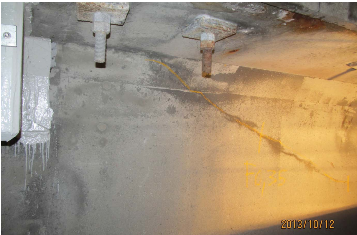
S5.PC.41W-42W.P1.b – 5748 (câble #17 – extrémité est face aval)
