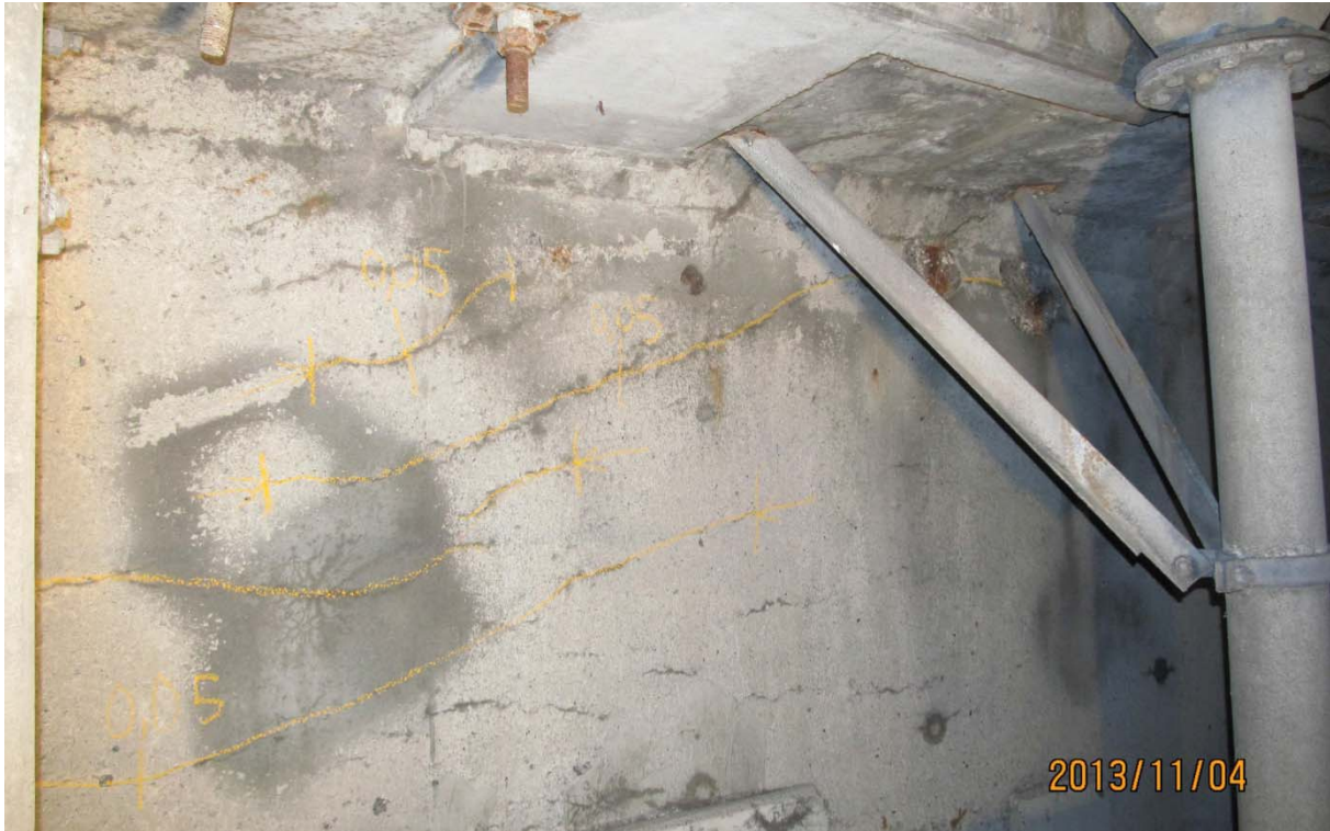
S5.PC.18W-19W.P1.a – 6081 (âme - extrémité est face aval)
