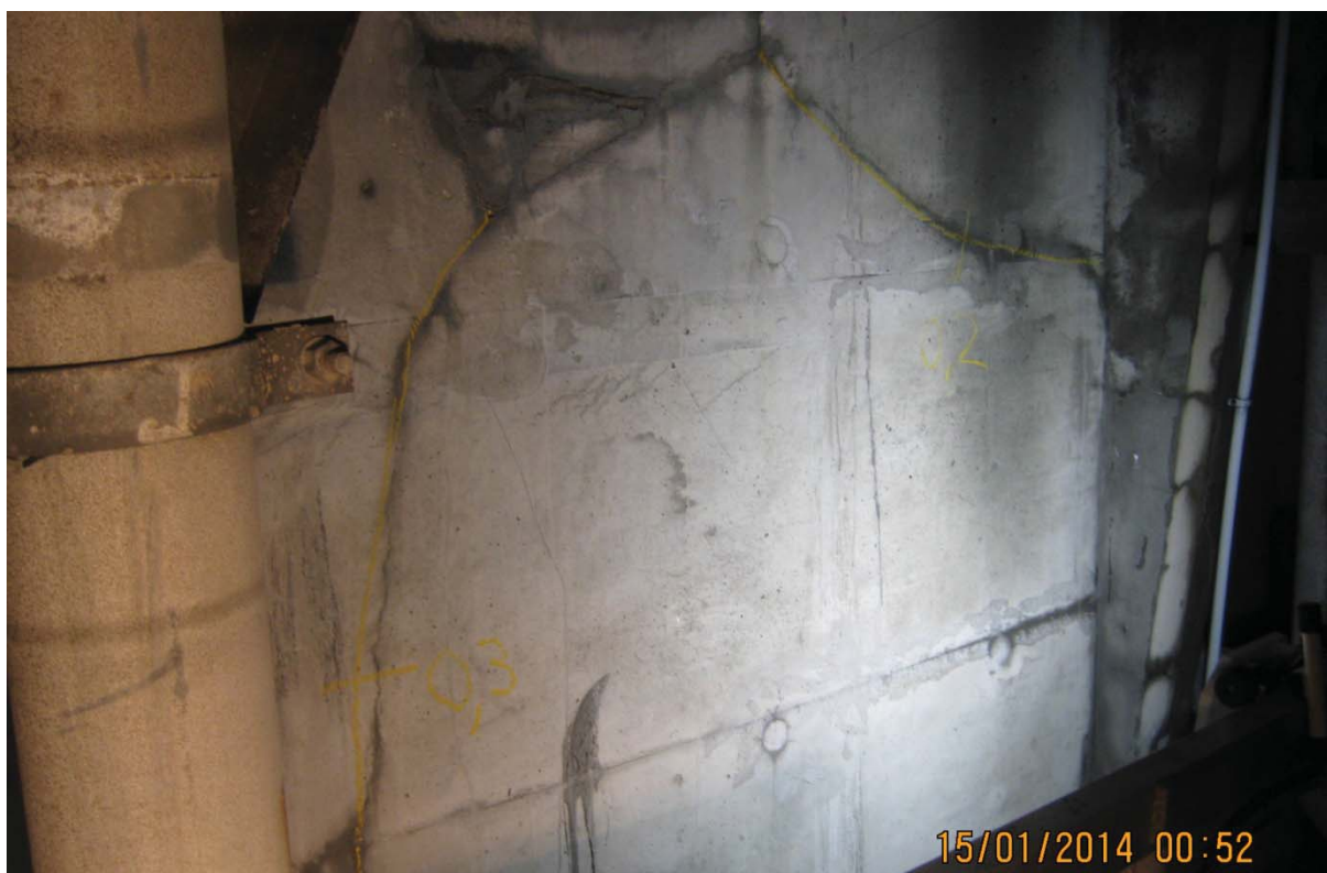
S5.PC.23W-24W.P7.b – 0282 (bloc d'ancrage QP 1.0 extérieur est)
