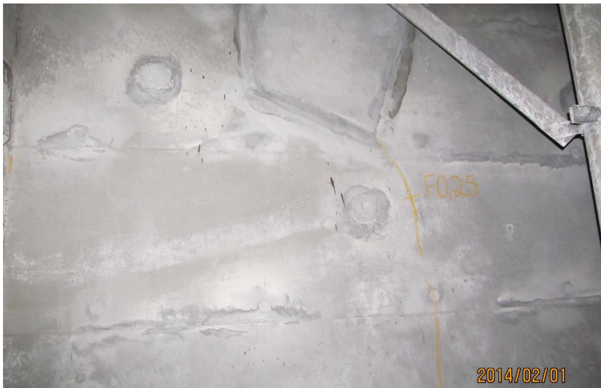
S5.PC.32W-33W.P7.a – 0211 (bloc d'ancrage QP 1.0 extérieur ouest)
