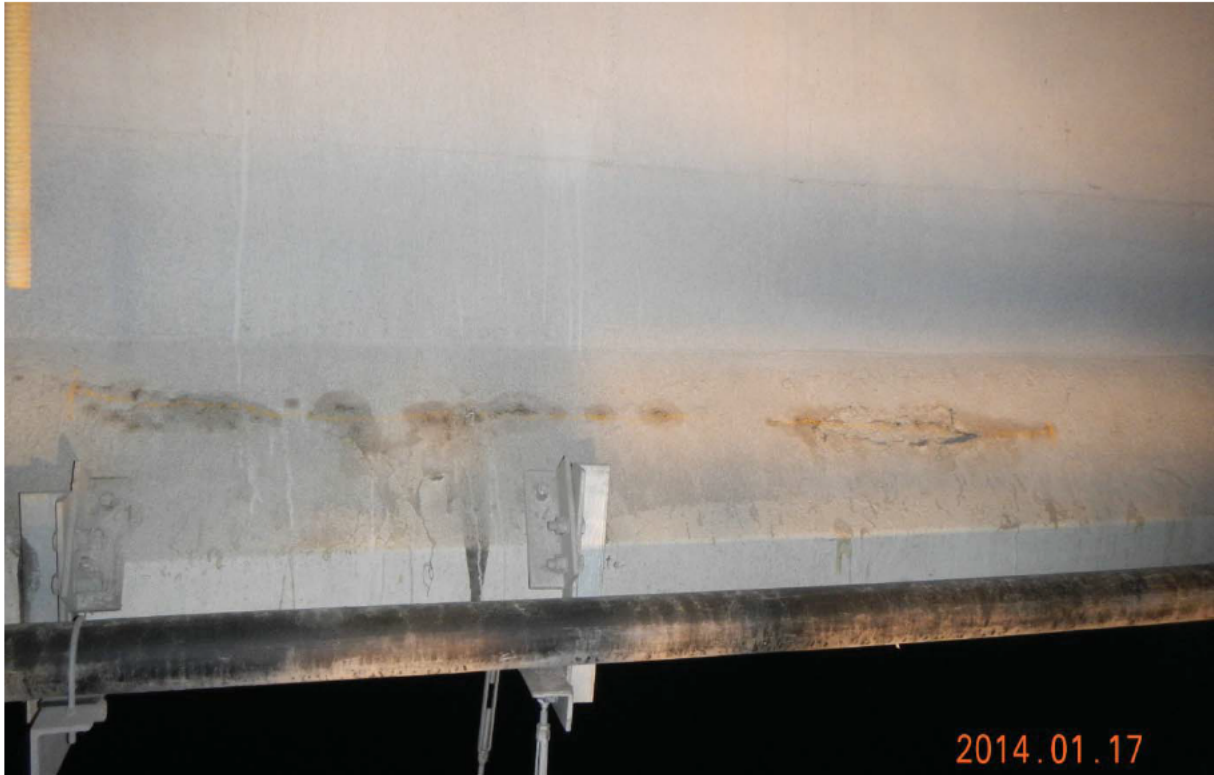
S5.PC.26W-27W.P1.a – 7425 (semelle inférieure - extrémité est face aval)
