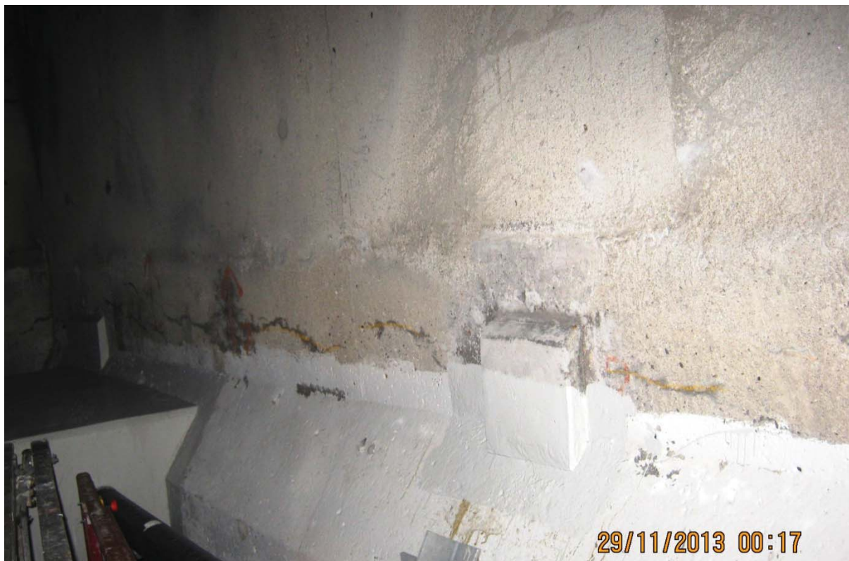
S5.PC.10W-11W.P7.e – 0108 (âme – extrémité ouest face amont)
