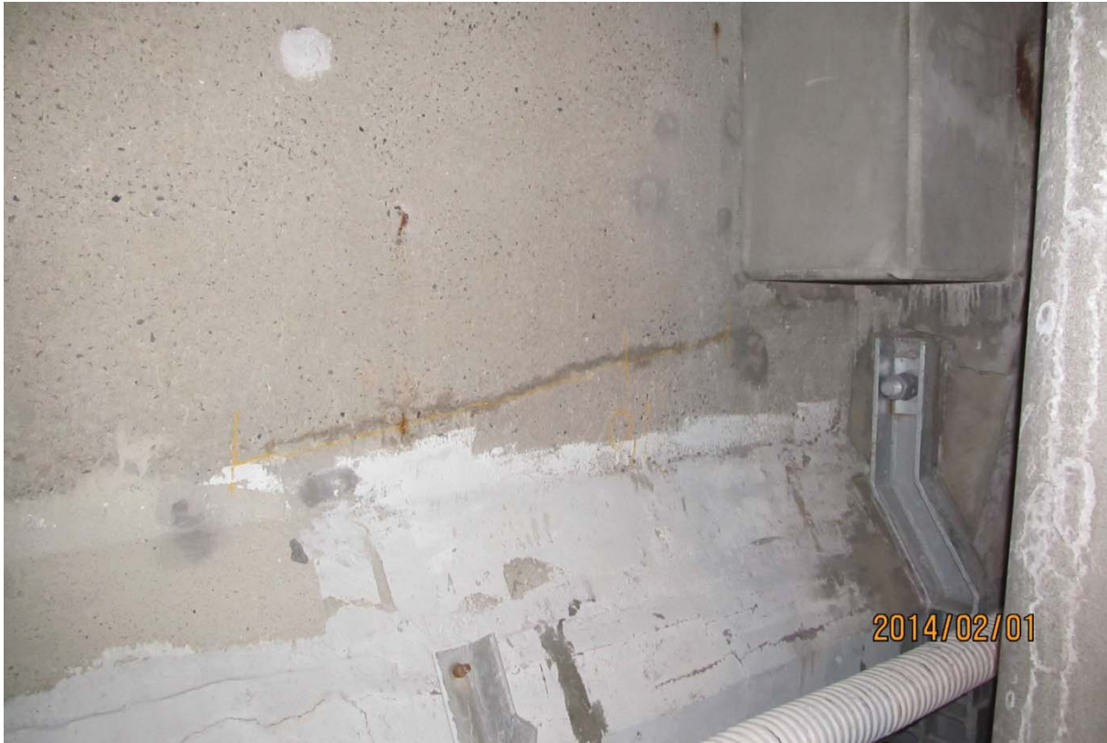
S5.PC.32W-33W.P7.e – 0214 (câble #22 – centre est face amont)
