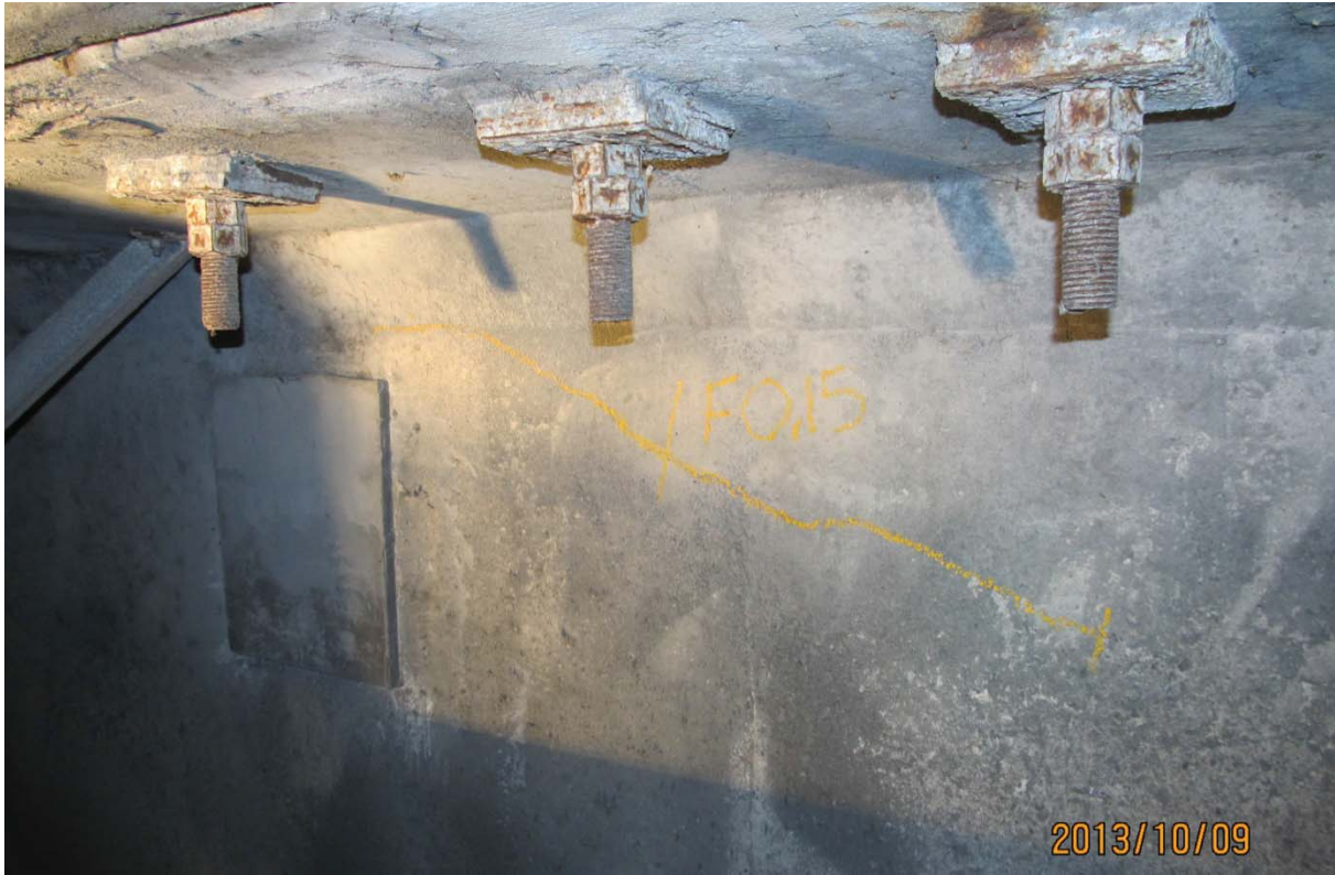
S5.PC.40W-41W.P7.a – 5684 (câble #16 - extrémité ouest face amont)
