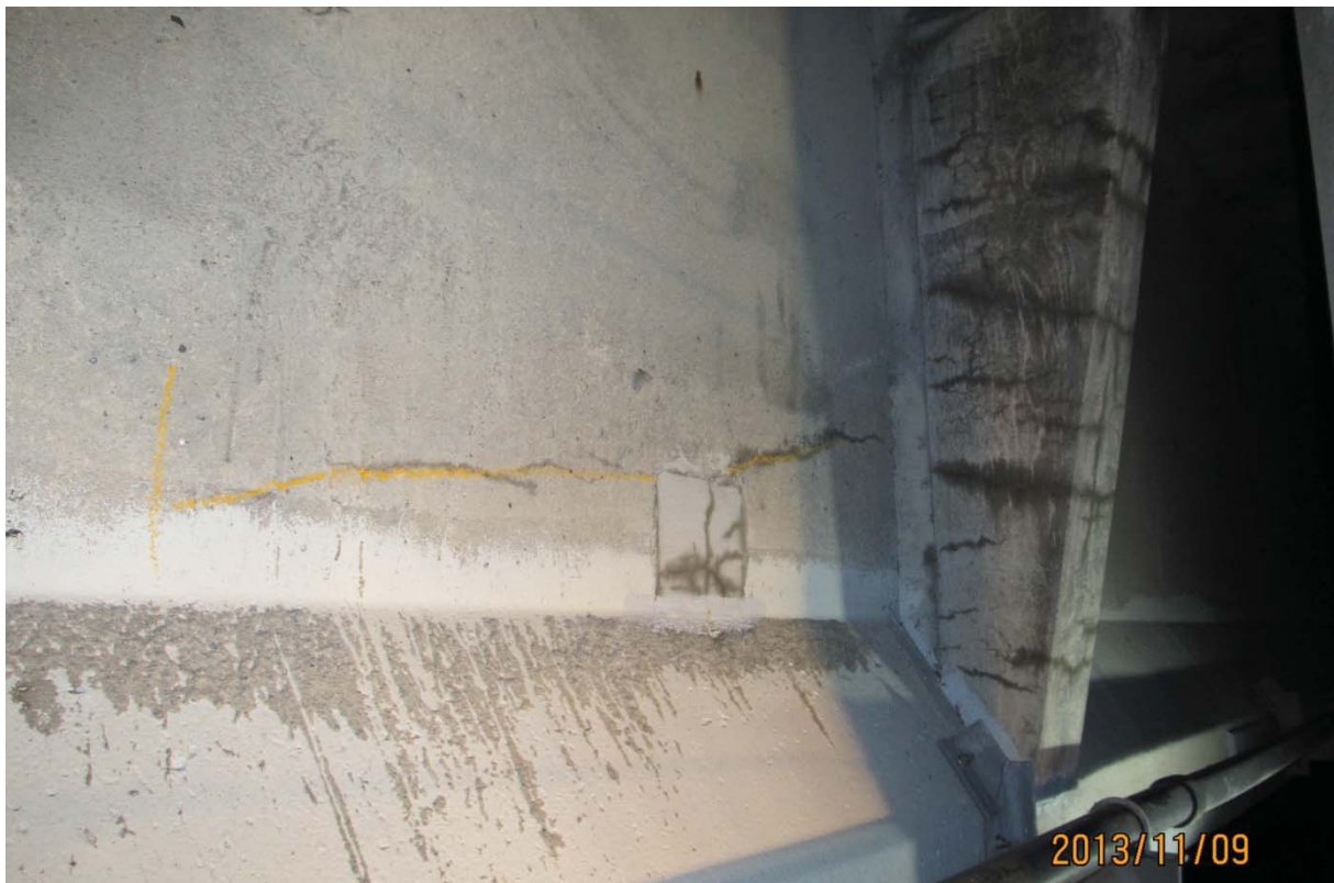
S5.PC.5W-6W.P1.b – 6211 (câble #22 - centre ouest face aval)
