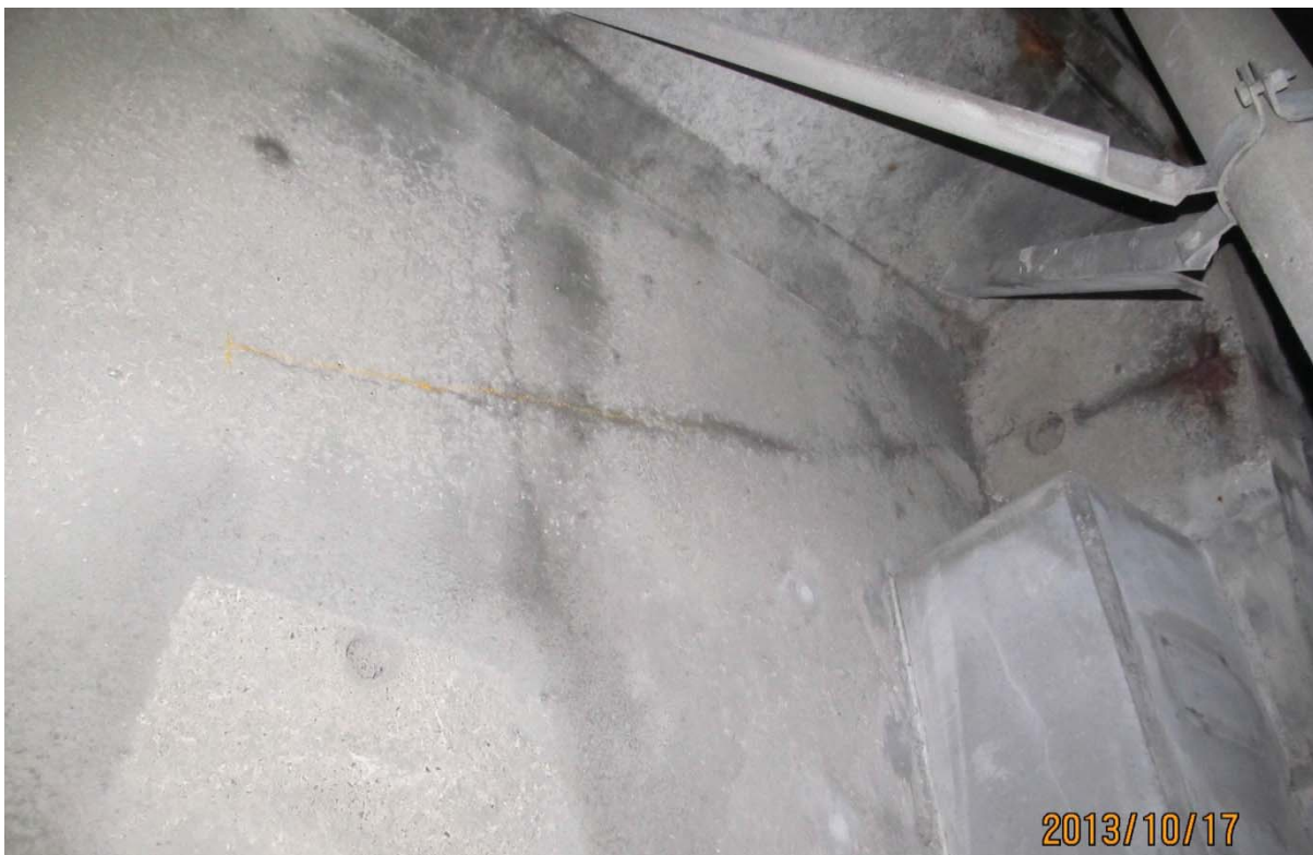
S5.PC.39W-40W.P1.a – 5817 (câble #24 – centre ouest face aval)
