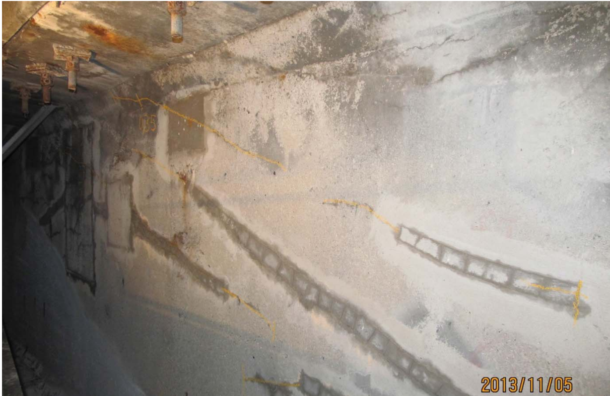
S5.PC.16W-17W.P7.a – 6102 (câbles #17, #16 et #15 – extrémité ouest face amont)
