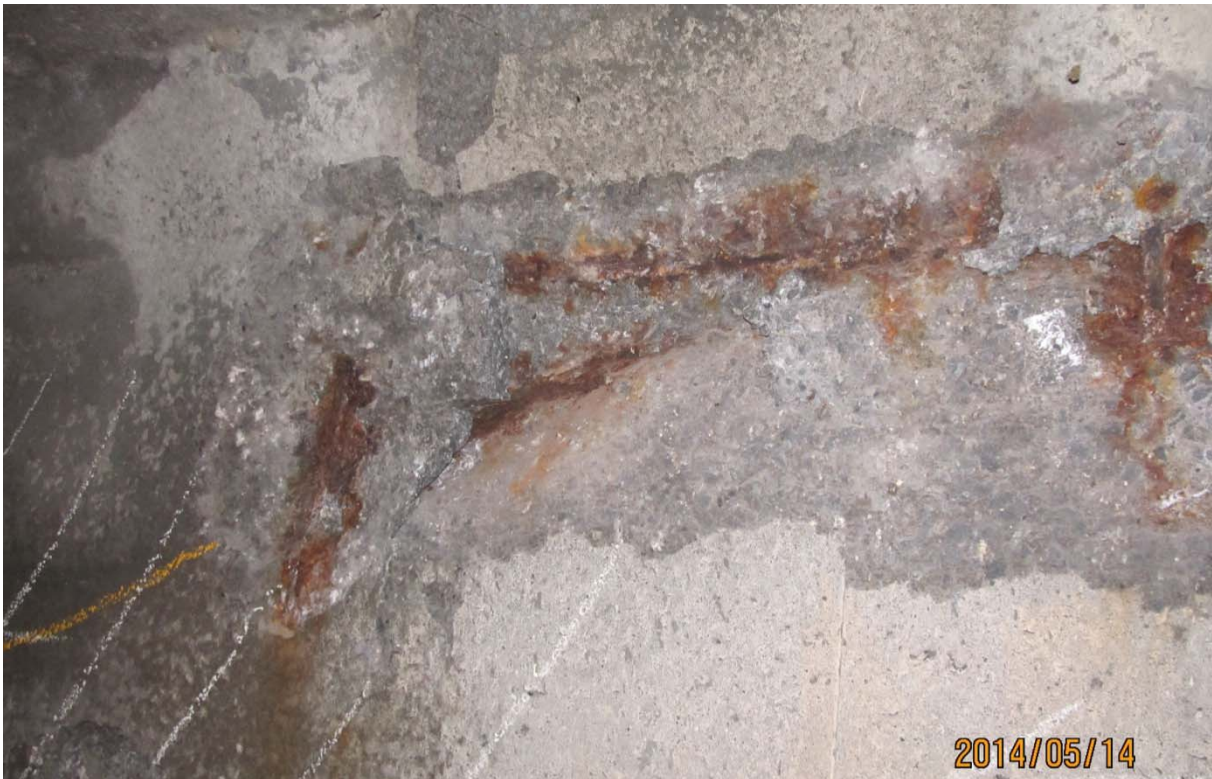
S5.PC.23W-24W.P1.b – 0487 (Détail câble #23 - extrémité ouest face aval)
