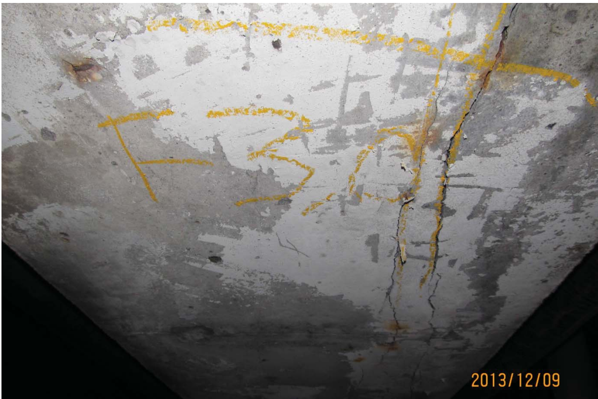
S5.PC.16W-17W.P1.d – 6690 (soffite – extrémité ouest)
