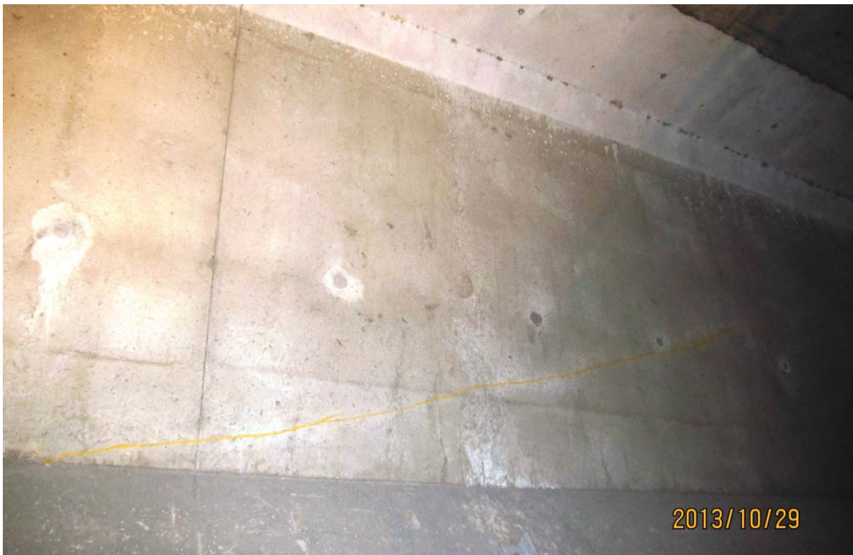
S5.PC.25W-26W.P7.d – 5963 (câble #20 – extrémité ouest face aval)
