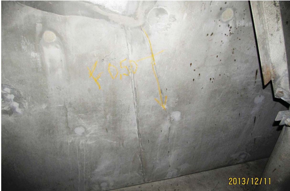
S5.PC.32W-33W.P1.a – 6724 (bloc d'ancrage QP 1.0 extérieur est)
