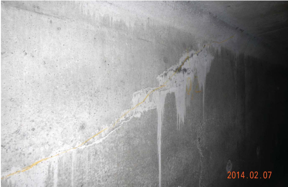
S5.PC.33W-34W.P4.b – 7537 (câble #19 – extrémité est face amont)
