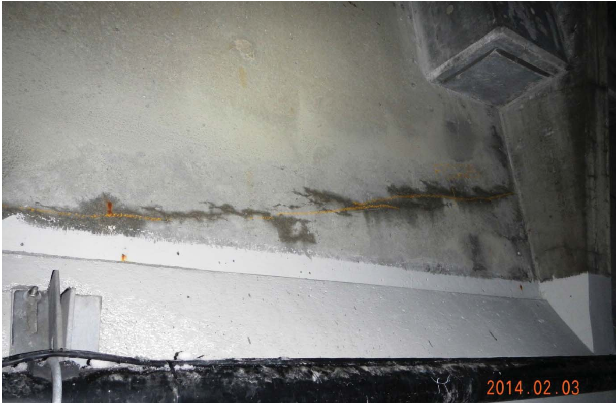
S7.PC.12E-13E.P7.e – 0799 (câbles #21 – centre est face amont)
