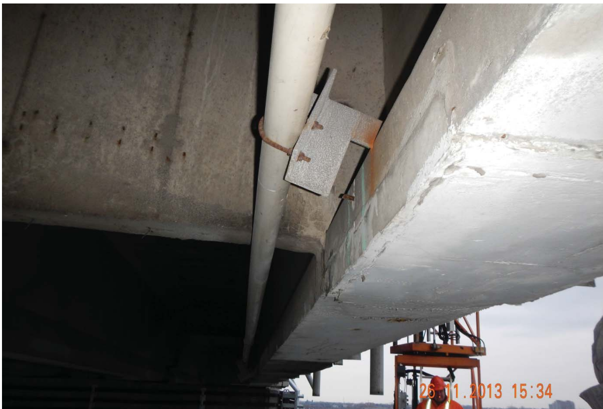
S5.PC.21W-20W.P7.k – 4388 (Ancrage de la précontrainte extérieure – face aval)
