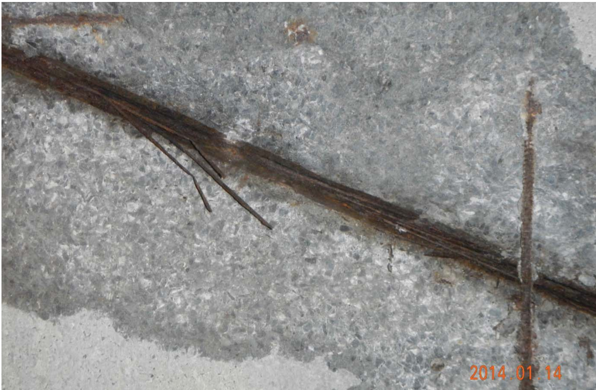
S5.PC.29W-30W.P1.d – 7325 (détail câble #23 - extrémité est face aval)
