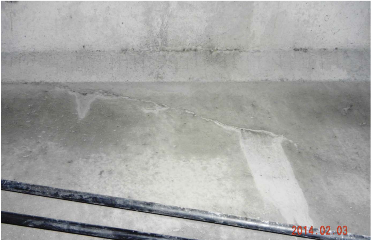
S7.PC.12E-13E.P7.h – 0811 (câble #16 – extrémité est face aval)
