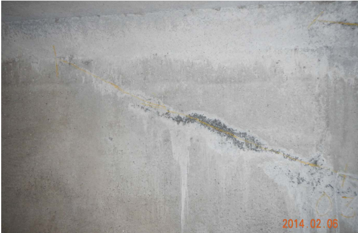
S5.PC.32W-33W.P4.a – 7527 (câble #19 – extrémité ouest face amont)
