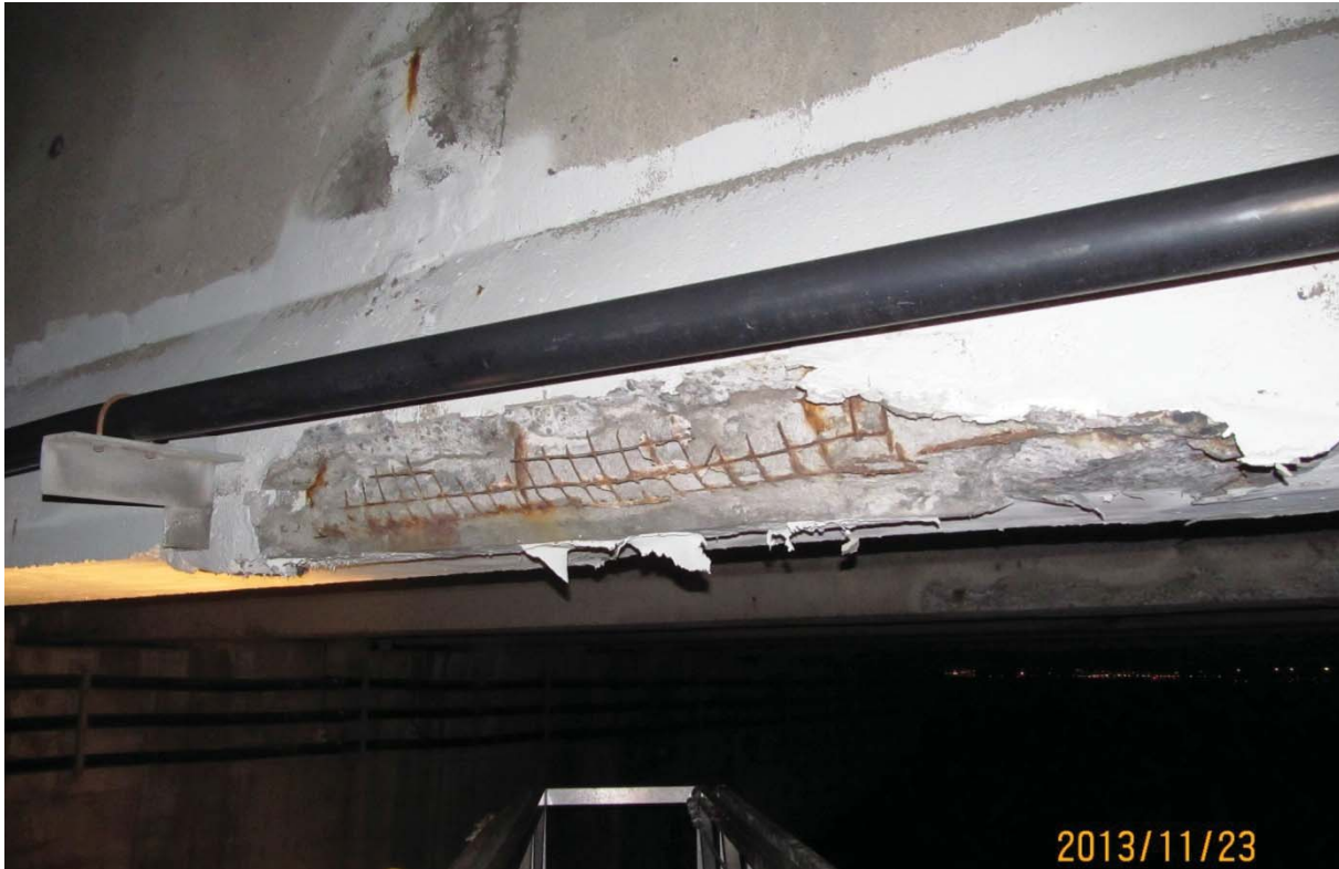
S5.PC.13W-14W.P7.j – 6404 (soffite – extrémité ouest face amont)
