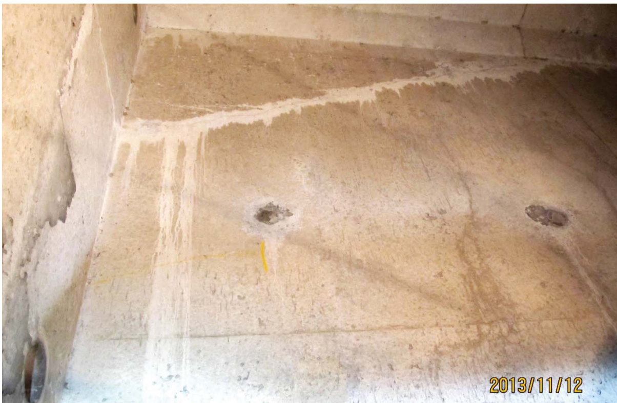
S5.PC.28W-29W.P7.j – 6234 (câbles #23 et #22 – extrémité ouest face aval)
