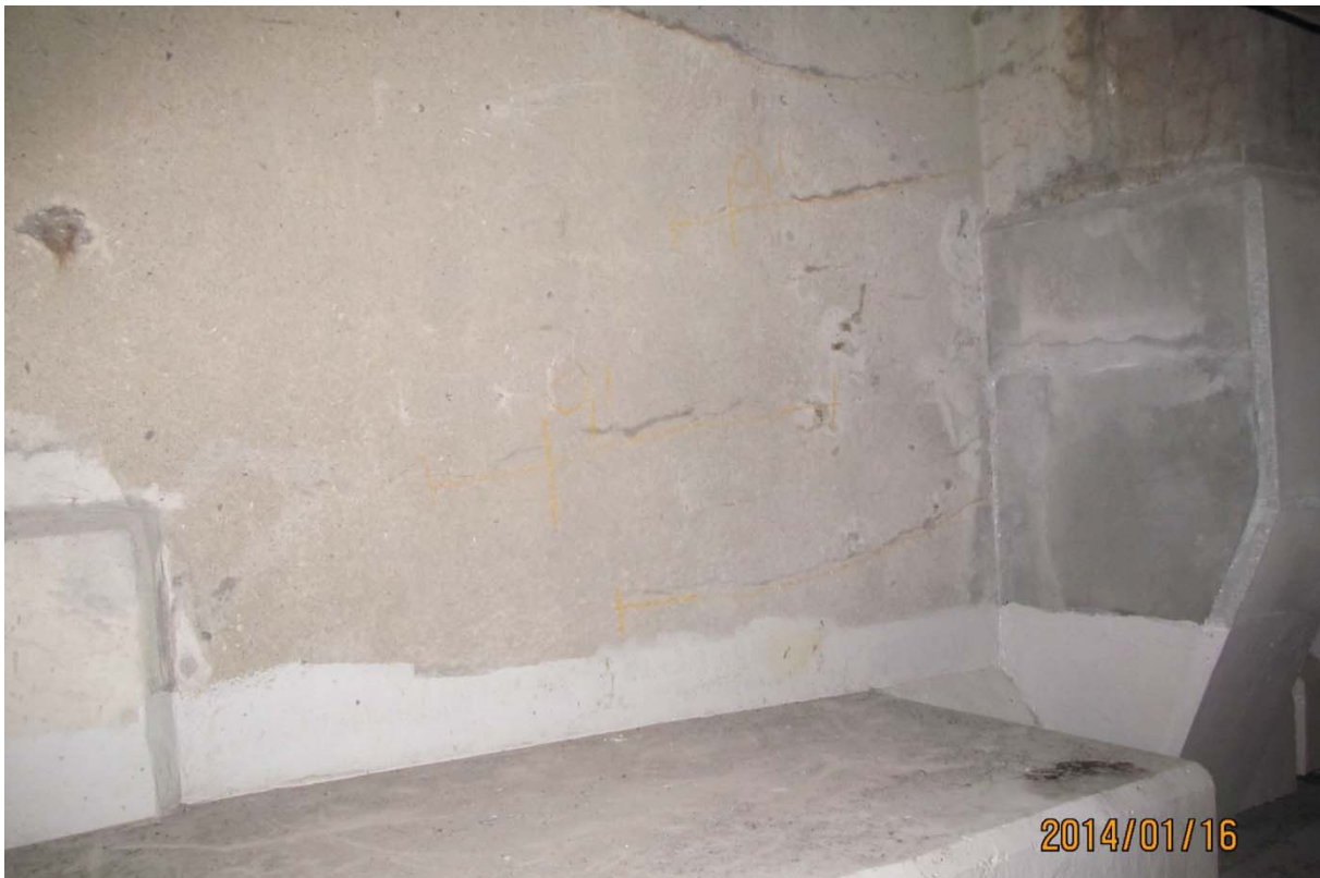
S7.PC.10E-11E.P1.d – 0178 (âme – extrémité ouest face aval)
