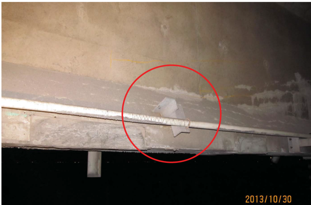
S5.PC.18W-19W.P7.k – 5988 (support gaine PTE – extrémité ouest face aval)
