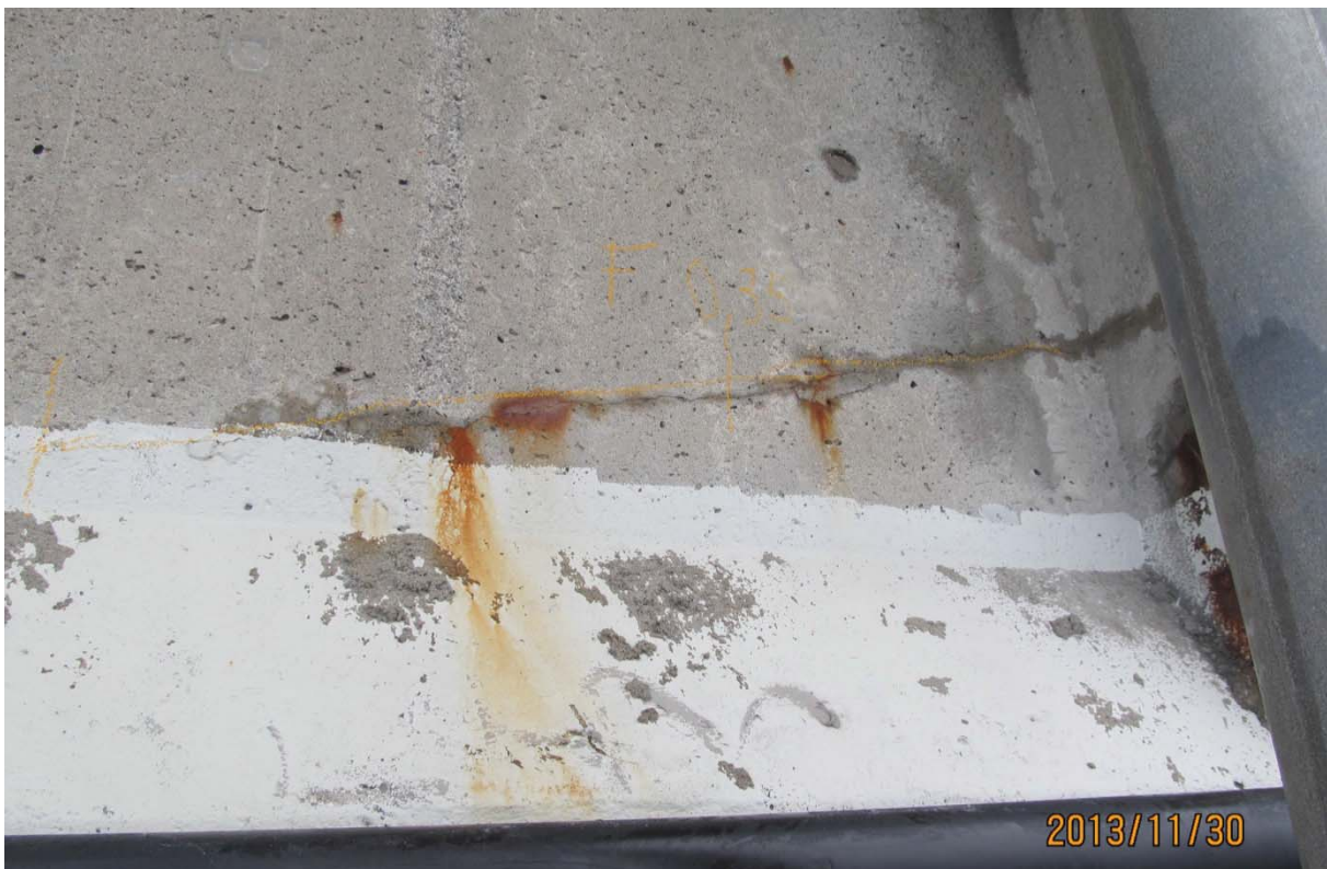
S5.PC.8W-9W.P7.d – 6528 (câble #22 – centre est face amont)
