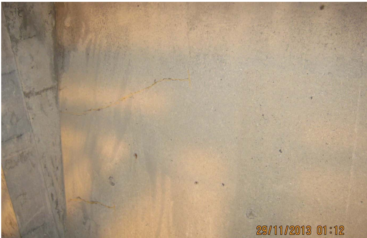
S5.PC.10W-11W.P7.d – 0114 (câbles #23 et #22 – extrémité est face amont)
