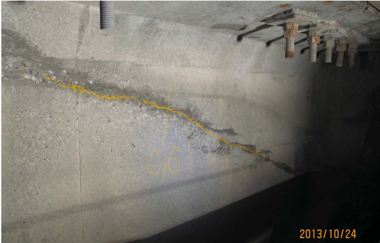
S5.PC.36W-37W.P7.a – 5917 (câble #23 - extrémité ouest face amont)
