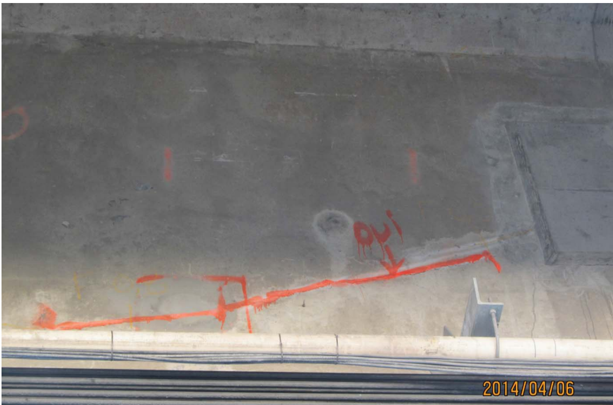
S5.PC.42W-43W.P1.d – 0406 (câble #24 - centre est face amont)
