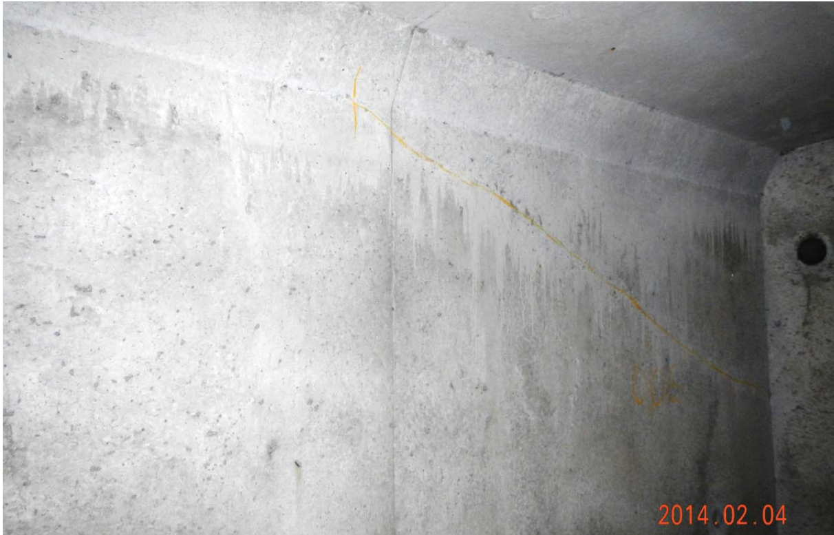
S5.PC.31W-32W.P4.c – 7504 (câble #23 – extrémité ouest face amont)
