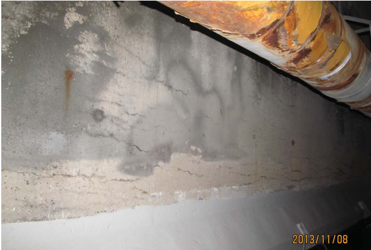
S7.PC.9E-10E.P7.a – 6172 (drain collecteur - face amont)
