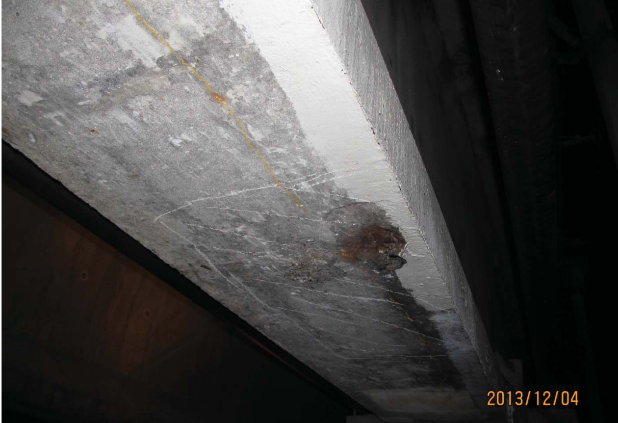
S5.PC.14W-15W.P1.e – 6588 (soffite – extrémité est)
