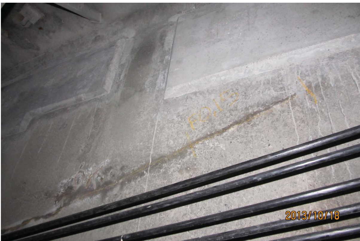
S5.PC.39W-40W.P1.b – 5821 (câble #20 - extrémité ouest face aval)
