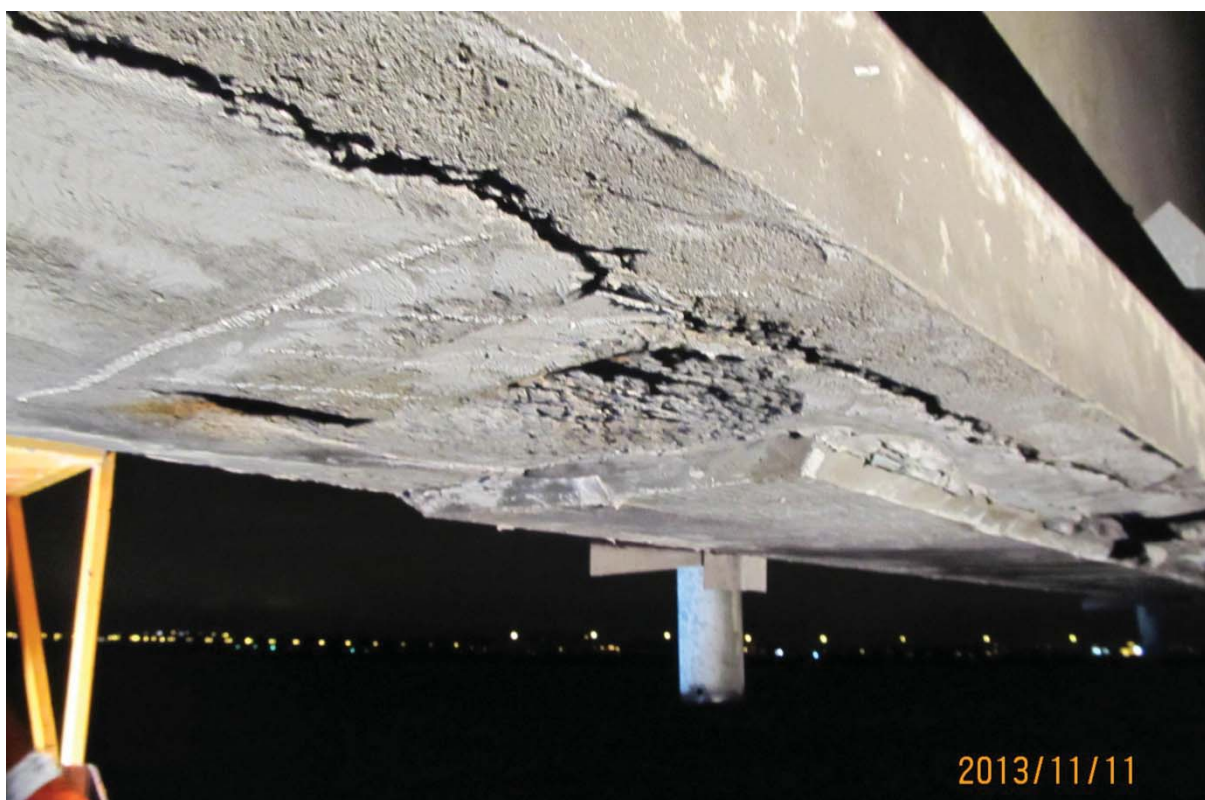
S5.PC.22W-23W.P1.b – 6222 (soffite – extrémité ouest)
