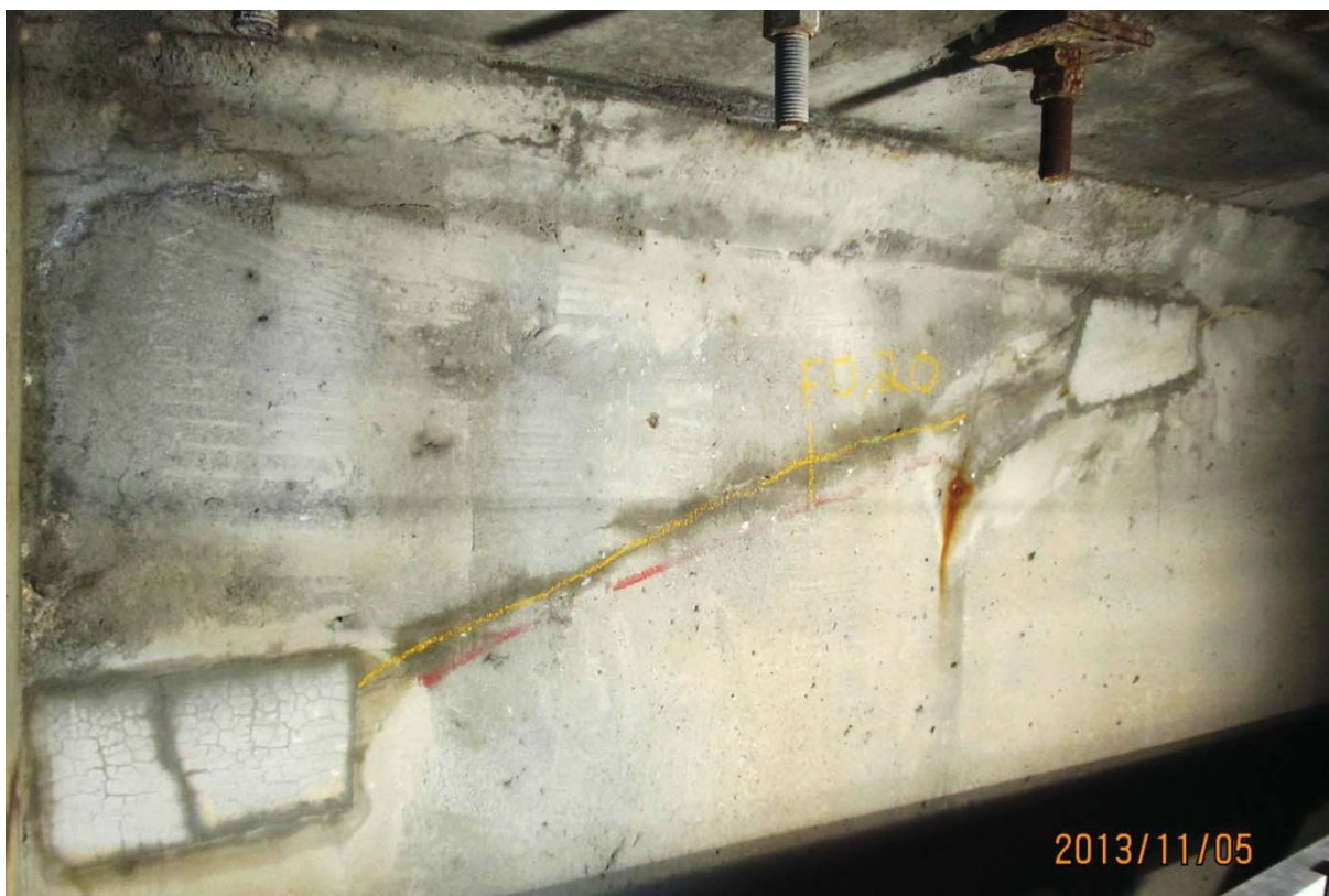
S5.PC.16W-17W.P7.h – 6115 (câble #23 – extrémité est face amont)
