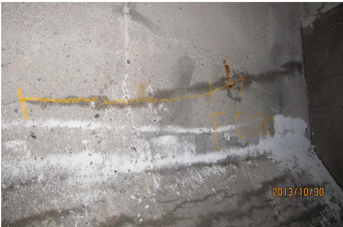
S5.PC.18W-19W.P7.e – 5992 (câble #22 – centre est face amont)
