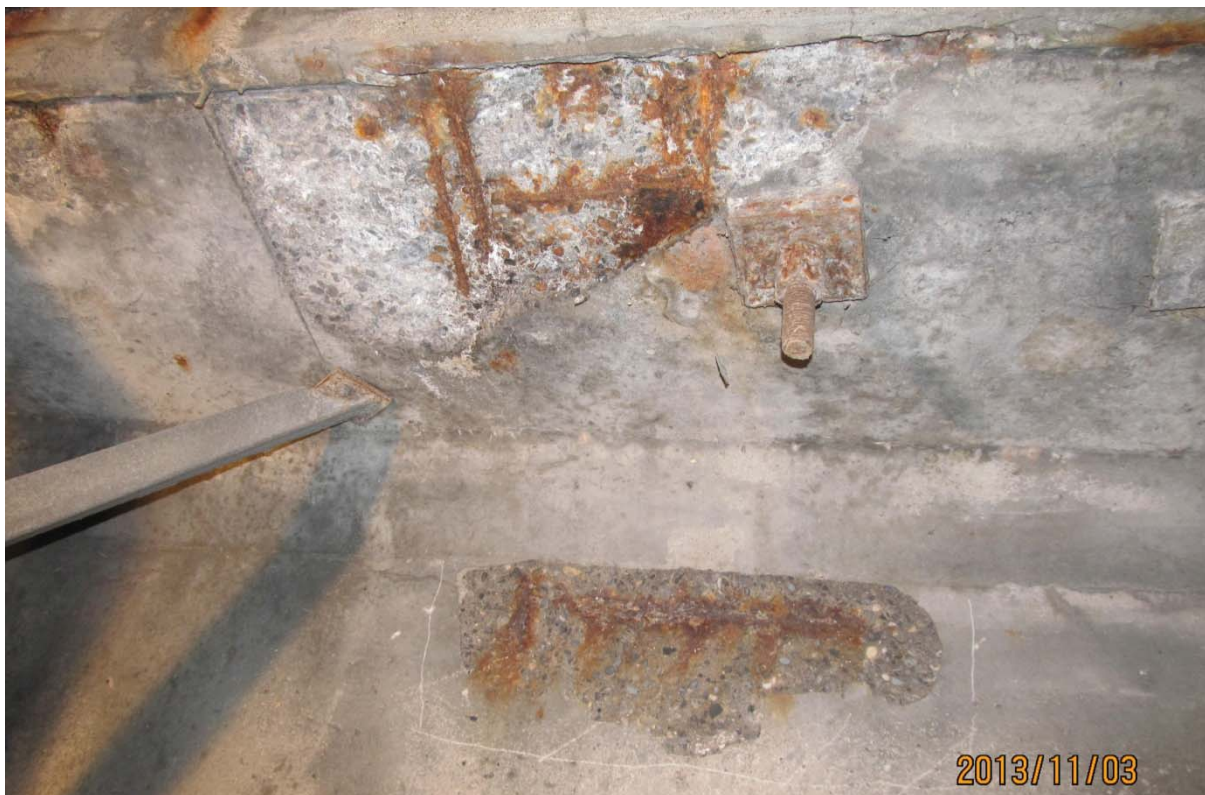
S5.PC.17W-18W.P1.c – 6077 (âme et semelle supérieure - extrémité ouest face aval)
