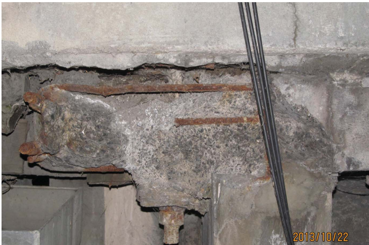
S7.PC.4E-5E.P1.a – 5886 (extrémité est - face aval)
