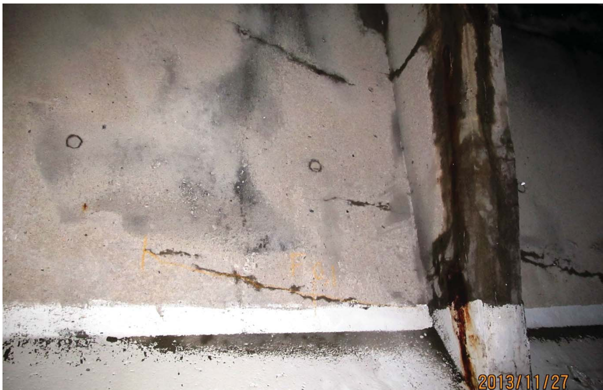
S5.PC.19W-20W.P7.c – 6429 (câble #21 – extrémité ouest face amont)
