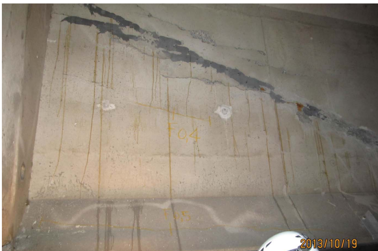
S5.PC.35W-36W.P7.f – 5835 (câbles #23 et #24 - centre est face aval)
