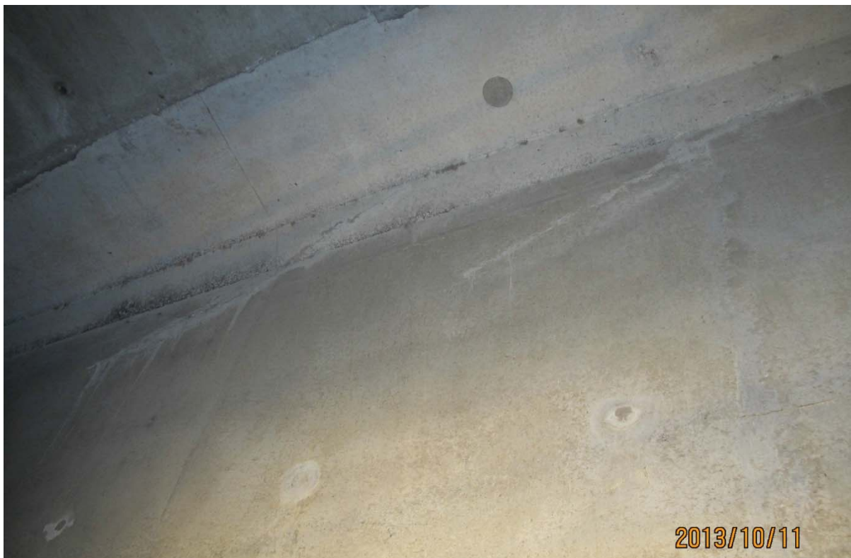
S5.PC.38W-39W.P1.e – 5730 (câbles #20 et #19 - extrémité est face amont)
