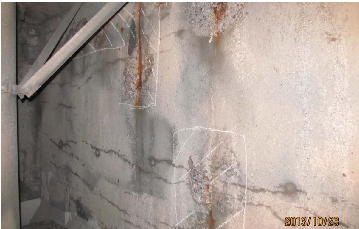
S5.PC.15W-16W.P1.a – 5896 (âme - extrémité est face aval)
