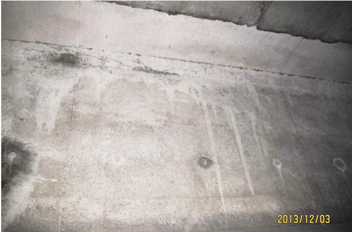
S5.PC.30W-31W.P1.e – 6561 (câble #19 - extrémité ouest face amont)
