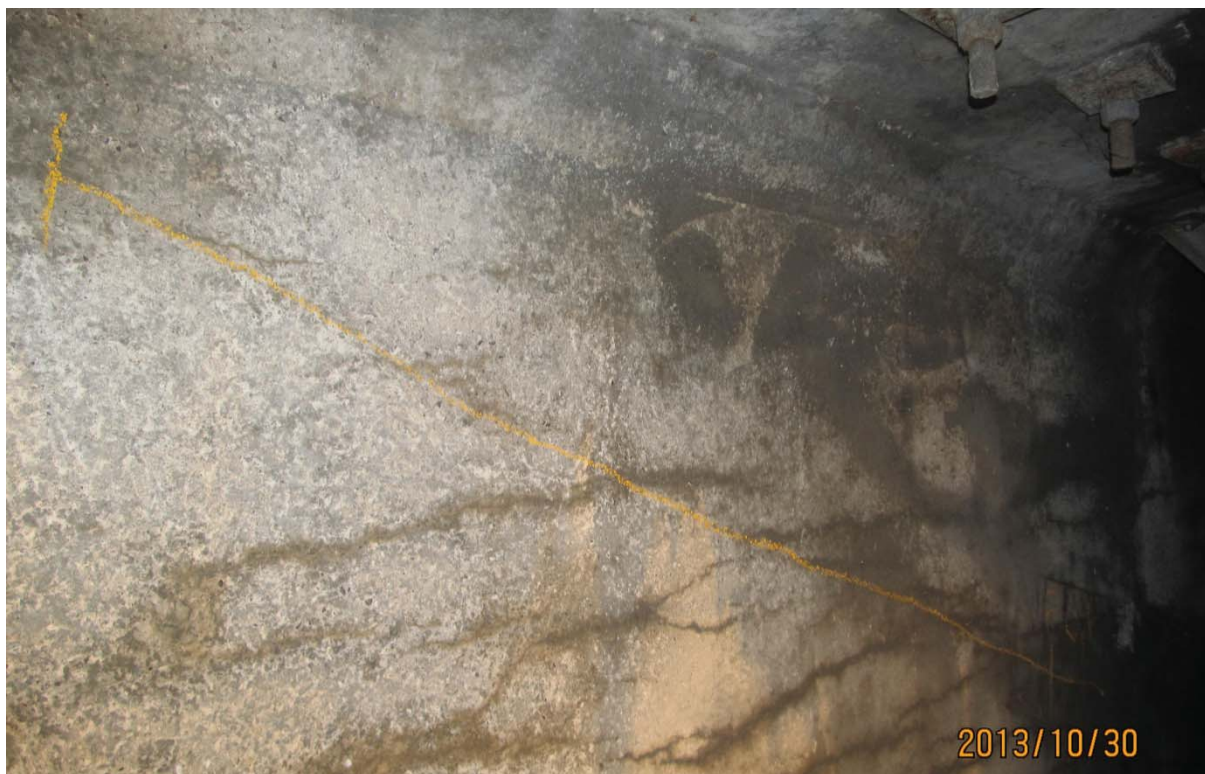
S5.PC.30W-31W.P1.b – 6049 (câble #20 - extrémité est face aval)
