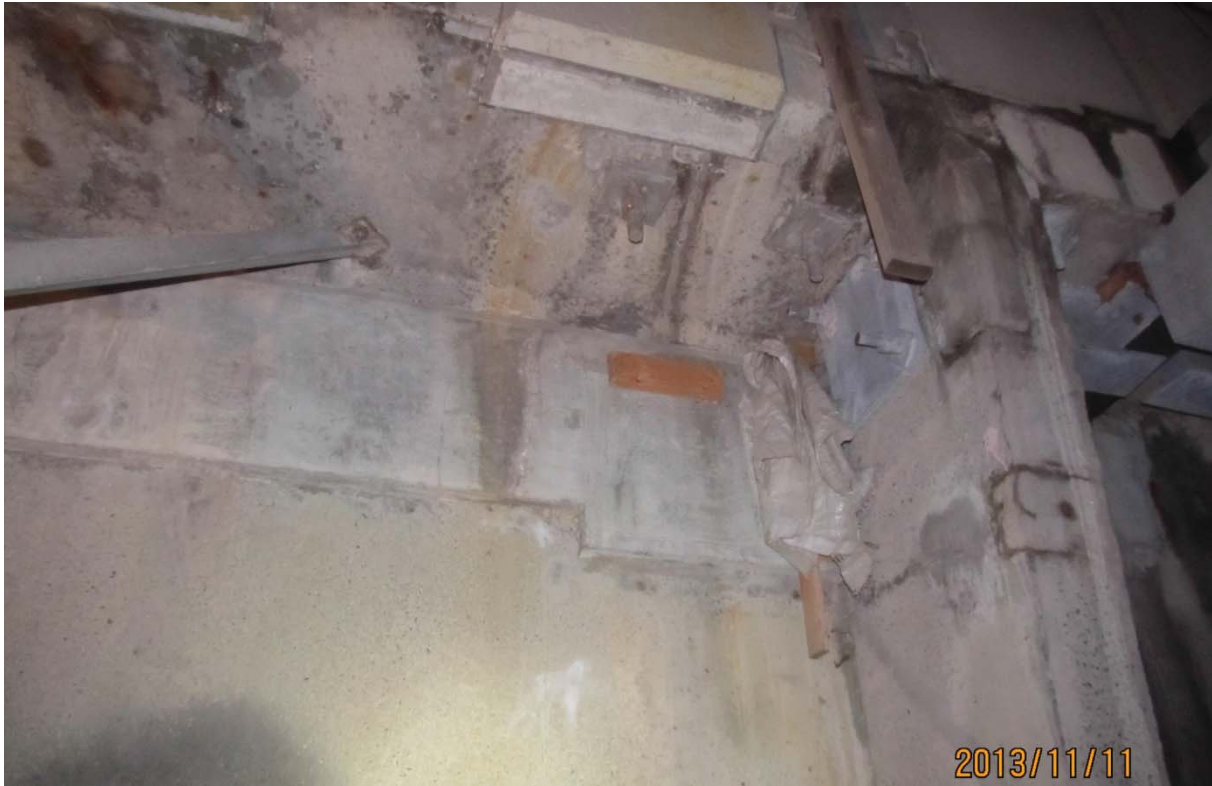
S5.PC.24W-25W.P1.a – 6225 (Coffrage laissé en place - extrémité ouest face aval)
