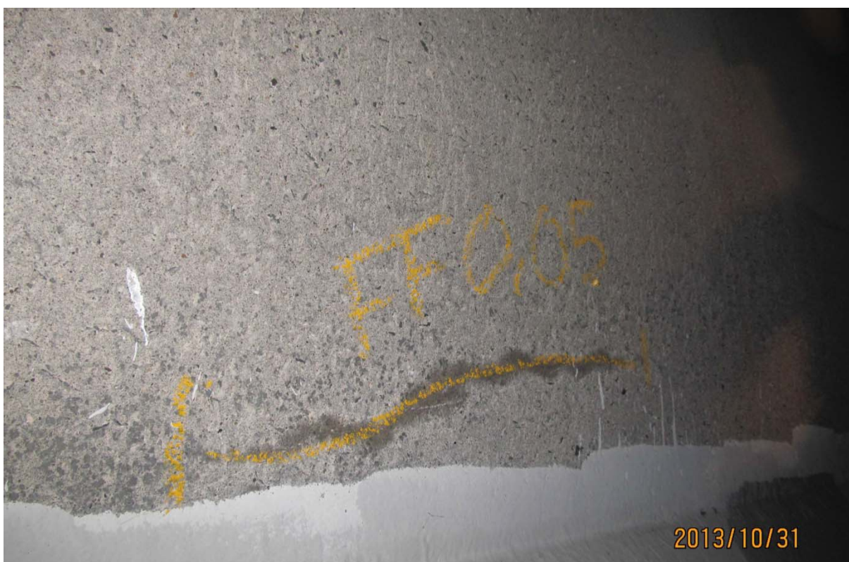
S5.PC.35W-36W.P1.d – 6069 (câble #24 – centre ouest face aval)
