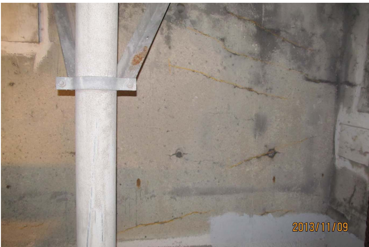
S5.PC.5W-6W.P1.d – 6217 (âme - extrémité ouest face aval)
