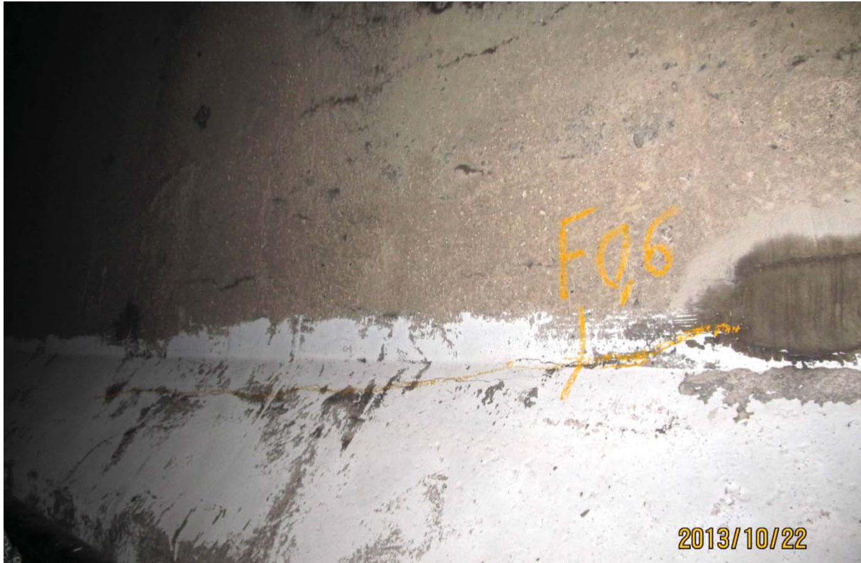
S7.PC.4E-5E.P1.c – 5894 (câble #18 - extrémité ouest face aval)
