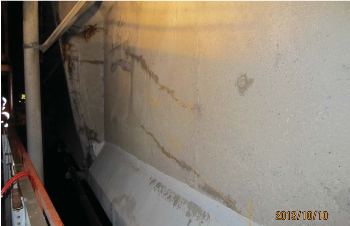
S5.PC.39W-38W.P7.a – 5723 (câbles #23 et #24 – centre ouest face amont)
