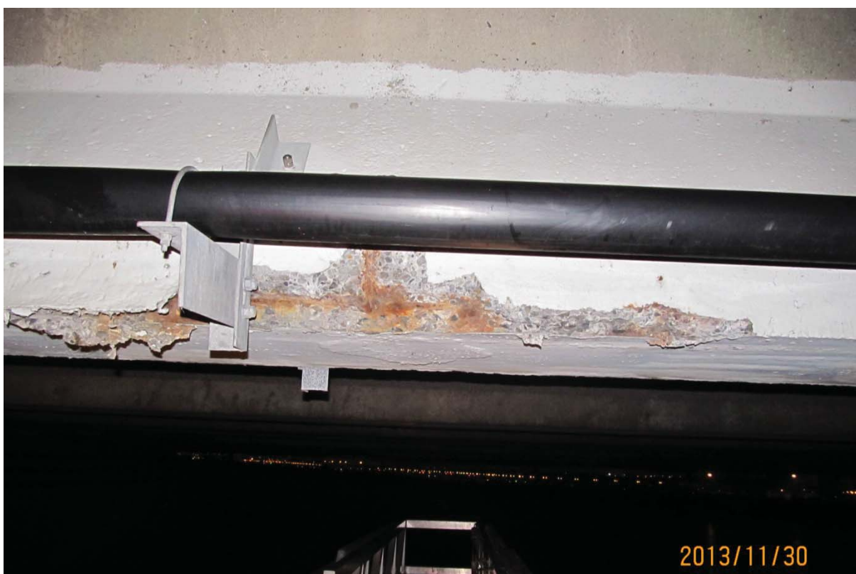
S5.PC.9W-10W.P7.h – 6502 (soffite – extrémité ouest)
