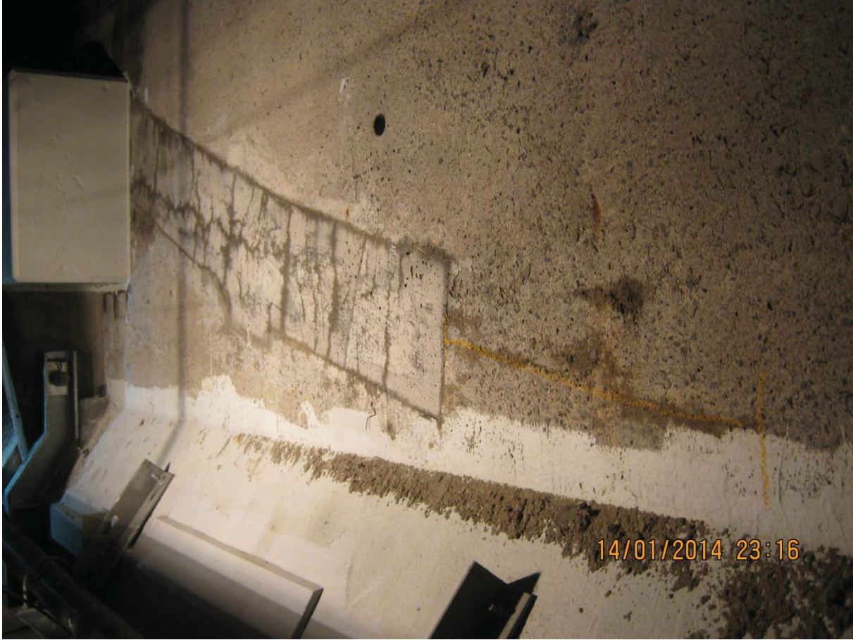
S5.PC.26W-27W.P7.a – 0281 (câble #23 - centre est face amont)
