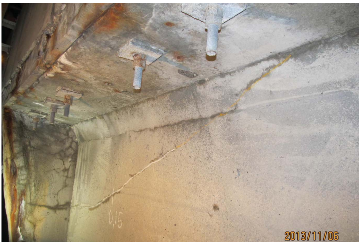
S5.PC.17W-18W.P7.h – 6139 (câble #23 – extrémité est face amont)
