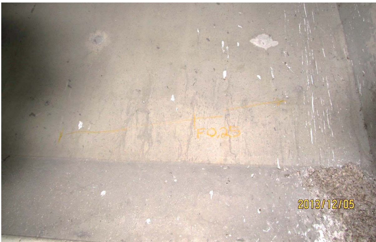
S5.PC.04W-05W.P7.h – 6592 (câble #22 – centre ouest face aval)
