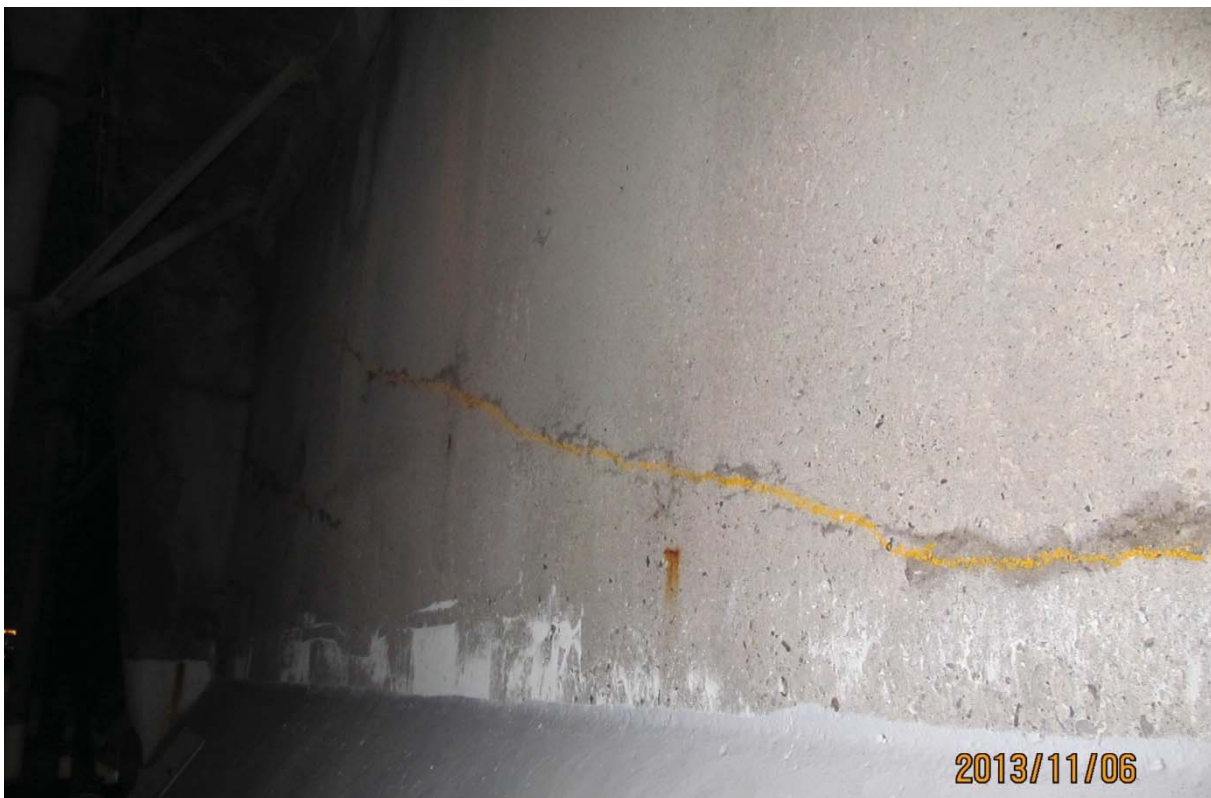
S5.PC.17W-18W.P7.f – 6136 (câble #24 – centre ouest face amont)
