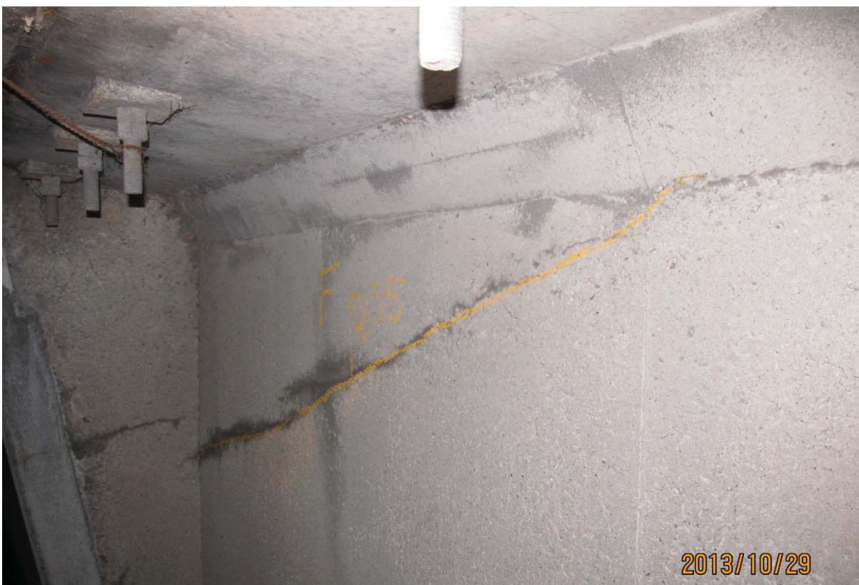
S5.PC.36W-37W.P1.b – 5957 (câble #23 - extrémité ouest face aval)
