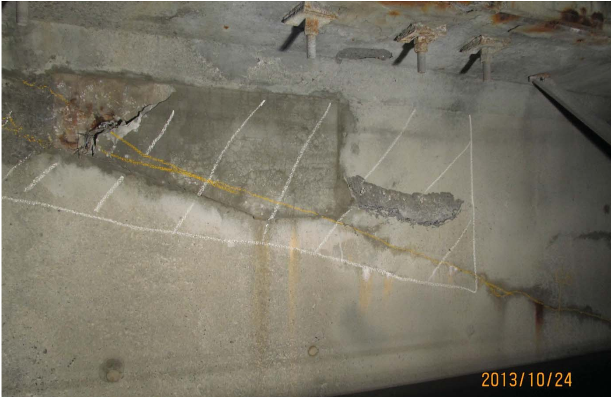
S5.PC.37W-38W.P7.a – 5907 (câble #20 - extrémité ouest face amont)
