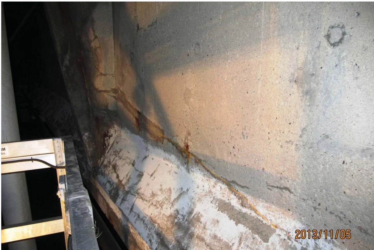
S5.PC.16W-17W.P7.f – 6109 (câble #22 – centre ouest face amont)
