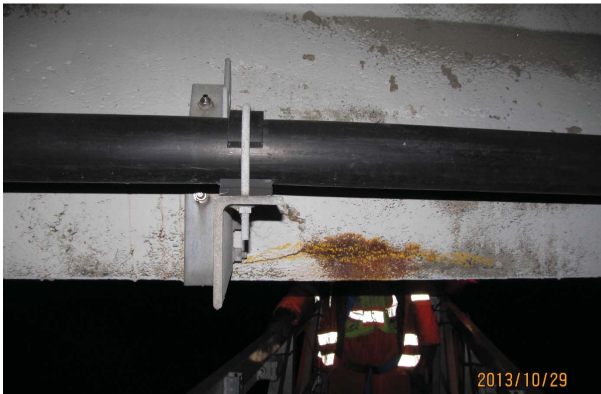
S5.PC.25W-26W.P7.g – 5964 (semelle inférieure – extrémité ouest face amont)
