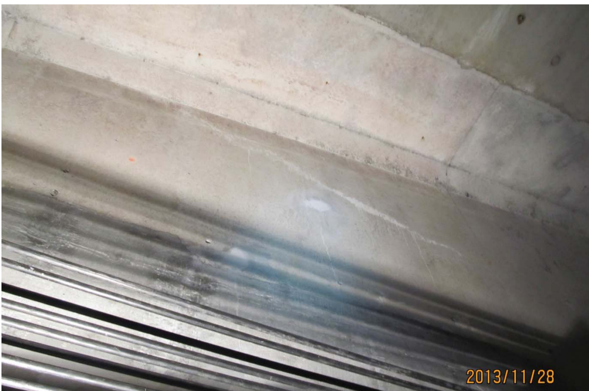
S5.PC.39W-40W.P7.b – 6467 (câble #22 - extrémité est face aval)
