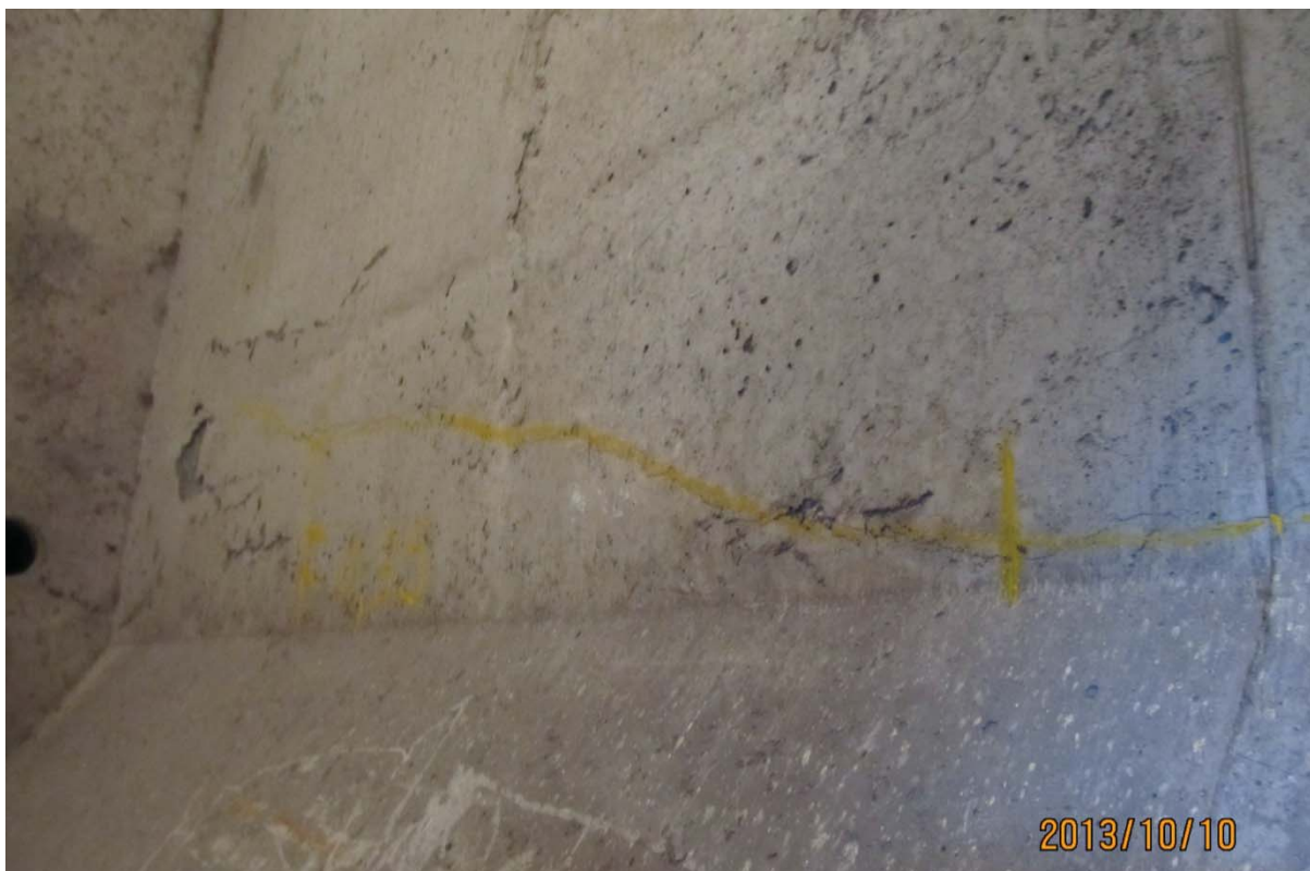
S5.PC.40W-41W.P7.f – 5703 (câble #22 - extrémité est face aval)
