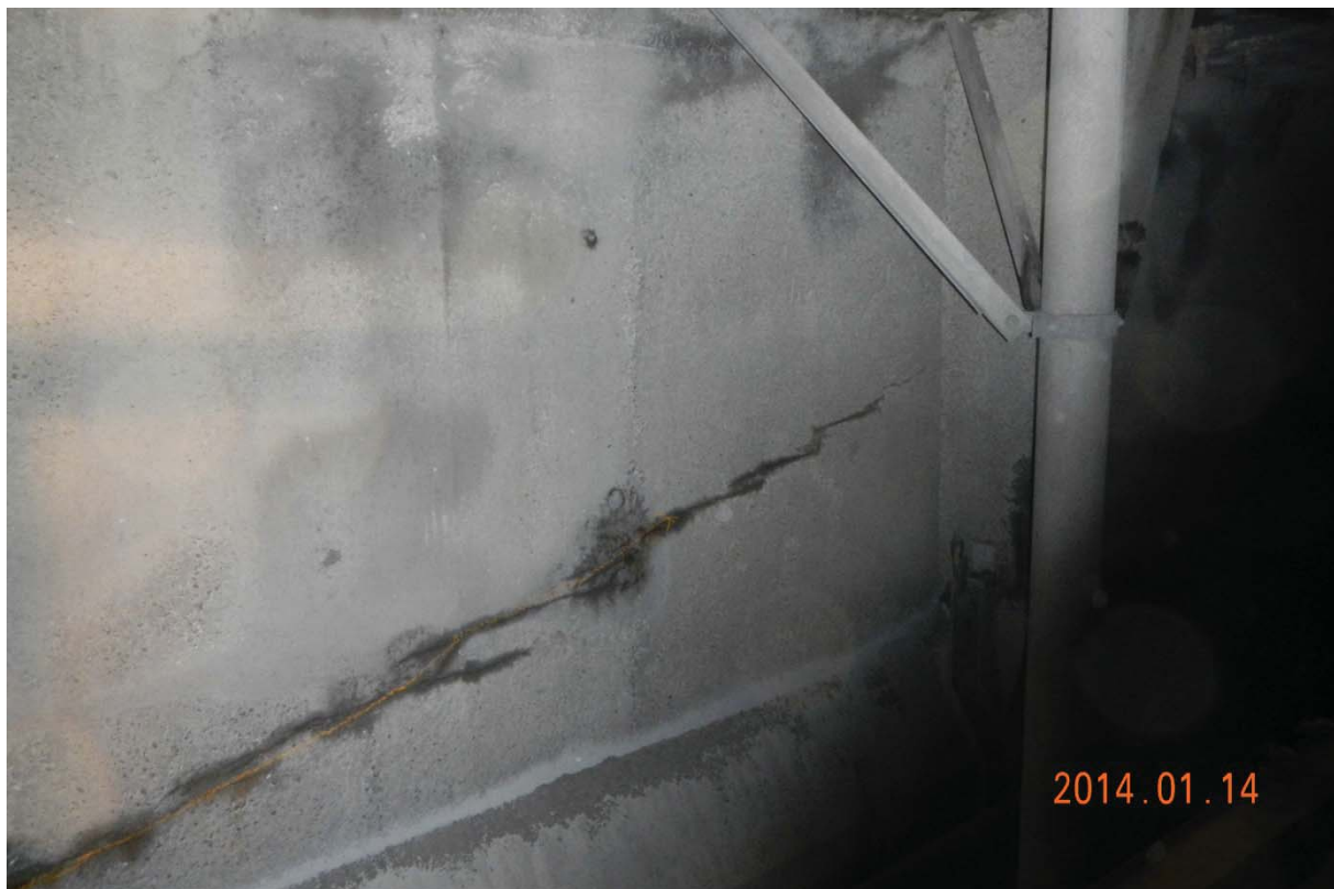
S5.PC.29W-30W.P1.f – 7331 (détail câble #23 - centre ouest face aval)
