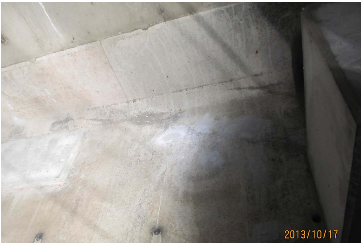
S5.PC.39W-40W.P1.d – 5818 (câbles #23 et #24 - extrémité ouest face amont)
