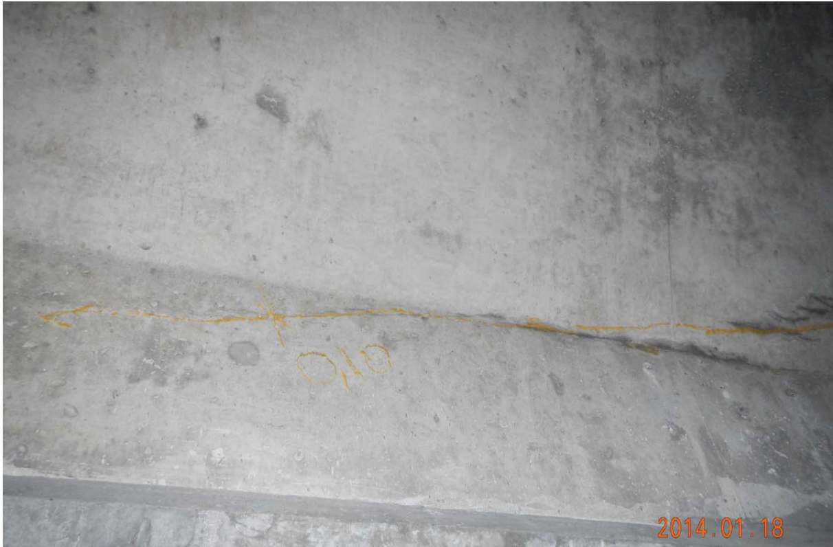
S7.PC.11E-12E.P4.c – 0725 (câble #19 – extrémité est face amont)
