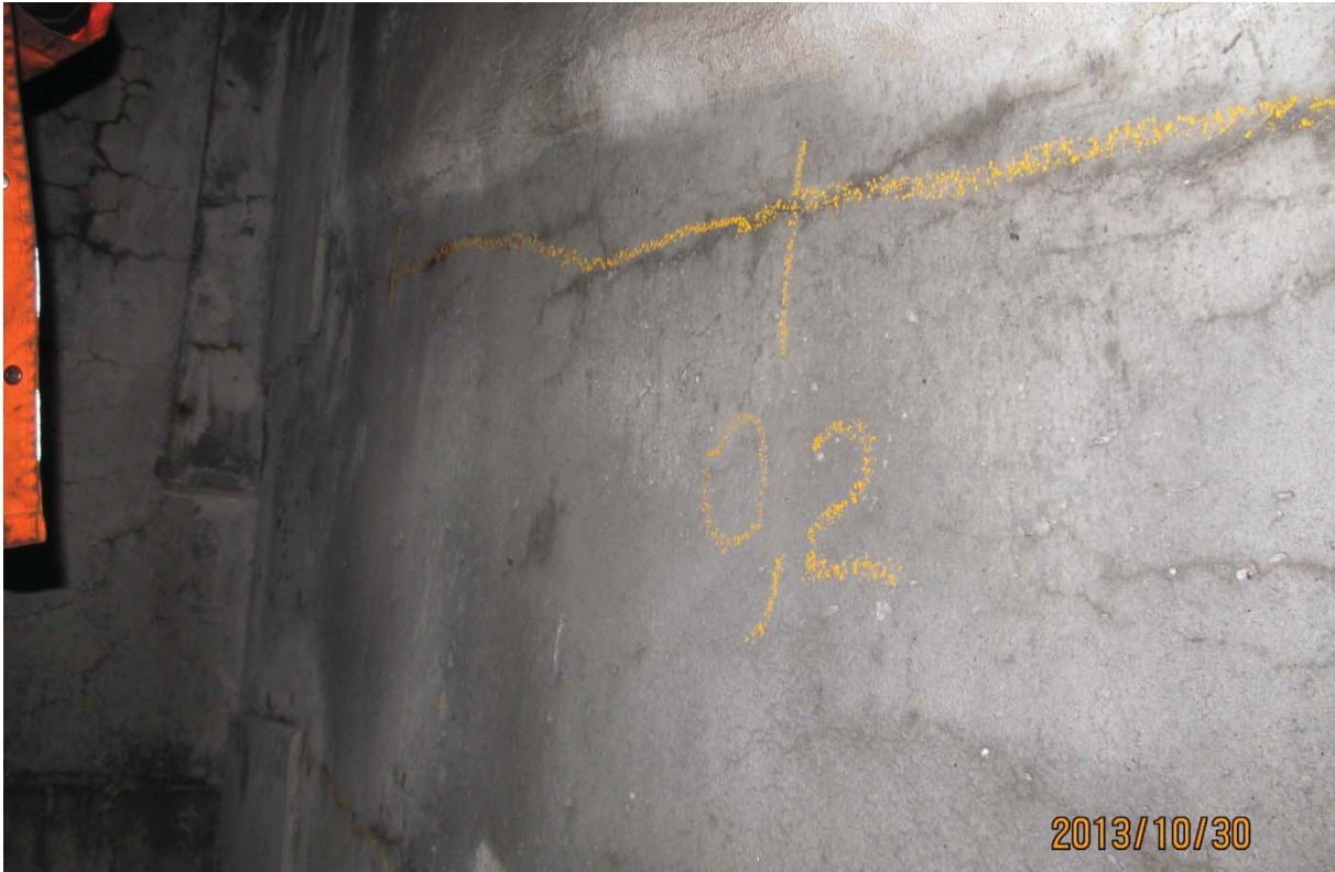
S5.PC.18W-19W.P7.a – 5985 (câble #11 – extrémité ouest face amont)
