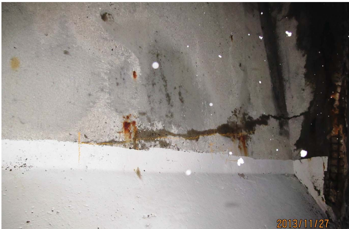
S5.PC.19W-20W.P7.e – 6442 (câbles #22 – centre est face amont)
