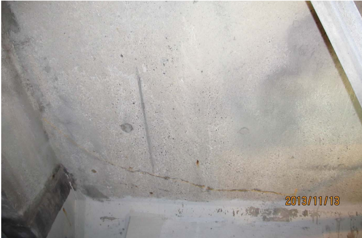
S5.PC.24W-25W.P7.a – 6269 (câble #6 – extrémité ouest face amont)
