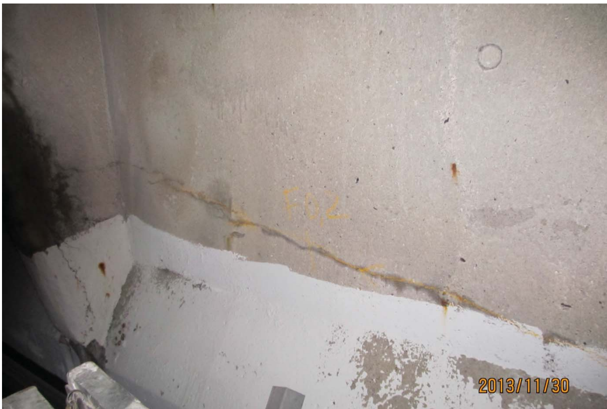
S5.PC.7W-8W.P7.b – 6533 (câble #22 – centre ouest face amont)
