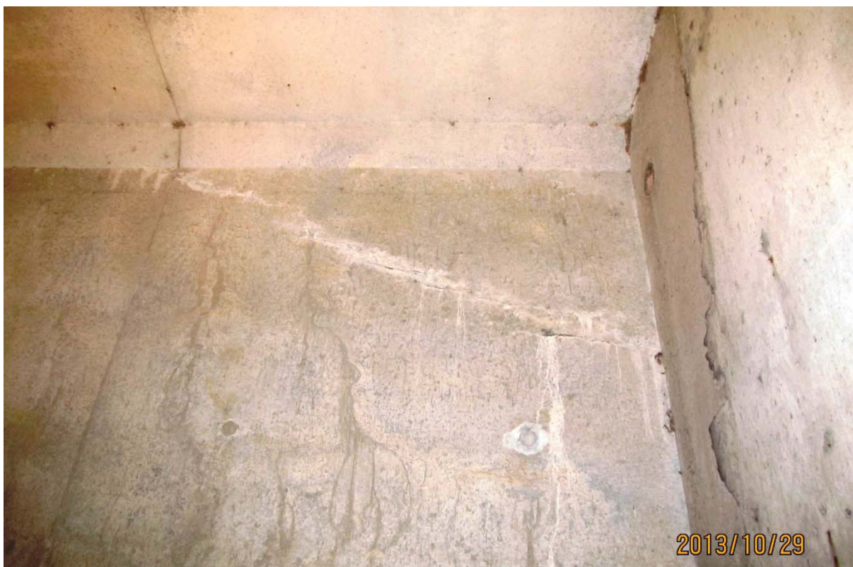
S5.PC.36W-37W.P1.d – 5956 (câble #23 - extrémité ouest face amont)
