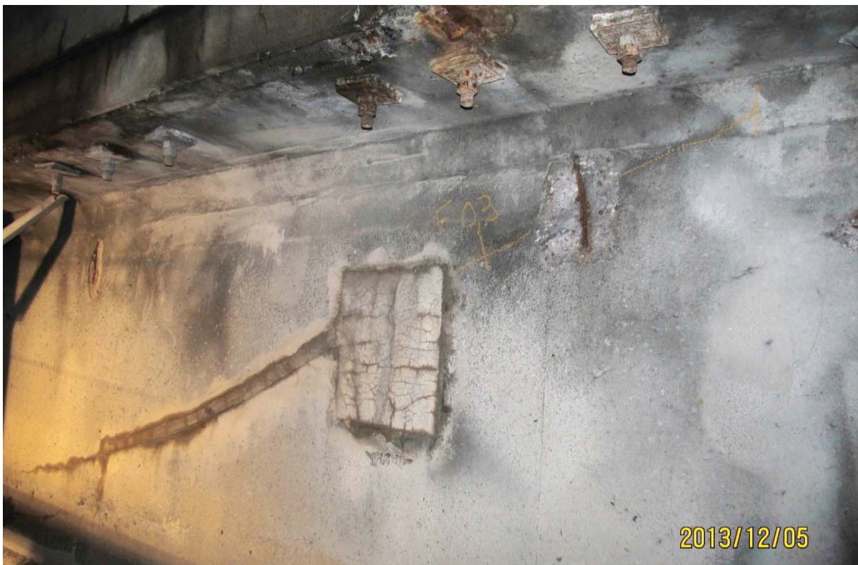
S5.PC.04W-05W.P7.e – 6610 (câble #12 – extrémité est face amont)
