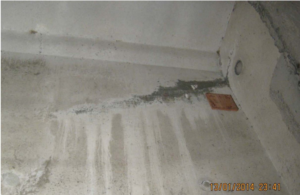
S5.PC.25W-26W.P1.a – 0271 (câble #24 - centre ouest face amont)
