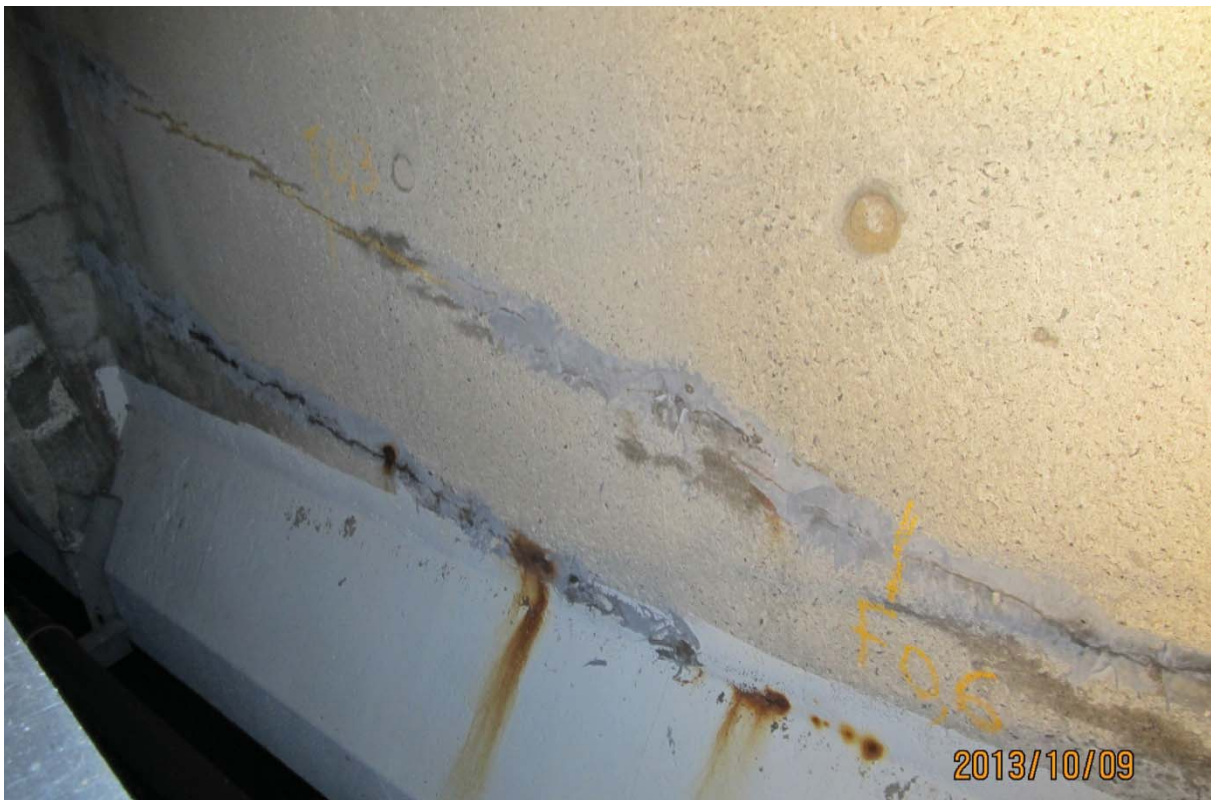
S5.PC.40W-41W.P7.d – 5699 (câbles #22 et #23 - extrémité ouest face amont)
