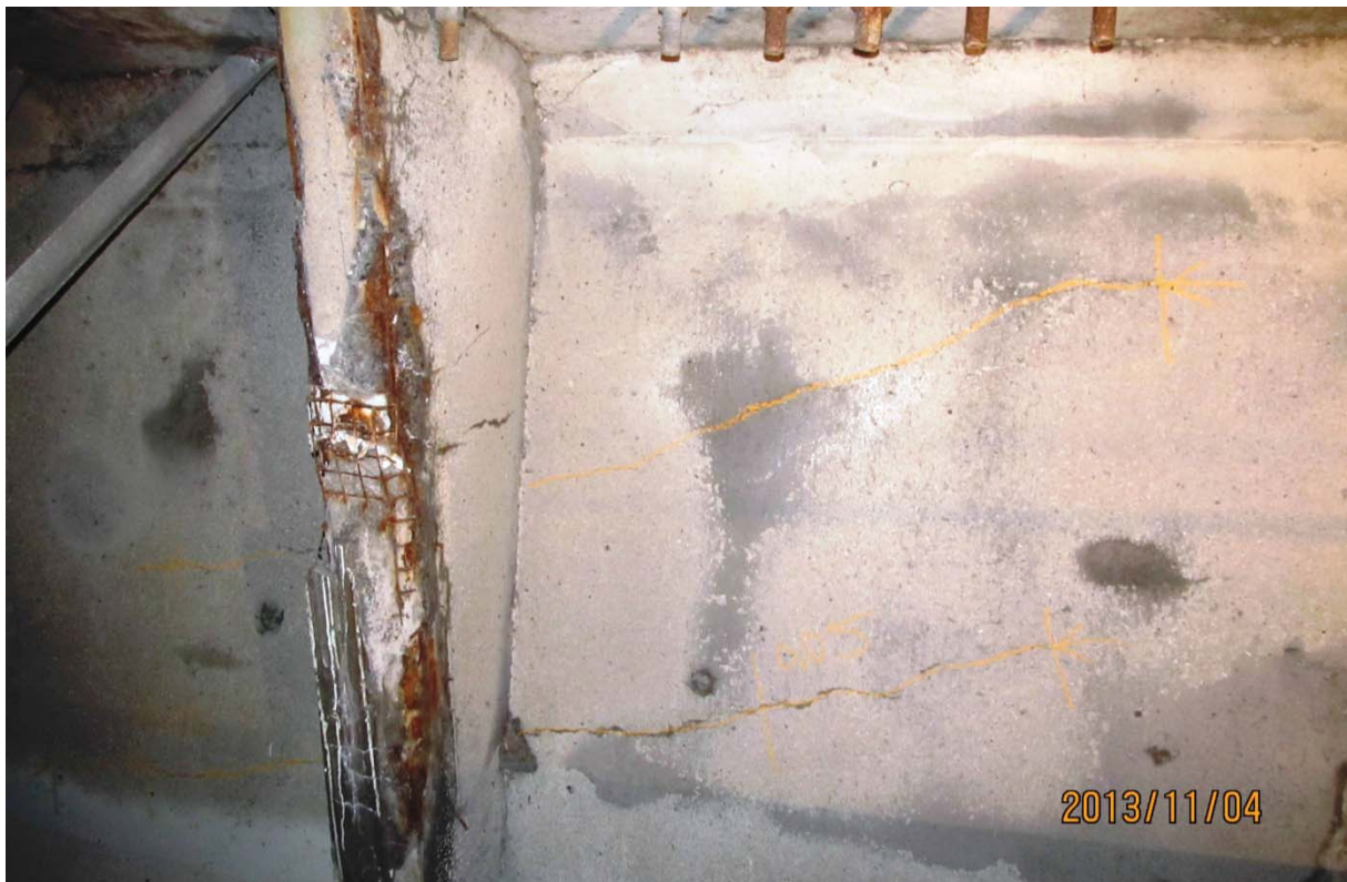
S5.PC.18W-19W.P1.d – 6092 (câbles #23 et #22 – extrémité ouest face aval)
