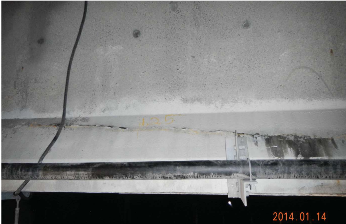
S5.PC.29W-30W.P1.e – 7328 (semelle inférieure - centre est face aval)
