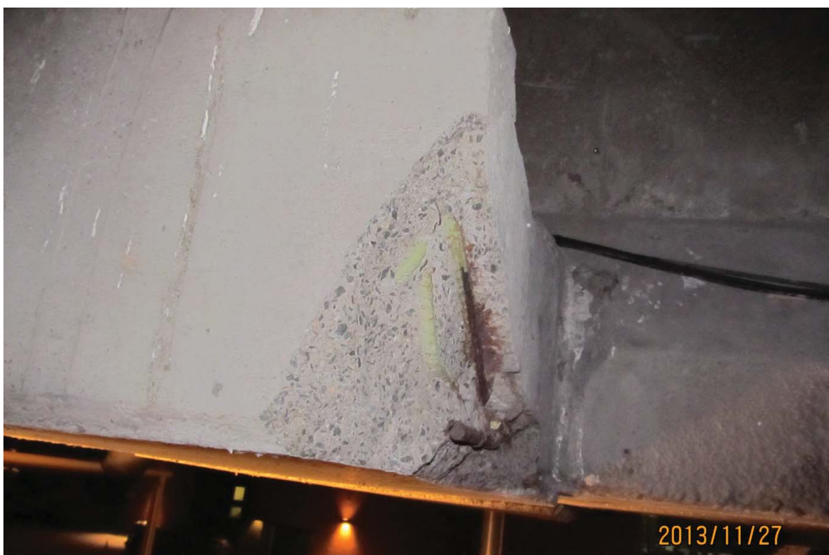
S5.PC.41W-42W.P7.d – 6455 (bloc d'ancrage PTE intérieur ouest)
