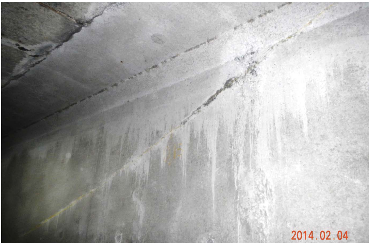
S5.PC.31W-32W.P4.k – 7507 (câble #19 – extrémité ouest face aval)
