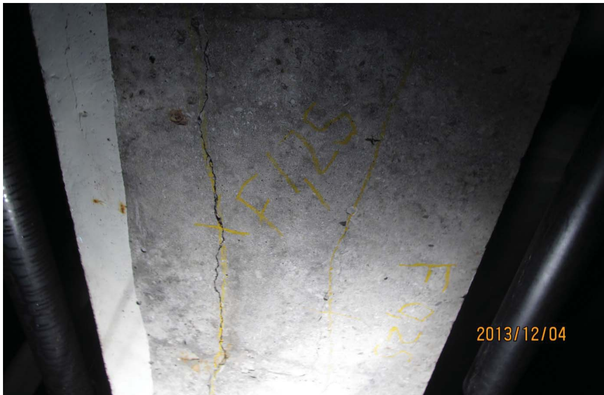
S5.PC.14W-15W.P1.d – 6583 (soffite – extrémité est)
