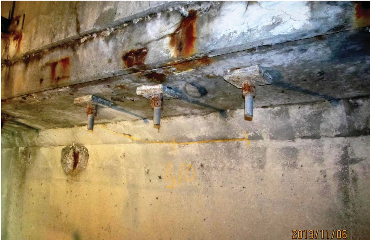
S5.PC.15W-16W.P7.a – 6146 (câble #18 – extrémité ouest face amont)
