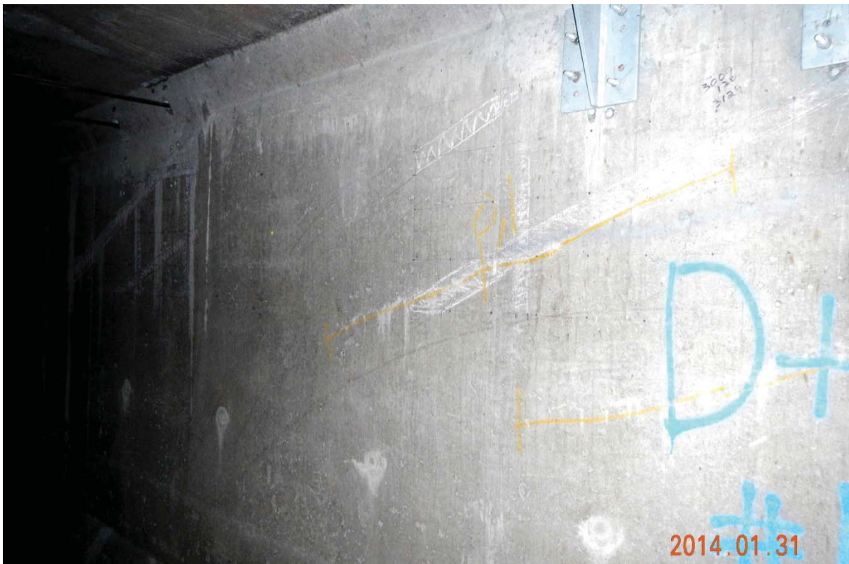
S5.PC.43W-44W.P4.d – 7472 (câbles #15 et #14 – extrémité est face amont)
