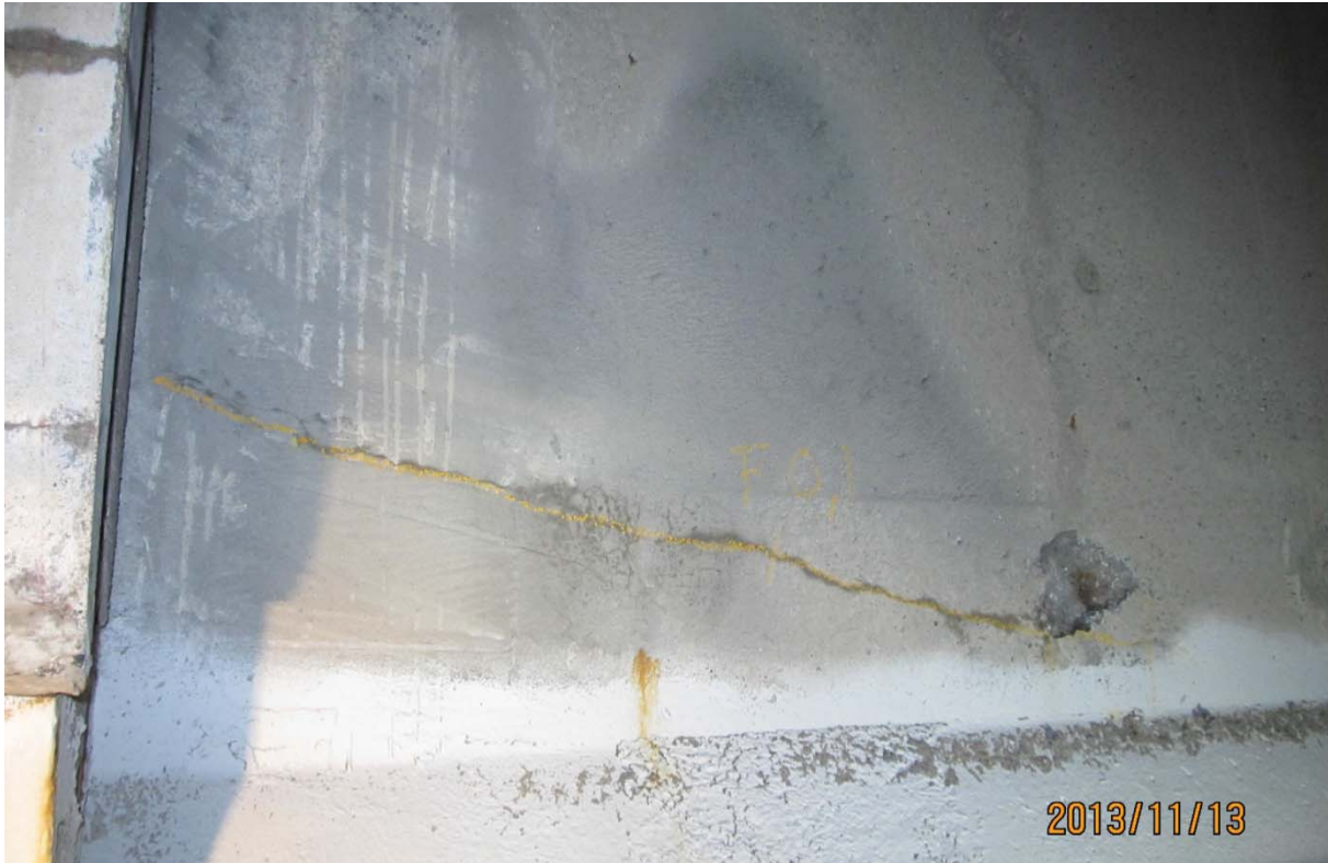
S5.PC.24W-25W.P7.c – 6270 (câble #22 – centre ouest face amont)
