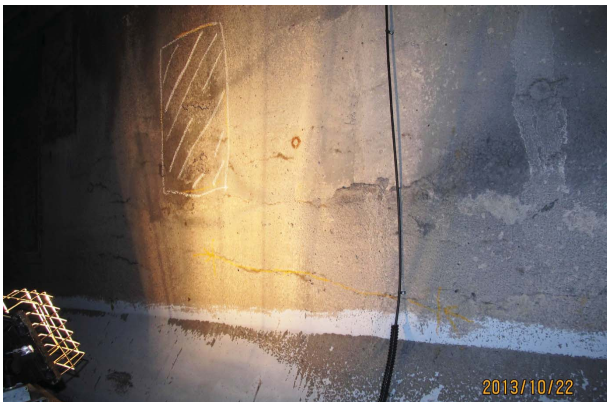
S7.PC.4E-5E.P1.b – 5890 (câble #11 - extrémité est face aval)
