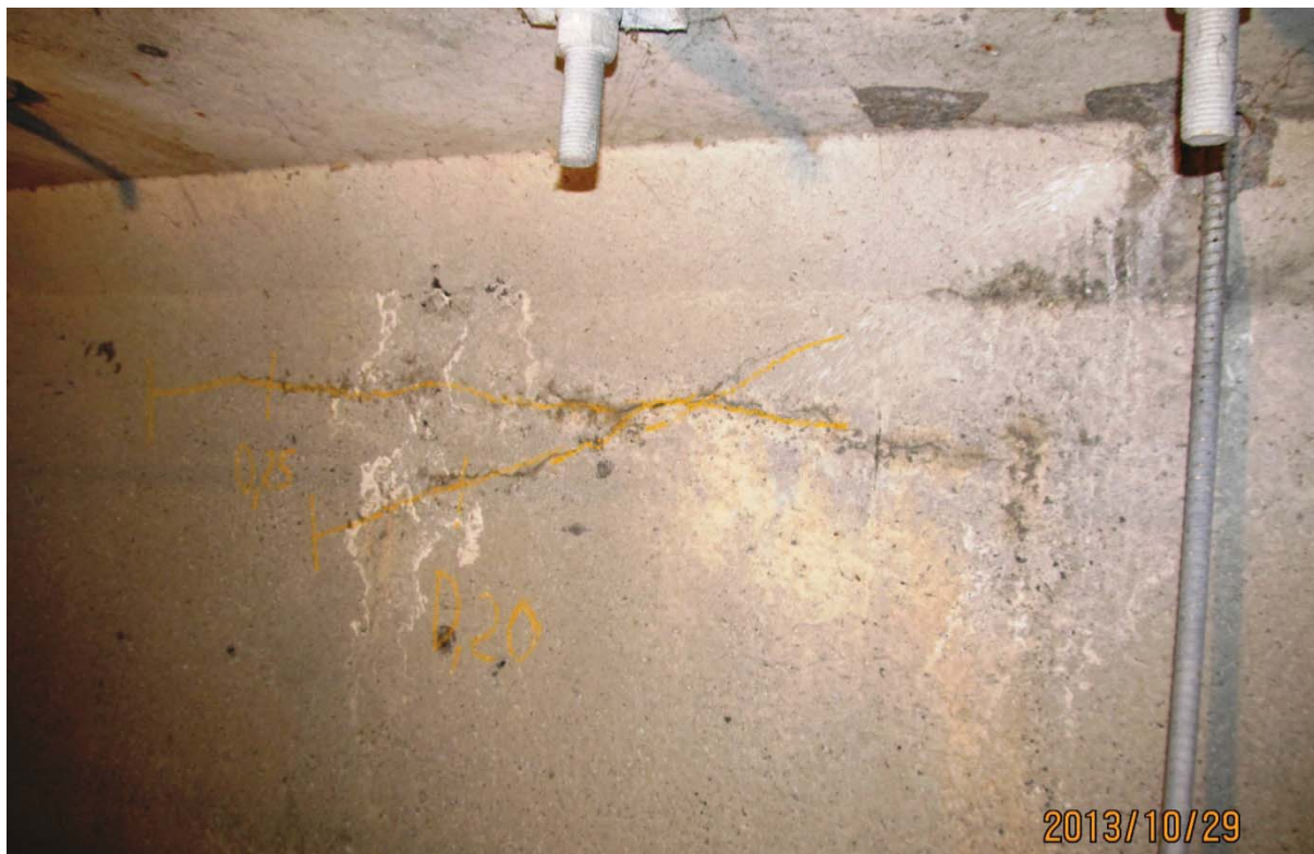
S5.PC.36W-37W.P1.c – 5960 (câble #20 - extrémité ouest face aval)
