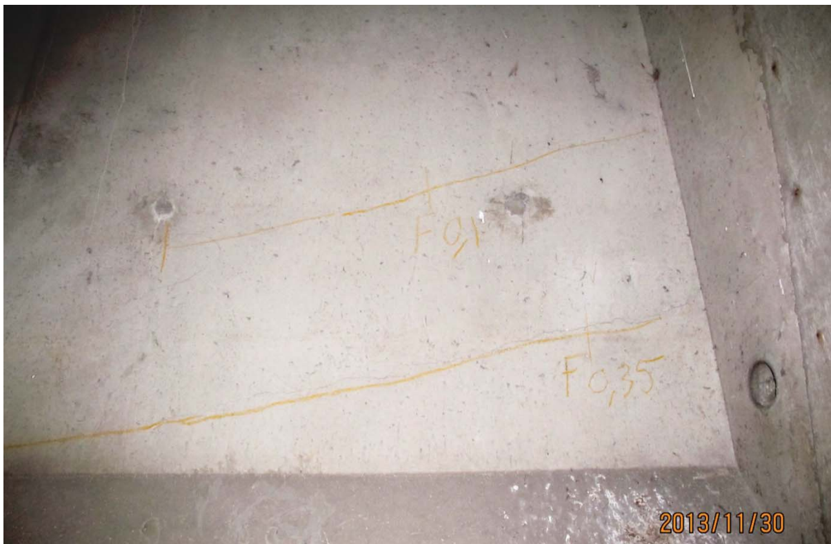
S5.PC.9W-10W.P7.g – 6505 (câbles #22 et #23 – centre ouest face aval)
