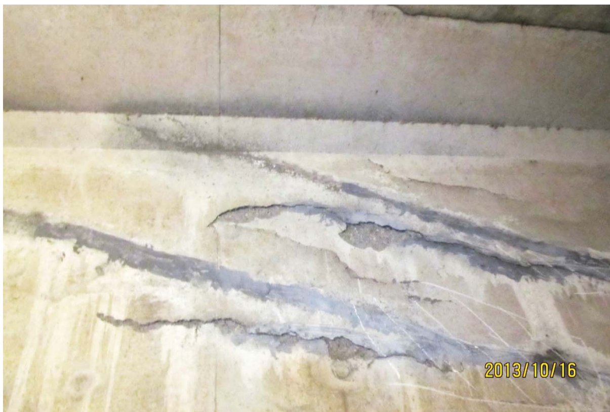
S5.PC.37W-38W.P1.f – 5807 (câbles #19 et #20 - extrémité ouest face amont)
