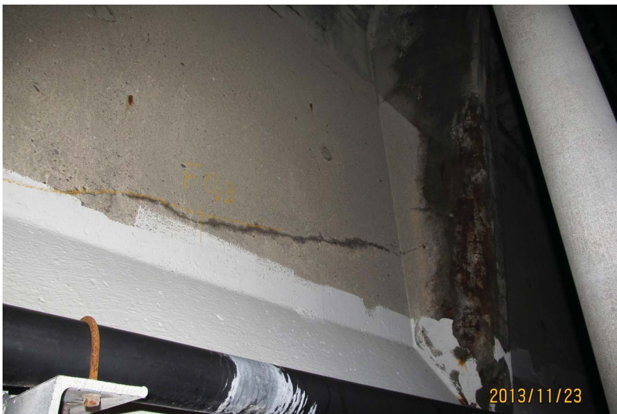
S5.PC.13W-14W.P7.d – 6410 (câble #22 – centre est face amont)
