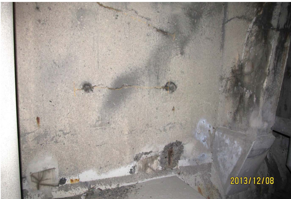
S5.PC.9W-10W.P1.b – 6677 (âme - extrémité ouest face aval)
