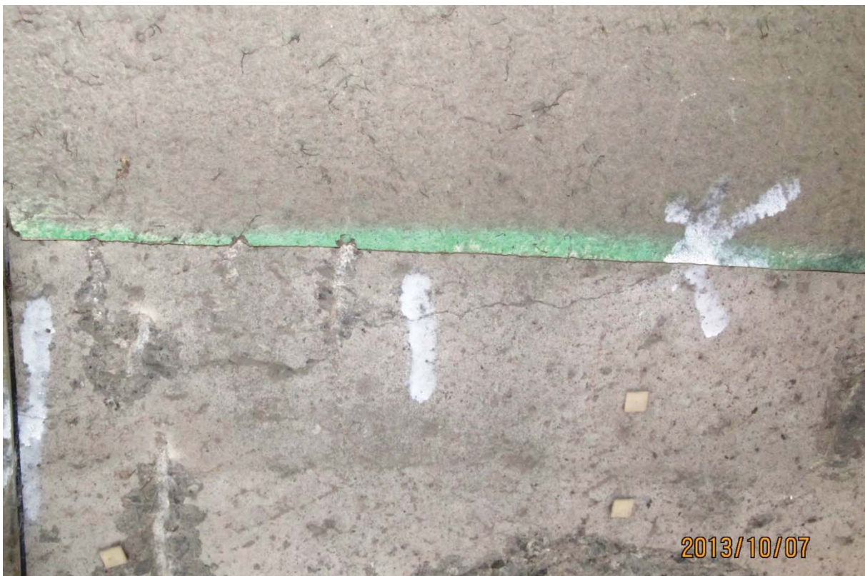
S5.PC.43W-44W.P7.d – 5674 (câble #16 - extrémité ouest face aval)
