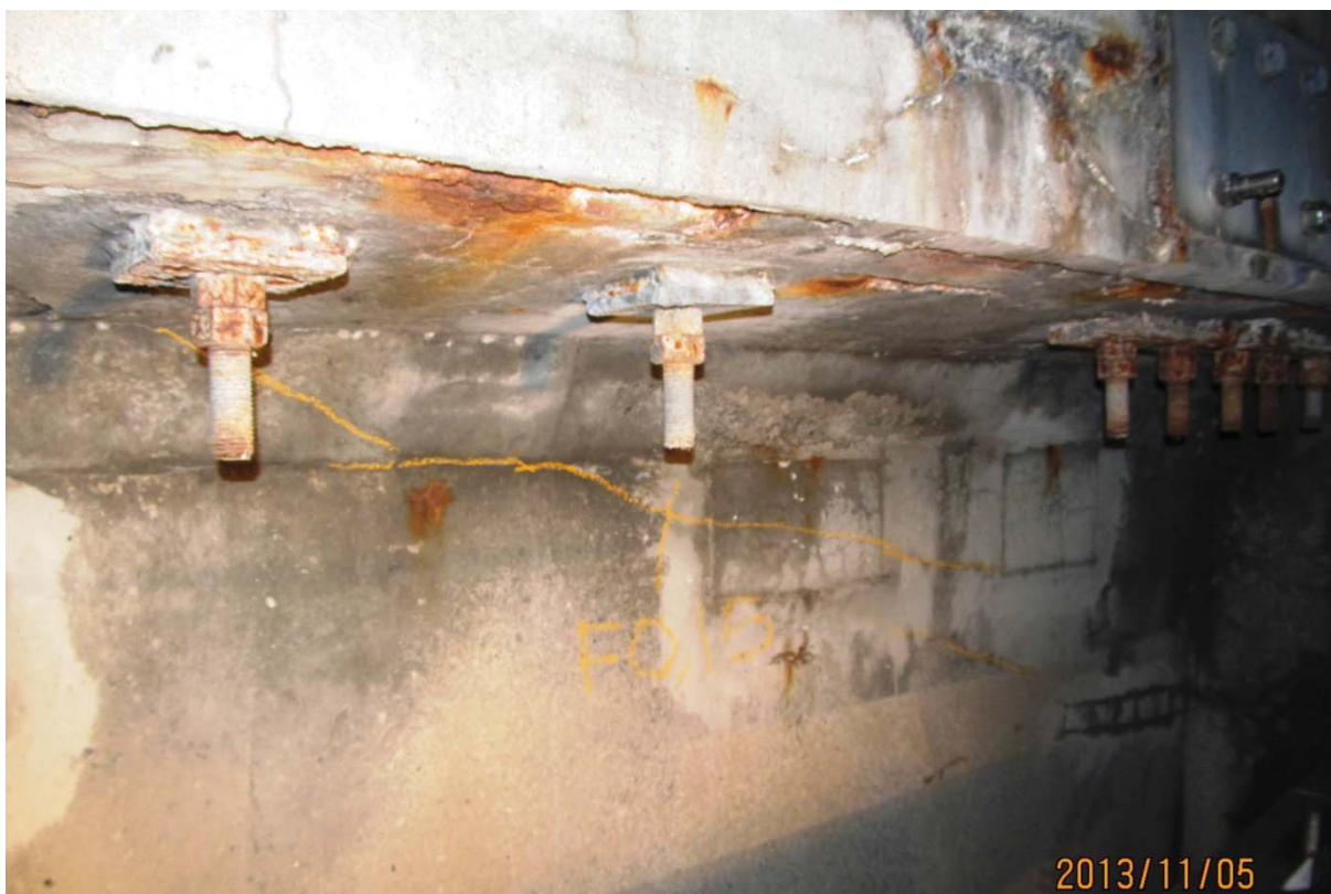
S5.PC.16W-17W.P7.d – 6097 (câbles #23 et #22 – extrémité ouest face amont)
