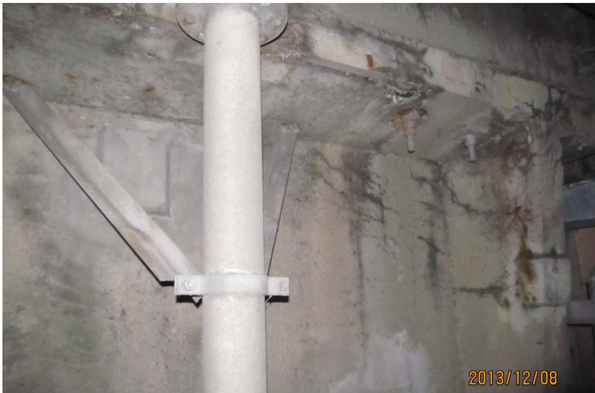
S5.PC.8W-9W.P1.d – 6665 (âme - extrémité ouest face aval)
