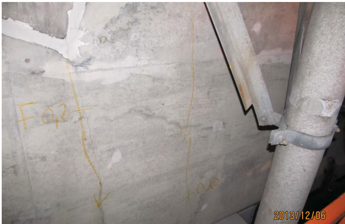
S5.PC.33W-34W.P7.a – 6638 (bloc d'ancrage QP 1.0 extérieur ouest)
