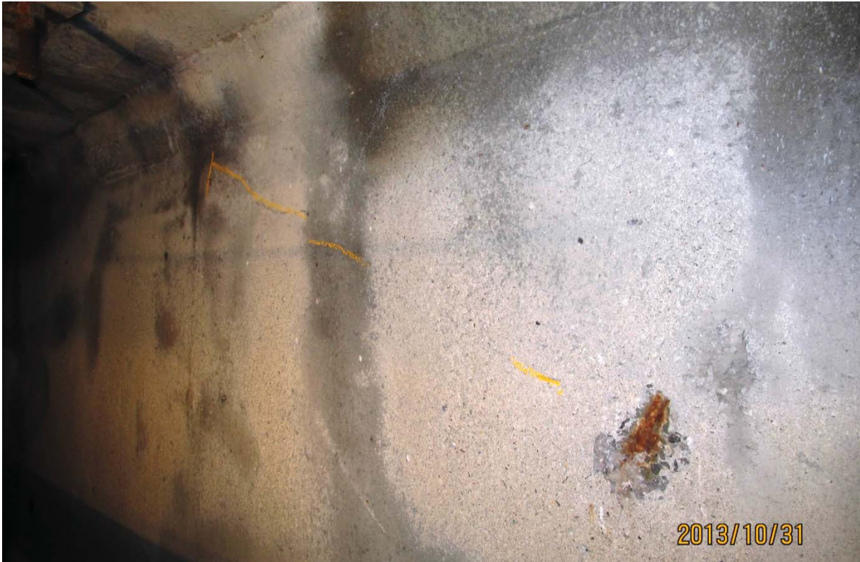
S5.PC.35W-36W.P1.a – 6063 (câble #20 - extrémité est face aval)
