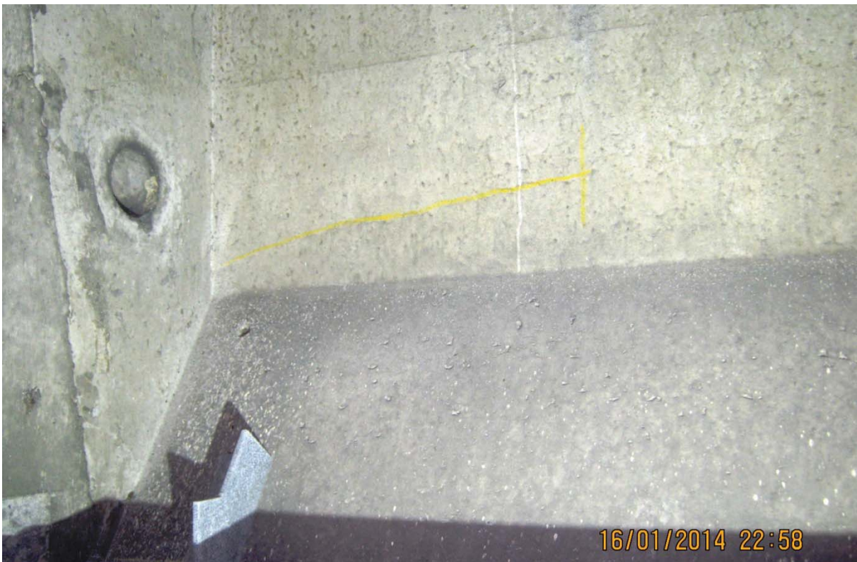
S5.PC.11W-12W.P1.b – 0288 (câble #21 - extrémité est face amont)
