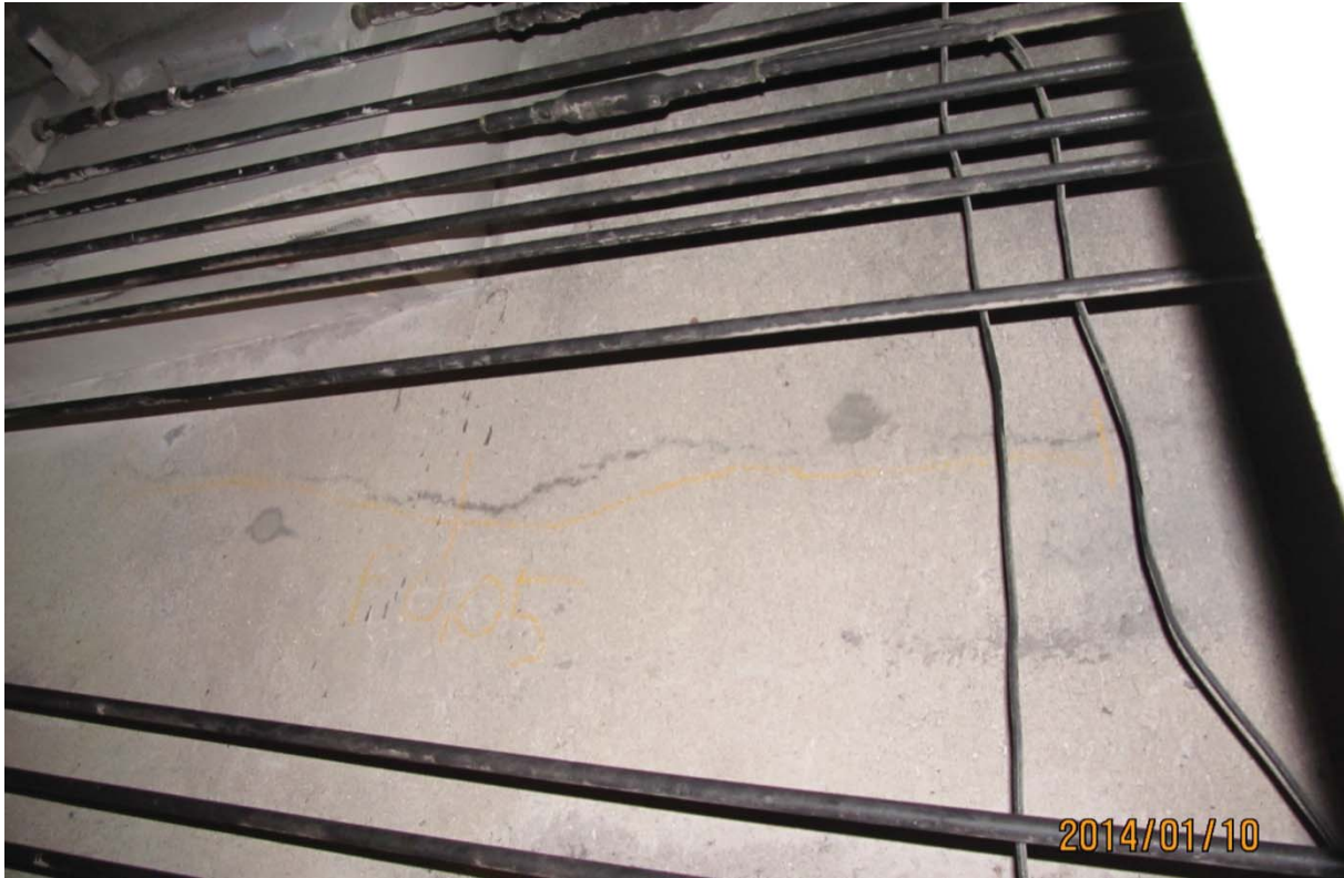
S7.PC.7E-8E.P1.a – 0120 (âme - extrémité est face aval)
