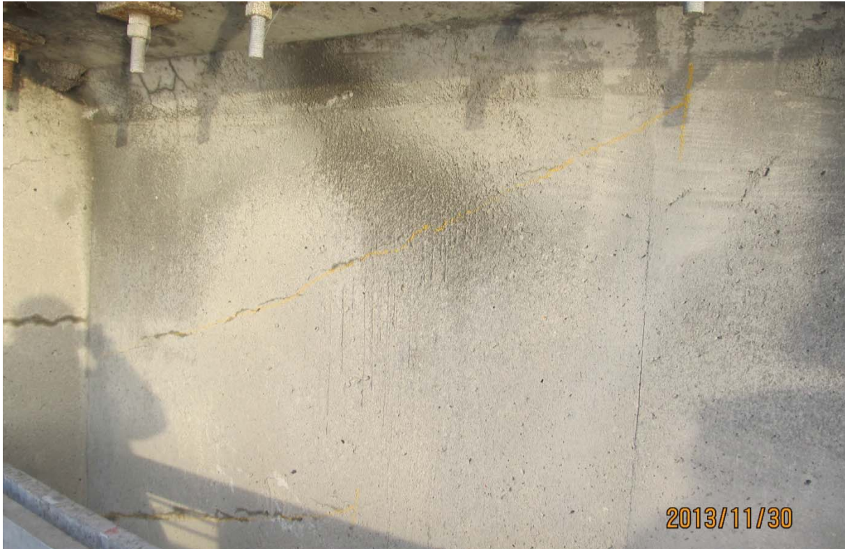
S5.PC.8W-9W.P7.e – 6530 (câbles #22 et #23 – extrémité est face amont)
