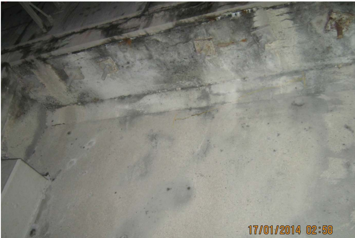
S5.PC.12W-13W.P1.b – 0297 (câble# 23 - extrémité ouest face aval)
