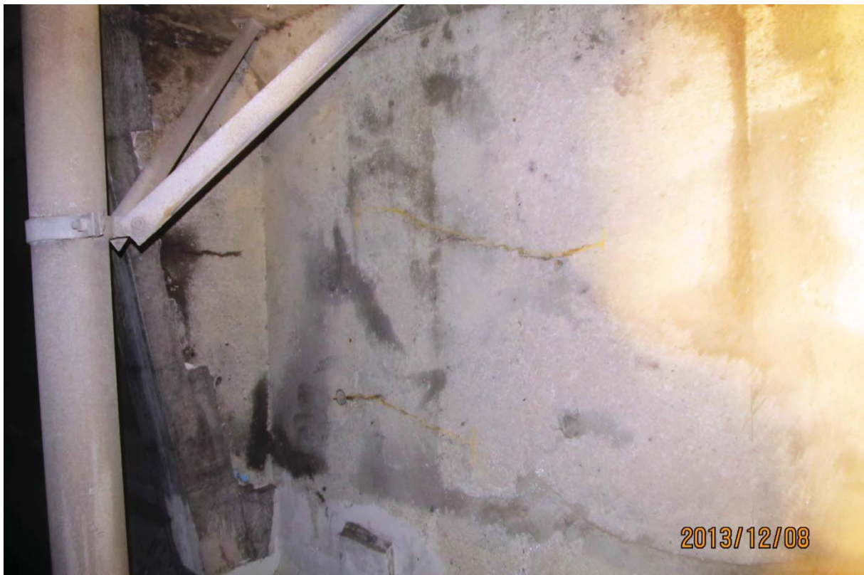
S5.PC.8W-9W.P1.b – 6662 (câbles #23 et #24 – centre est face aval)
