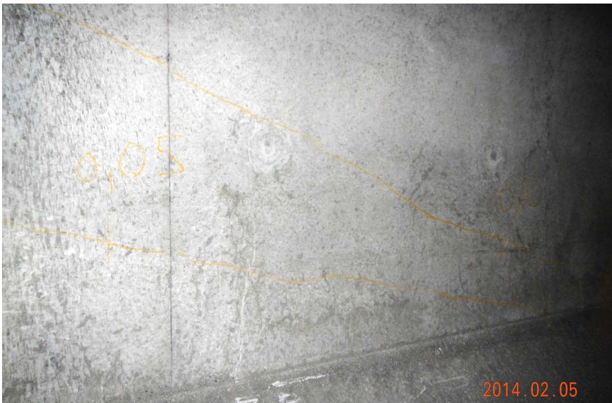
S5.PC.32W-33W.P4.b – 7518 (câbles #23 et #24 – centre ouest face amont)
