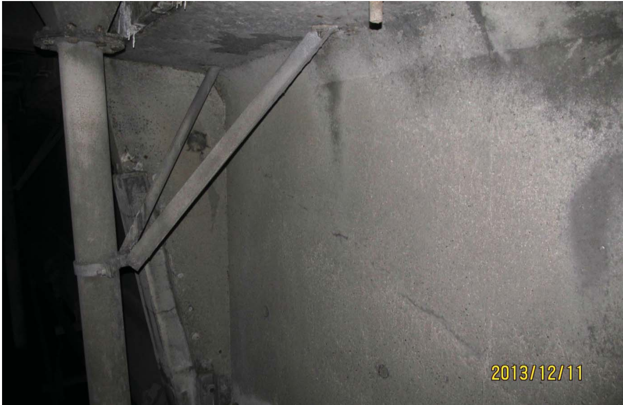
S5.PC.33W-34W.P1.c – 6743 (câble #24 - centre est face aval)
