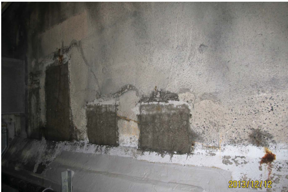
S5.PC.21W-22W.P7.c – 6766 (câble #23 – centre ouest face amont)
