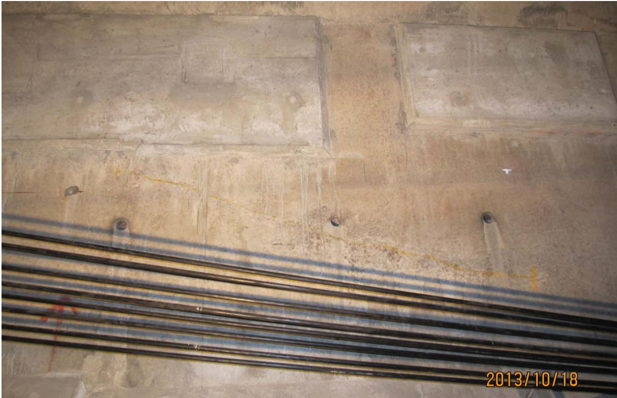
S5.PC.39W-40W.P1.c – 5820 (câble #20 - extrémité ouest face amont)
