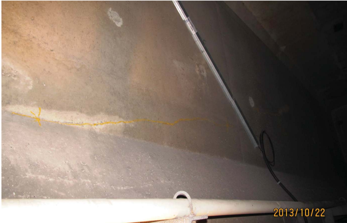
S7.PC.4E-5E.P1.e – 5889 (câble #15 - extrémité est face amont)
