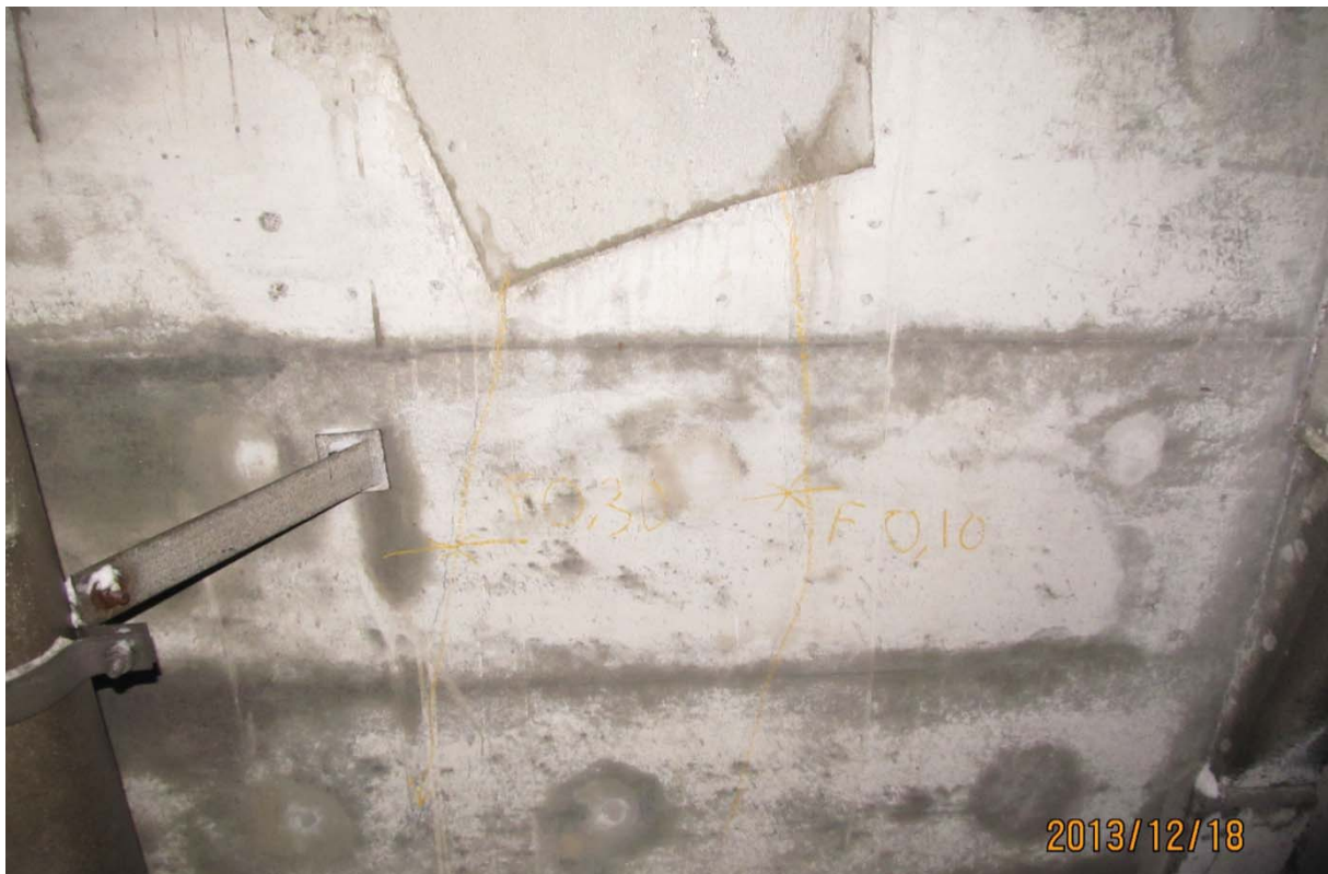
S5.PC.34W-35W.P1.b – 6826 (bloc d'ancrage QP 1.0 extérieur ouest)
