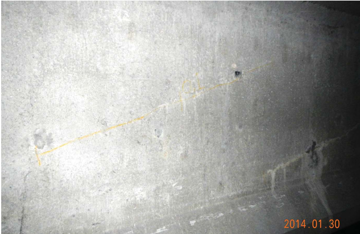
S5.PC.42W-43W.P4.a – 7466 (câble #19 – extrémité est face amont)
