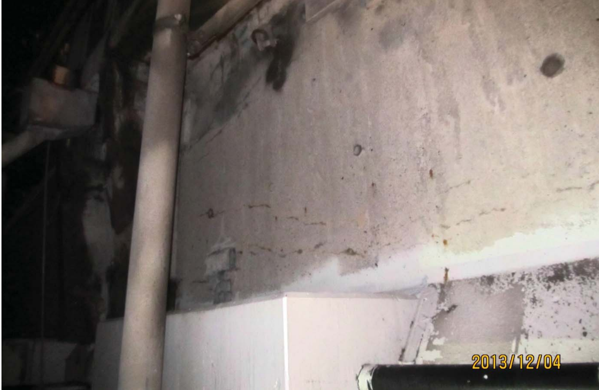
S5.PC.13W-14W.P1.a – 6572 (câbles #7 et #8 - extrémité est face aval)
