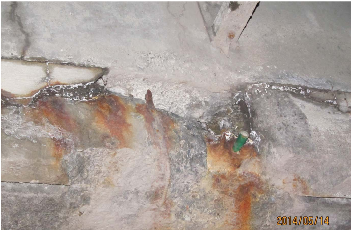
S5.PC.23W-24W.P1.f – 0488 (cachetage semelle supérieure - extrémité ouest face aval)
