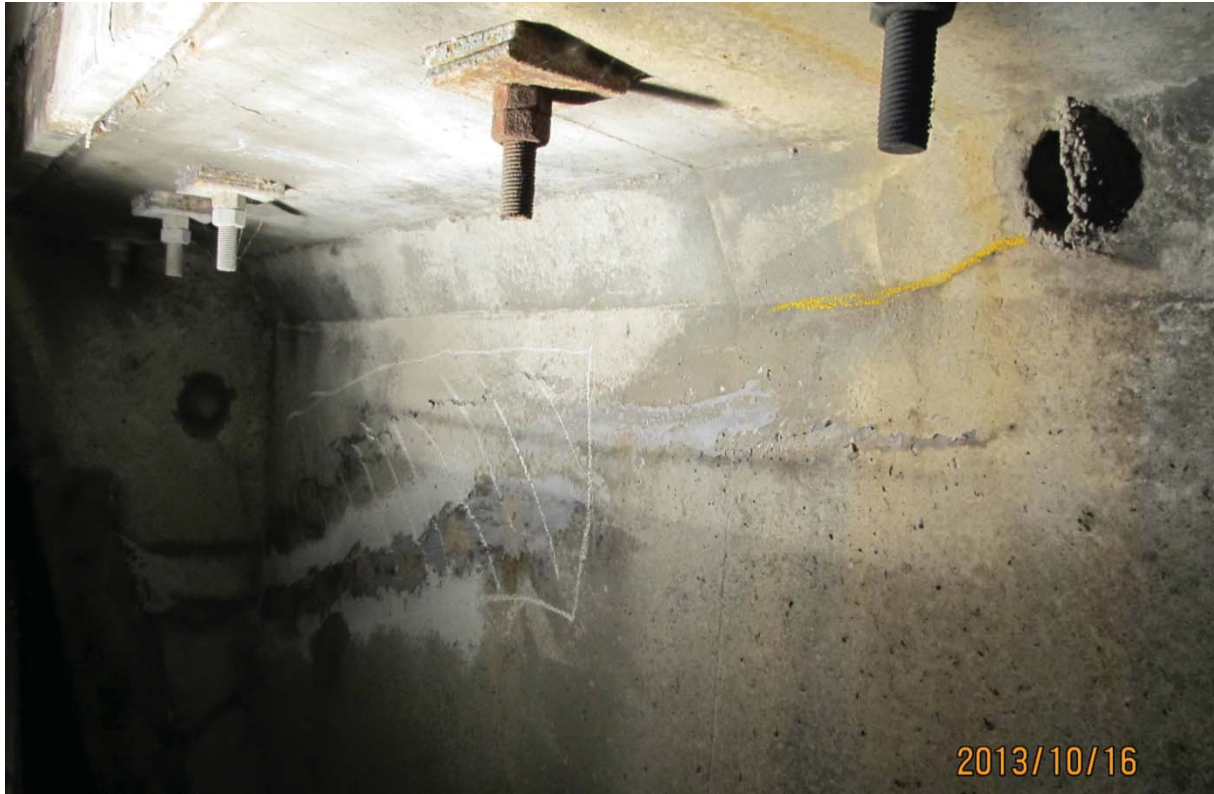
S5.PC.37W-38W.P1.c – 5804 (câble #23 - extrémité ouest face aval)
