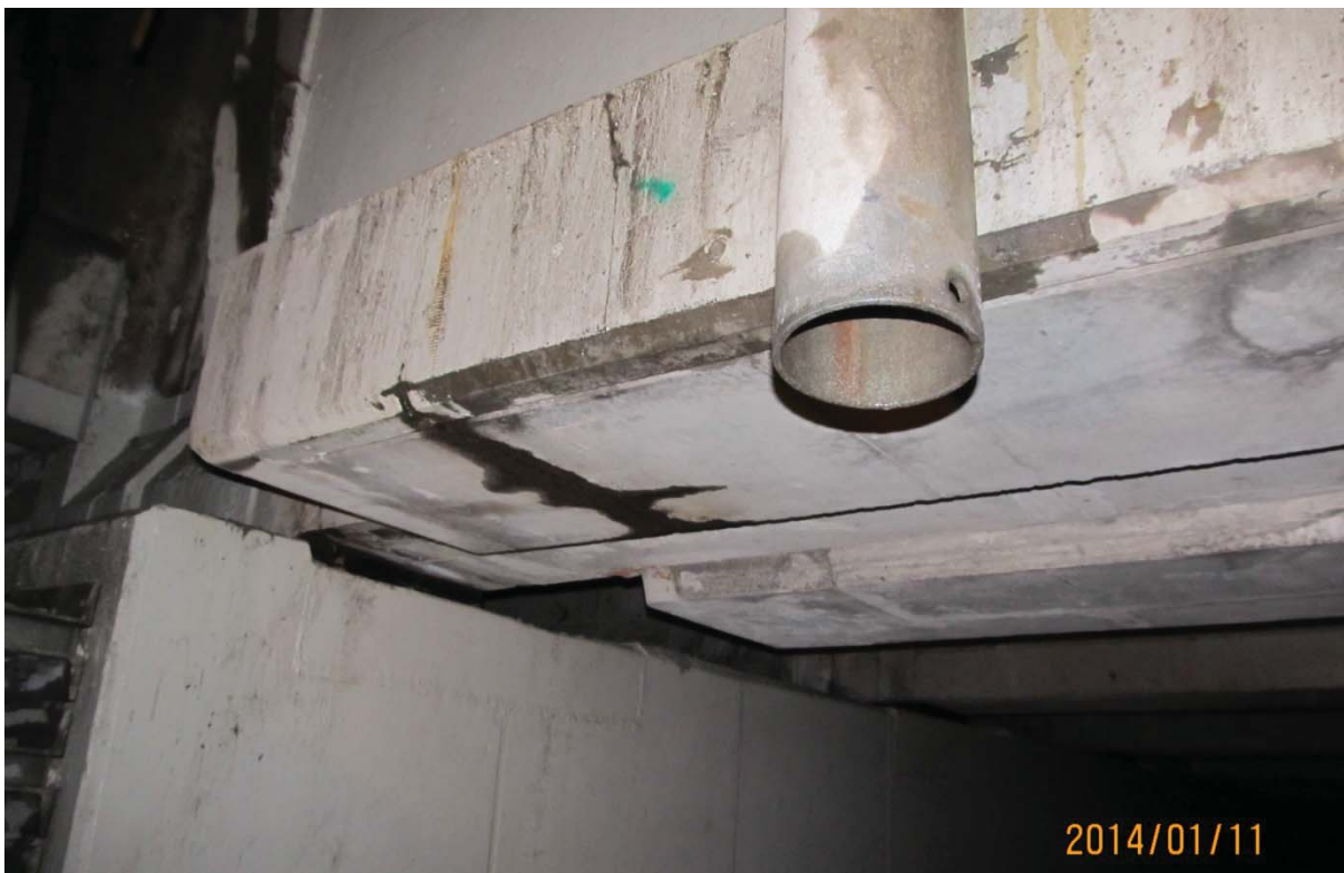
S5.PC.27W-28W.P1.a – 0131 (bloc d'ancrage extérieur est PTE)
