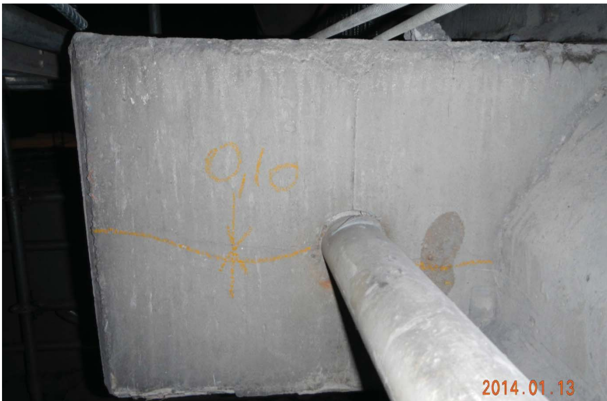
S7.PC.8E-9E.P7.a – 0702 (bloc d'ancrage extérieur est – post tension extérieure)
