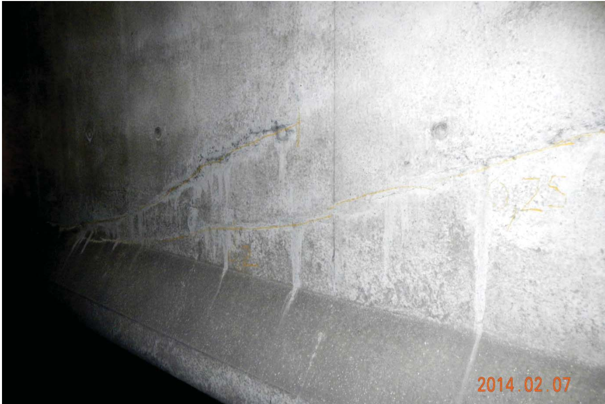
S5.PC.33W-34W.P4.a – 7545 (câbles #23 et #24 – centre est face amont)
