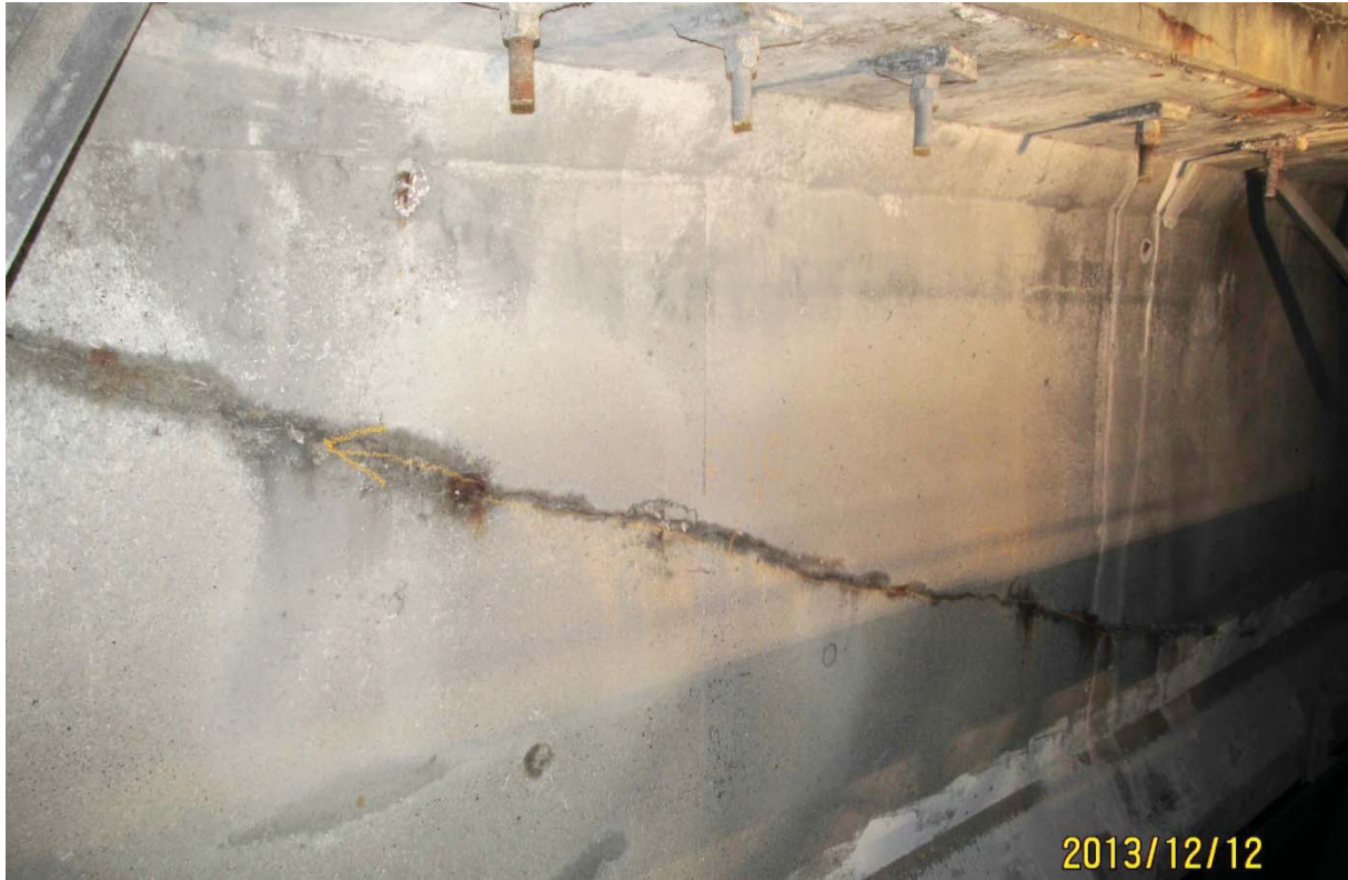
S5.PC.31W-32W.P7.a – 6783 (câble #19 - extrémité ouest face amont)
