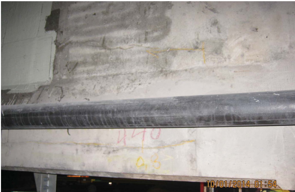
S7.PC.11E-12E.P1.d – 0261 (câble #22 – centre ouest face amont)
