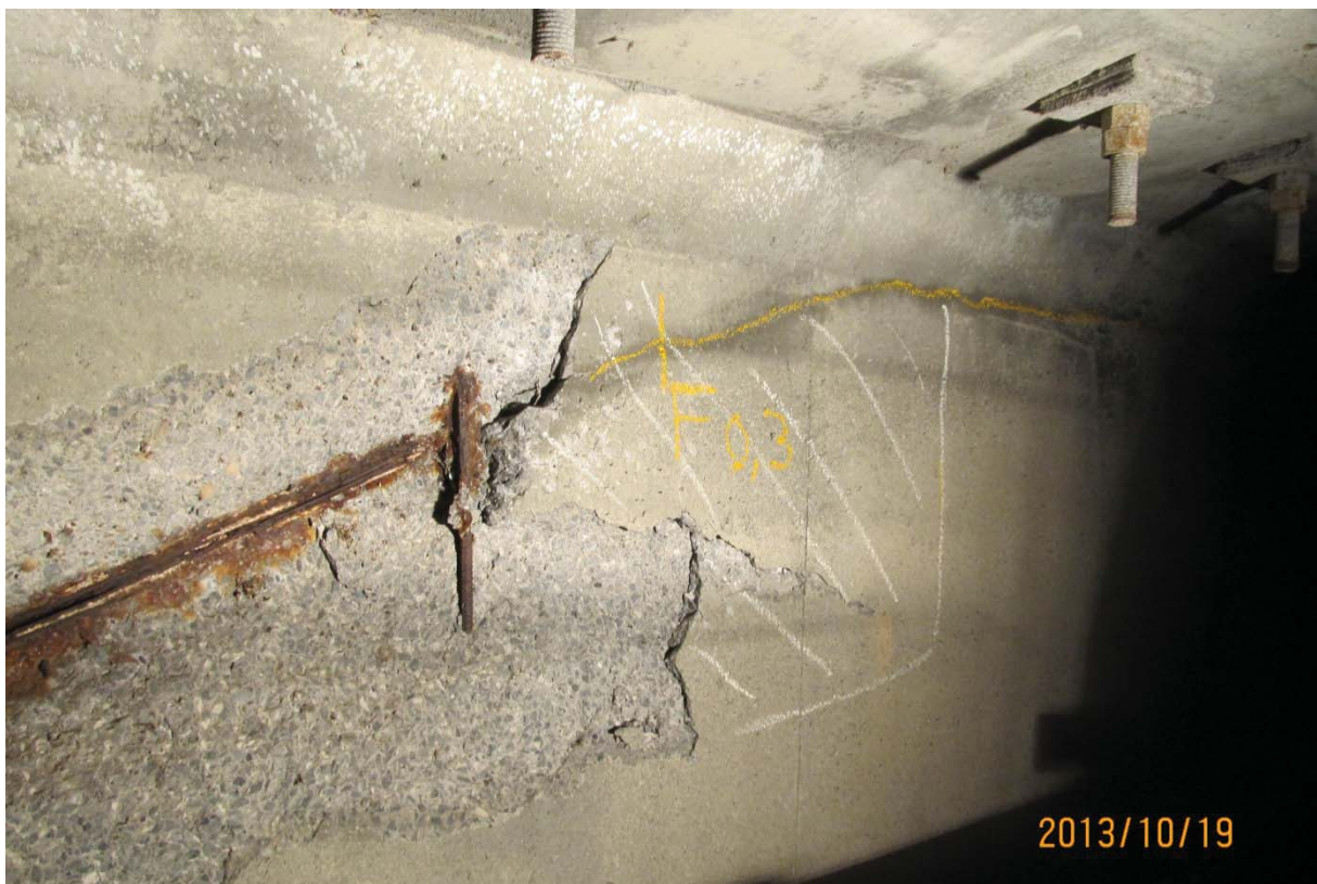
S5.PC.35W-36W.P7.b – 5843 (câble #23 - extrémité est face amont)
