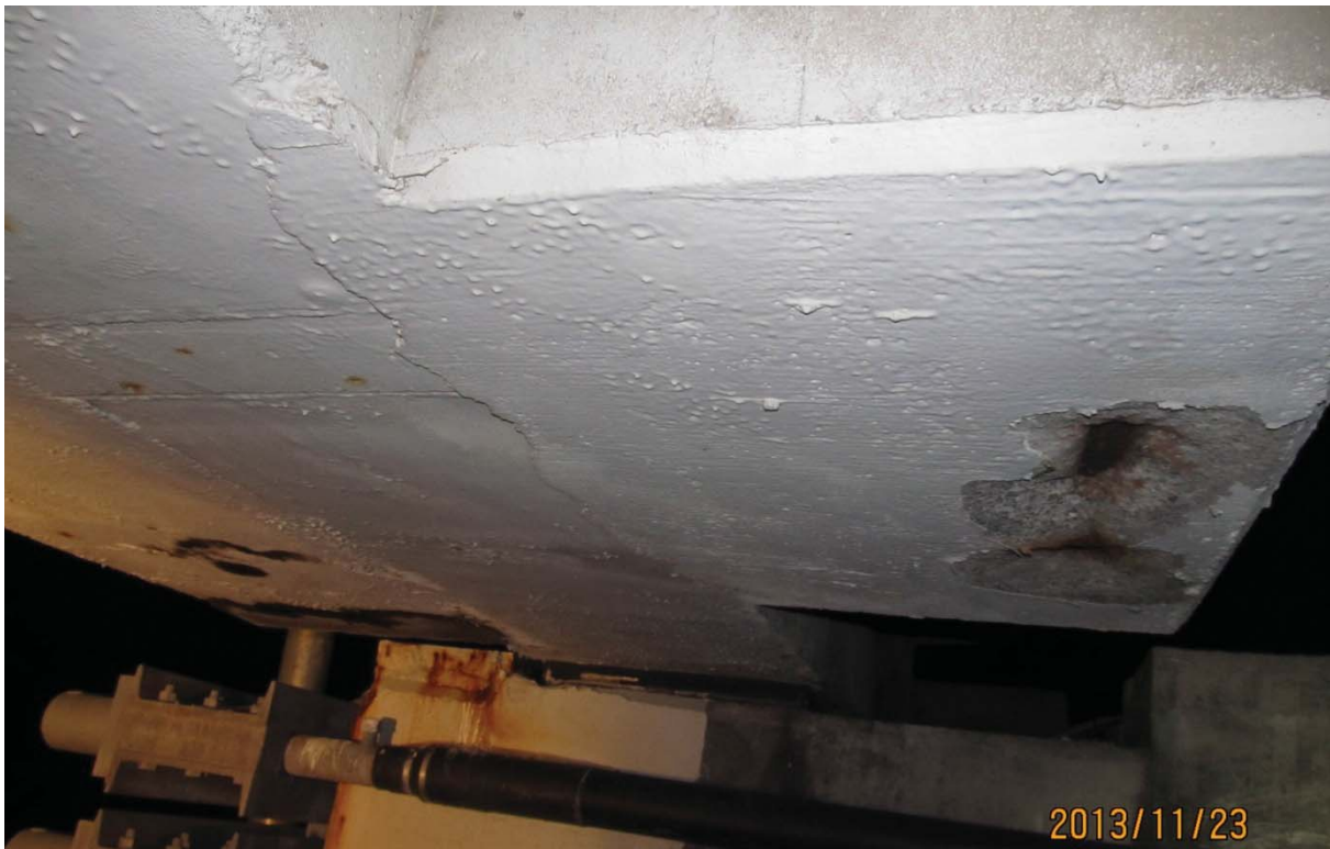
S5.PC.13W-14W.P7.h – 6405 (bloc d'ancrage intérieur ouest)
