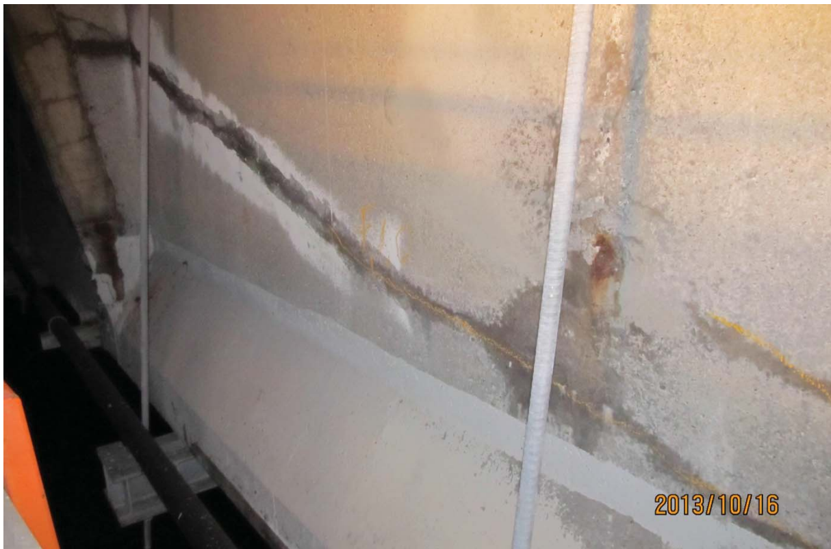
S5.PC.37W-38W.P1.b – 5790 (câbles #23 et #24 - extrémité est face aval)
