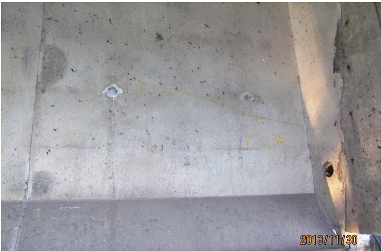
S5.PC.8W-9W.P7.f – 6529 (câble #22 – extrémité est face aval)
