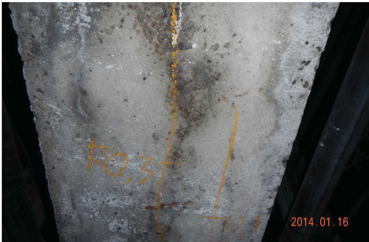
S7.PC.12E-13E.P1.d – 7416 (soffite – extrémité est)
