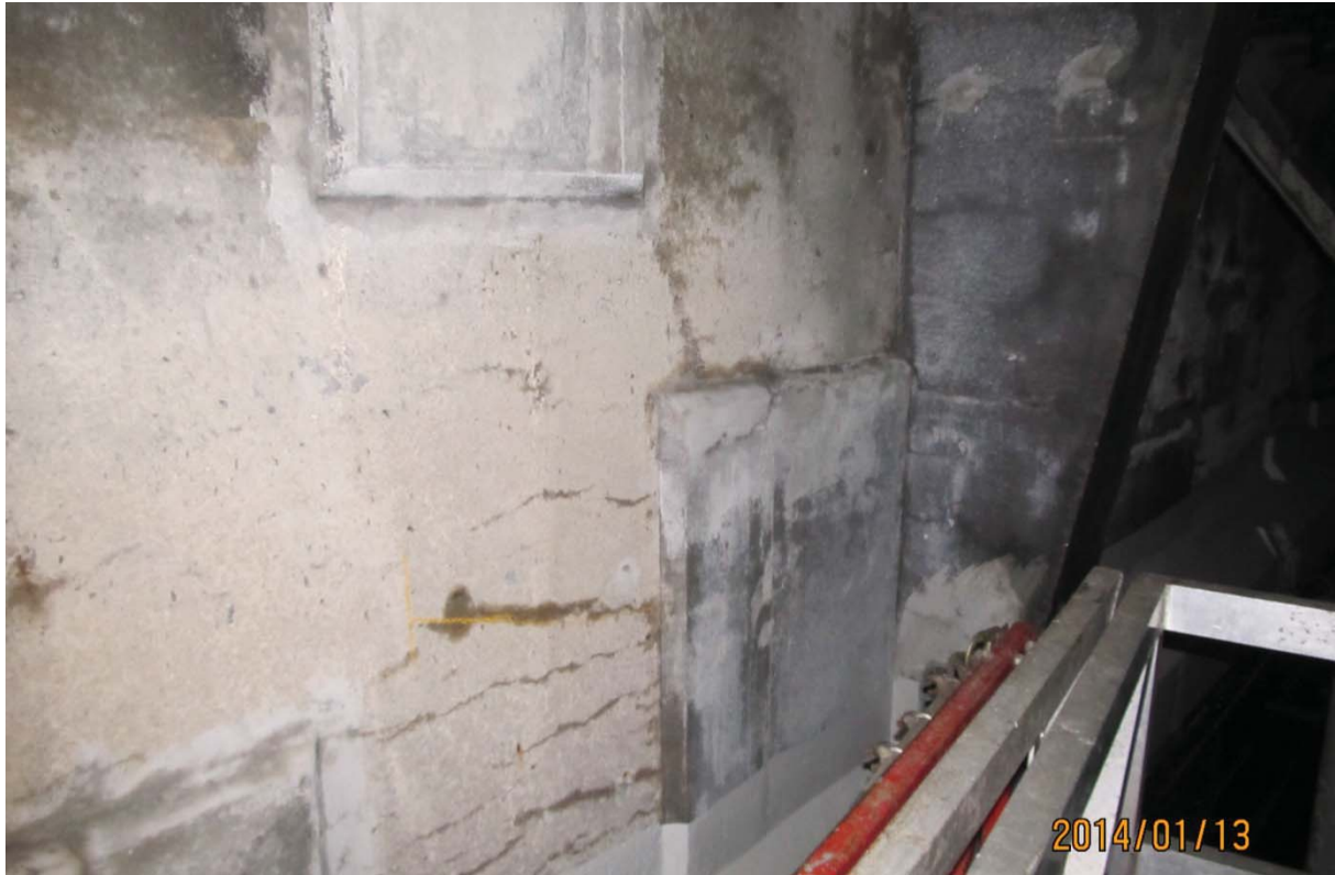
S7.PC.6E-7E.P7.a – 0157 (câble #22 - extrémité ouest face amont)
