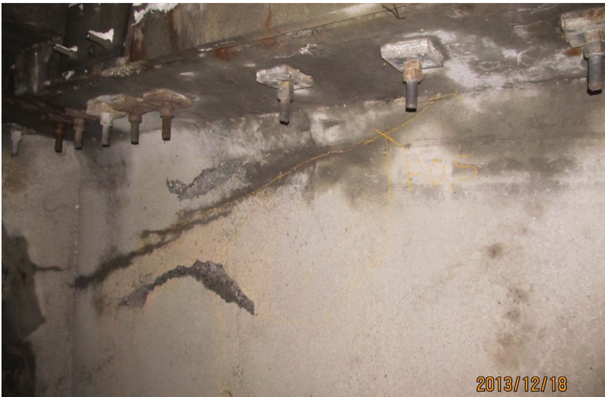
S5.PC.34W-35W.P1.d – 6824 (câble #23 – extrémité ouest face aval)
