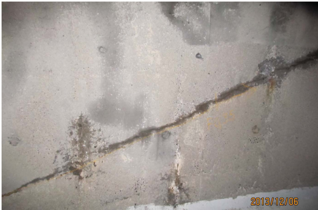
S5.PC.34W-35W.P7.d – 6628 (câble #24 – centre est face amont)
