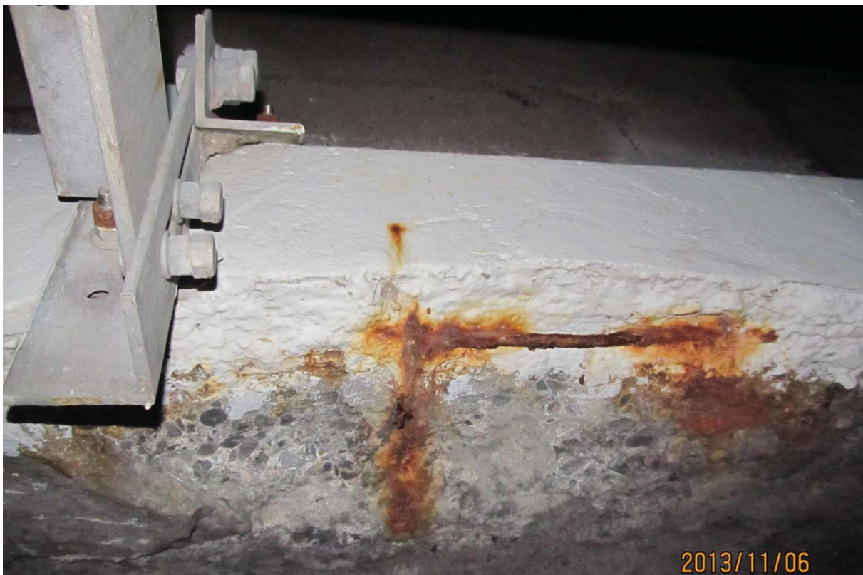
S5.PC.17W-18W.P7.k – 6143 (soffite – extrémité est)
