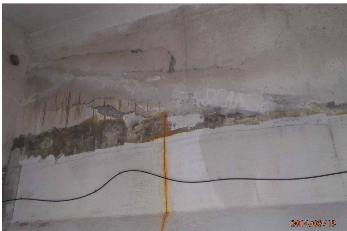
S5.PC.31W-32W.P7.l – PH.20140813_P7_31W-32W_039 (câble #24 - extrémité centre face aval)
