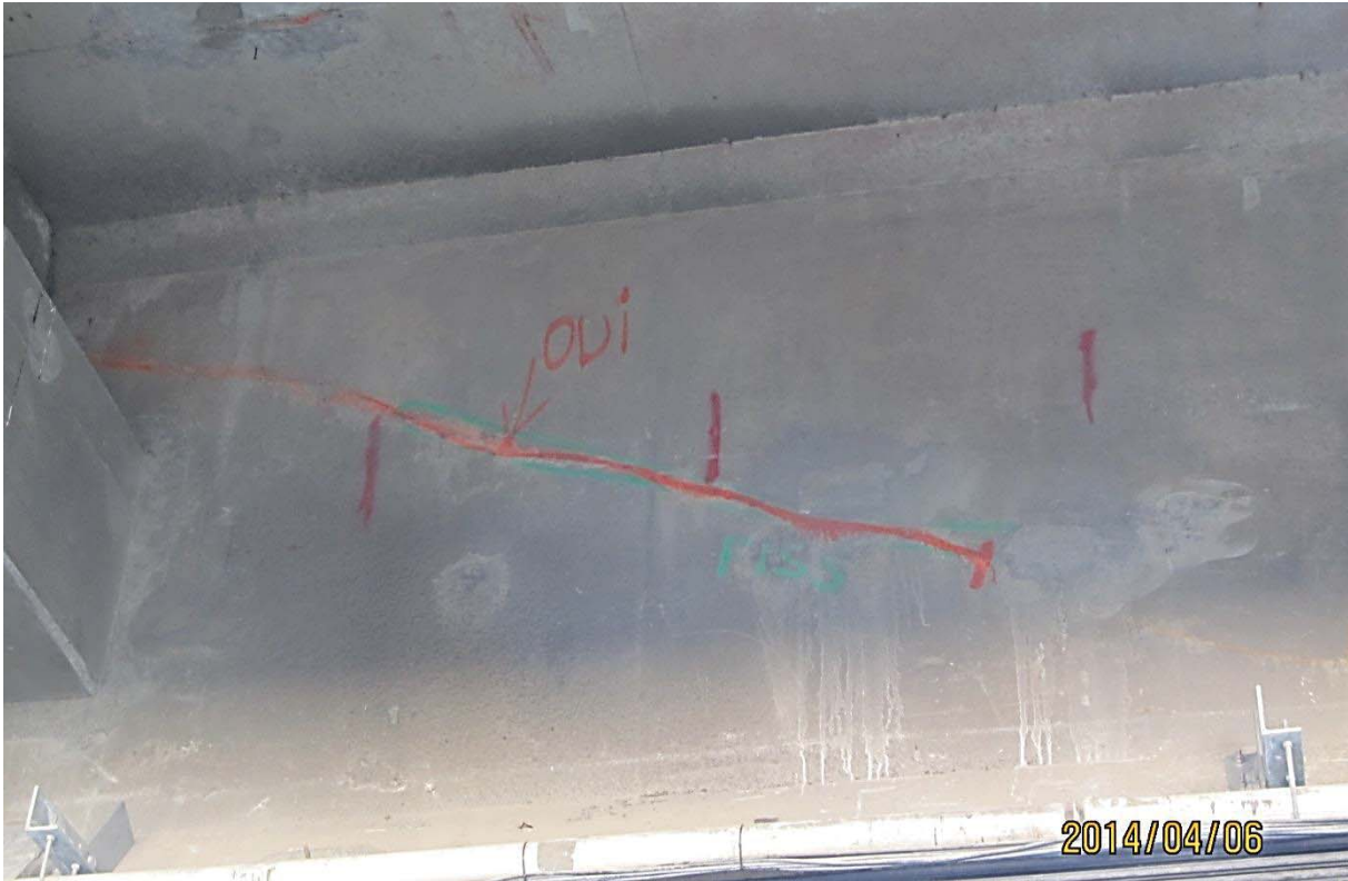
S5.PC.42W-43W.P1.c – 0410 (câble #24 - centre ouest face amont)
