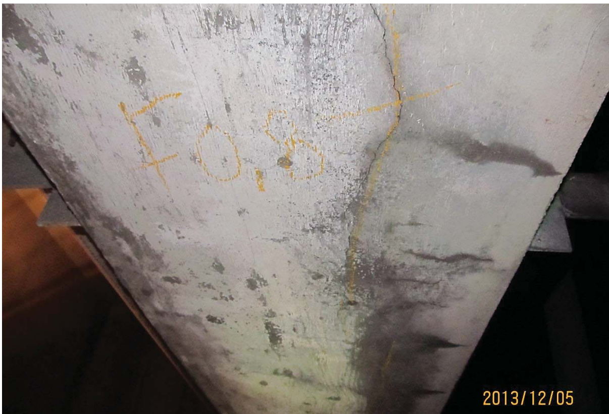
S5.PC.04W-05W.P7.j – 6597 (soffite – extrémité ouest)
