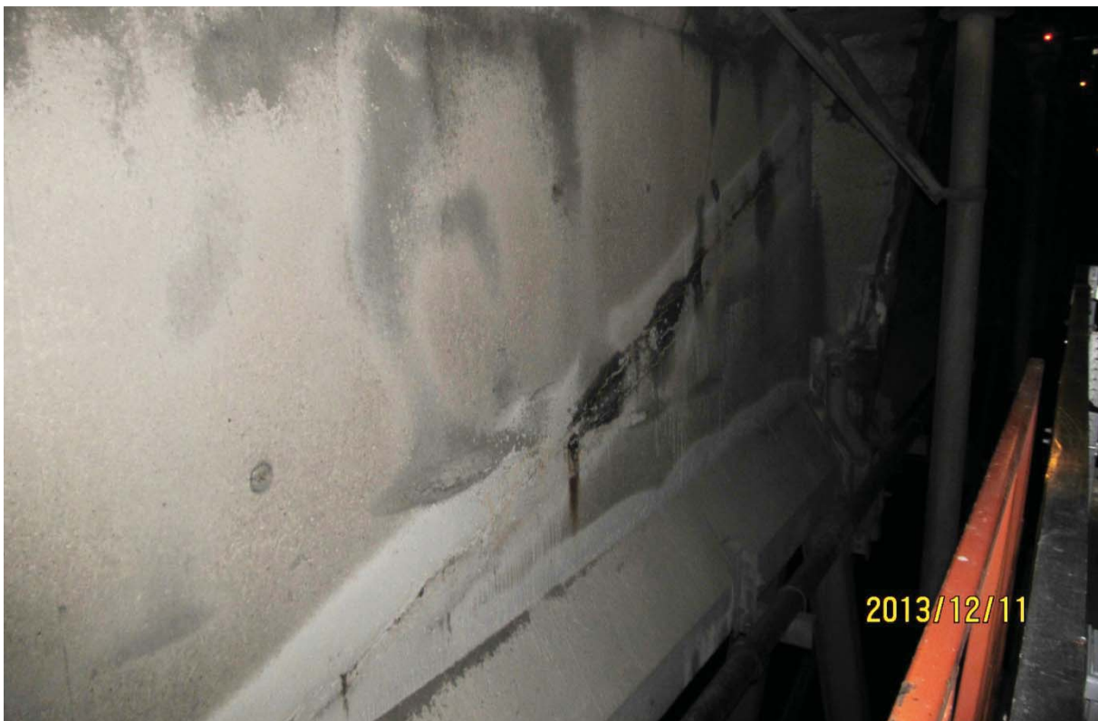
S5.PC.33W-34W.P1.d – 6744 (câble #24 - centre ouest face aval)
