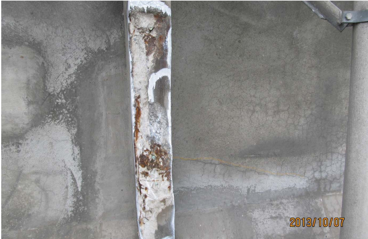
S5.PC.43W-44W.P7.a – 5681 (câble #22 - centre ouest face amont)
