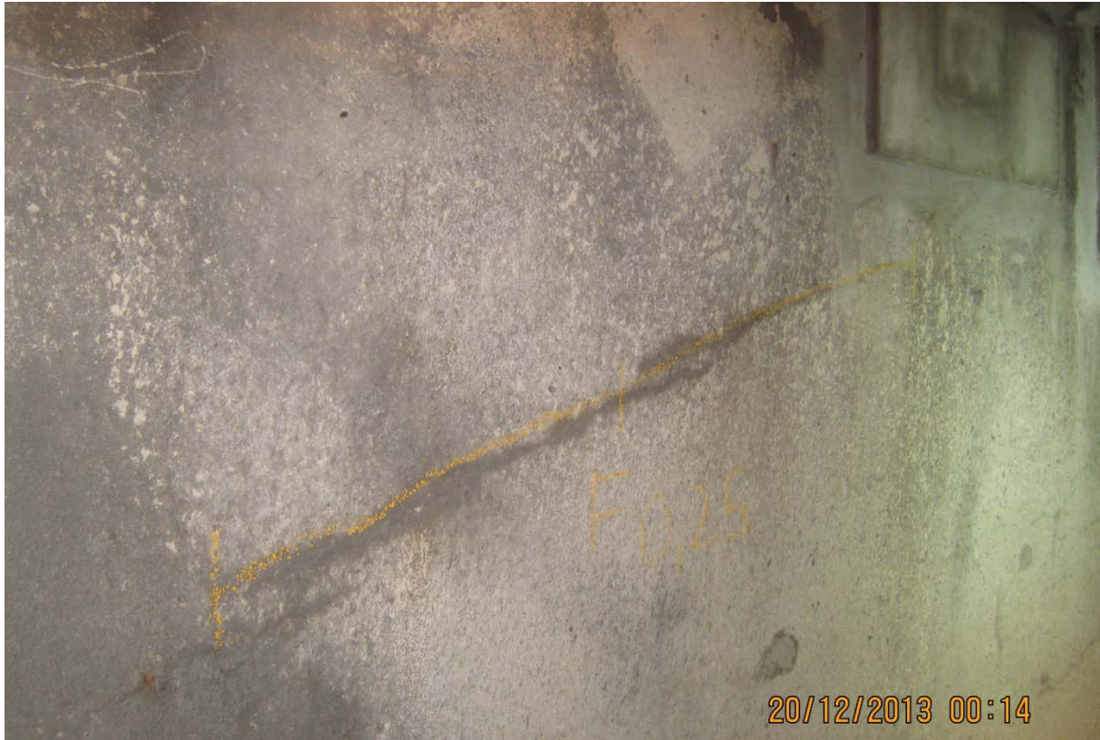
S7.PC.6E-7E.P1.a – 0251 (câble #20 - extrémité ouest face aval)
