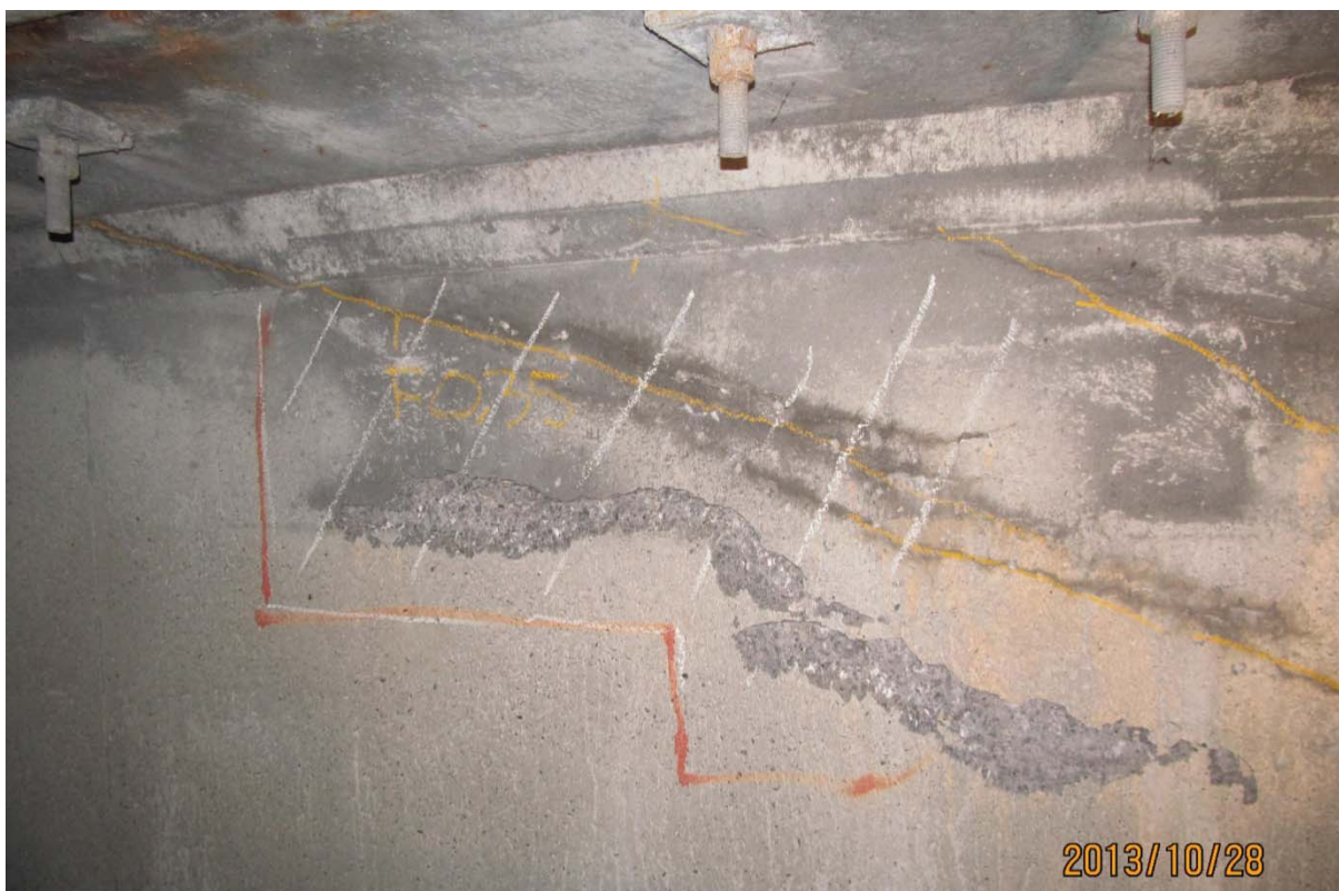
S5.PC.40W-41W.P1.b – 5941 (câbles #17 et #18 - extrémité est face aval)
