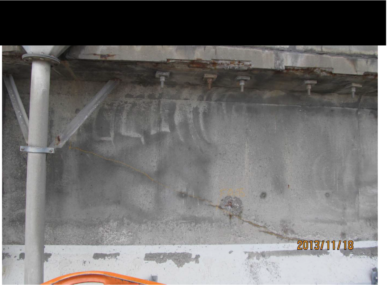
S5.PC.43W-44W.P1.c – 6323 (câble #24 - centre est face aval)
