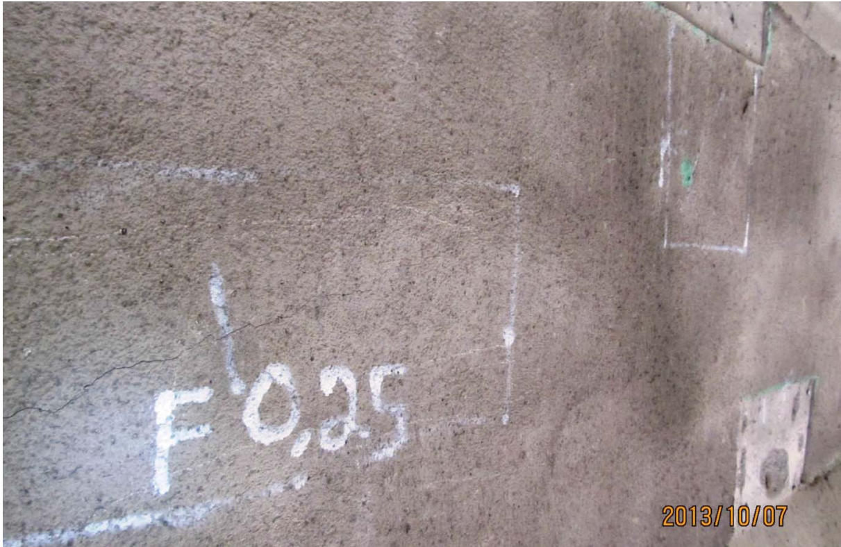
S5.PC.43W-44W.P7.c – 5676 (câble #19 - extrémité ouest face aval)
