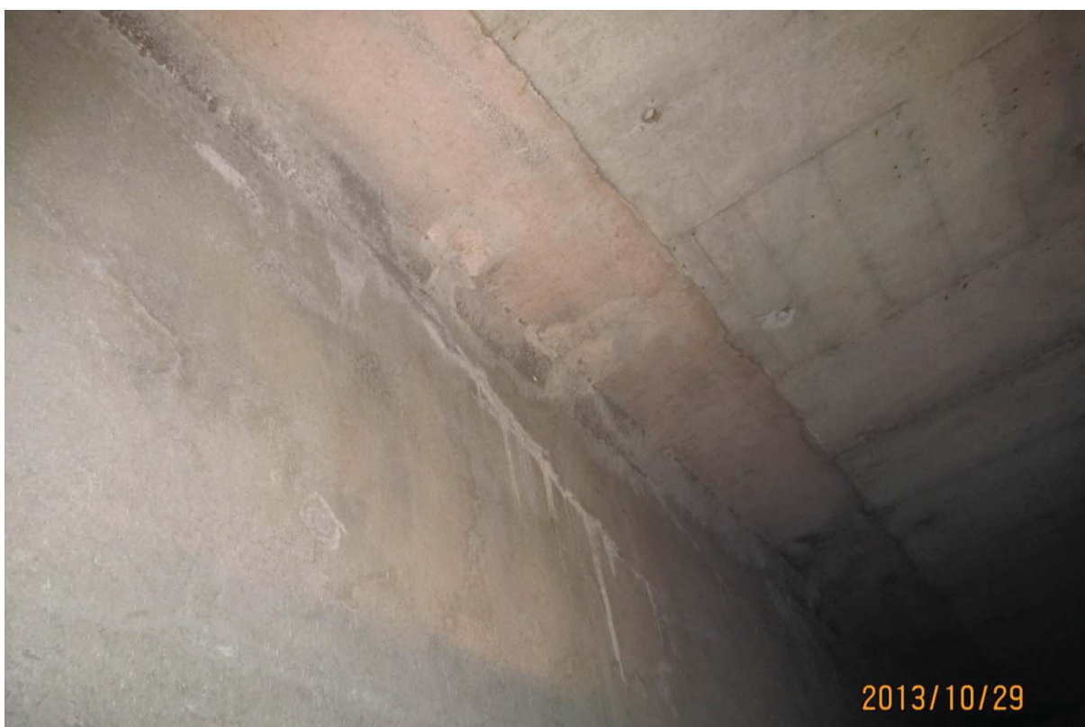
S5.PC.40W-41W.P1.f – 5945 (câbles #18, #19 et #20 – extrémité ouest face amont)
