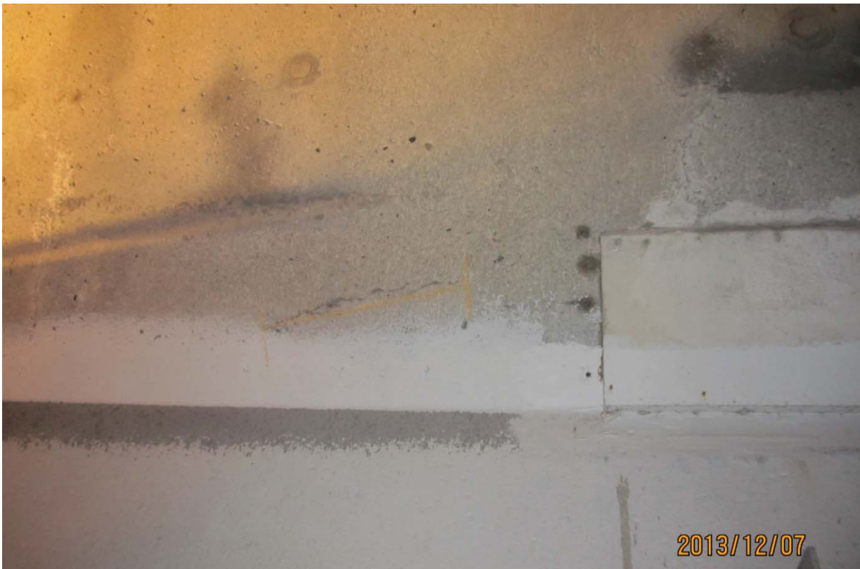
S5.PC.14W-15W.P1.b – 6644 (câble 19 - extrémité ouest face aval)
