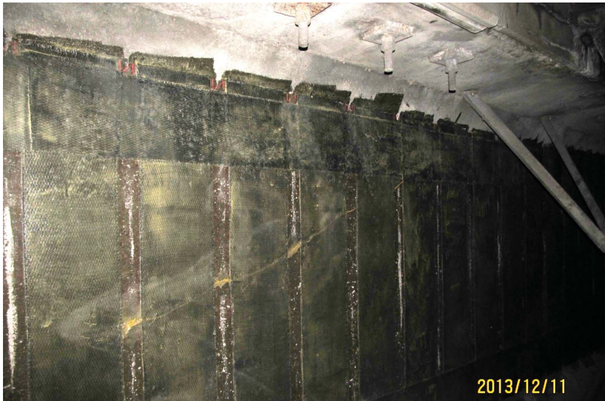
S5.PC.32W-33W.P1.f – 6732 (câble #19 – extrémité ouest face aval)
