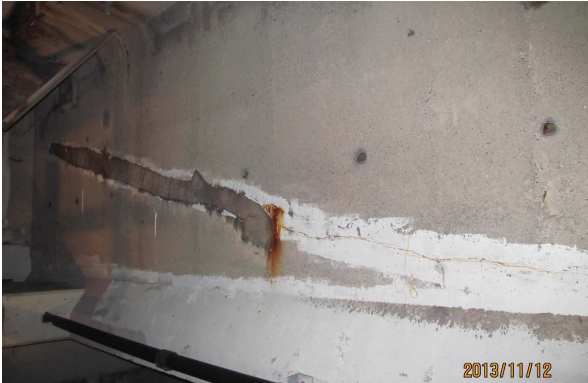
S5.PC.28W-29W.P7.a – 6243 (câble #15 – extrémité ouest face amont)
