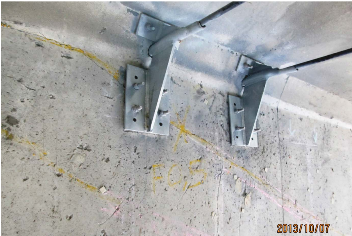
S5.PC.43W-44W.P7.b – 5678 (câbles #17 et #18 - extrémité est face aval)
