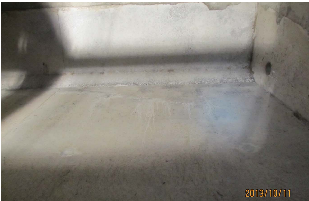
S5.PC.38W-39W.P1.c – 5741 (câble #23 - extrémité ouest face amont)
