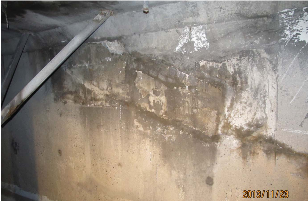
S5.PC.29W-30W.P7.c – 6386 (câble #19 – extrémité ouest face amont)
