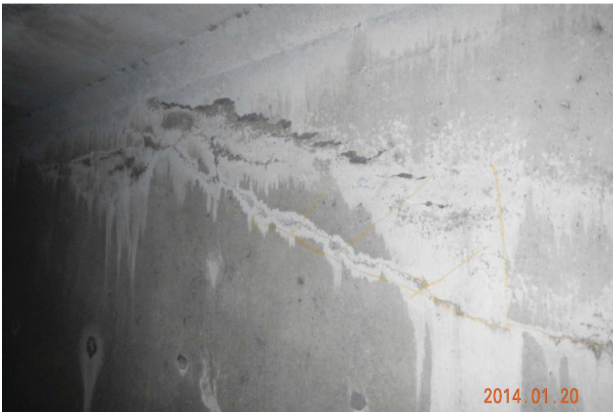
S5.PC.28W-29W.P4.d – 7441 (câble #17 – extrémité est face aval)
