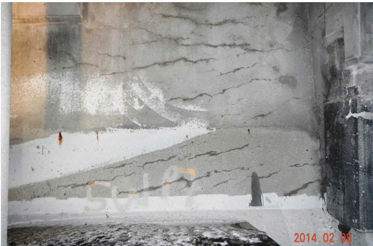
S5.PC.5W-6W.P7.d – 7569 (âme – extrémité est face amont)
