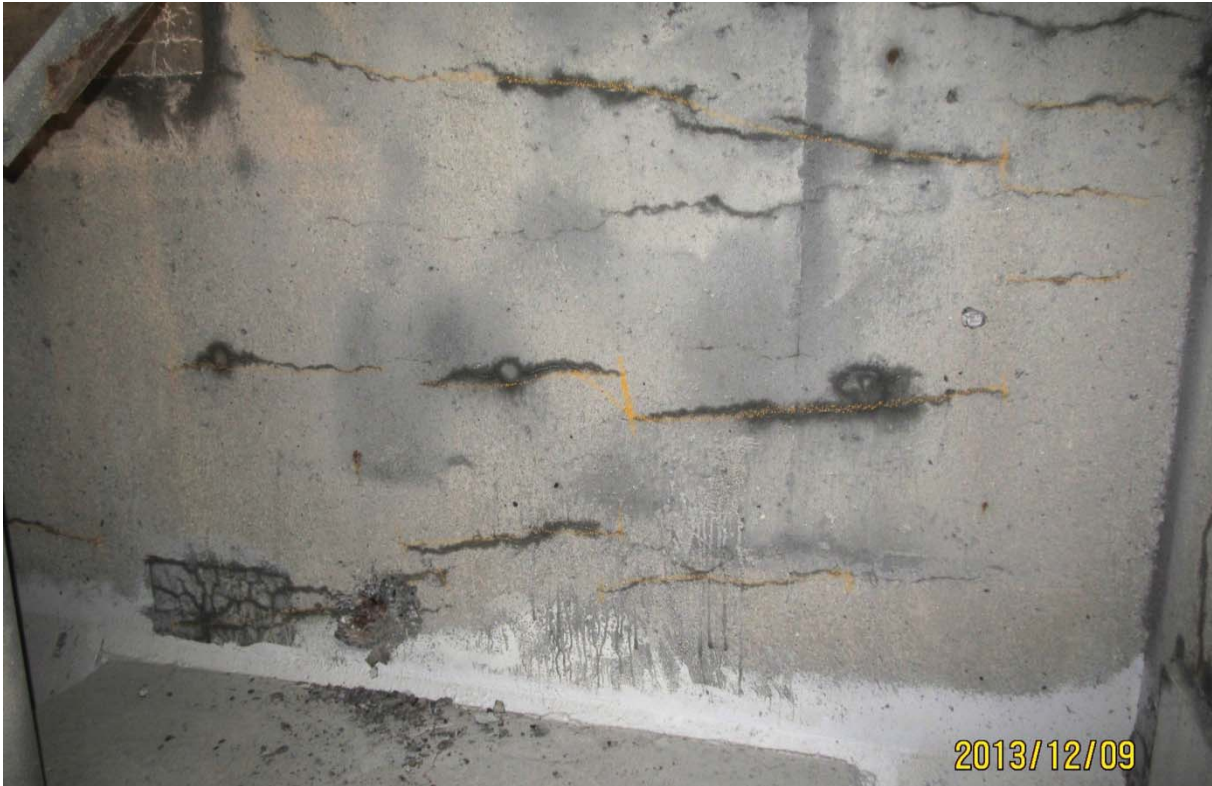
S5.PC.16W-17W.P1.b – 6688 (âme - extrémité ouest face aval)
