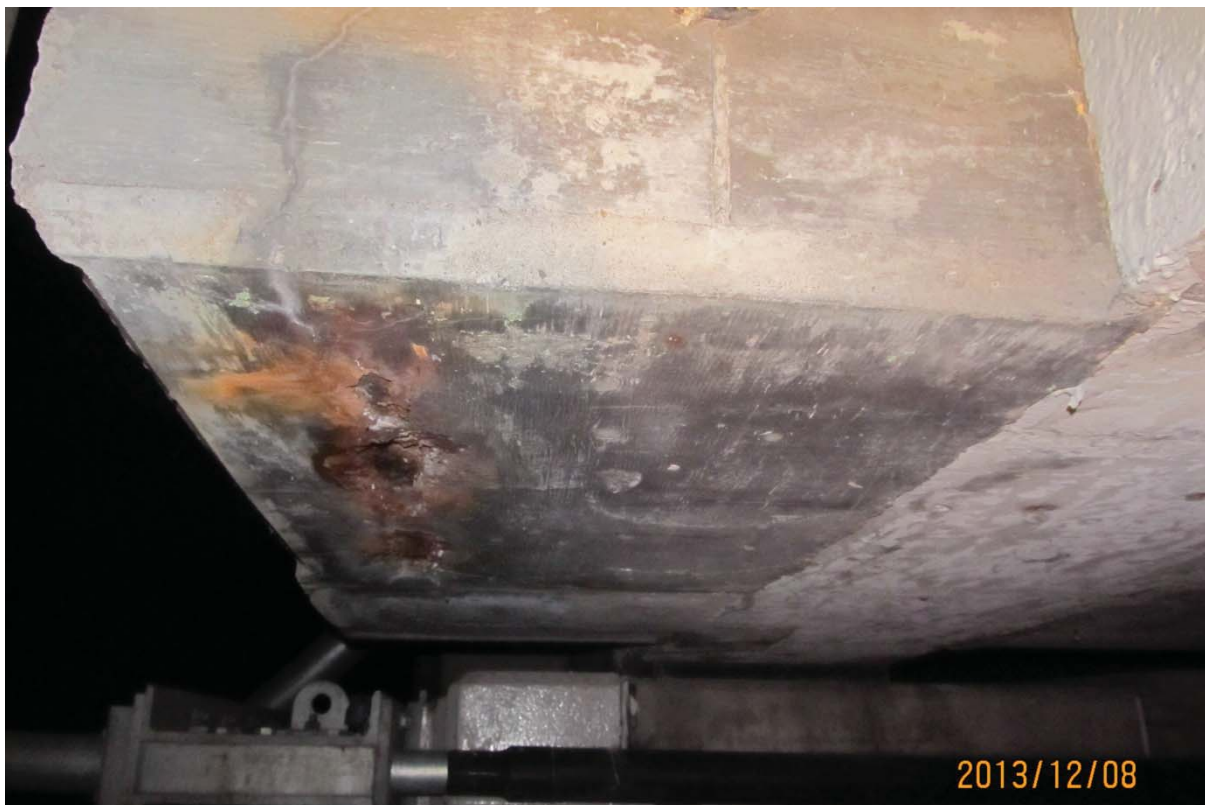
S5.PC.9W-10W.P1.e – 6667 (bloc d'ancrage PTE extérieur est)
