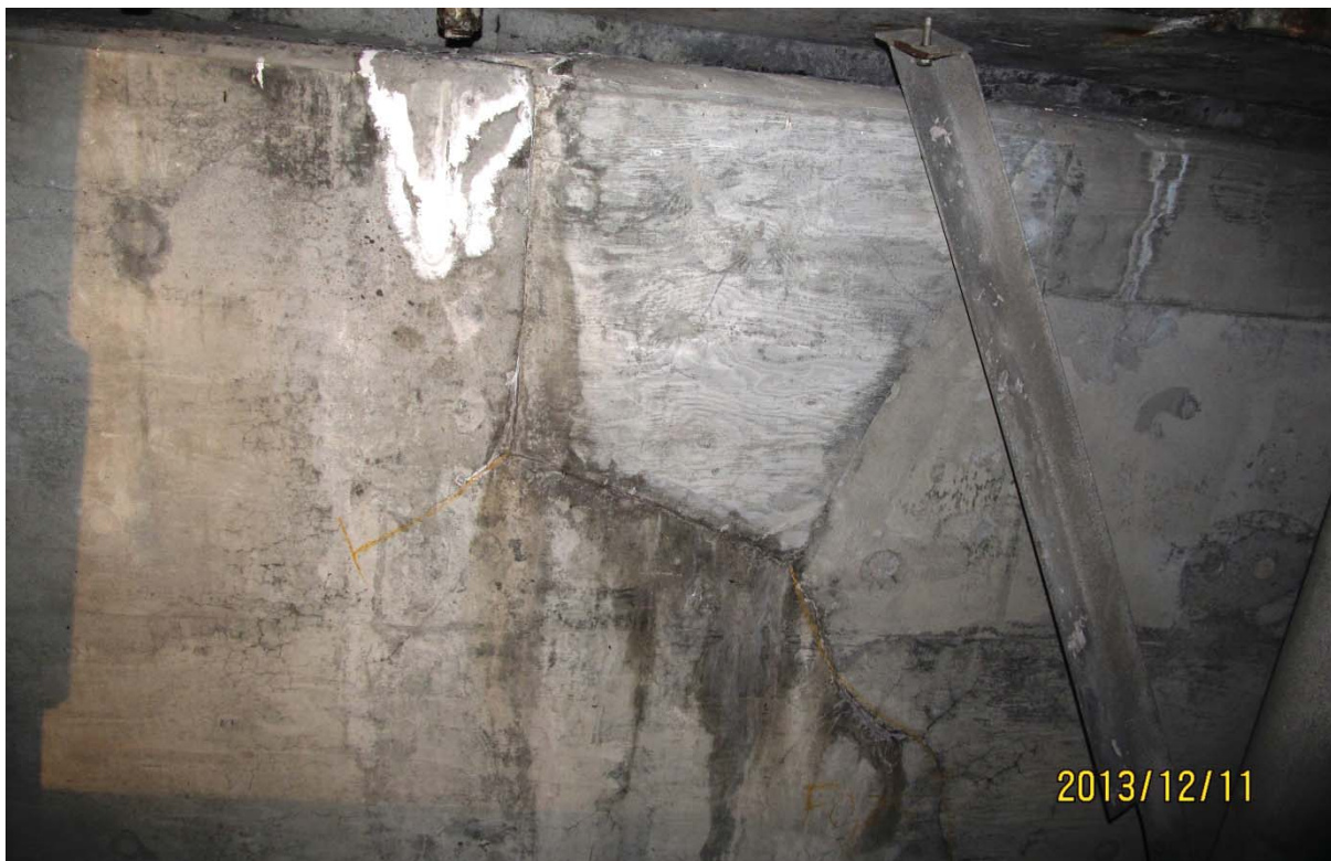
S5.PC.33W-34W.P1.a – 6739 (bloc d'ancrage QP 1.0 - extrémité est face aval)
