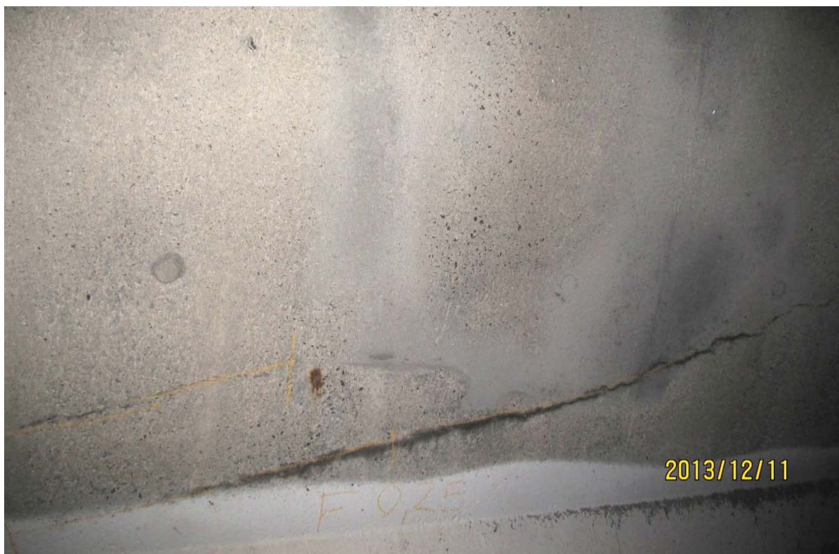
S5.PC.32W-33W.P1.d – 6727 (câbles #23 et #24 – centre ouest face aval)
