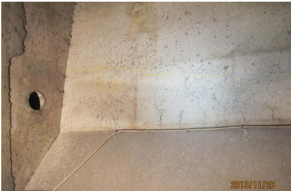
S5.PC.41W-42W.P7.c – 6459 (câble #22 - centre est face aval)
