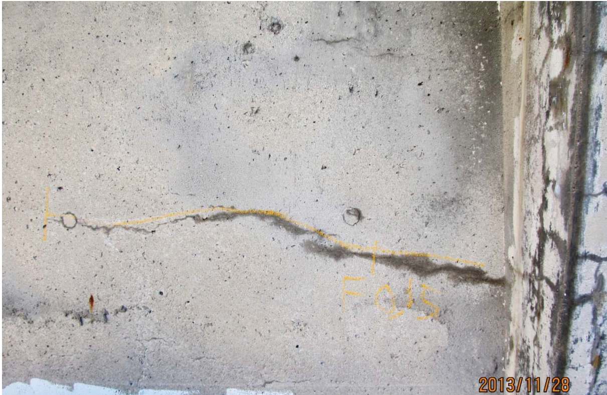
S5.PC.14W-15W.P7.c – 6476 (câble #22 – extrémité ouest face amont)
