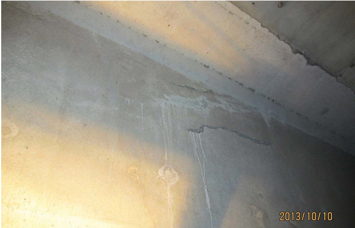
S5.PC.39W-38W.P7.e – 5716 (câble #20 – extrémité ouest face aval)
