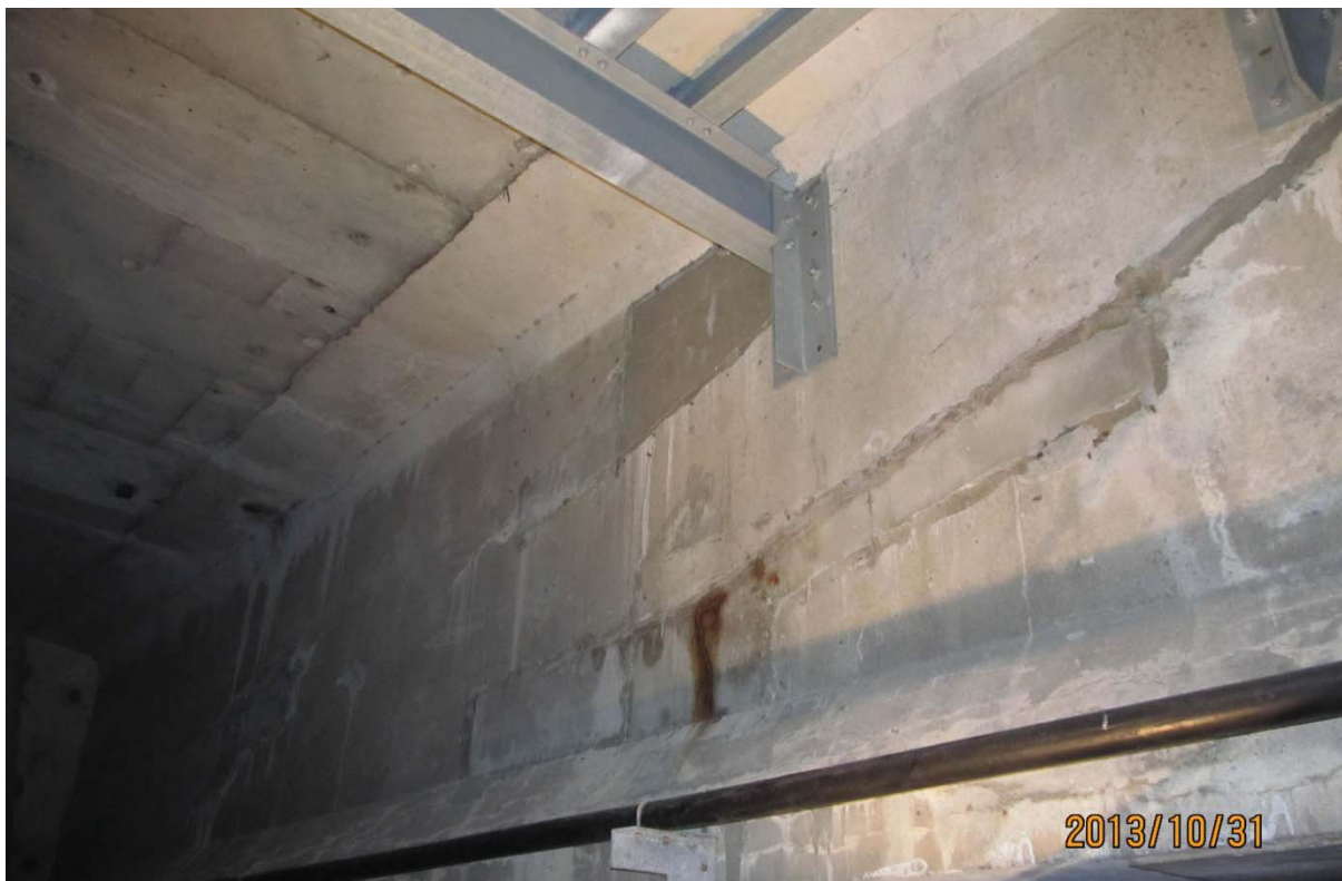
S5.PC.30W-31W.P1.g – 6059 (câbles #19 et #17 - extrémité est face amont)
