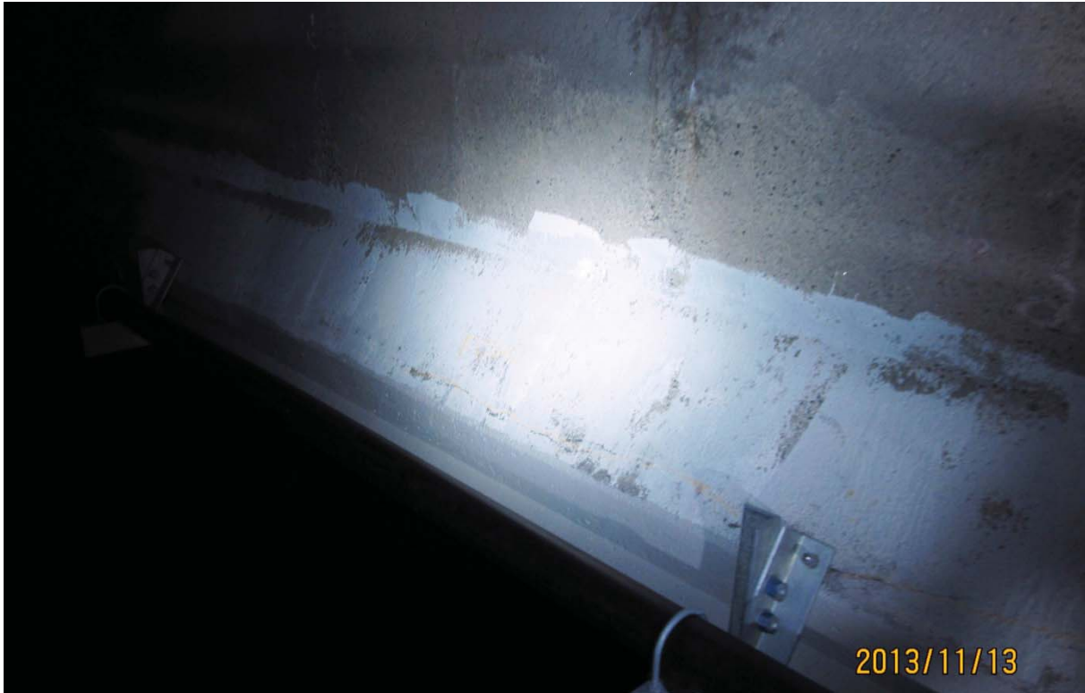
S5.PC.22W-23W.P7.a – 6284 (semelle inférieure – centre est face amont)
