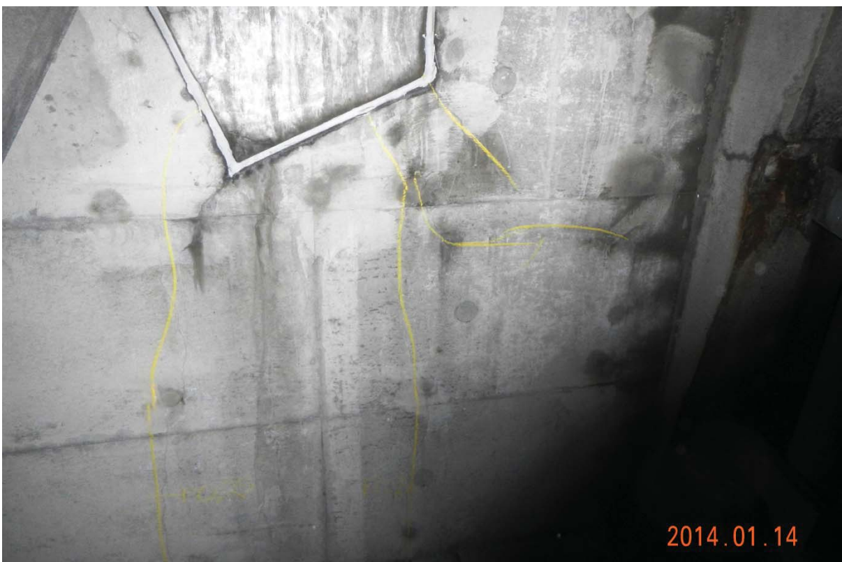
S5.PC.29W-30W.P1.b – 7335 (bloc d'ancrage QP 1.0 - extrémité ouest face aval)
