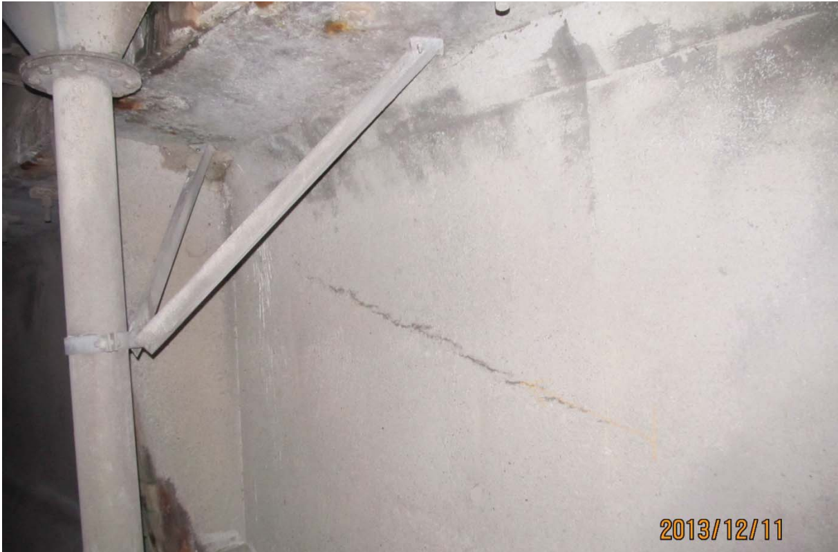
S5.PC.34W-35W.P1.c – 6758 (câble #24 – centre est face aval)
