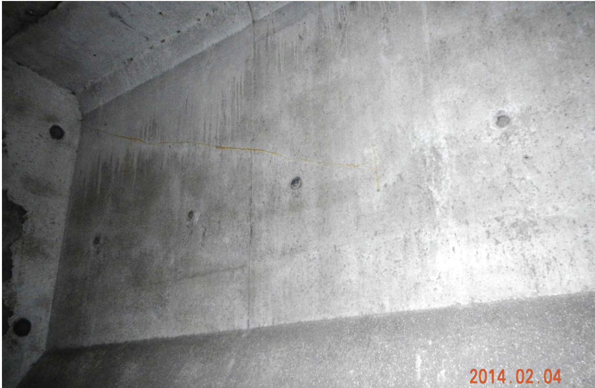
S5.PC.31W-32W.P4.j – 7499 (câble #24 – centre est face aval)
