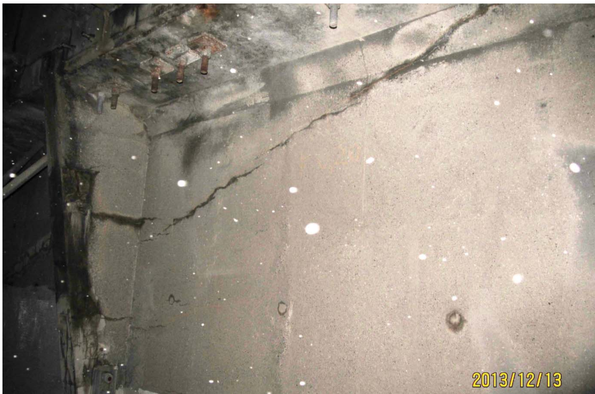
S5.PC.31W-32W.P7.e – 6793 (câbles #22 et #23 - extrémité est face amont)
