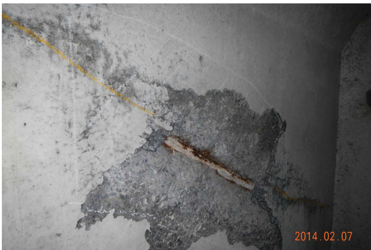
S5.PC.33W-34W.P4.d – 7540 (câble #23 – extrémité est face aval)
