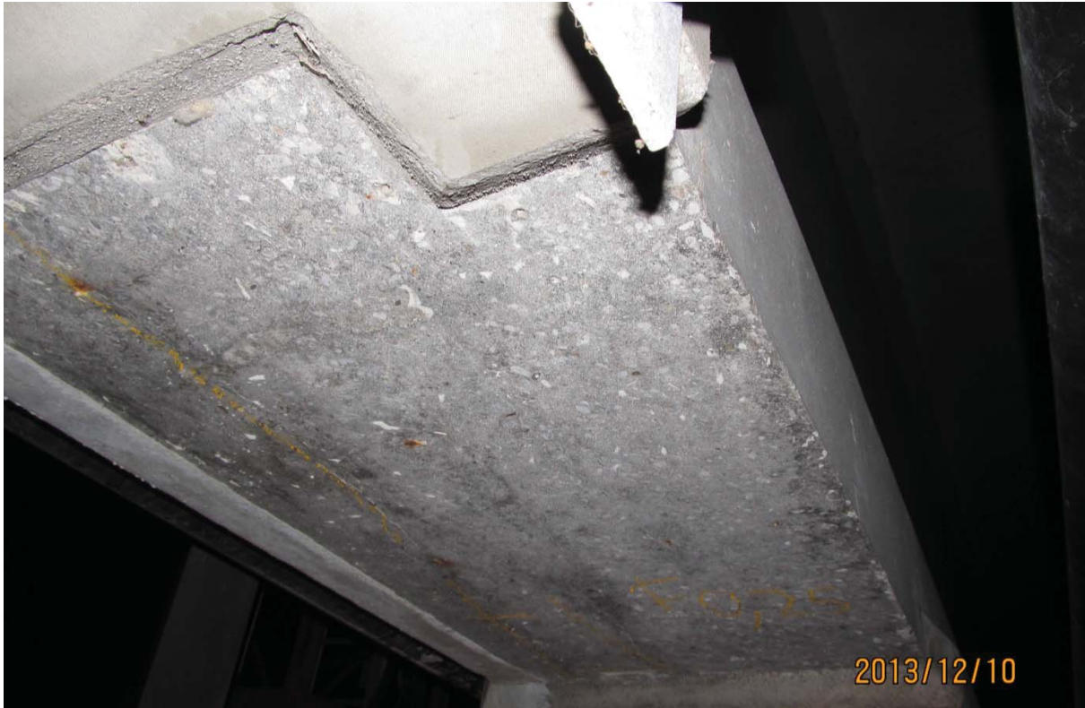
S5.PC.7W-8W.P1.a – 6709 (soffite – centre)
