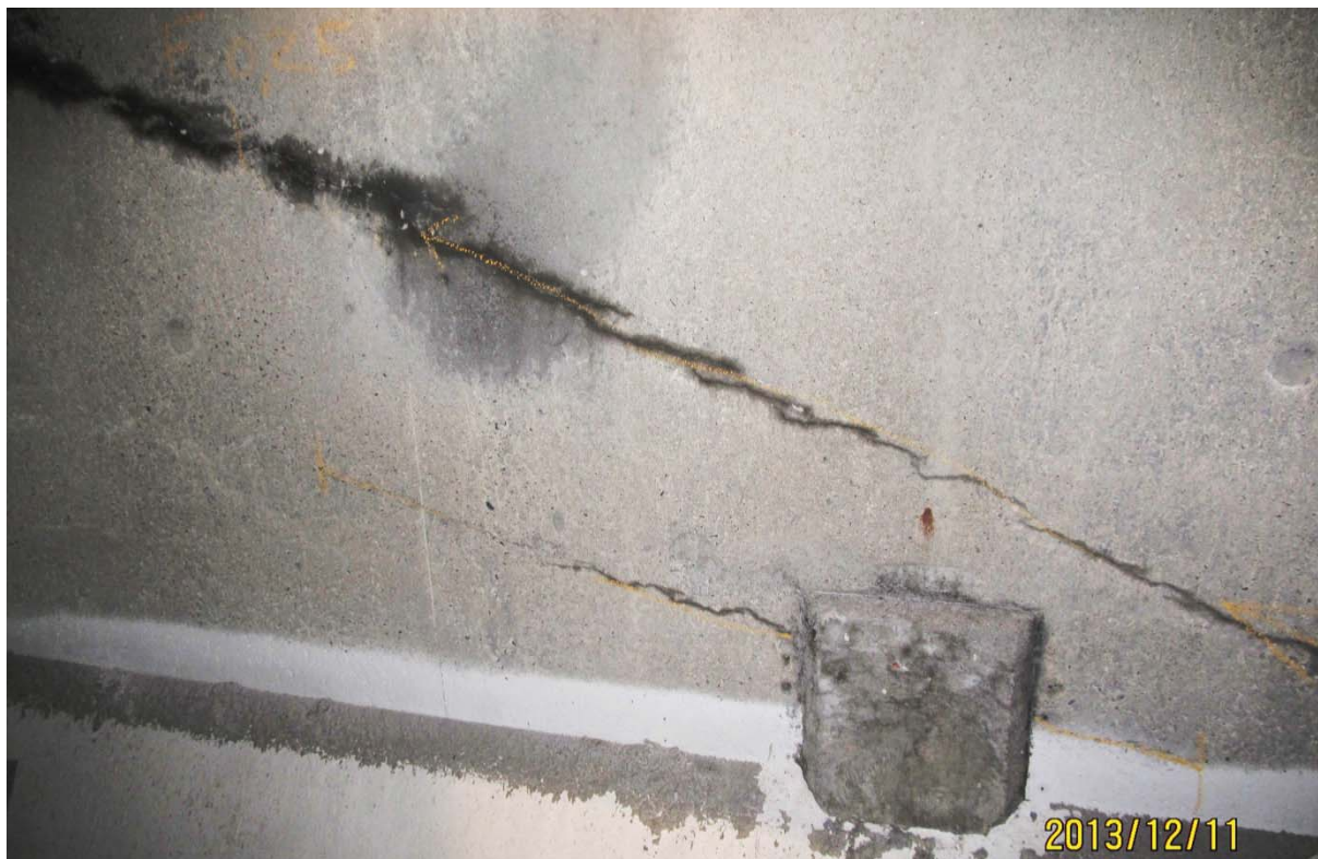
S5.PC.32W-33W.P1.c – 6726 (câbles #23 et #24 – centre est face aval)
