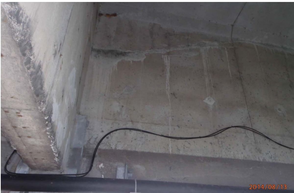
S5.PC.31W-32W.P7.j – PH.20140813_P7_31W-32W_015 (câble #23 - extrémité ouest face aval)
