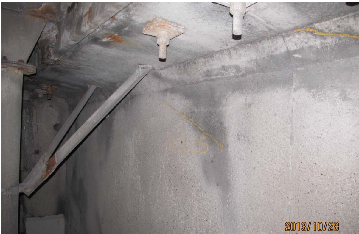
S5.PC.40W-41W.P1.a – 5943 (câble #15 – extrémité est face aval)
