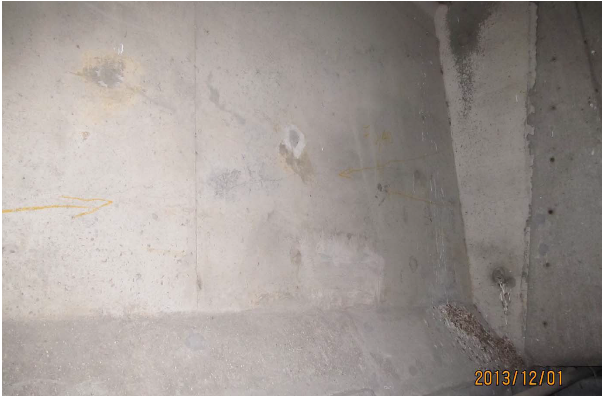
S7.PC.4E-5E.P7.e – 6542 (câble #23 – centre ouest face aval)
