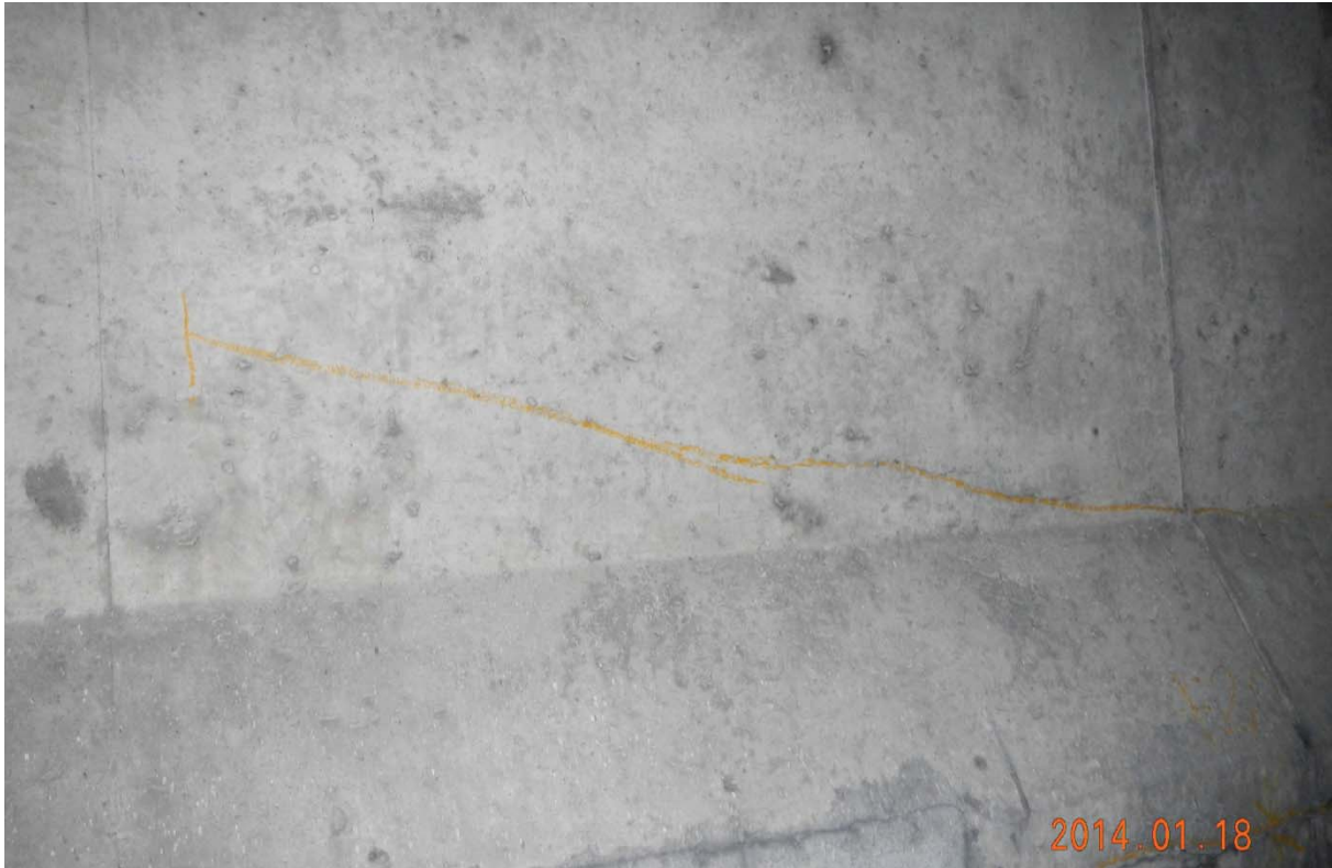
S7.PC.11E-12E.P4.a – 0740 (câble #22 – centre ouest face amont)
