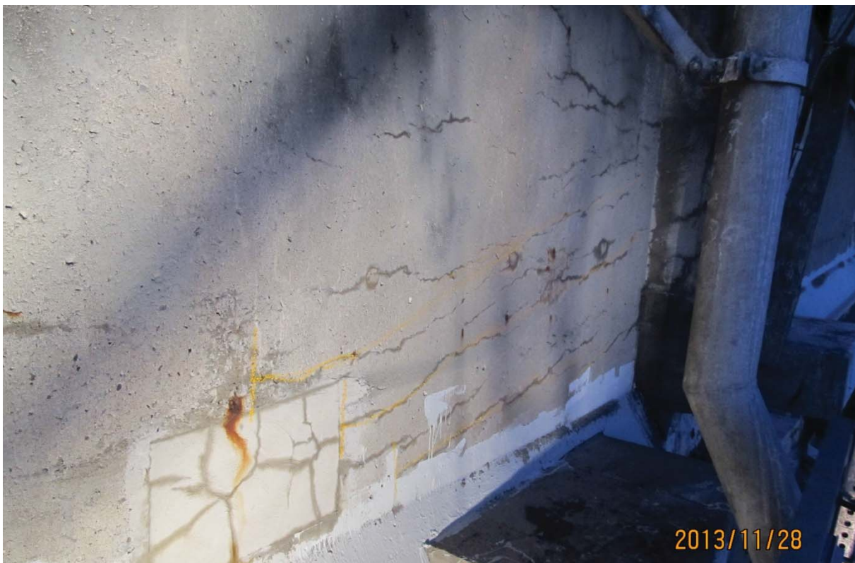
S5.PC.14W-15W.P7.h – 6484 (câbles #6, #8 et #10 – extrémité est face amont)
