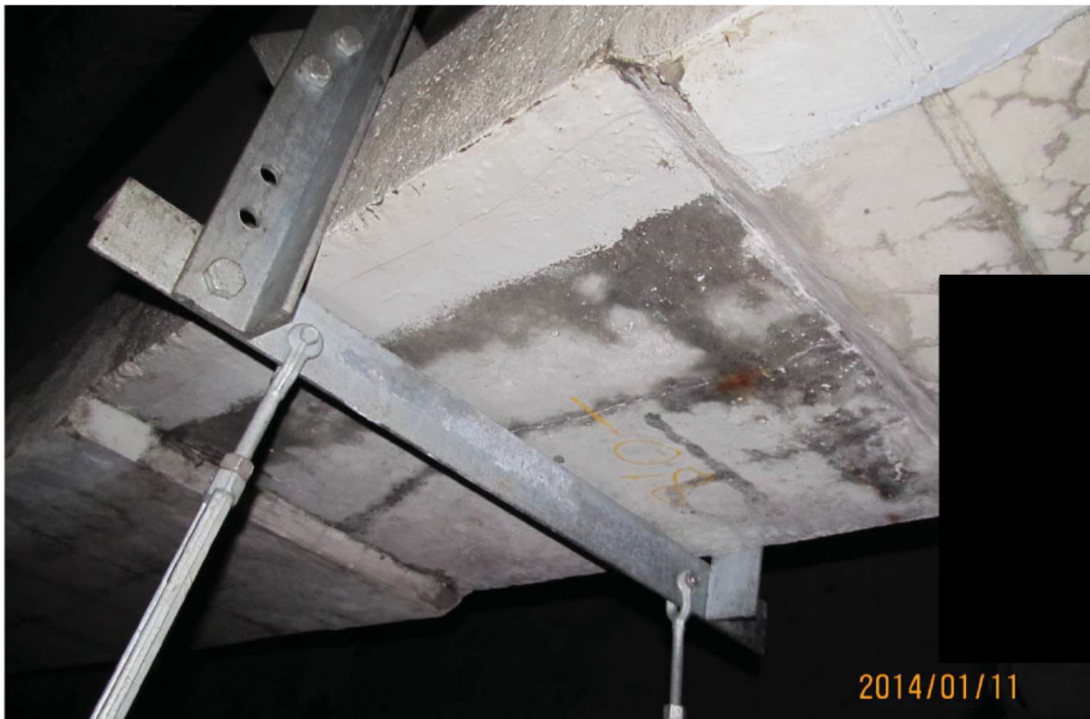
S5.PC.27W-28W.P1.d – 0135 (soffite - centre est)
