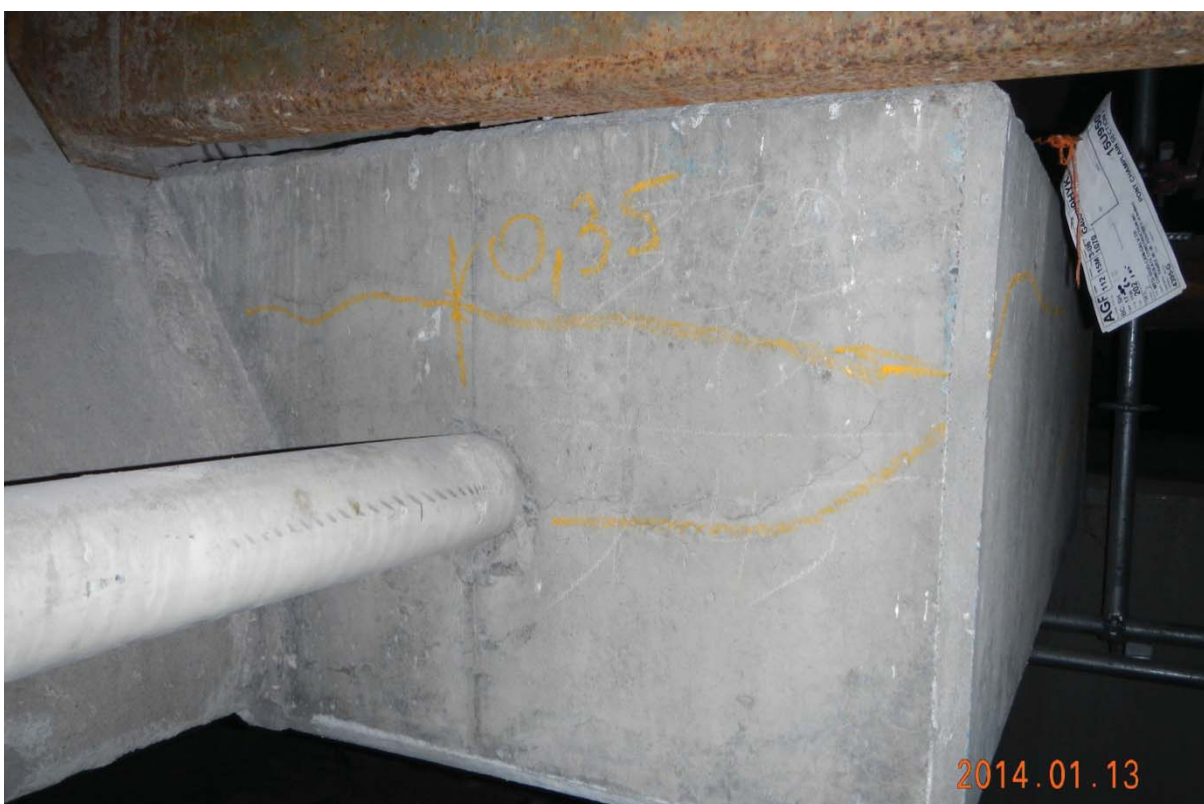
S7.PC.8E-9E.P7.b – 0696 (bloc d'ancrage extérieur ouest – post tension extérieure)
