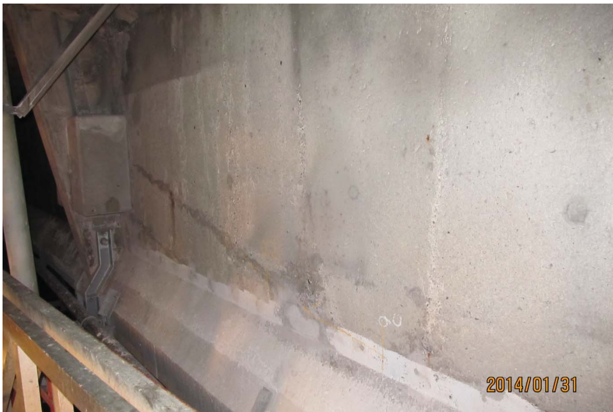
S5.PC.6W-7W.P7.a – 0198 (câbles #22 et #23 - centre ouest face amont)
