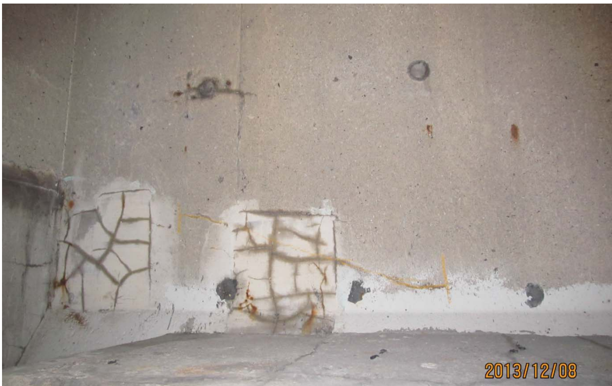
S5.PC.9W-10W.P1.a – 6670 (câble #5 - extrémité est face aval)
