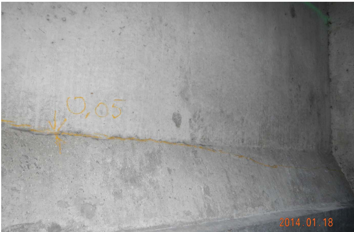
S7.PC.11E-12E.P4.d – 0726 (câble #19 – extrémité est face aval)
