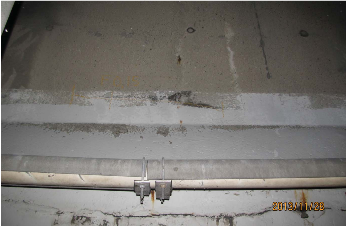
S5.PC.41W-42W.P7.a – 6457 (câble #22 - extrémité ouest face amont)
