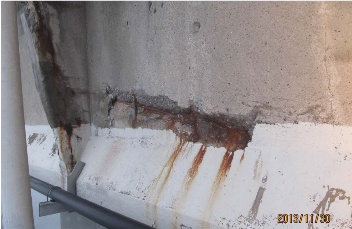
S5.PC.8W-9W.P7.c – 6525 (câble #22 – centre ouest face amont)
