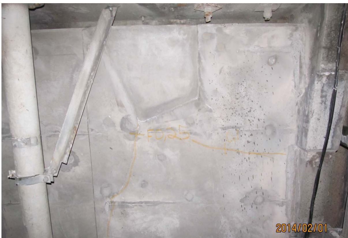
S5.PC.32W-33W.P7.b – 0215 (bloc d'ancrage QP 1.0 extérieur est)
