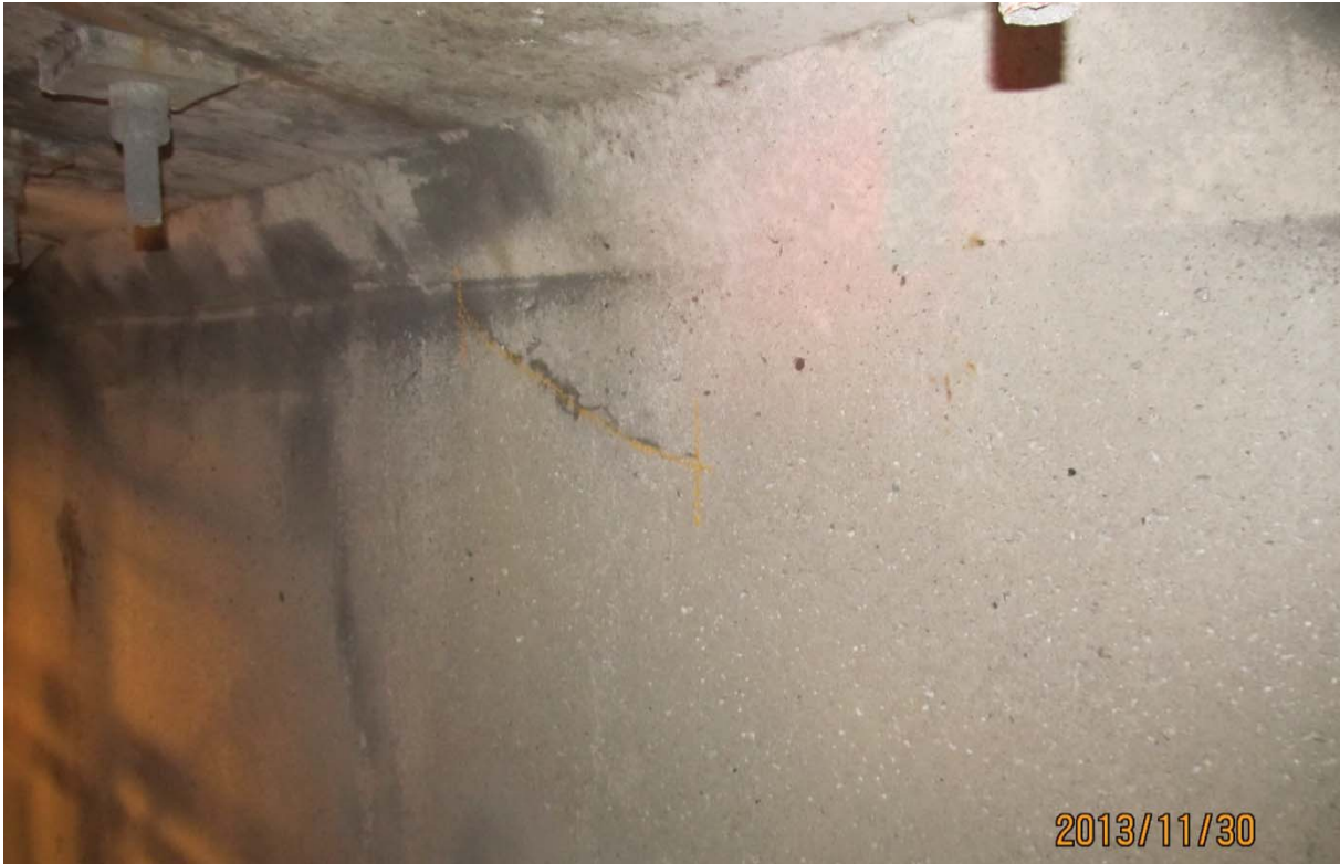
S5.PC.9W-10W.P7.a – 6497 (câble #20 – extrémité ouest face amont)
