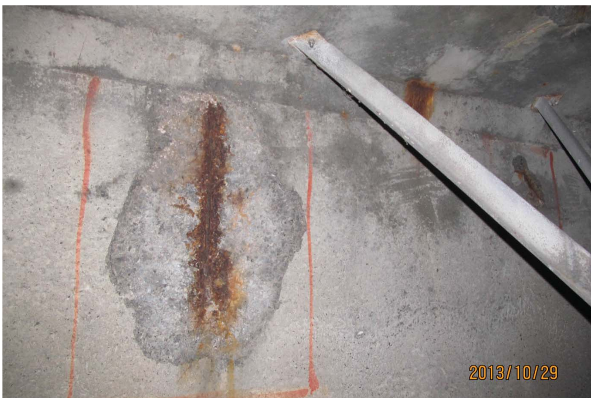
S5.PC.40W-41W.P1.h – 5947 (âme – extrémité ouest face aval)
