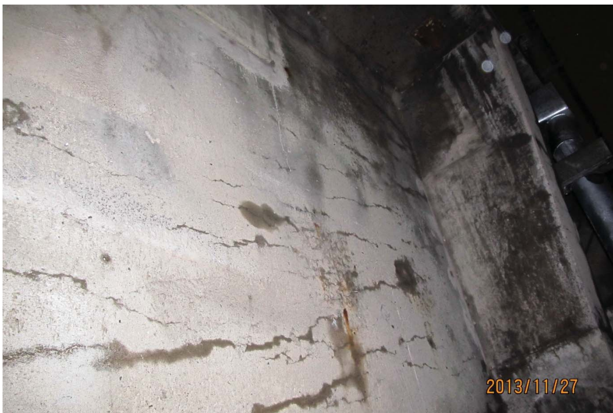
S5.PC.19W-20W.P7.f – 6451 (âme et câble #7 – extrémité est face amont)
