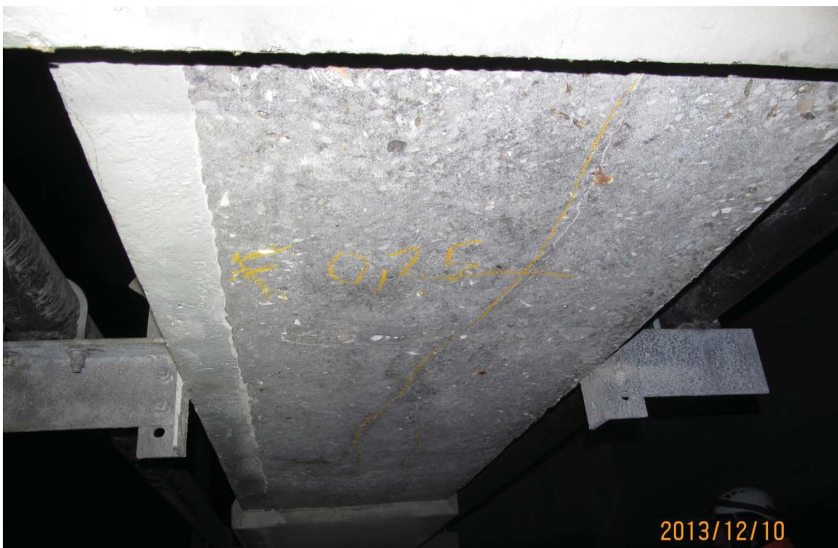
S5.PC.7W-8W.P1.b – 6710 (soffite – centre est)
