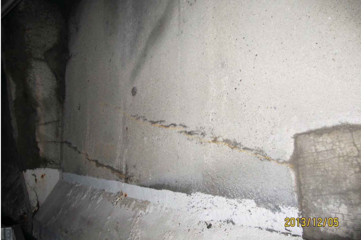
S5.PC.04W-05W.P7.c – 6602 (câbles #22 et #23 – centre ouest face amont)
