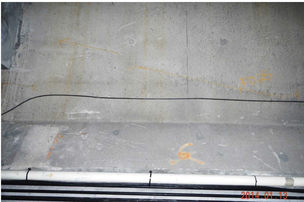
S7.PC.7E-8E.P7.b – 0682 (câbles #23 – centre est face aval)
