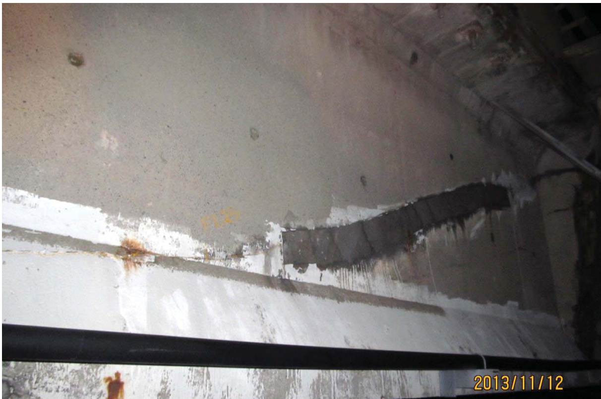
S5.PC.28W-29W.P7.d – 6249 (câble #24 – centre est face amont)
