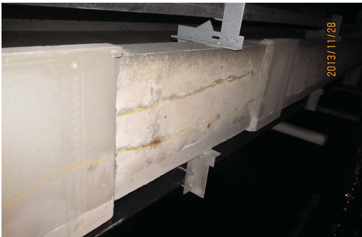
S5.PC.11W-12W.P7.h – 6486 (soffite – extrémité ouest)
