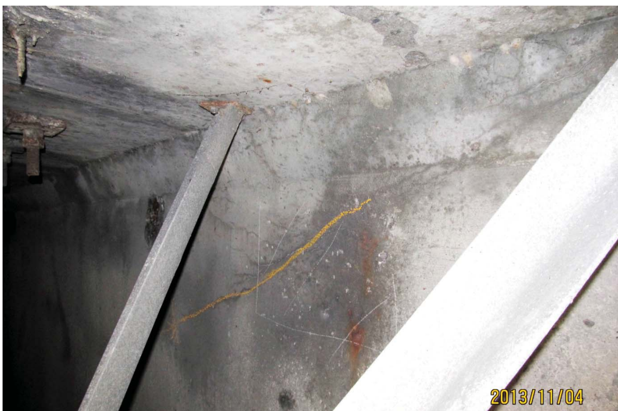
S5.PC.17W-18W.P1.d – 6079 (câble #19 - extrémité ouest face aval)
