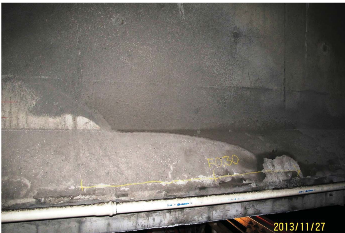
S5.PC.19W-20W.P7.k – 6437 (semelle inférieure – centre ouest face aval)
