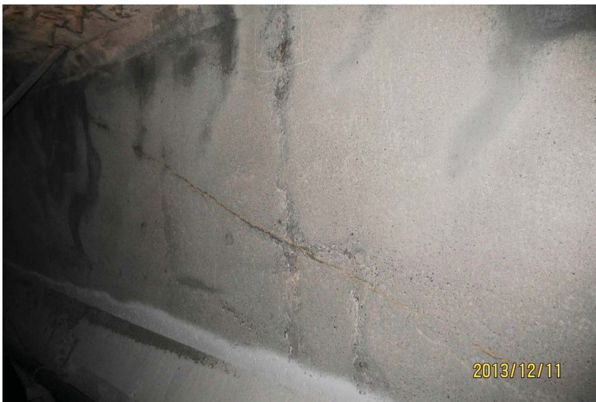
S5.PC.33W-34W.P1.b – 6742 (câble #19 - extrémité est face aval)
