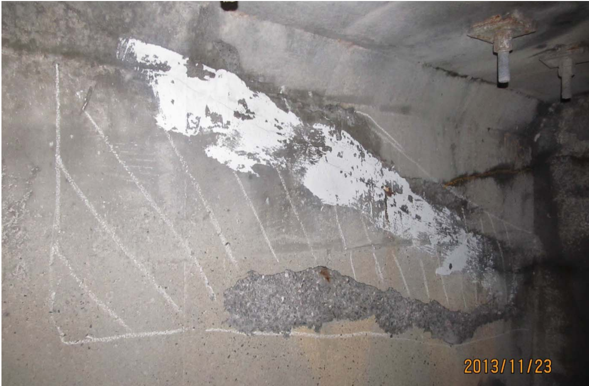
S5.PC.29W-30W.P7.e – 6389 (câble #23 – extrémité ouest face amont)
