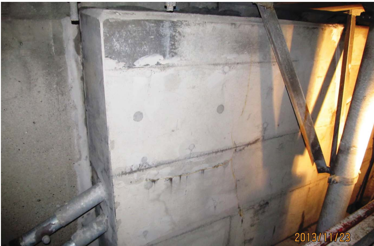
S5.PC.29W-30W.P7.b – 6398 (bloc d'ancrage QP 1.0 – extérieur est)
