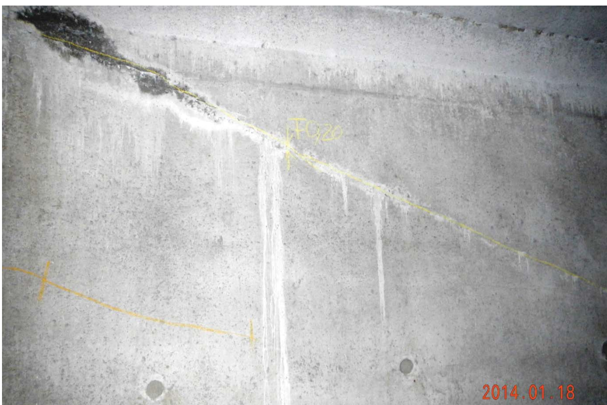
S5.PC.31W-32W.P4.h – 0758 (câble #20 – extrémité est face aval)
