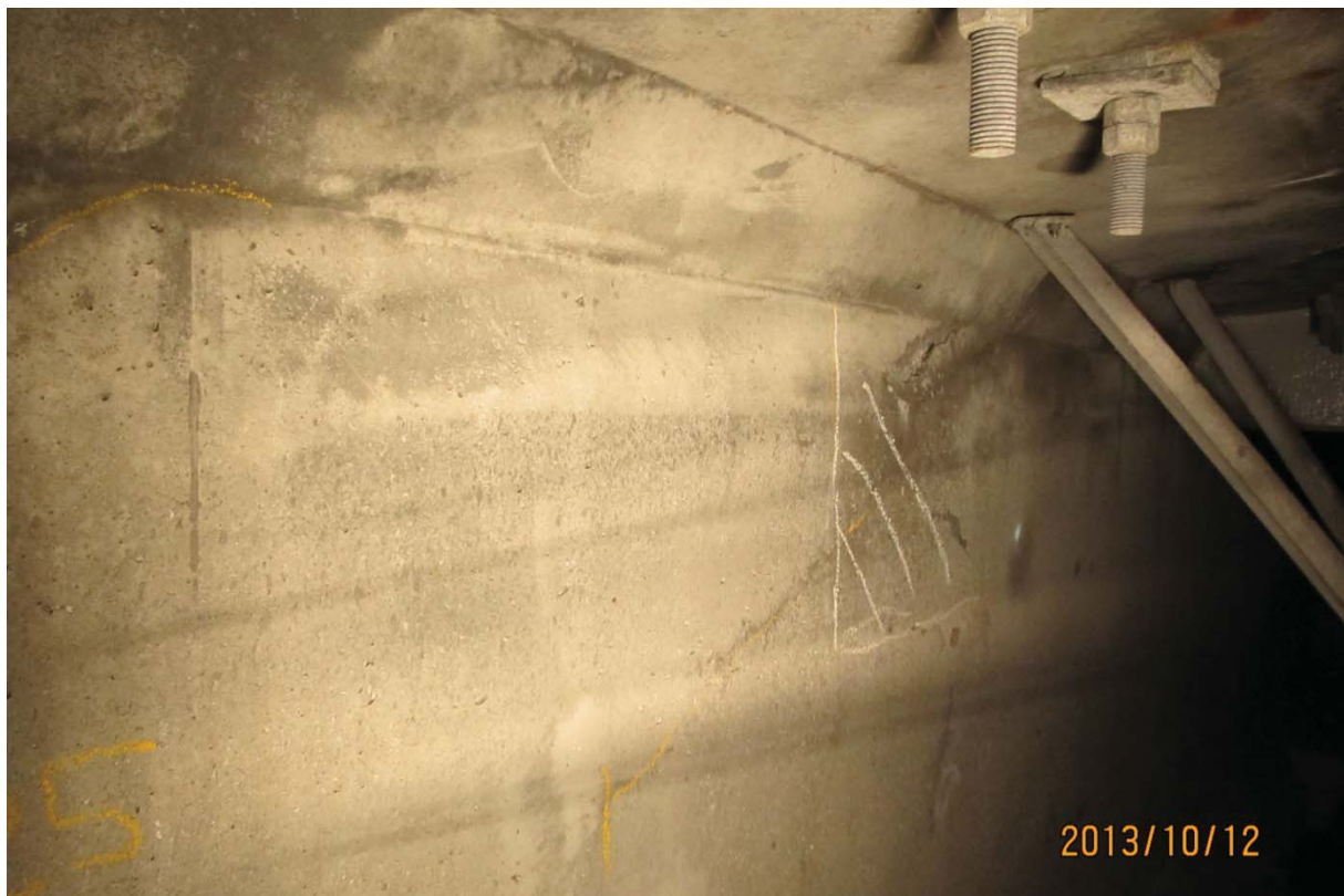
S5.PC.41W-42W.P1.f – 5763 (câble #19 - extrémité ouest face aval)
