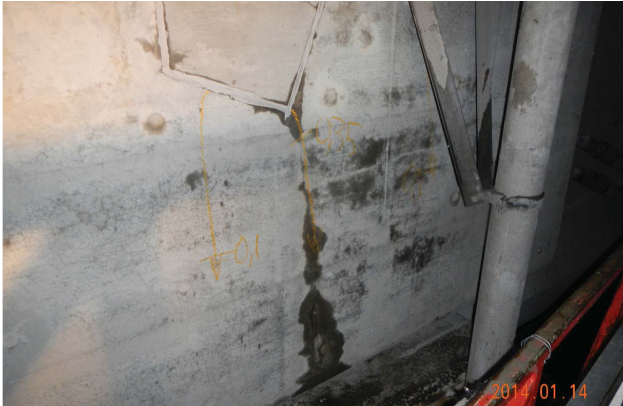
S5.PC.31W-32W.P1.a – 7338 (bloc d'ancrage QP 1.0 extérieur est)
