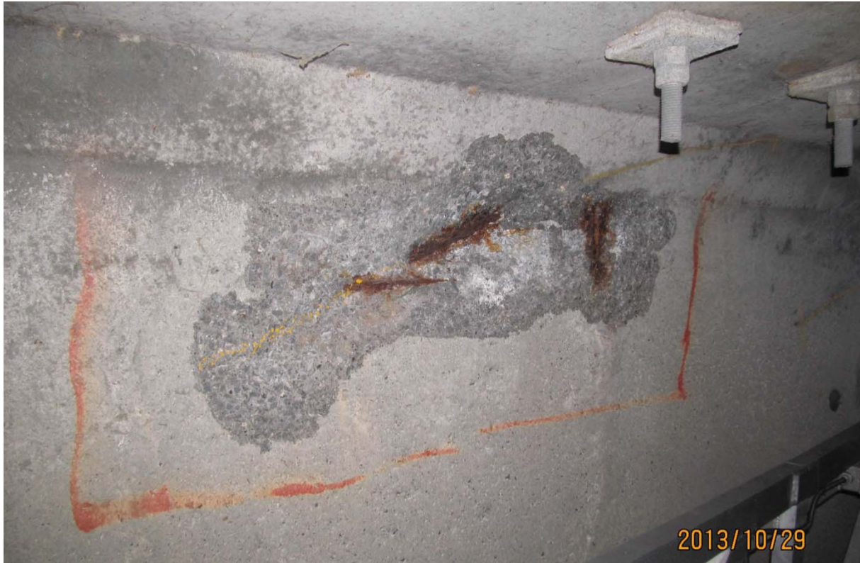
S5.PC.40W-41W.P1.c – 5950 (câble #20 – extrémité ouest face aval)
