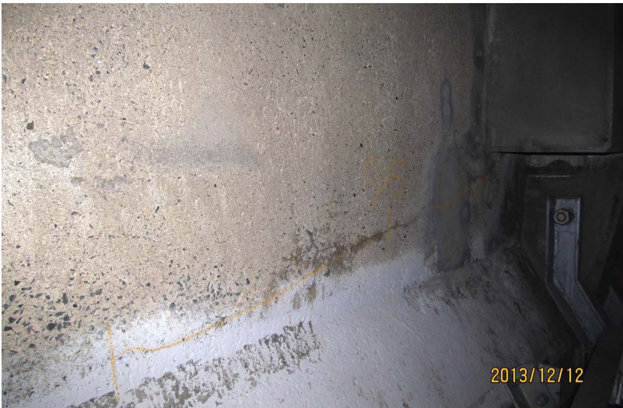
S5.PC.21W-22W.P7.f – 6774 (câble #22 – centre est face amont)
