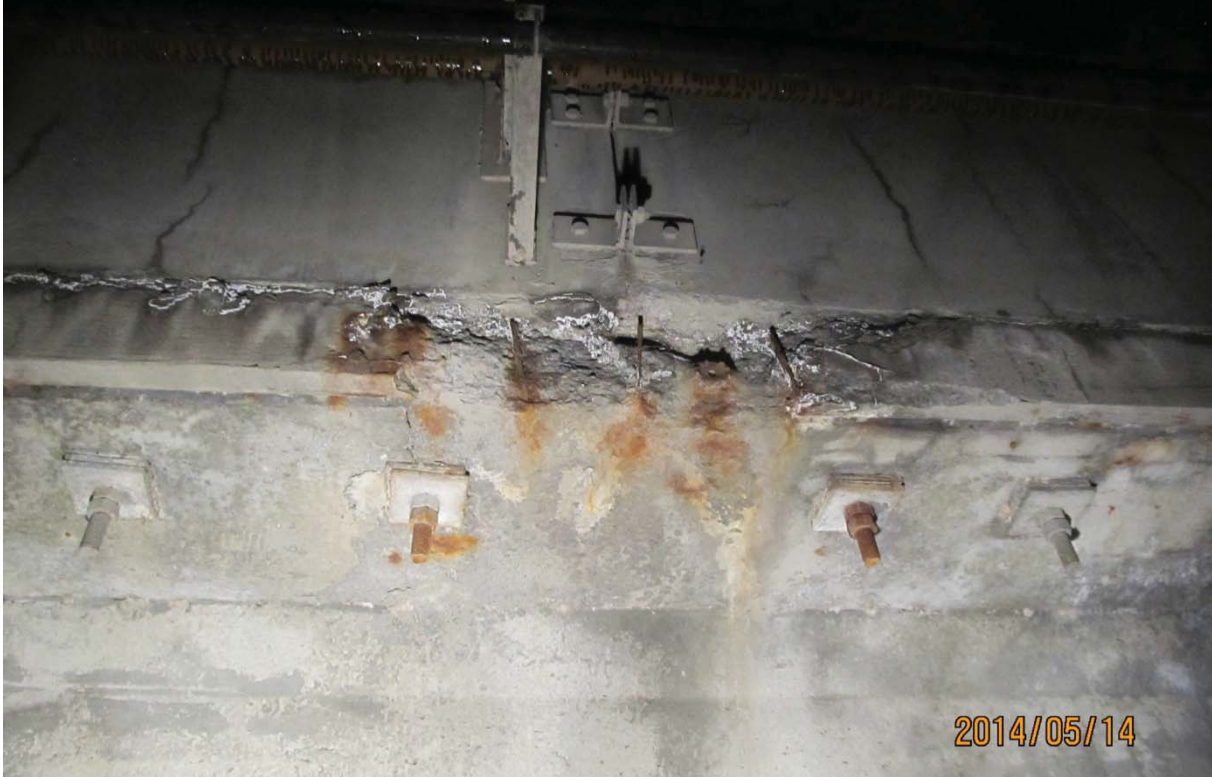
S5.PC.23W-24W.P1.e – 0485 (cachetage semelle supérieure – centre ouest face aval)
