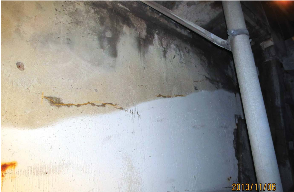
S5.PC.17W-18W.P7.j – 6141 (câble #12 – extrémité est face amont)
