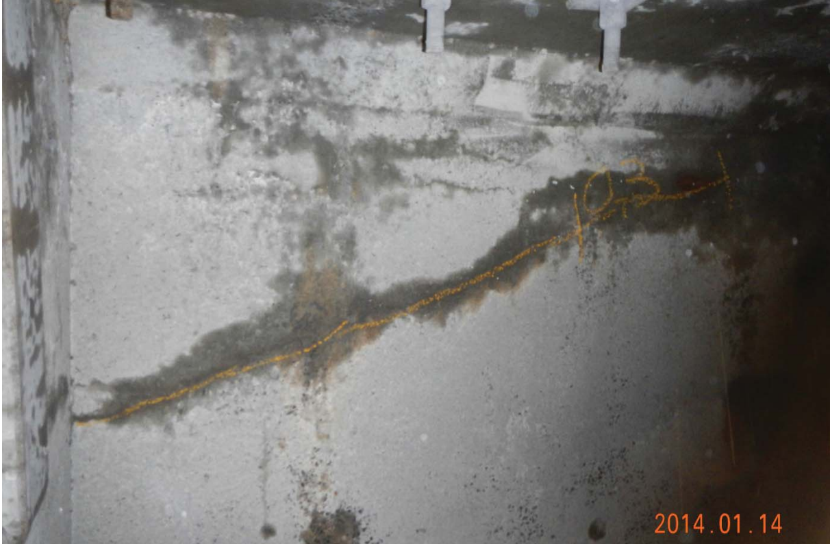
S5.PC.31W-32W.P1.e – 7343 (câble #23 – extrémité ouest face aval)
