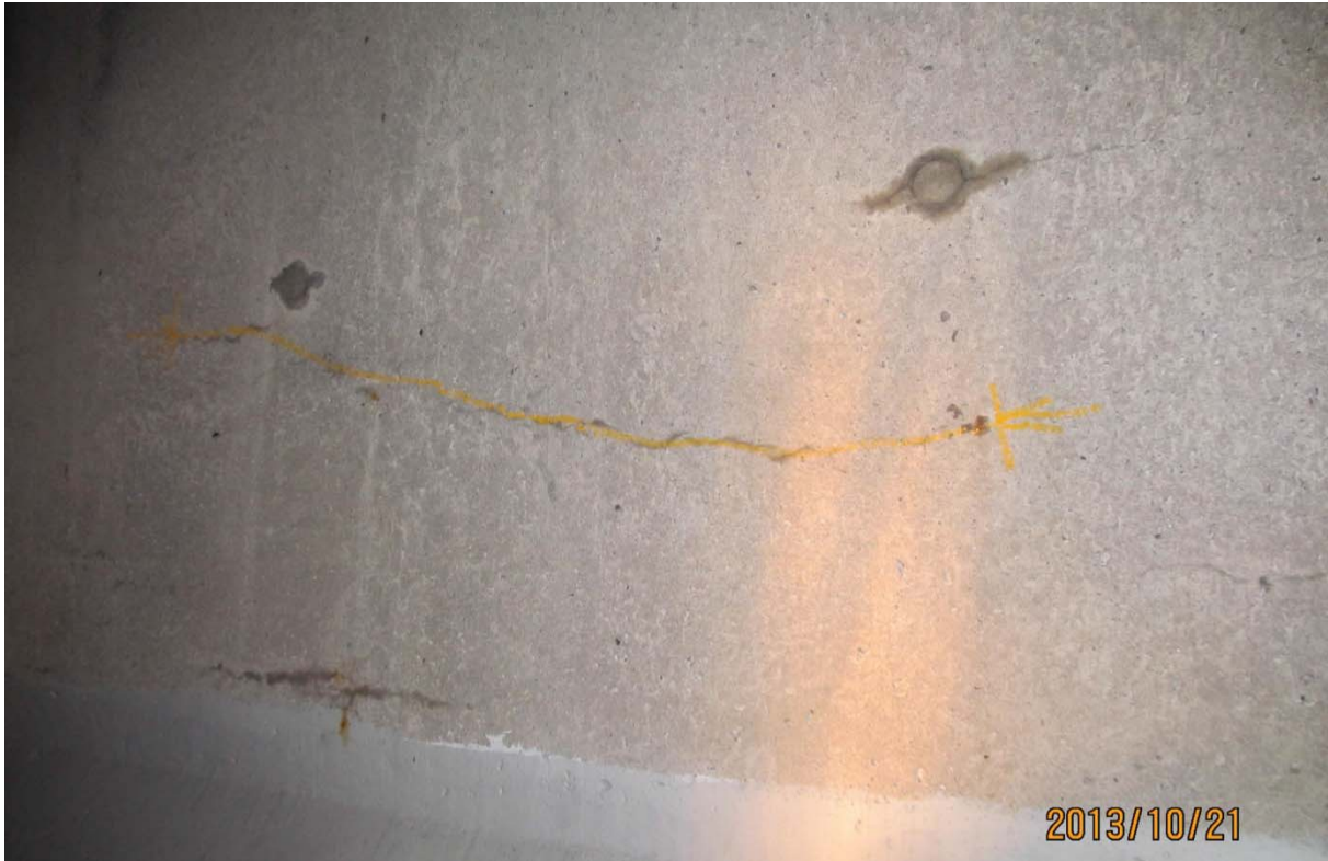
S7.PC.9E-10E.P1.a – 5872 (câble #21 - extrémité est face aval)
