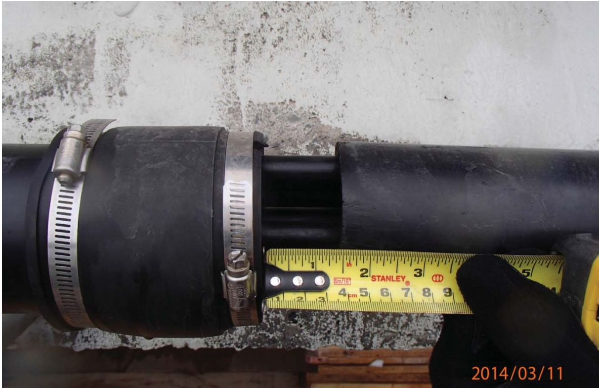
S5.PC.28W-29W.P7.t – 0371 (gaine PTE amont – près du bloc d'ancrage est)
