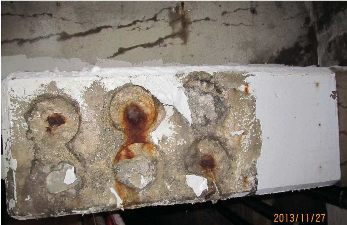
S5.PC.19W-20W.P7.g – 6453 (bloc d'ancrage extérieur – extrémité est face amont)
