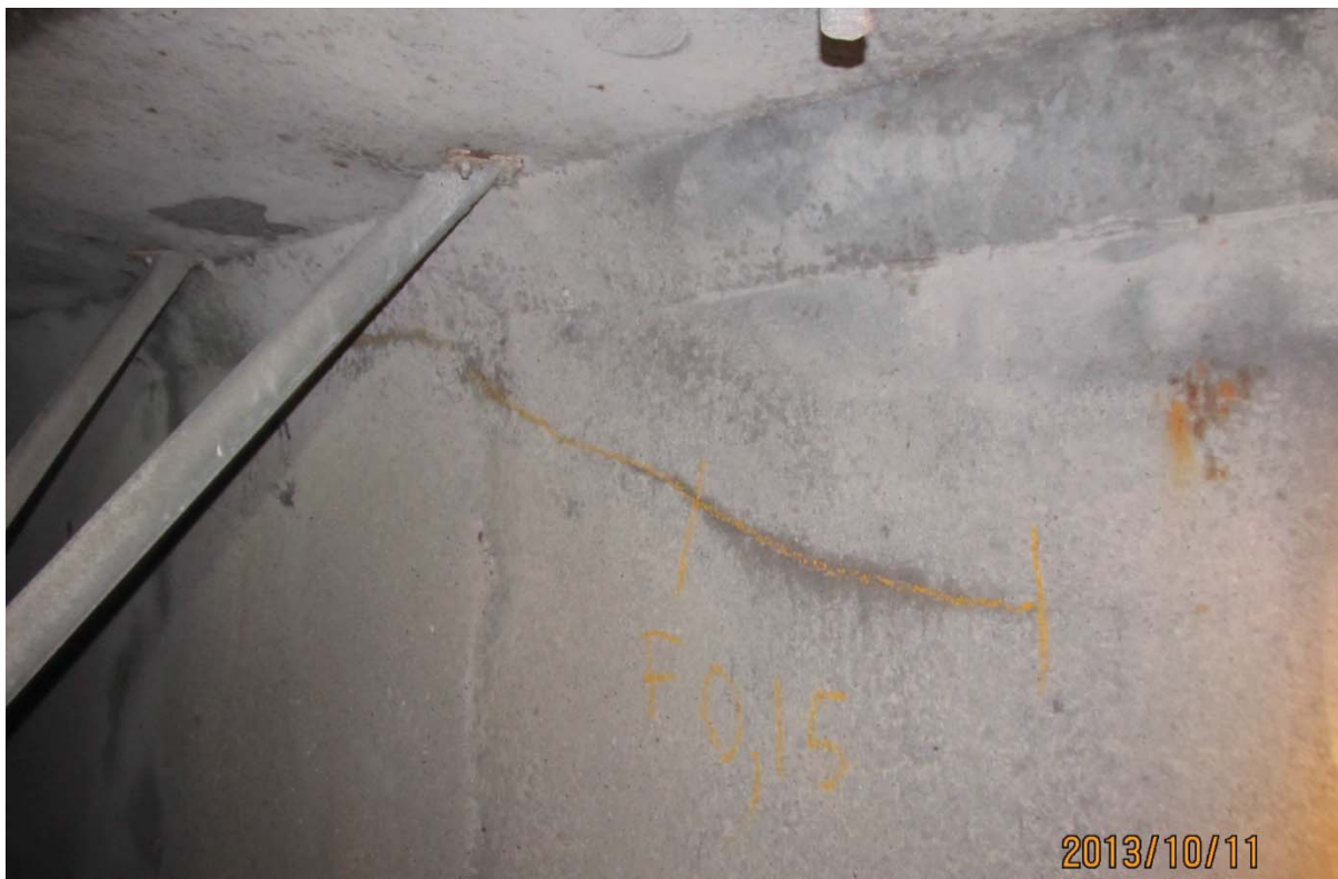
S5.PC.38W-39W.P1.a – 5734 (câble #19 - extrémité est face aval)
