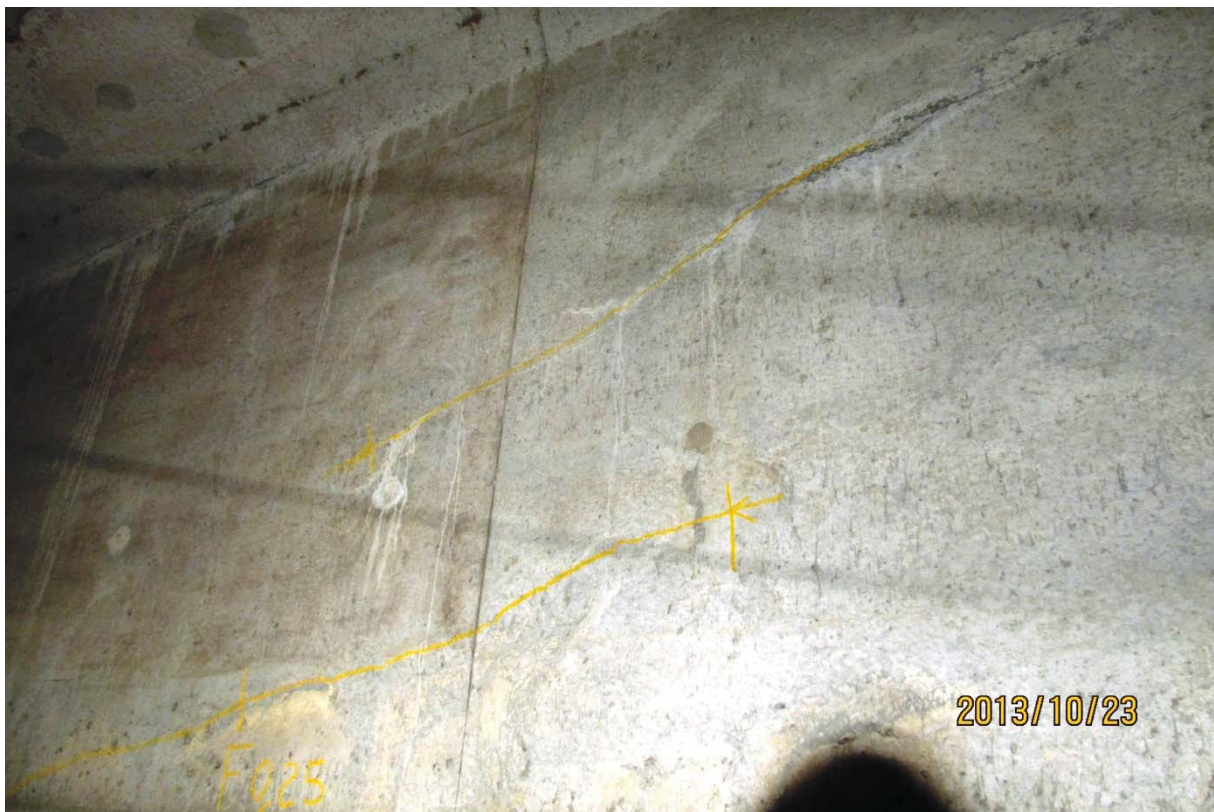
S5.PC.39W-38W.P7.f – 5901 (câbles #23 et #24 – centre est face aval)
