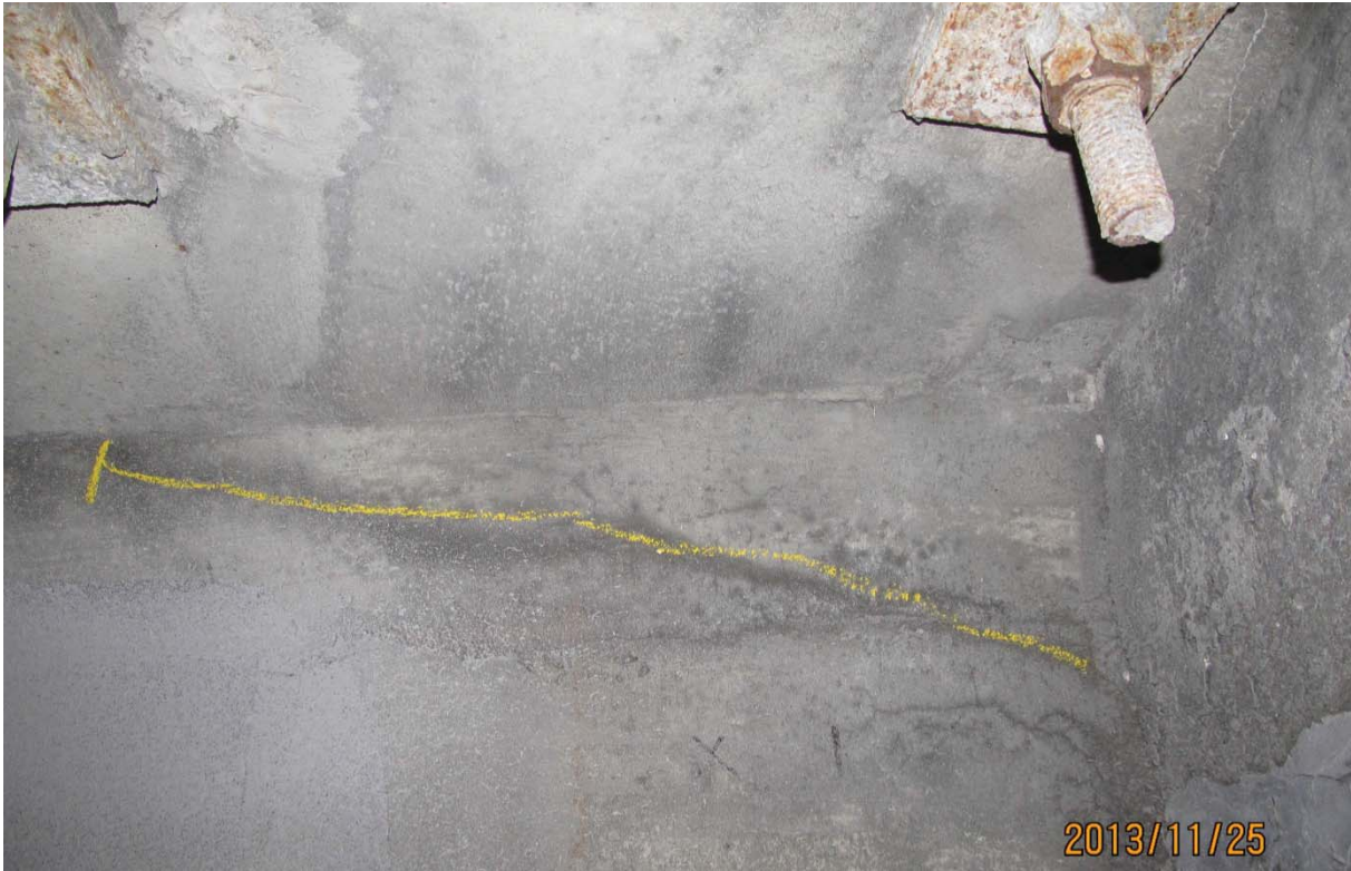
S5.PC.27W-28W.P7.c – 6416 (câble #24 – extrémité ouest face amont)
