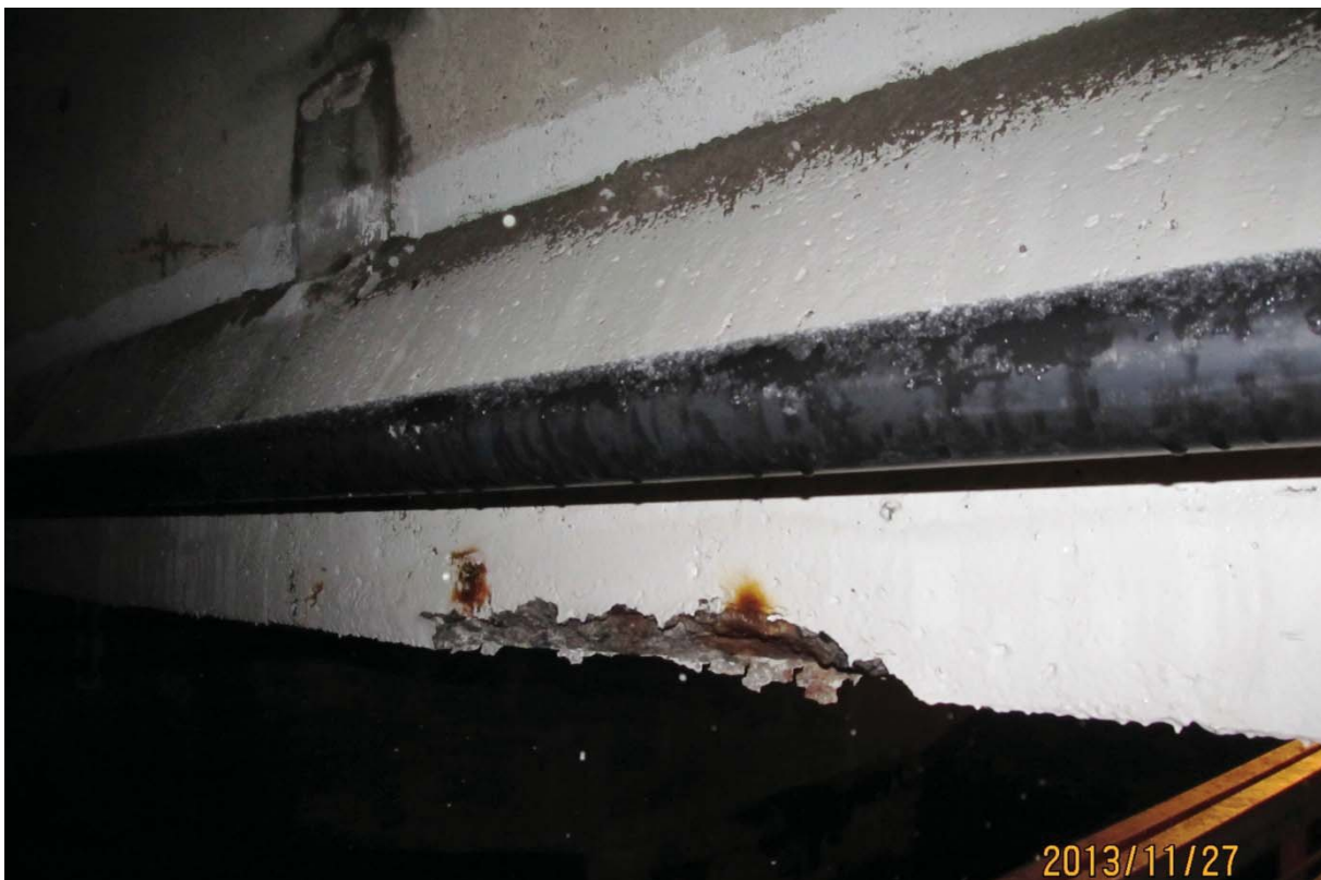
S5.PC.19W-20W.P7.b – 6427 (semelle inférieure – extrémité ouest face amont)
