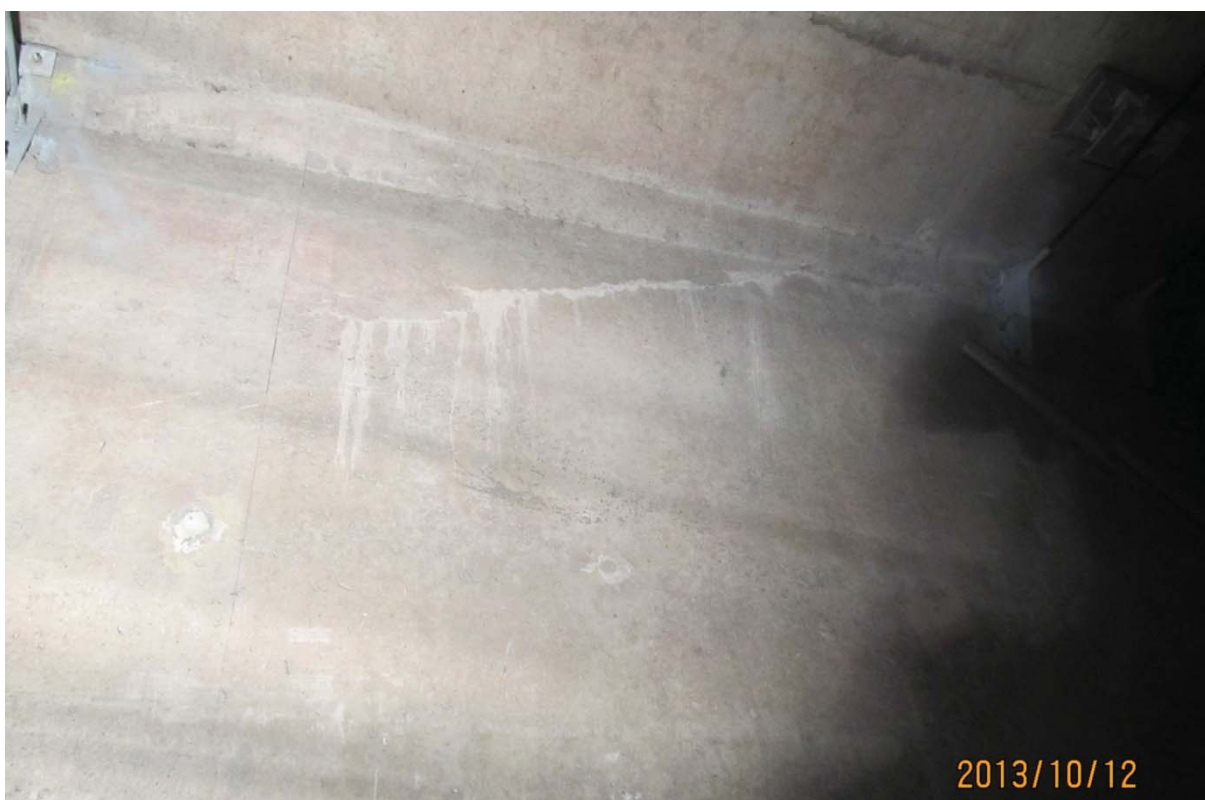
S5.PC.41W-42W.P1.k – 5754 (câble #17 - extrémité est face amont)
