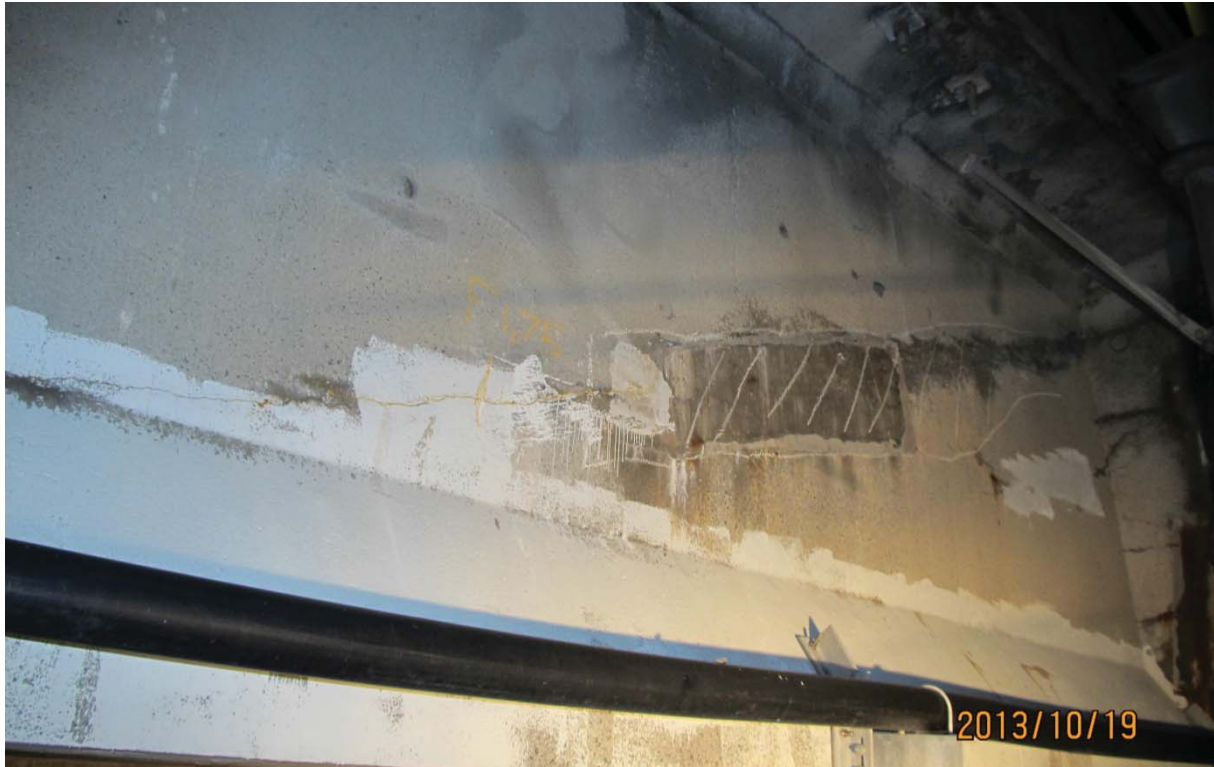
S5.PC.35W-36W.P7.a – 5832 (câble #24 - centre est face amont)
