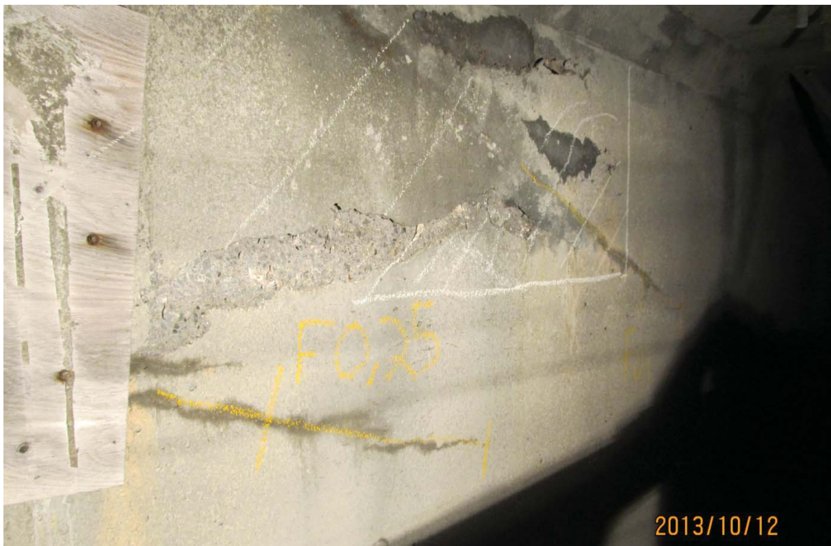
S5.PC.41W-42W.P1.d – 5751 (câbles #19 et #20 - extrémité est face aval)
