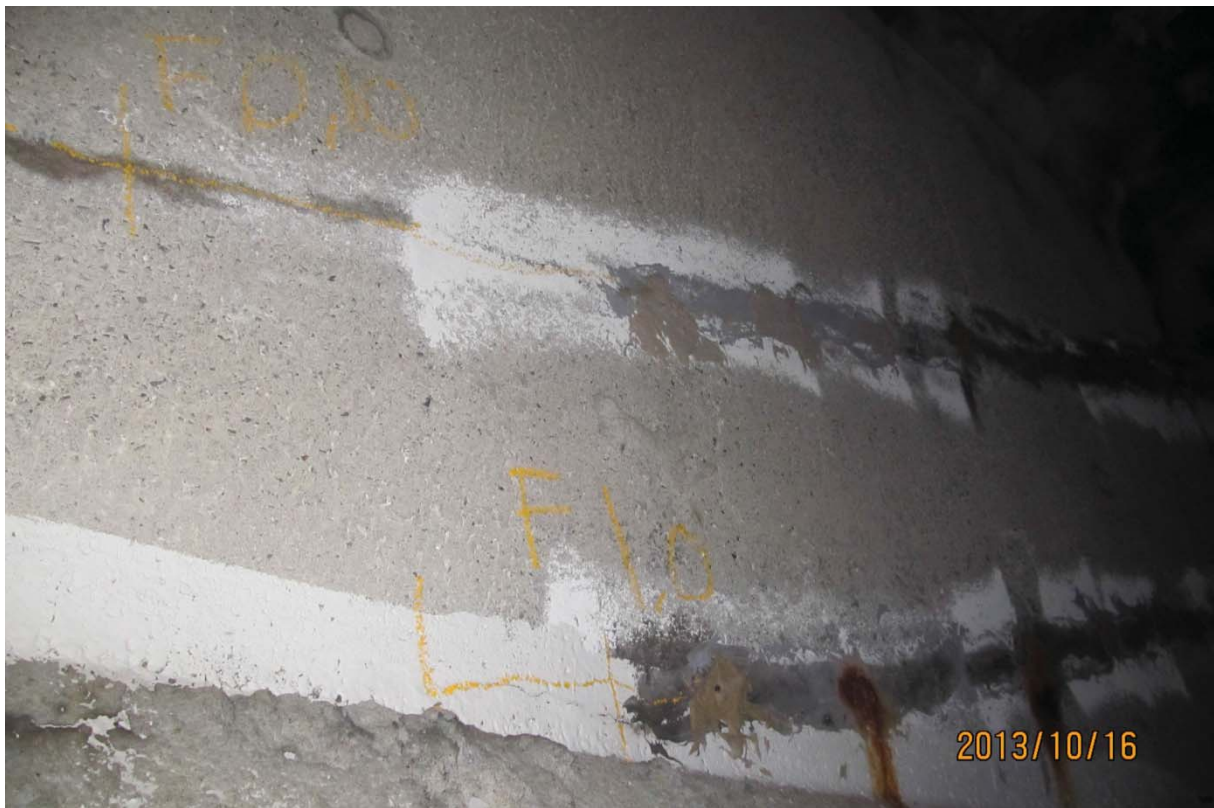
S5.PC.37W-38W.P1.d – 5801 (câbles #19 et #20 - extrémité ouest face aval)
