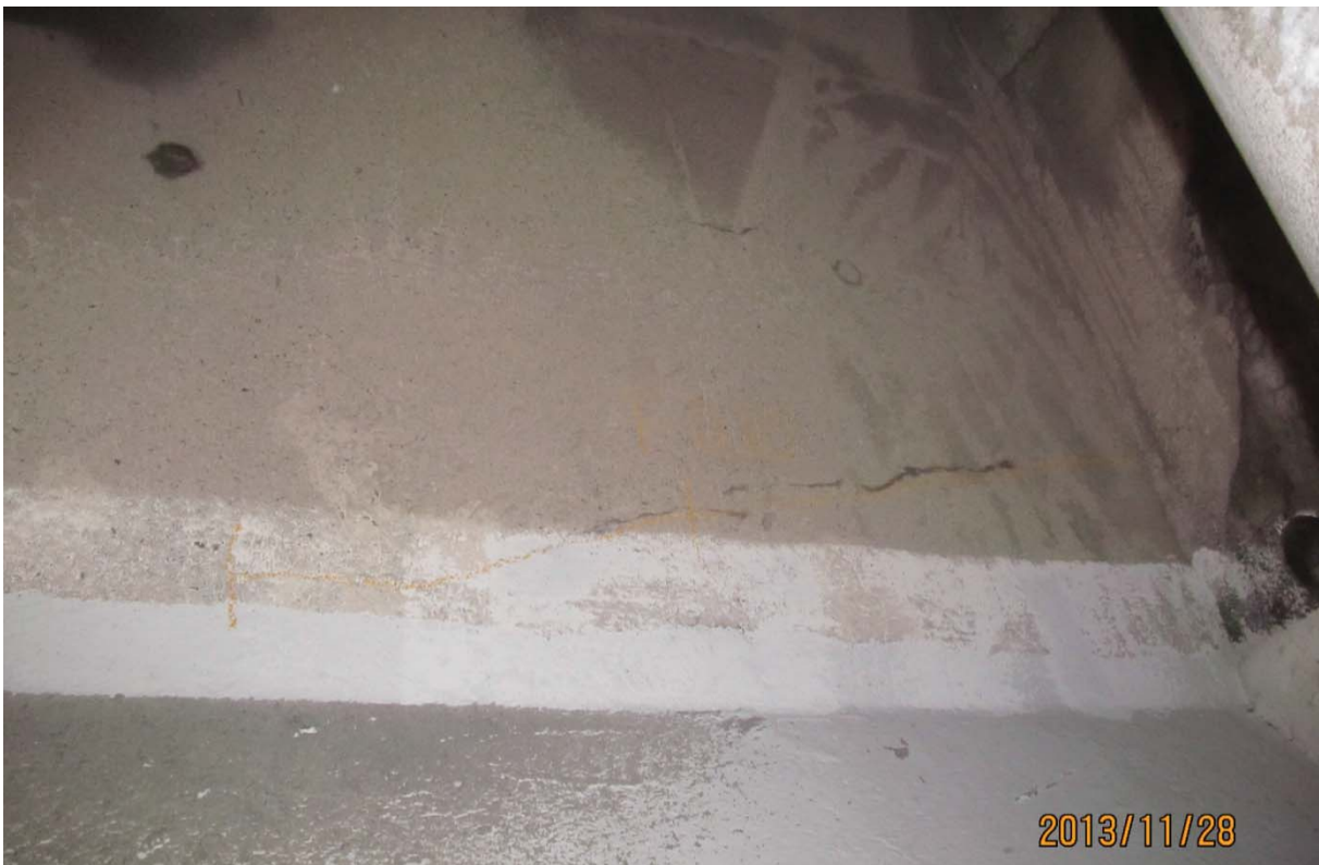
S5.PC.41W-42W.P7.b – 6460 (câble #22 - centre est face amont)
