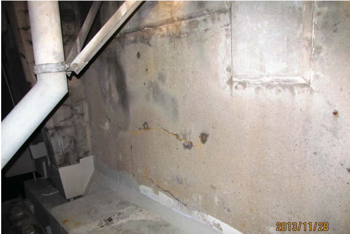
S5.PC.11W-12W.P7.a – 6485 (câble #6 – extrémité ouest face amont)
