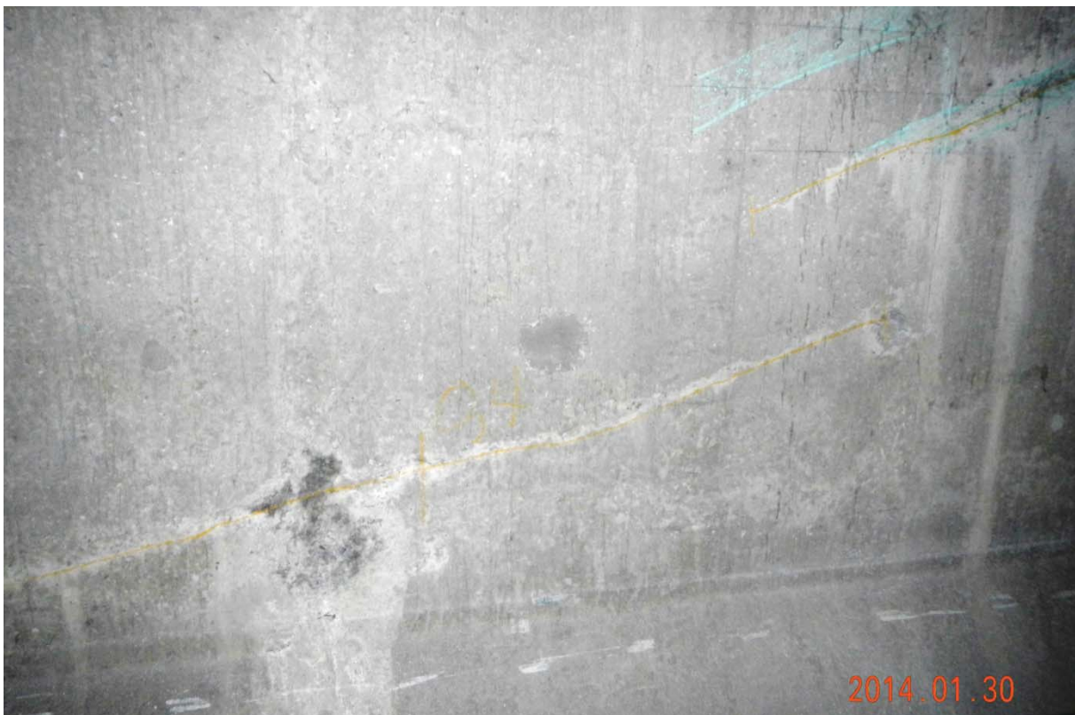
S5.PC.42W-43W.P4.b – 7465 (câble #16 – extrémité est face amont)
