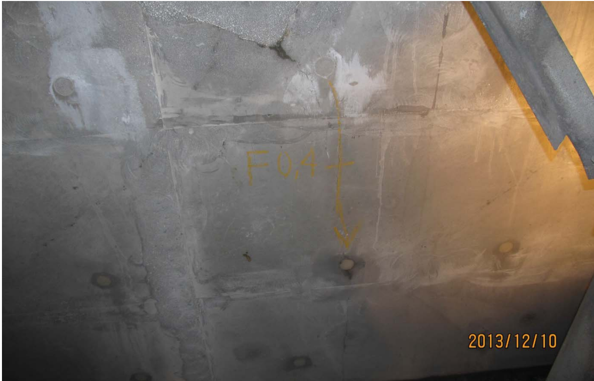
S5.PC.6W-7W.P1.a – 6712 (bloc d'ancrage QP 1.0 extérieur est)
