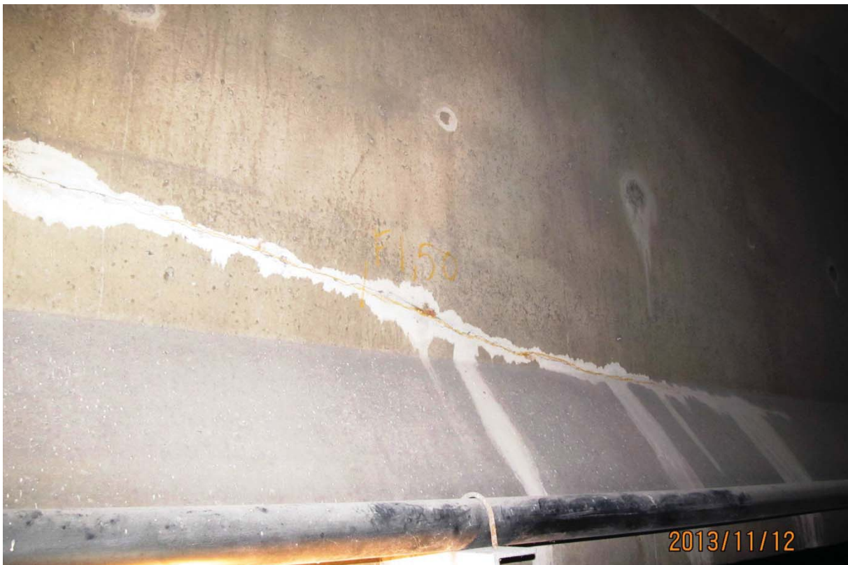
S5.PC.28W-29W.P7.f – 6261 (câble #11 – extrémité est face aval)
