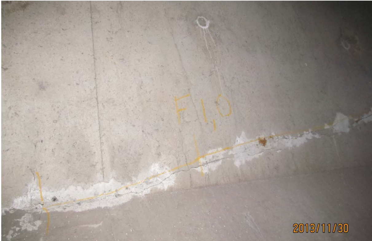
S5.PC.8W-9W.P7.g – 6524 (câble #22 – extrémité ouest face aval)
