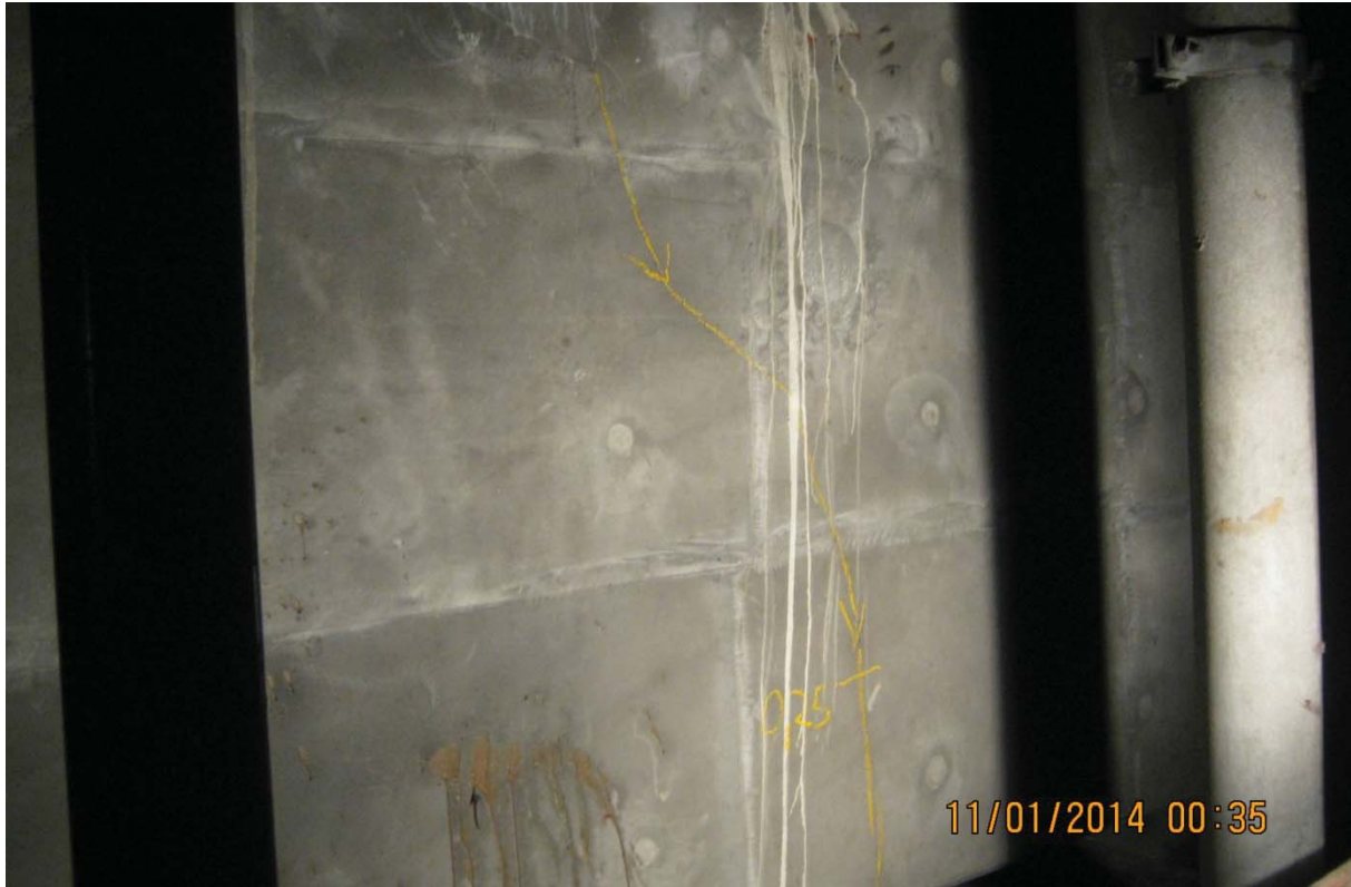
S5.PC.21W-22W.P1.a – 0266 (bloc d'ancrage QP 1.0 - extrémité est face aval)
