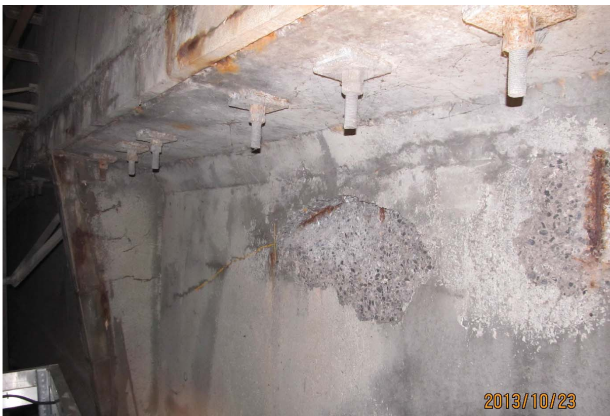
S5.PC.15W-16W.P1.b – 5898 (câble #23 - extrémité ouest face aval)
