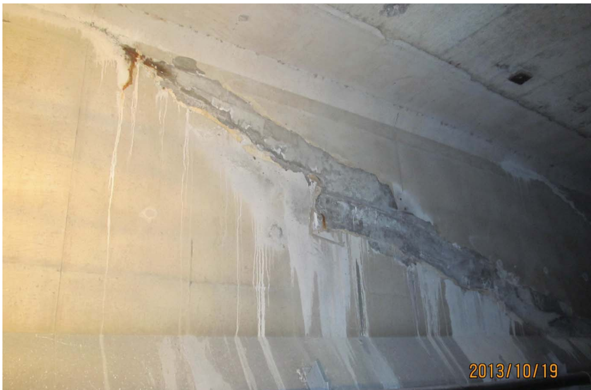
S5.PC.35W-36W.P7.e – 5849 (câble #20 - extrémité est face aval)
