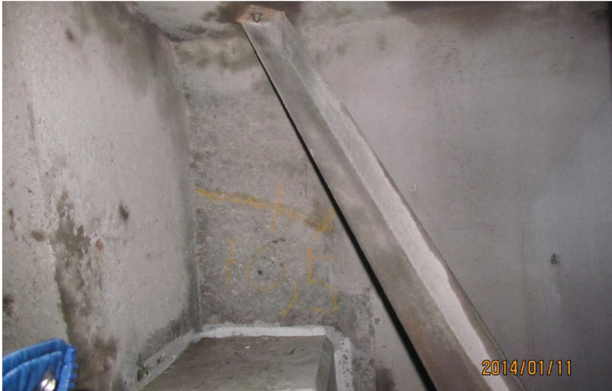
S5.PC.27W-28W.P1.c – 0133 (câble #24 - centre est face aval)
