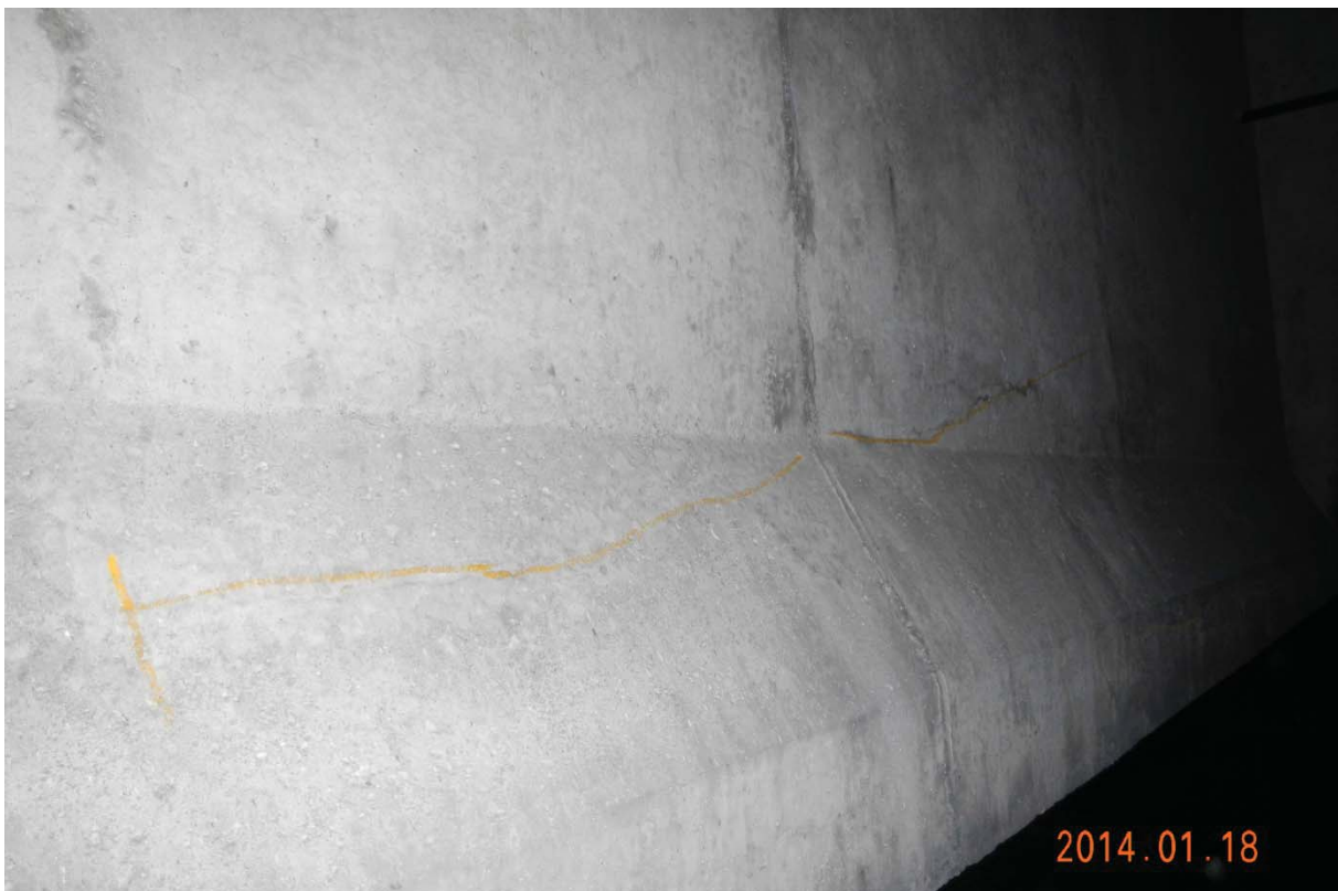
S7.PC.11E-12E.P4.b – 0729 (câble #22 – centre est face amont)
