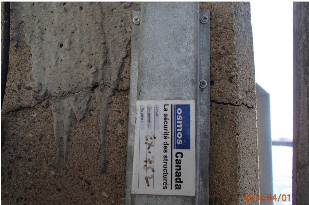
S5.PC.28W-29W.P7.s – 0445 (bloc d'ancrage PTE – extérieur est)
