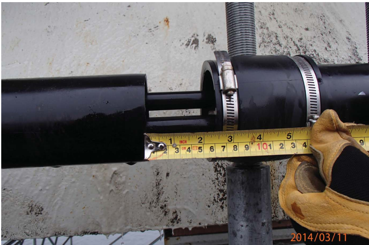
S5.PC.28W-29W.P7.u – 0372 (gaine PTE amont – près du diaphragme 3)
