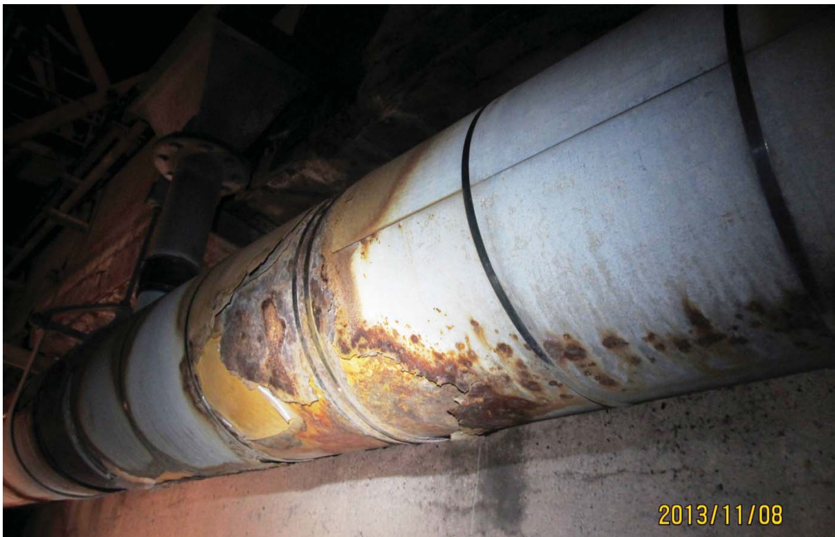
S7.PC.9E-10E.P7.b – 6174 (drain collecteur - face amont)
