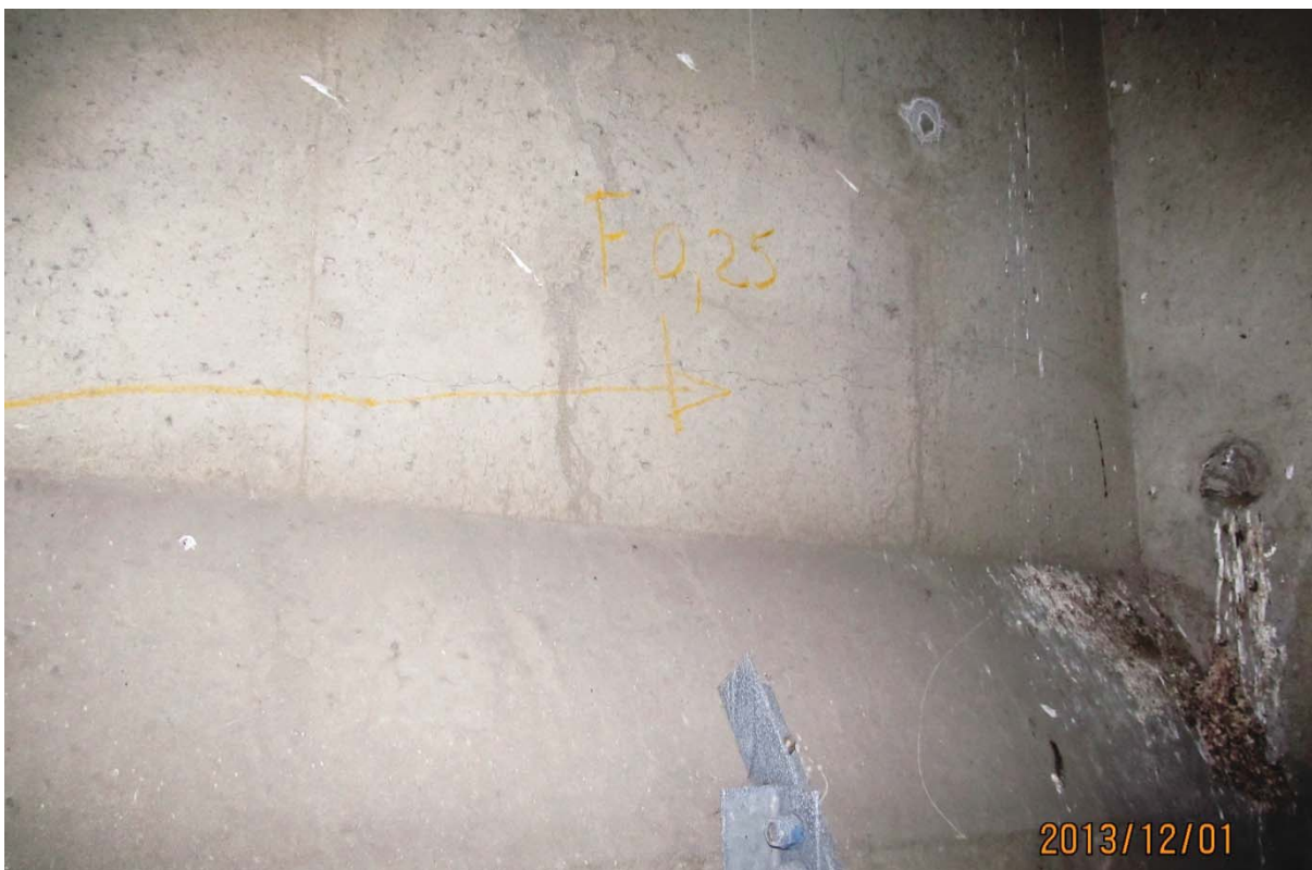
S5.PC.7W-8W.P7.d – 6535 (câble #22 – centre ouest face aval)
