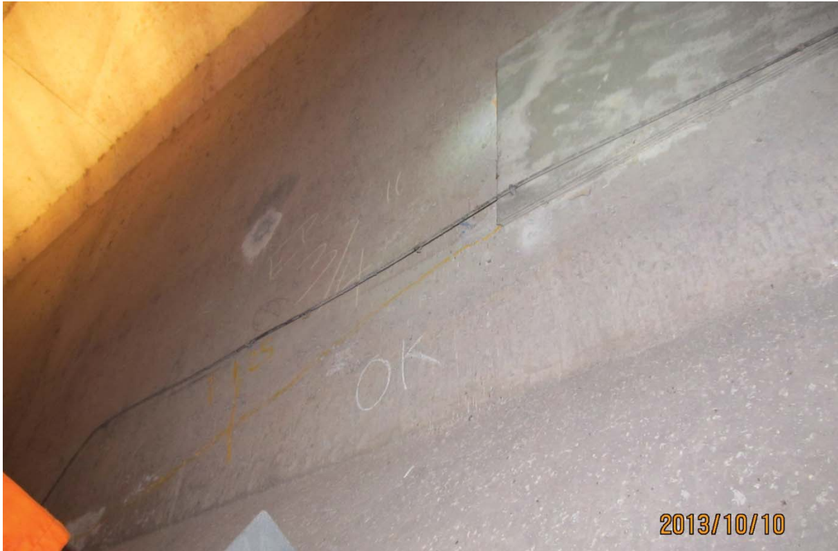
S5.PC.40W-41W.P7.g – 5705 (câble #23 - extrémité ouest face aval)
