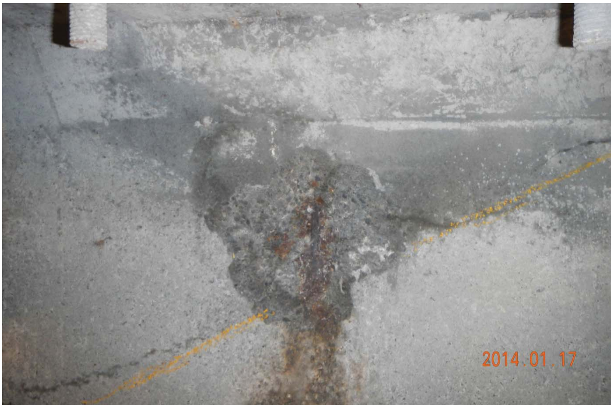
S5.PC.31W-32W.P1.f – 7431 (câble #18 – extrémité ouest face aval)
