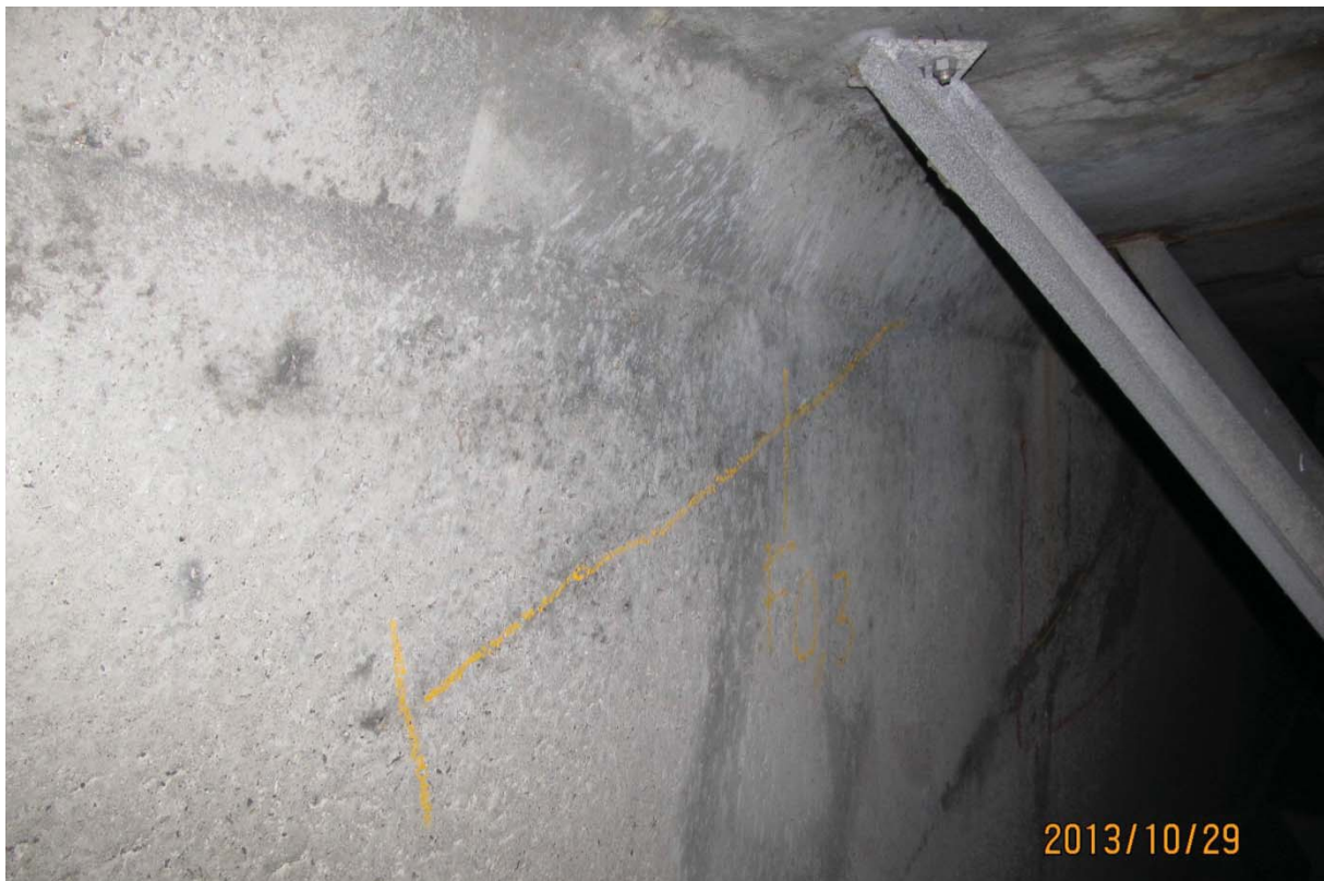
S5.PC.40W-41W.P1.d – 5949 (câble #19 – extrémité ouest face aval)
