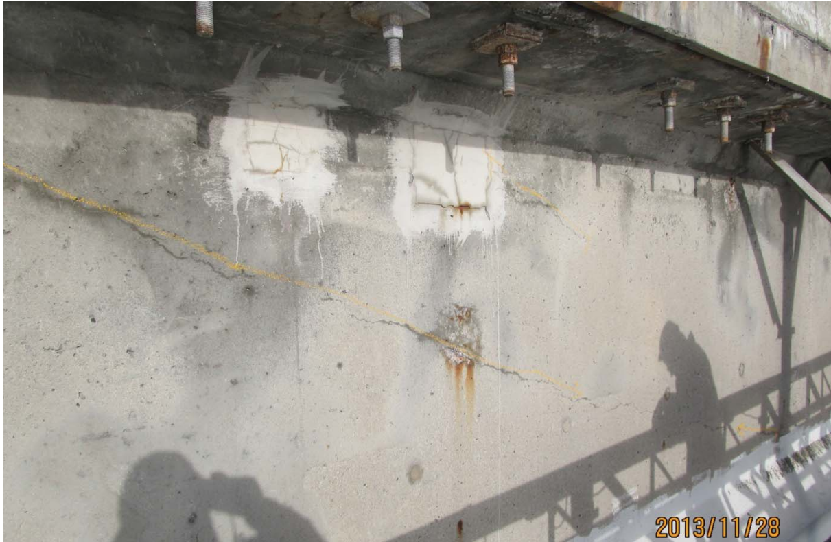
S5.PC.14W-15W.P7.a – 6471 (câbles #15 et #17 – extrémité ouest face amont)
