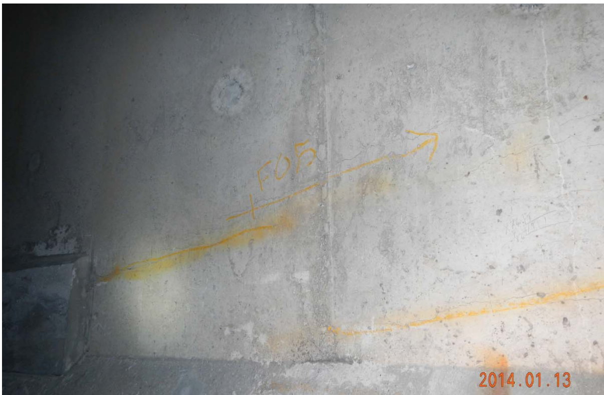
S7.PC.7E-8E.P7.c – 0677 (câbles #23 et #22 – centre ouest face aval)
