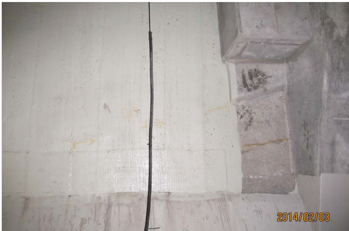
S7.PC.11E-12E.P7.a – 0232 (câbles #22 et #21 – centre est face amont)
