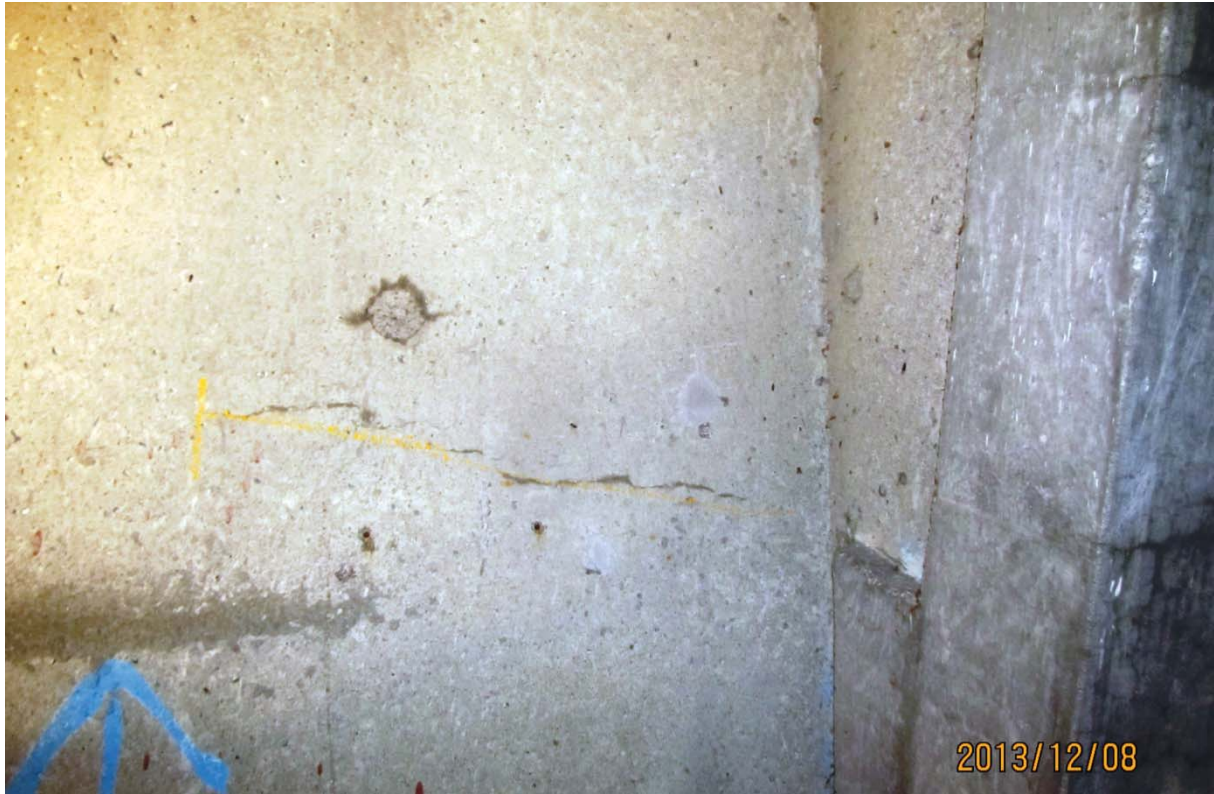
S5.PC.8W-9W.P1.a – 6661 (câble #22 - extrémité est face aval)
