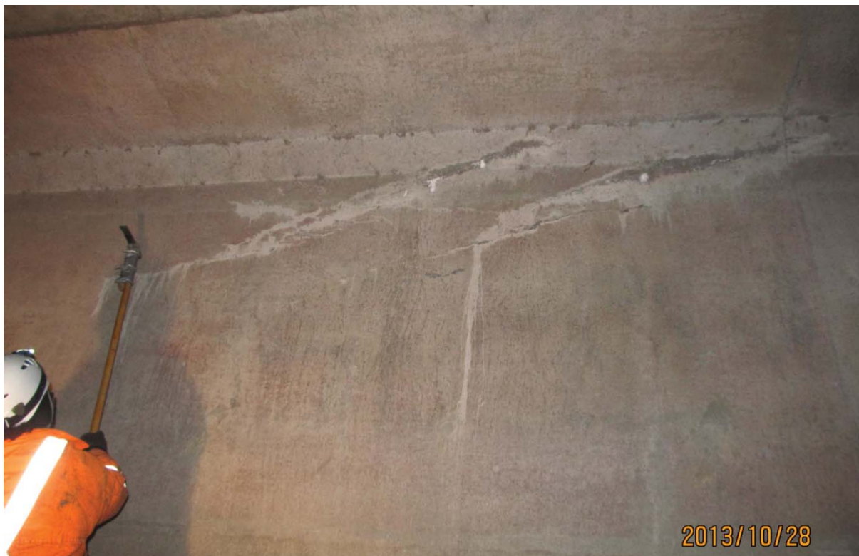
S5.PC.40W-41W.P1.g – 5940 (câbles #17 et #18 – extrémité est face amont)
