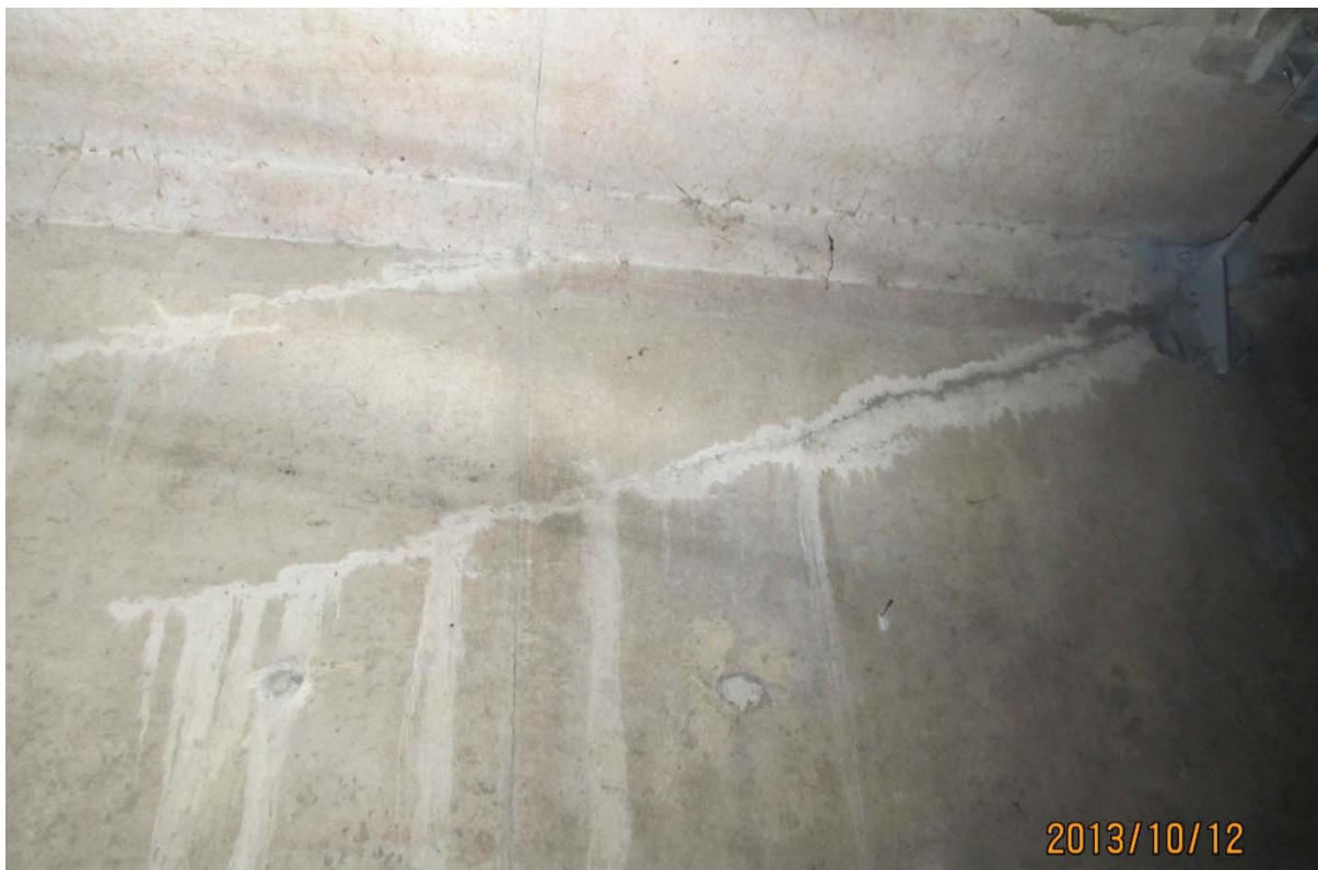
S5.PC.41W-42W.P1.j – 5757 (câbles #19 et #20 - extrémité est face amont)
