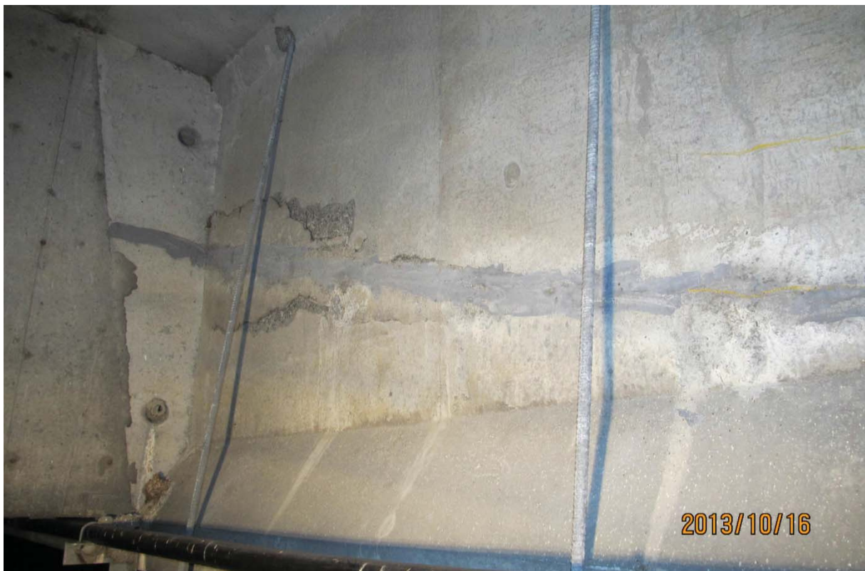
S5.PC.37W-38W.P1.h – 5795 (câble #23 - centre ouest face amont)
