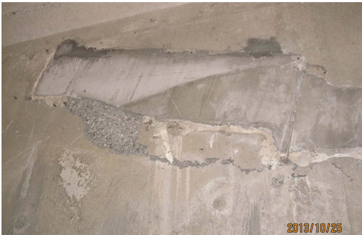
S5.PC.30W-31W.P7.e – 5936 (câble #19 - extrémité est face aval)
