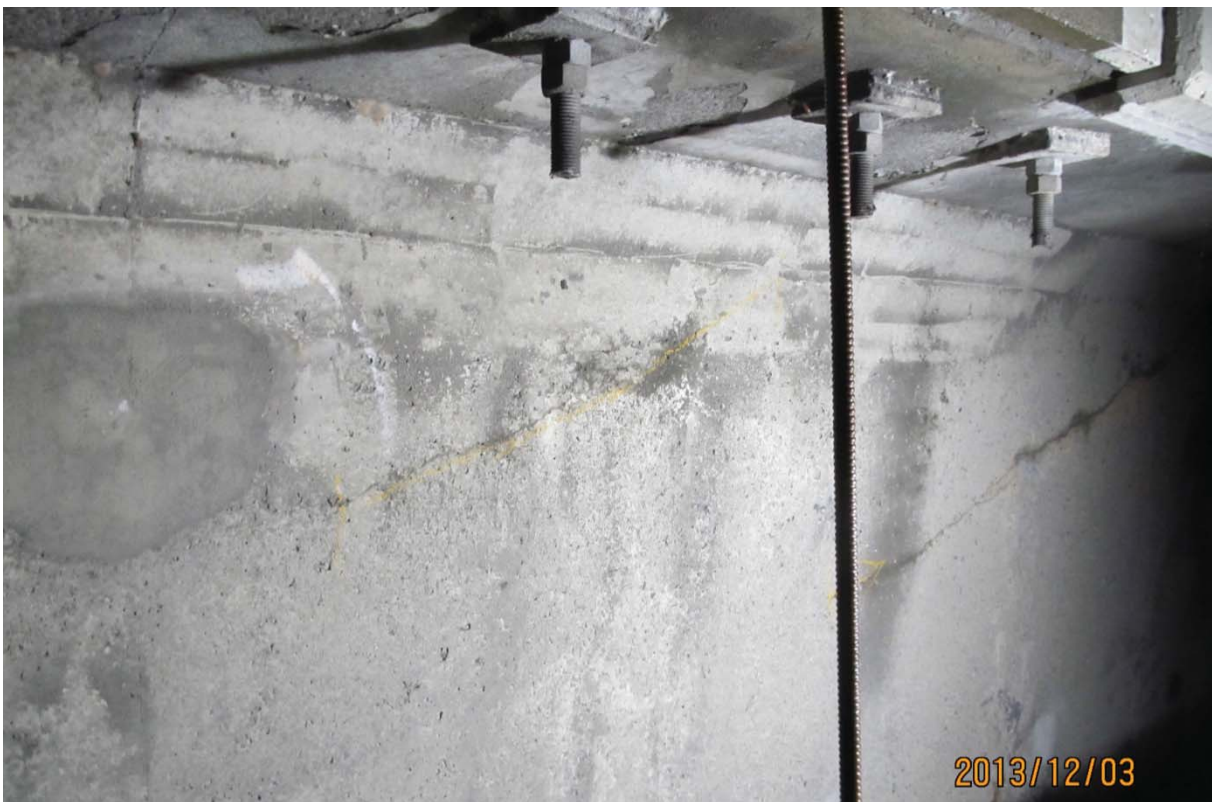
S5.PC.28W-29W.P1.b – 6550 (câble 18 - extrémité ouest face aval)
