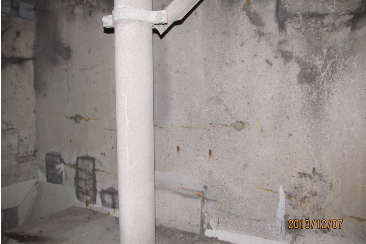
S5.PC.16W-17W.P1.a – 6652 (âme – extrémité est face aval)
