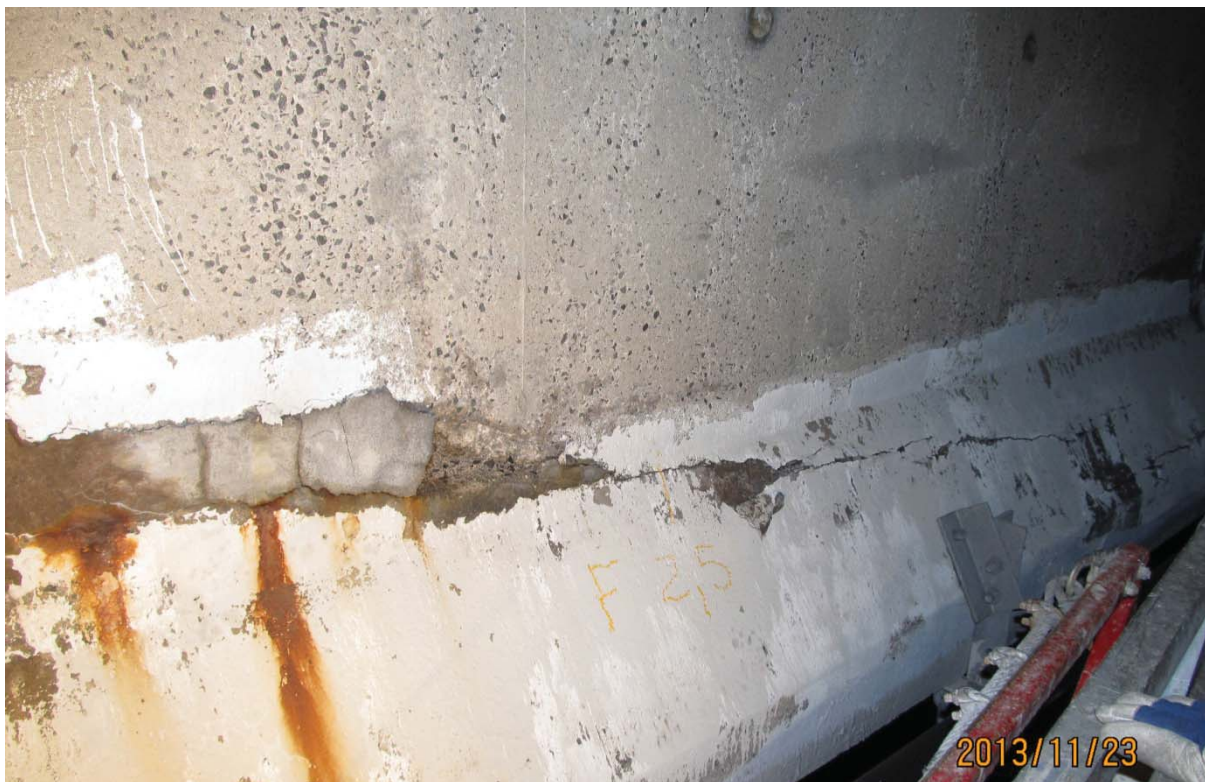
S5.PC.29W-30W.P7.g – 6394 (câble #24 – centre ouest face amont)
