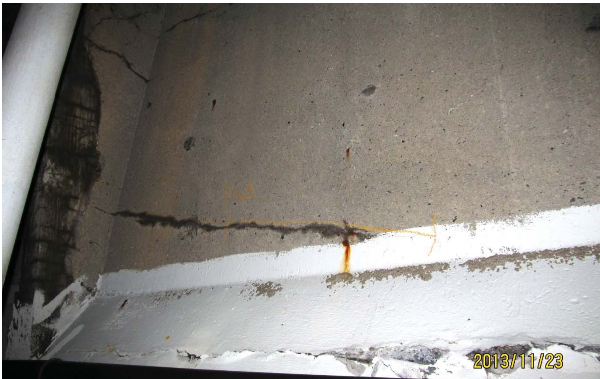
S5.PC.13W-14W.P7.b – 6408 (câble #22 – centre ouest face amont)
