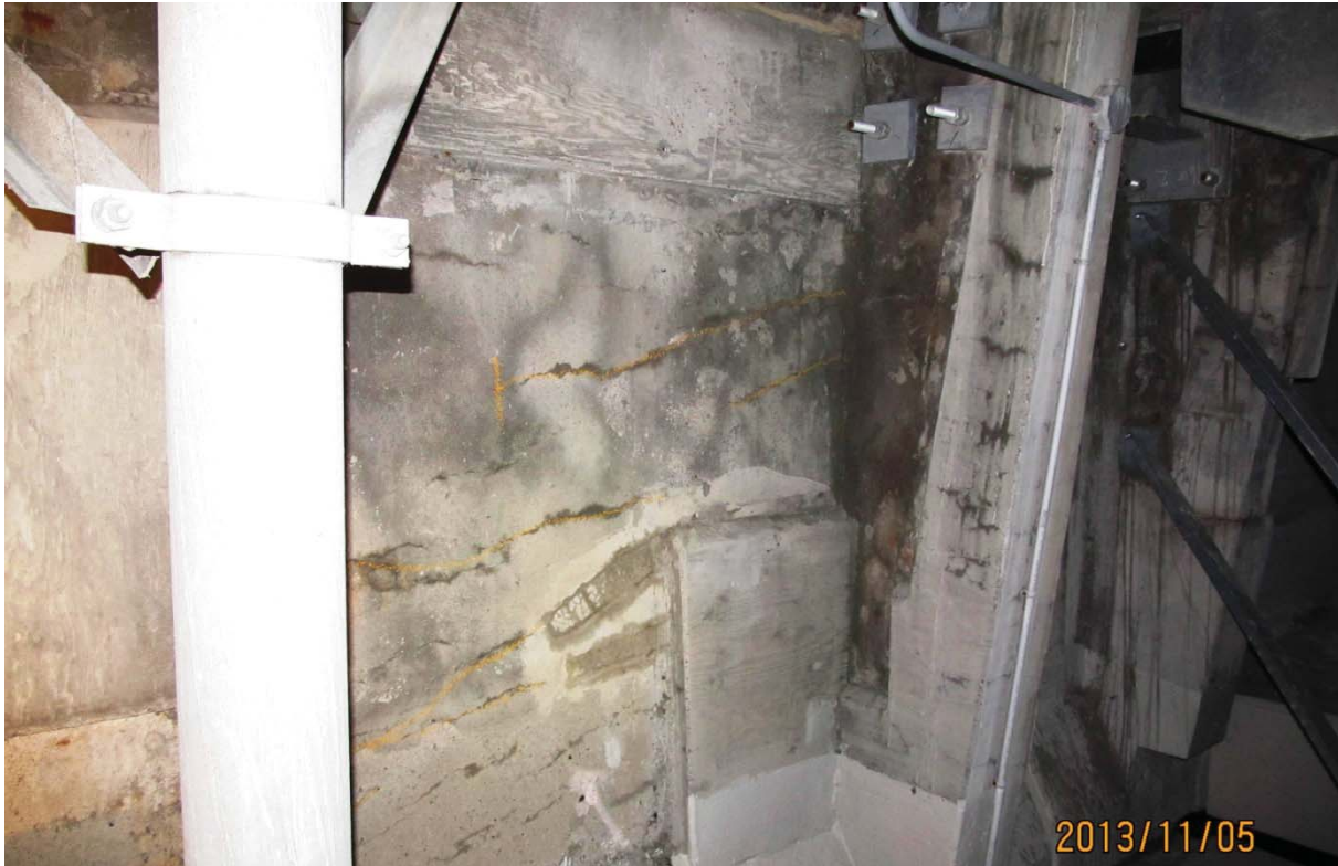
S5.PC.16W-17W.P7.j – 6117 (câbles #11 et #7 – extrémité est face amont)
