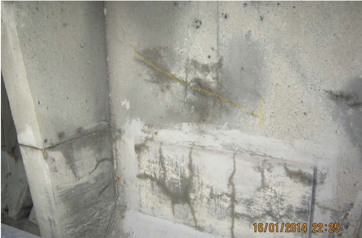
S5.PC.11W-12W.P1.a – 0287 (câble #8 - extrémité est face aval)
