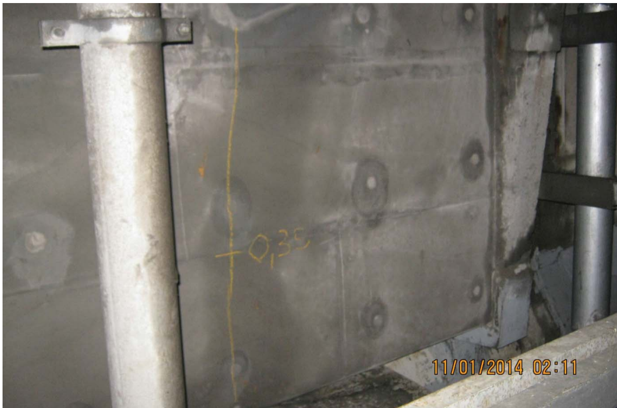
S5.PC.21W-22W.P1.b – 0268 (bloc d'ancrage QP 1.0 - extrémité ouest face aval)
