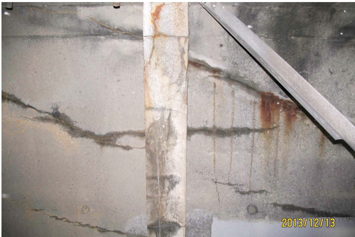
S5.PC.31W-32W.P7.c – 6790 (câbles #22, #23 et #24 - extrémité ouest/centre ouest face amont)
