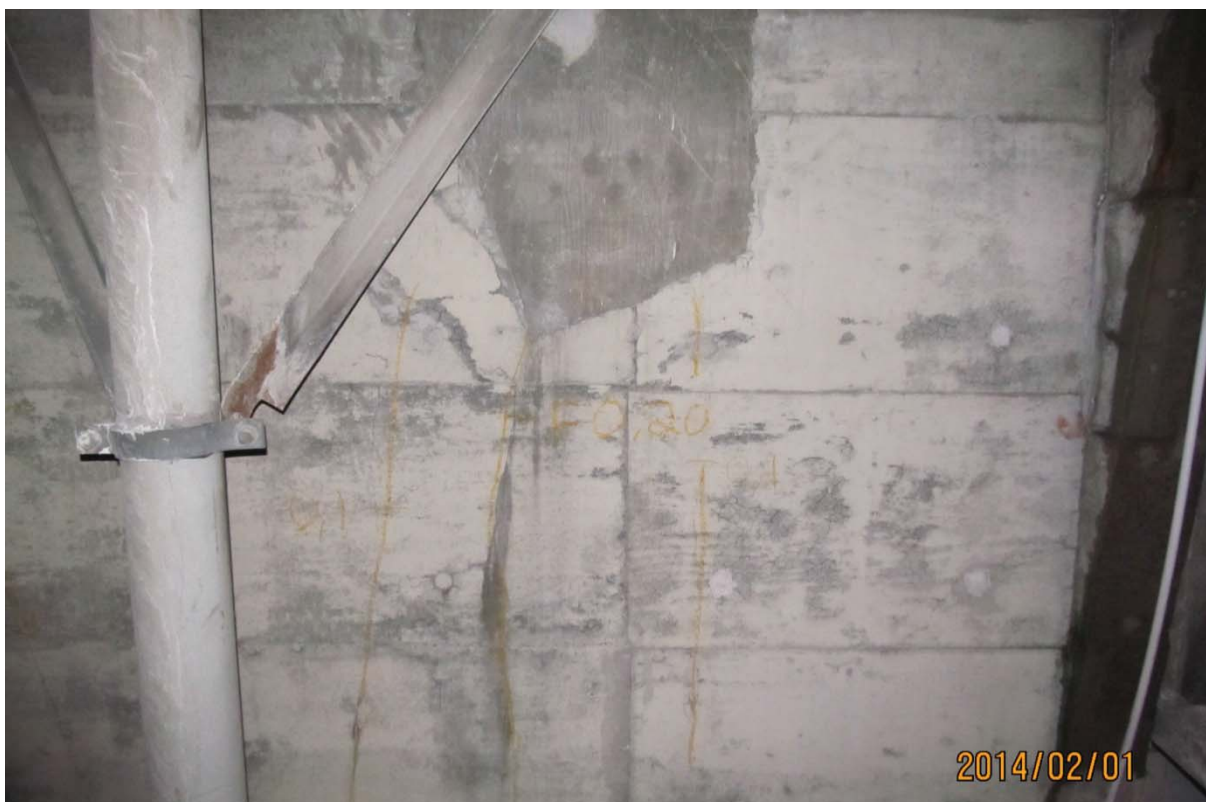
S5.PC.33W-34W.P7.b – 0210 (bloc d'ancrage QP 1.0 extérieur est)
