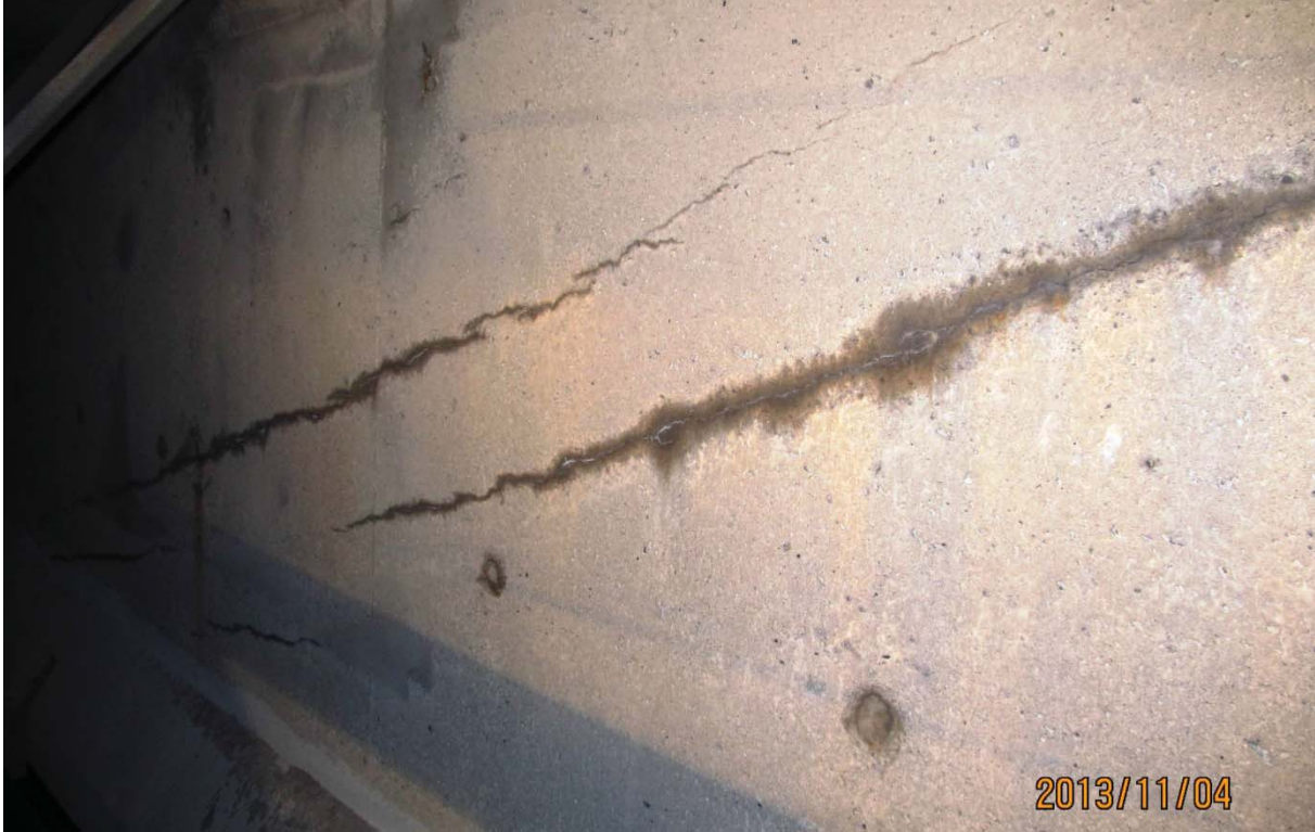
S5.PC.18W-19W.P1.e – 6089 (câbles #18, #17 et #16 – extrémité ouest face aval)
