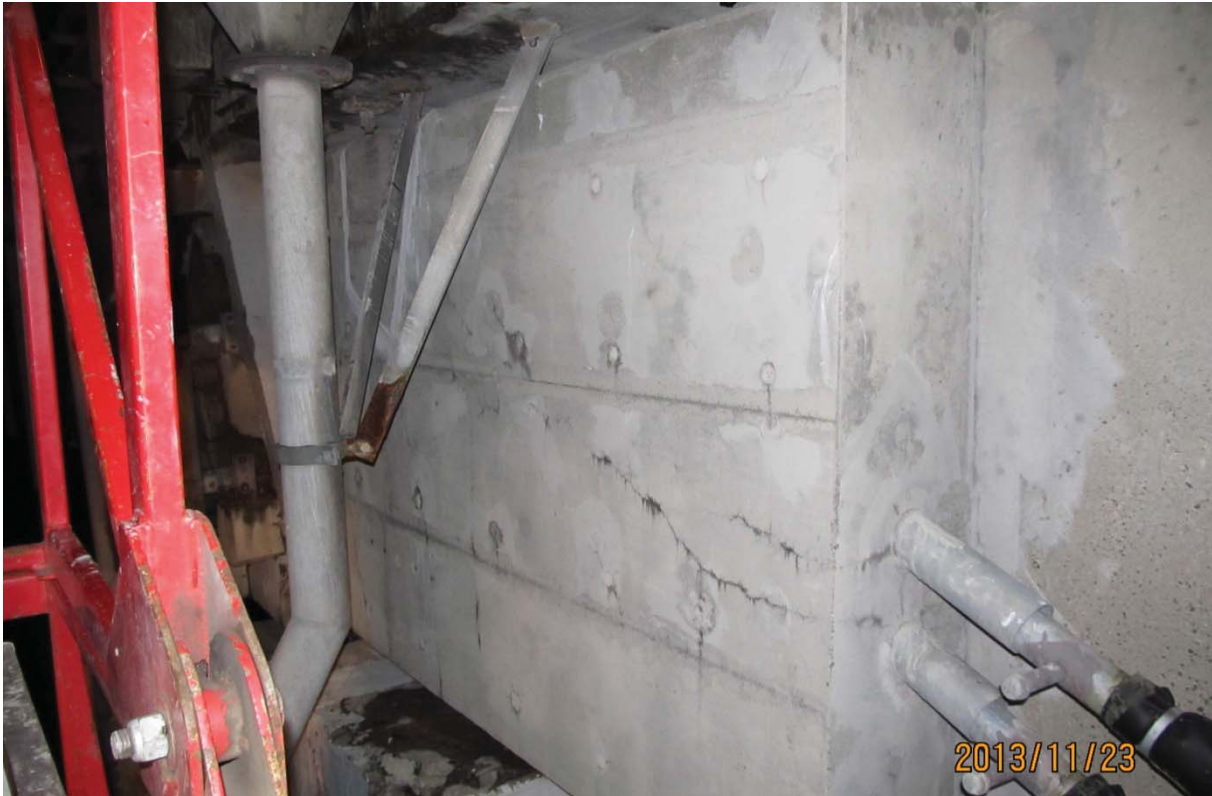
S5.PC.29W-30W.P7.a – 6385 (bloc d'ancrage QP 1.0 – extérieur ouest)
