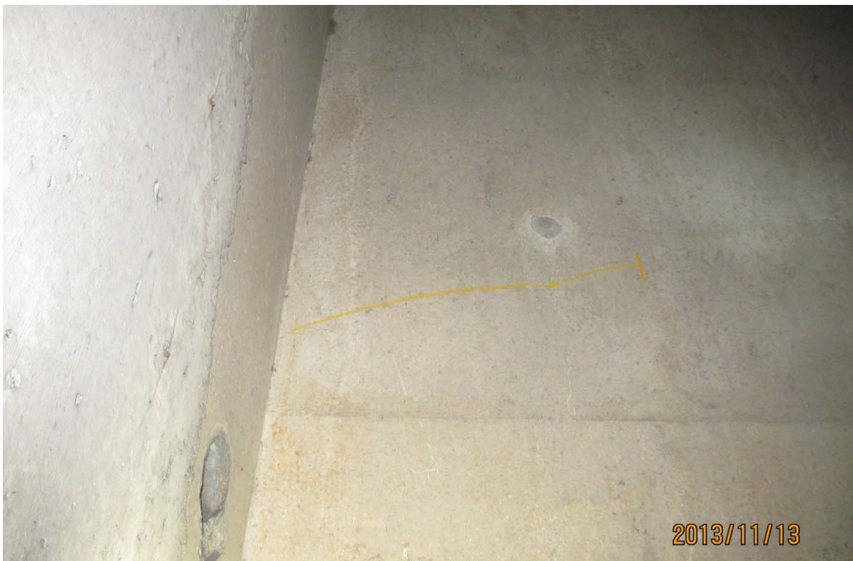
S5.PC.24W-25W.P7.h – 6272 (câble #22 – extrémité ouest face aval)
