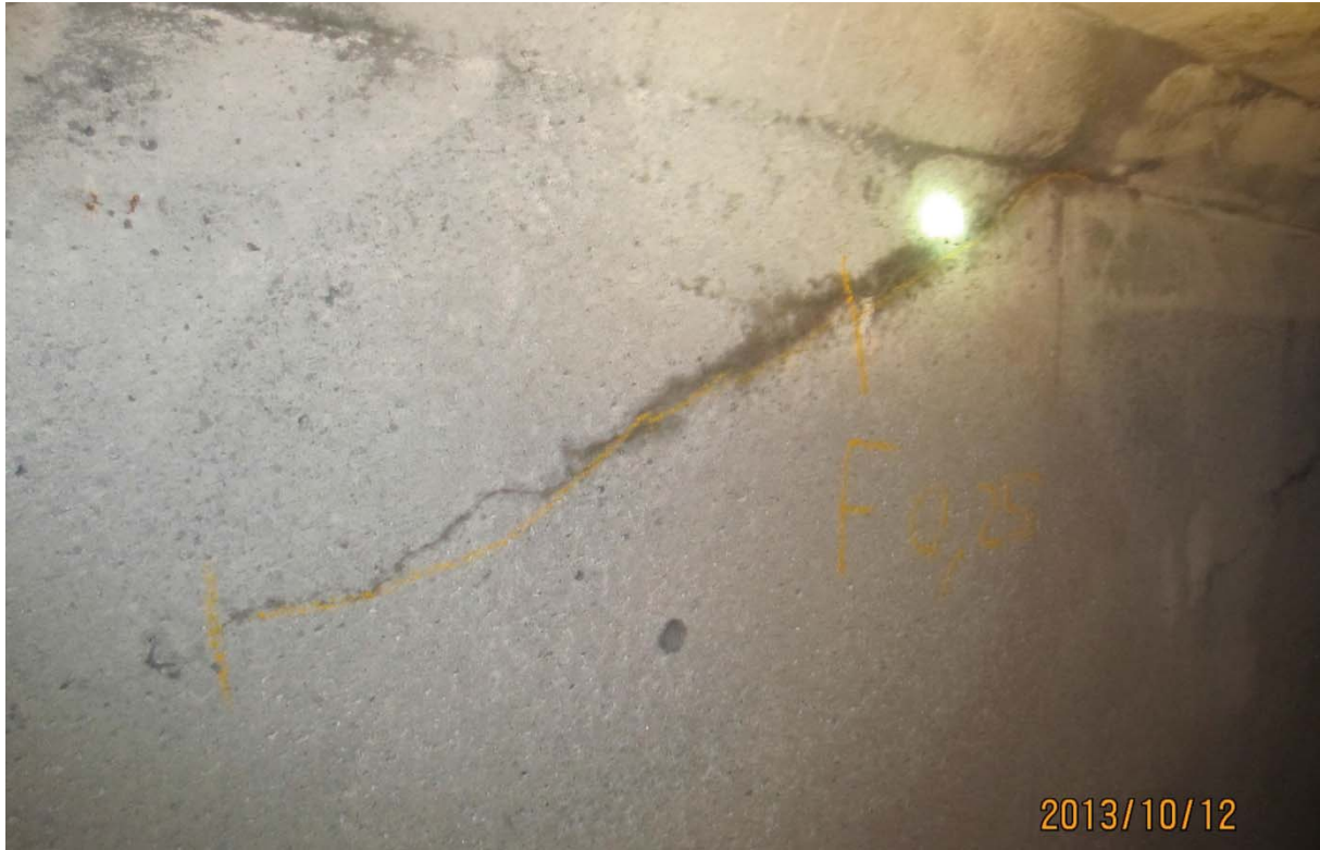
S5.PC.41W-42W.P1.e – 5762 (câble #20 - extrémité ouest face aval)
