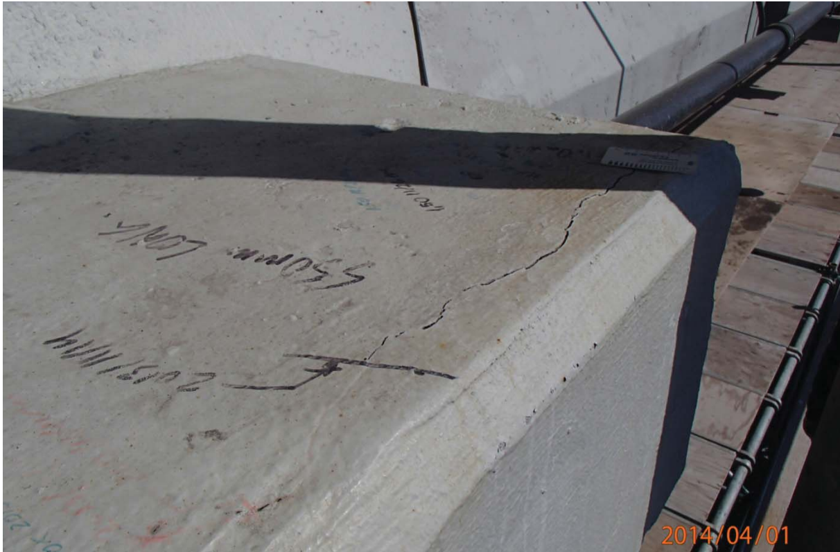
S5.PC.28W-29W.P7.q – 0532 (bloc d'ancrage PTE – extérieur ouest)
