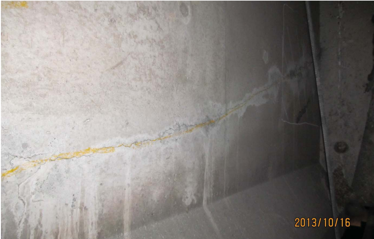
S5.PC.37W-38W.P1.j – 5787 (câble #23 - centre est face amont)
