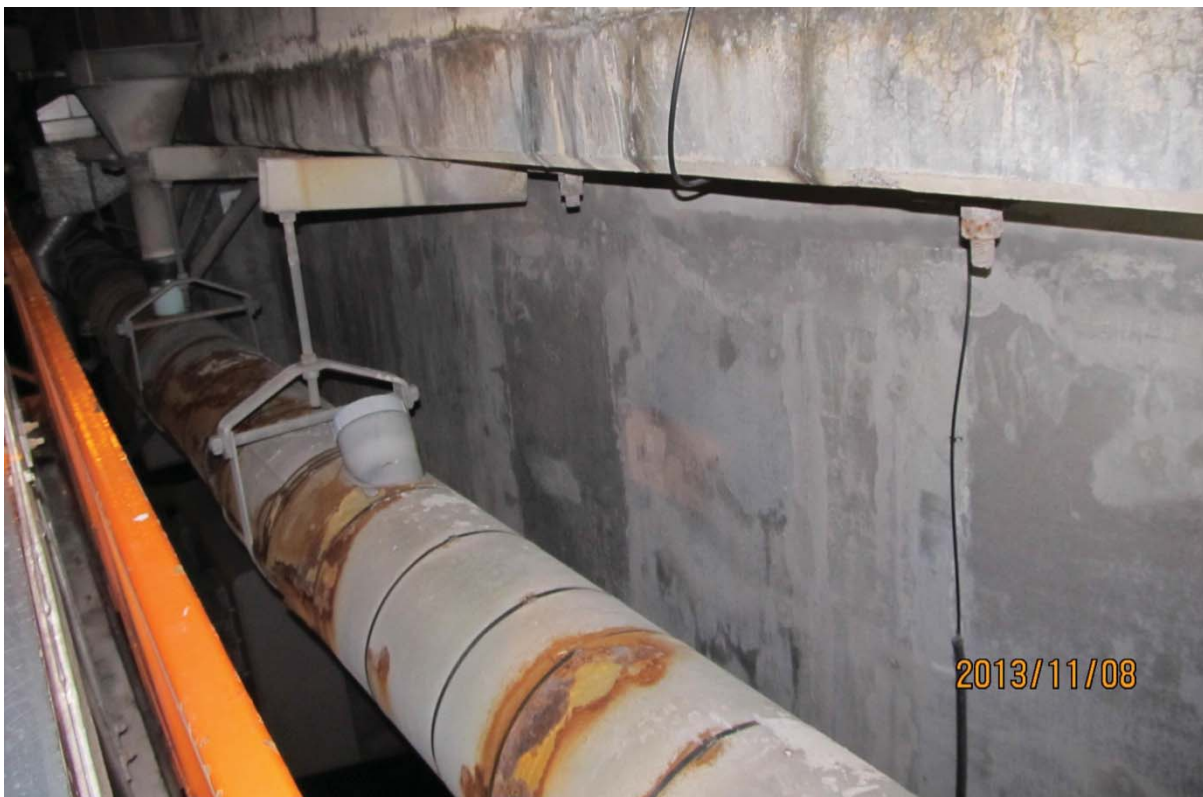
S7.PC.10E-11E.P7.a – 6185 (drain collecteur – face amont)
