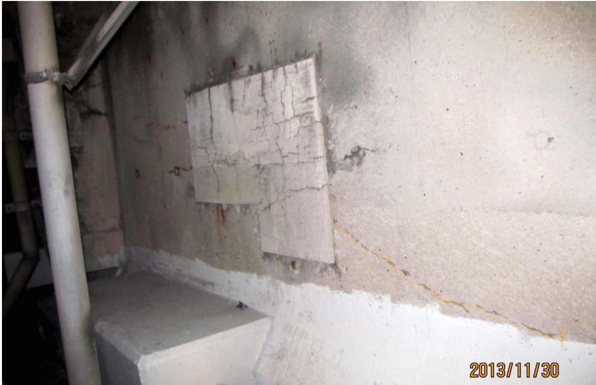
S5.PC.7W-8W.P7.a – 6532 (câble #9 – extrémité ouest face amont)
