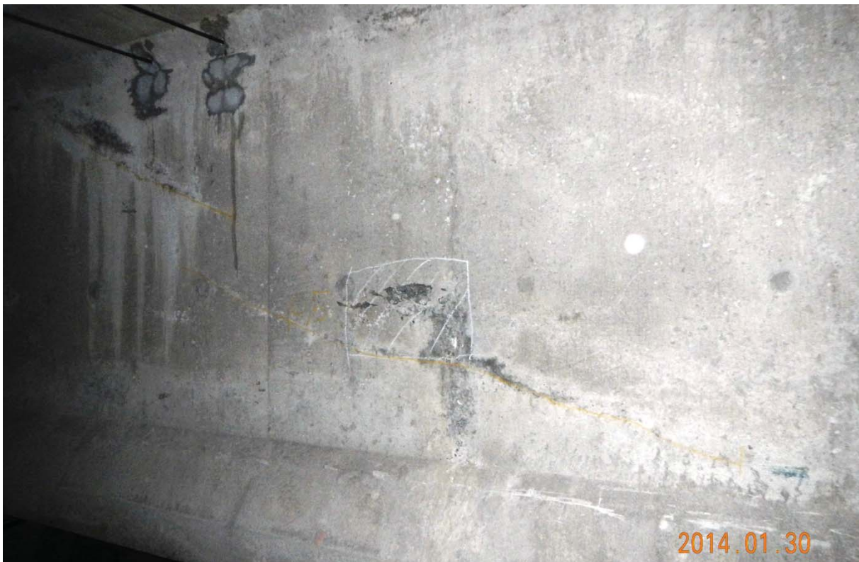
S5.PC.42W-43W.P4.d – 7463 (câbles #17 et #16 – extrémité est face aval)
