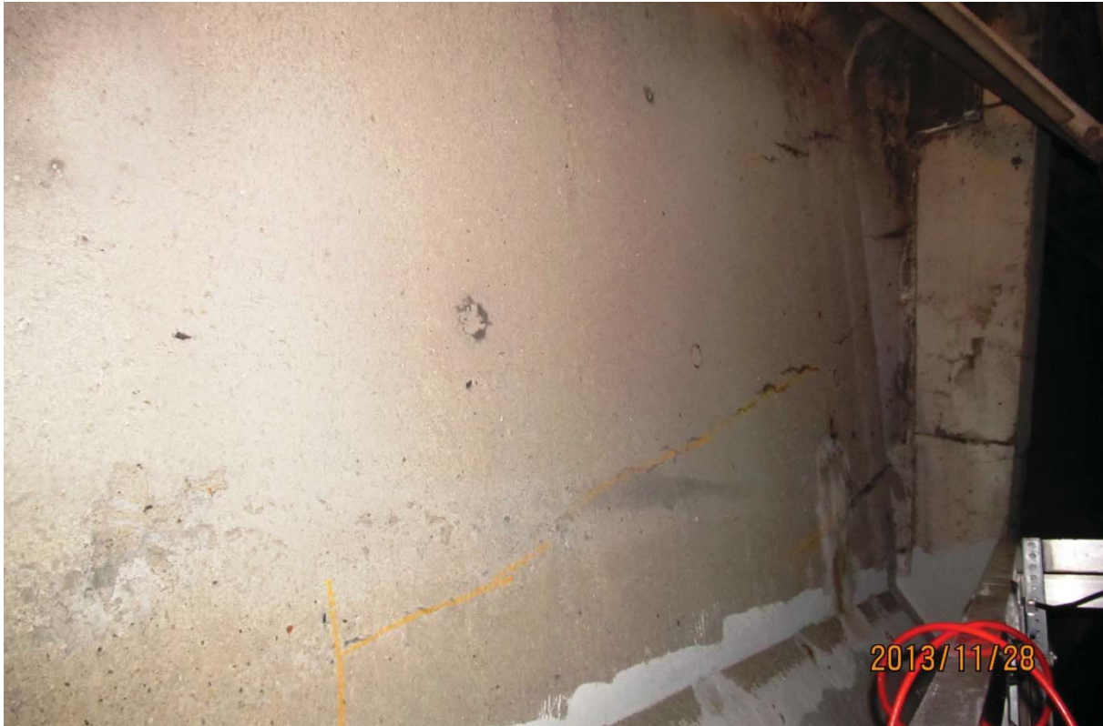
S5.PC.11W-12W.P7.e – 6494 (câble #23 – centre est face amont)
