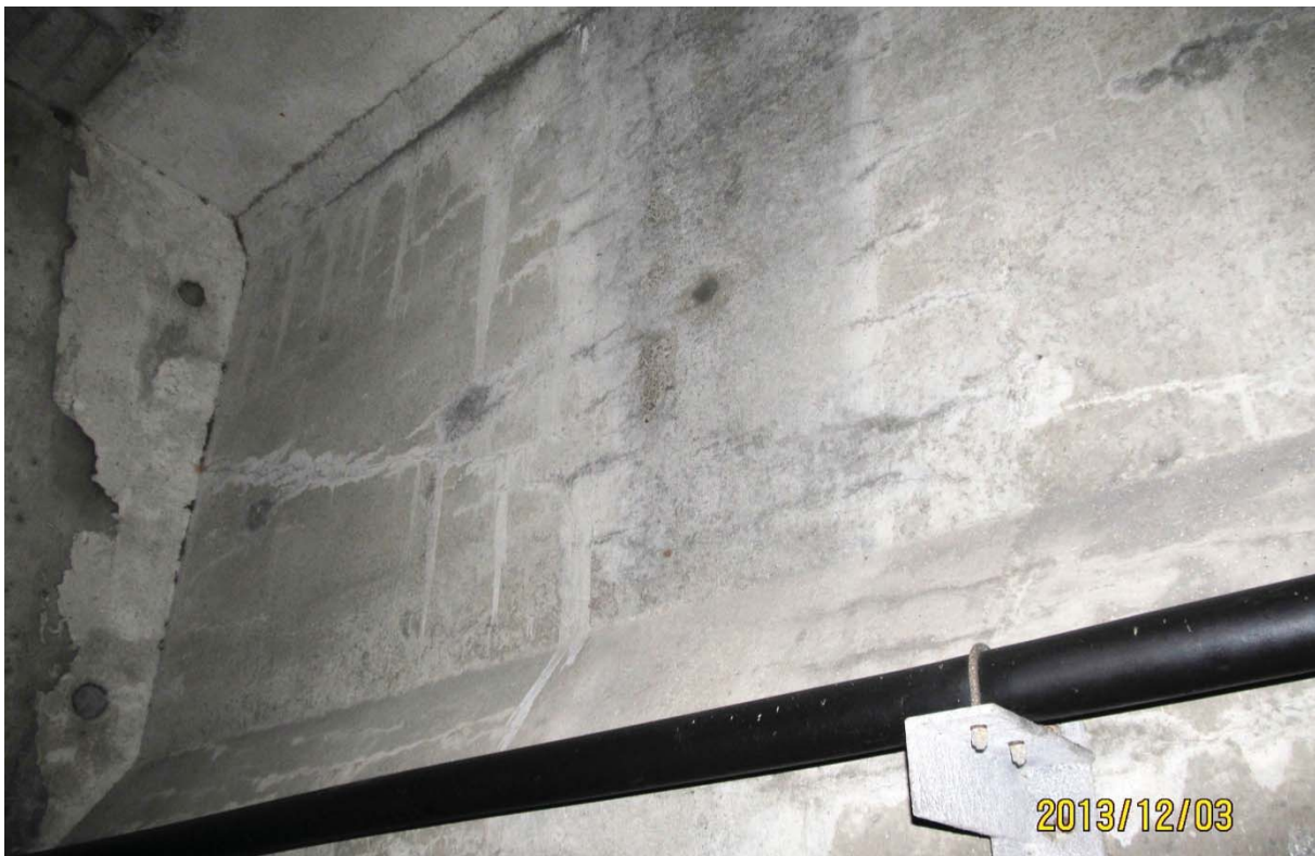
S5.PC.30W-31W.P1.f – 6557 (câble #23 - centre ouest face amont)
