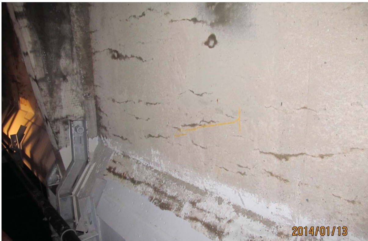
S7.PC.5E-6E.P7.c – 0150 (câble #21 - extrémité est face amont)
