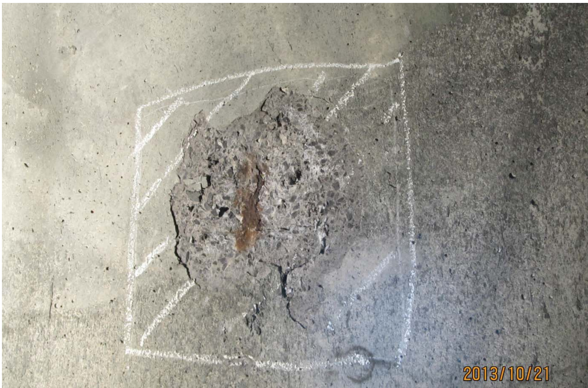
S7.PC.9E-10E.P1.b – 5873 (âme - extrémité ouest face aval)
