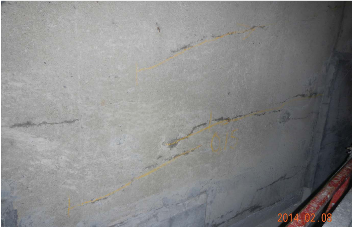
S7.PC.13E-14E.P7.c – 7575 (âme – extrémité ouest face amont)
