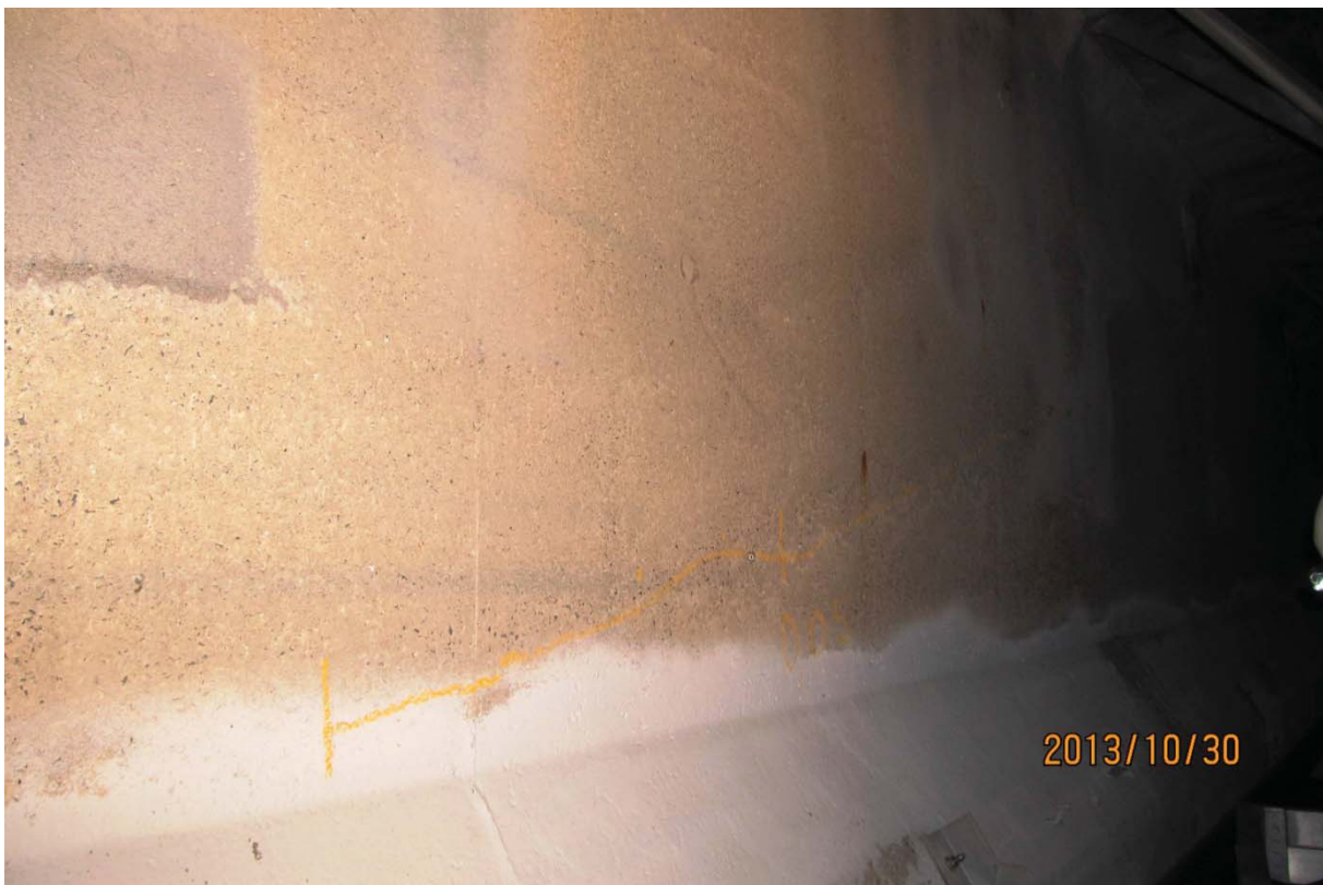
S5.PC.25W-26W.P7.b – 5973 (câble #20 – extrémité est face amont)
