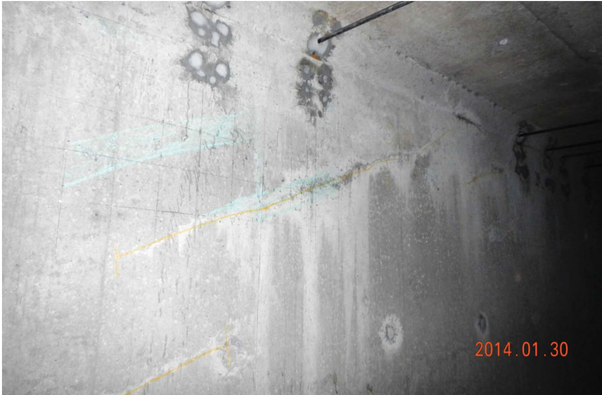
S5.PC.42W-43W.P4.c – 7464 (câbles #17 et #16 – extrémité est face amont)
