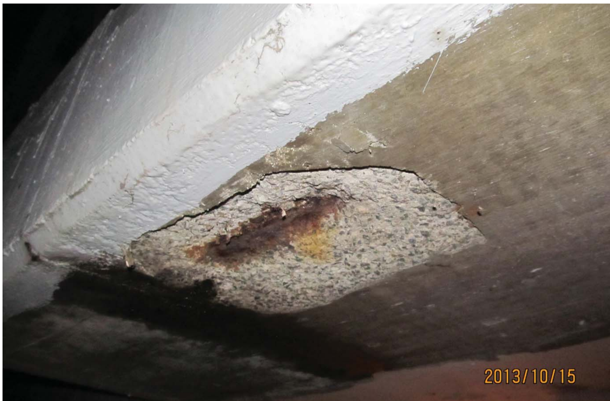
S5.PC.37W-38W.P1.l – 5770 (Bloc d’ancrage extérieur est)
