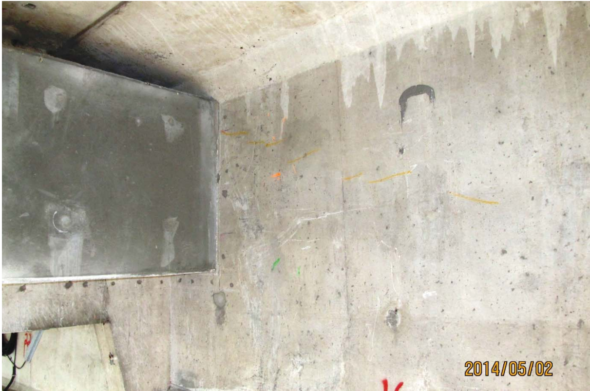
S7.PC.13E-14E.P7.j – 0477 (câble #19 – extrémité est face aval)
