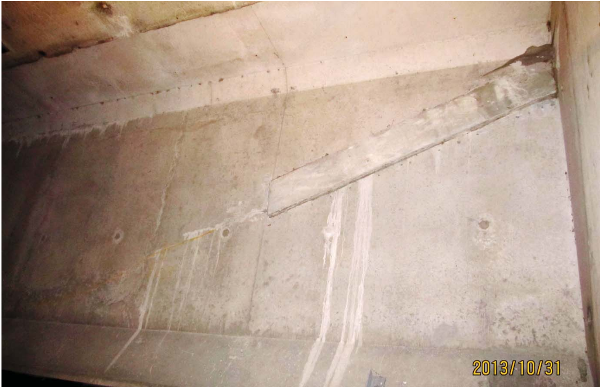
S5.PC.35W-36W.P1.e – 6070 (câble #24 - centre est face amont)
