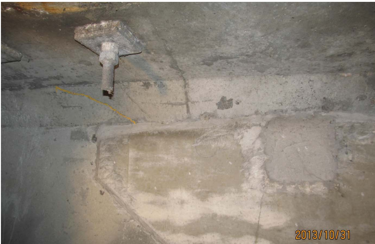
S5.PC.35W-36W.P1.b – 6066 (câble #23 - extrémité est face aval)
