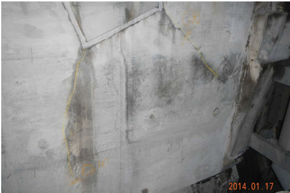
S5.PC.31W-32W.P1.b – 7436 (bloc d'ancrage QP 1.0 extérieur ouest)
