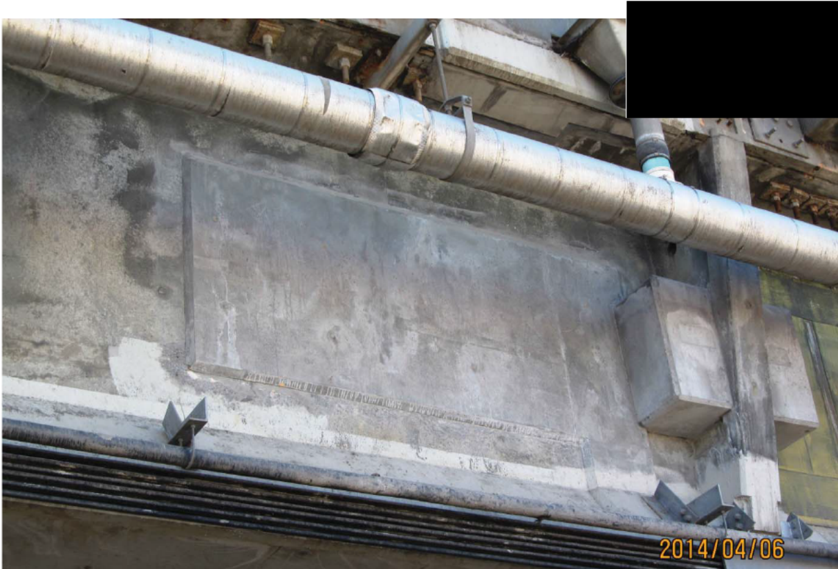
S5.PC.42W-43W.P1.b – 0416 (câble #24 - centre ouest face aval)
