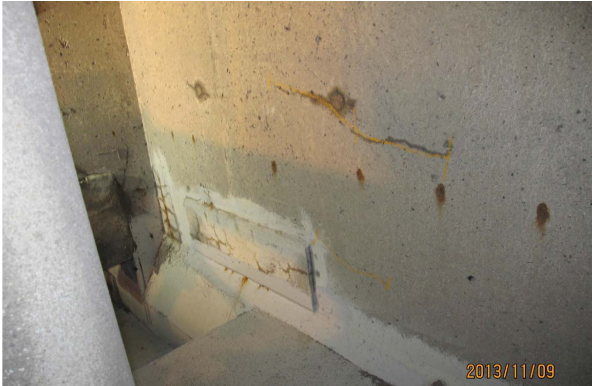
S5.PC.5W-6W.P1.a – 6210 (câble #9 - extrémité est face aval)
