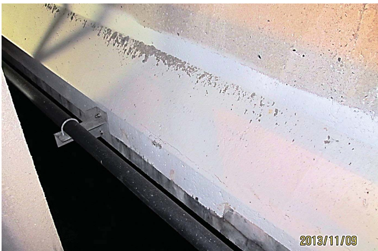
S5.PC.4W-5W.P1.b – 6196 (semelle inférieure - face aval)
