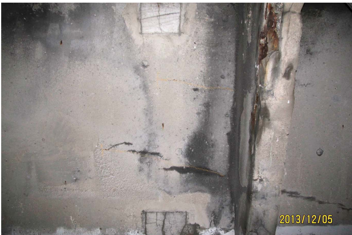
S5.PC.04W-05W.P7.b – 6591 (câbles #22 et #23 – extrémité/centre ouest face amont)
