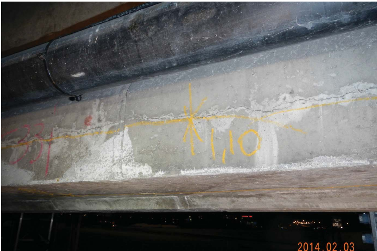
S7.PC.12E-13E.P7.k – 0807 (semelle inférieure – extrémité est face aval)
