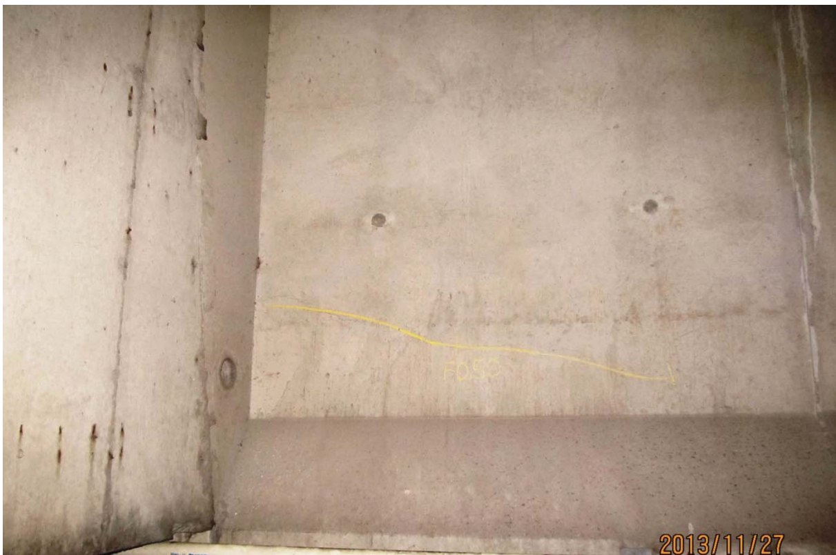
S5.PC.19W-20W.P7.h – 6443 (câble #22 – centre est face aval)
