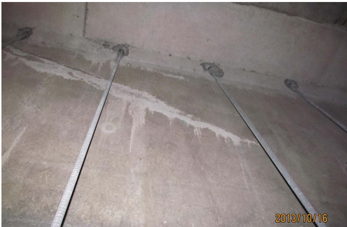
S5.PC.37W-38W.P1.e – 5809 (câble #15 - extrémité ouest face amont)
