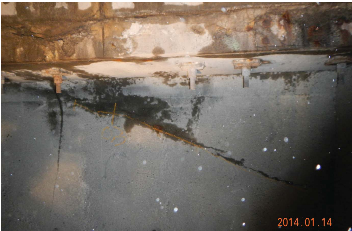
S5.PC.31W-32W.P1.d – 7341 (câble #23 – extrémité est face aval)
