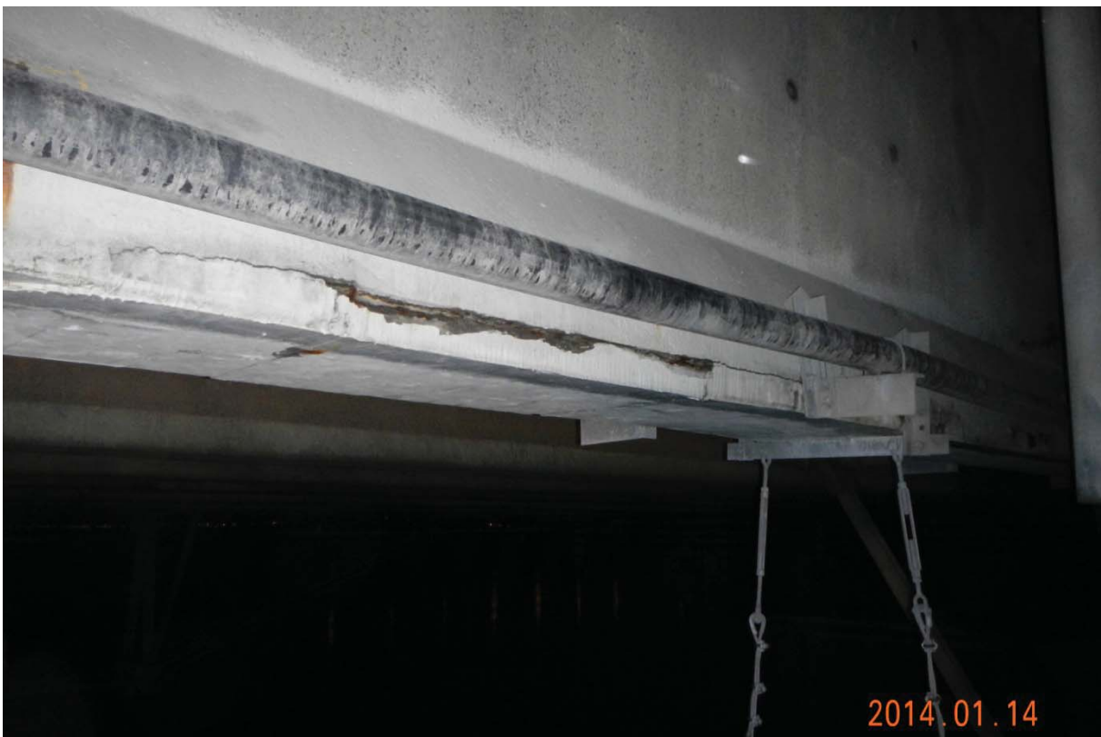
S5.PC.29W-30W.P1.h – 7329 (soffite - centre)
