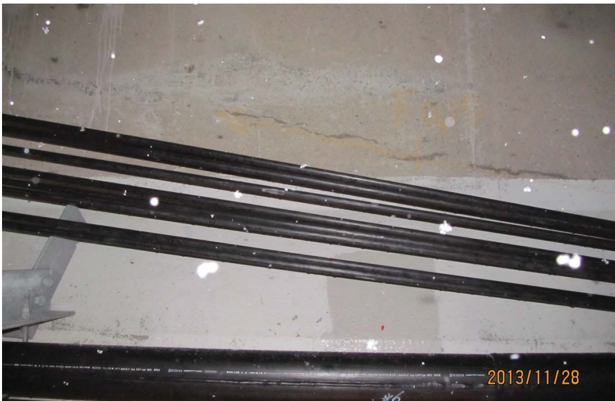
S5.PC.39W-40W.P7.a – 6465 (câble #20 - extrémité ouest face amont)
