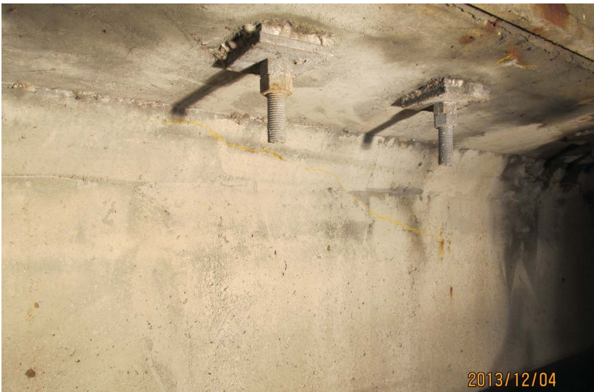
S5.PC.13W-14W.P1.b – 6570 (câble #23 - extrémité est face amont)
