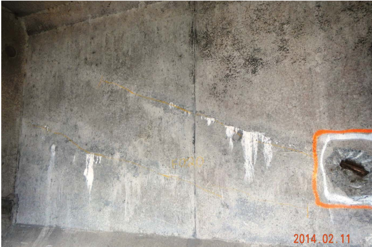
S5.PC.43W-44W.P4.a – 7592 (câbles #23 et #24 – centre est face aval)
