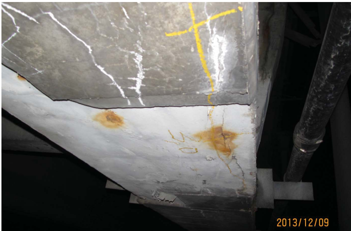
S5.PC.20W-21W.P1.b – 6694 (soffite - extrémité est)
