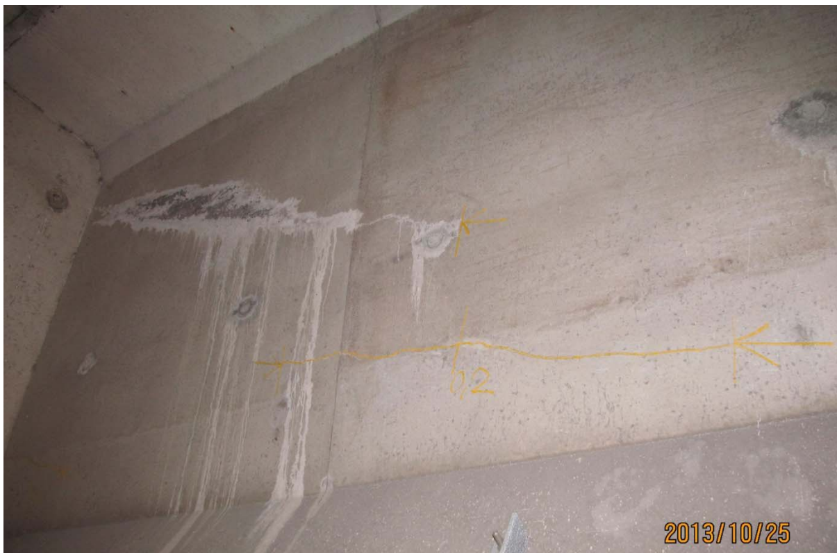
S5.PC.36W-37W.P7.c – 5932 (câbles #24 et #23 - centre est face aval)
