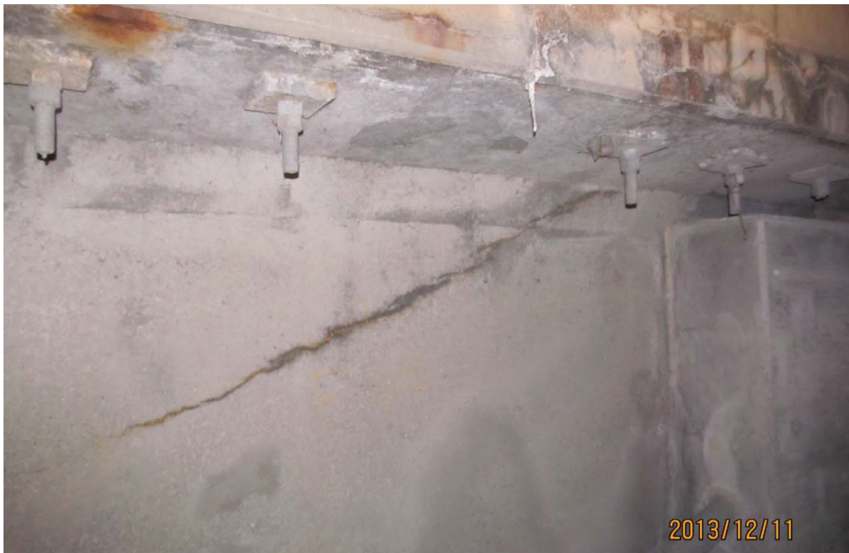
S5.PC.33W-34W.P1.f – 6748 (câble #17 - extrémité ouest face aval)
