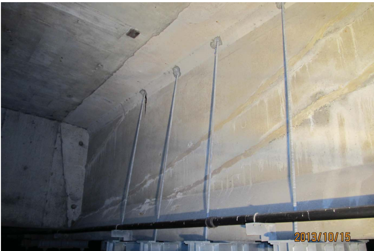
S5.PC.37W-38W.P1.k – 5772 (câbles #19 et #20 - extrémité est face amont)
