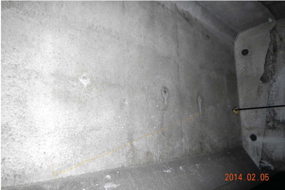
S5.PC.32W-33W.P4.c – 7516 (câble #23 – centre est face amont)
