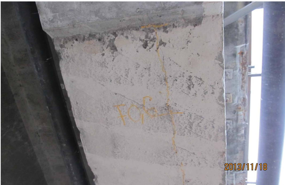
S5.PC.43W-44W.P1.b – 6325 (soffite - extrémité est)
