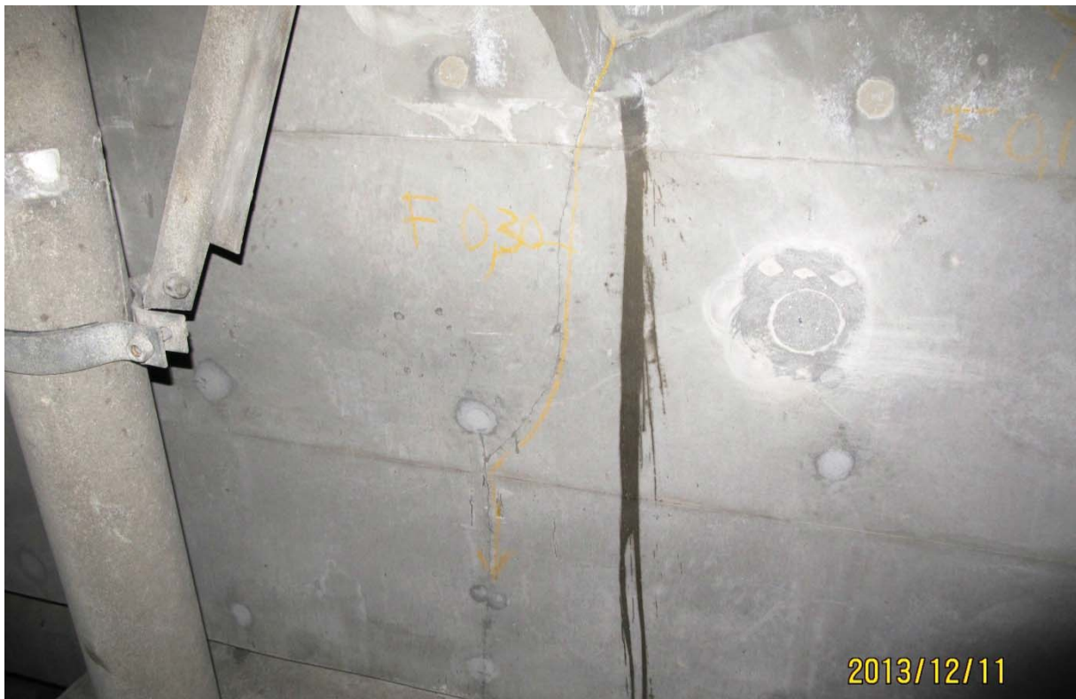
S5.PC.32W-33W.P1.b – 6734 (bloc d'ancrage QP 1.0 extérieur ouest)
