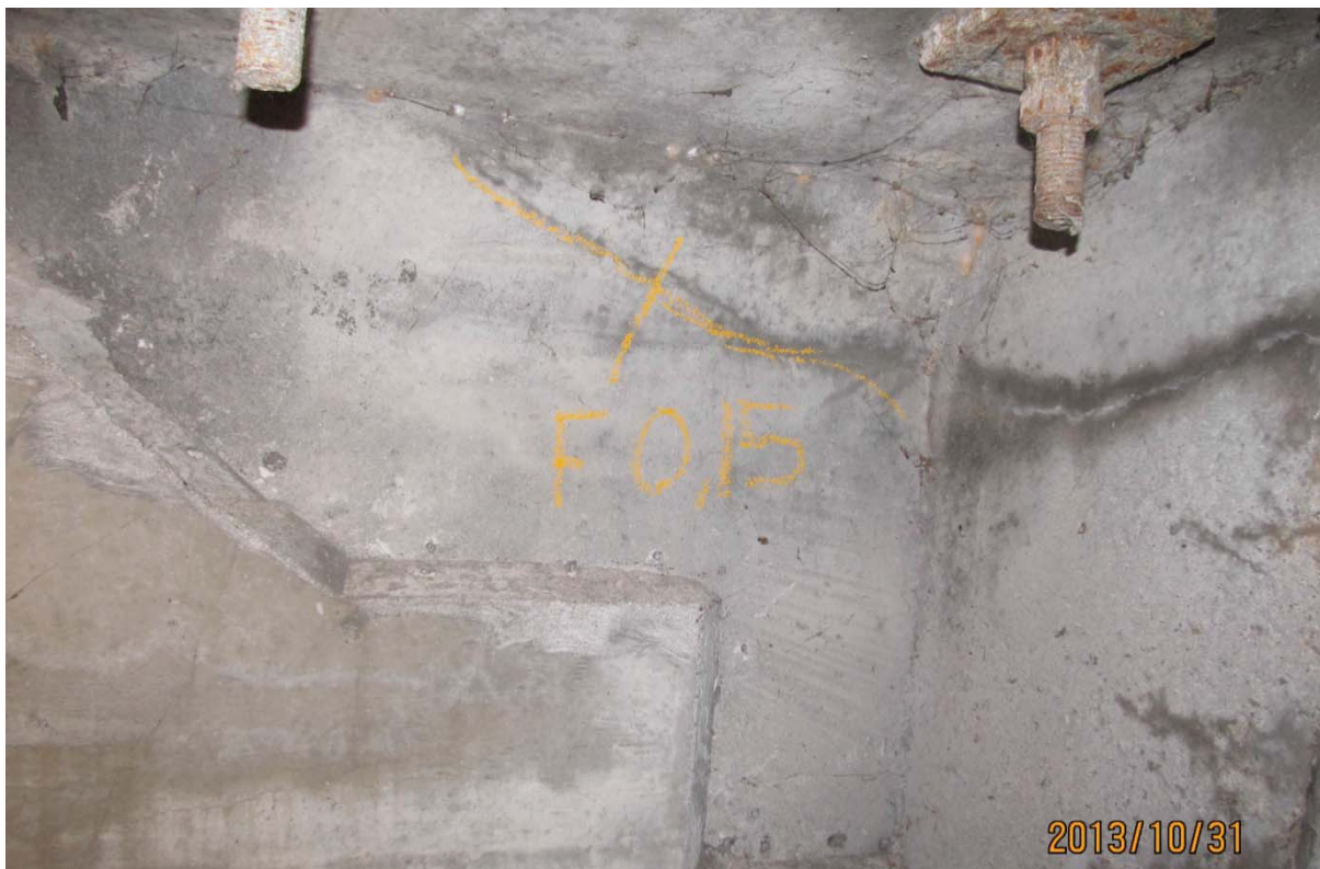
S5.PC.35W-36W.P1.c – 6064 (câble #24 - extrémité est face aval)
