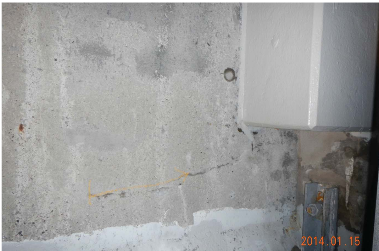
S5.PC. 12W-13W.P7.b – 7365 (câble #22 - centre est face amont)
