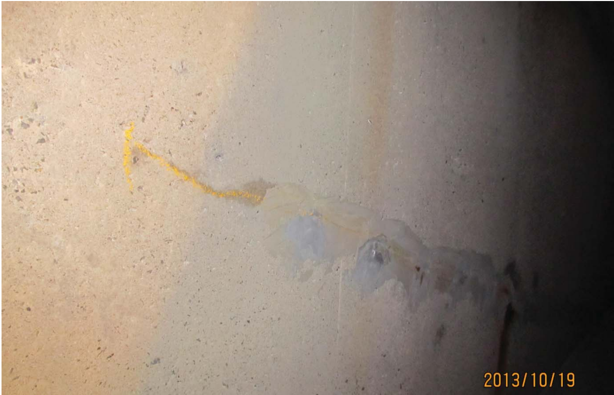
S5.PC.30W-31W.P7.a – 5854 (câble #17 - extrémité ouest face amont)
