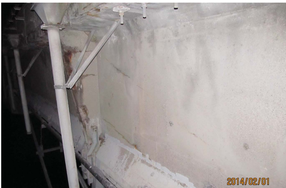
S5.PC.33W-34W.P7.d – 0208 (câbles #22 et #24 – centre ouest face amont)
