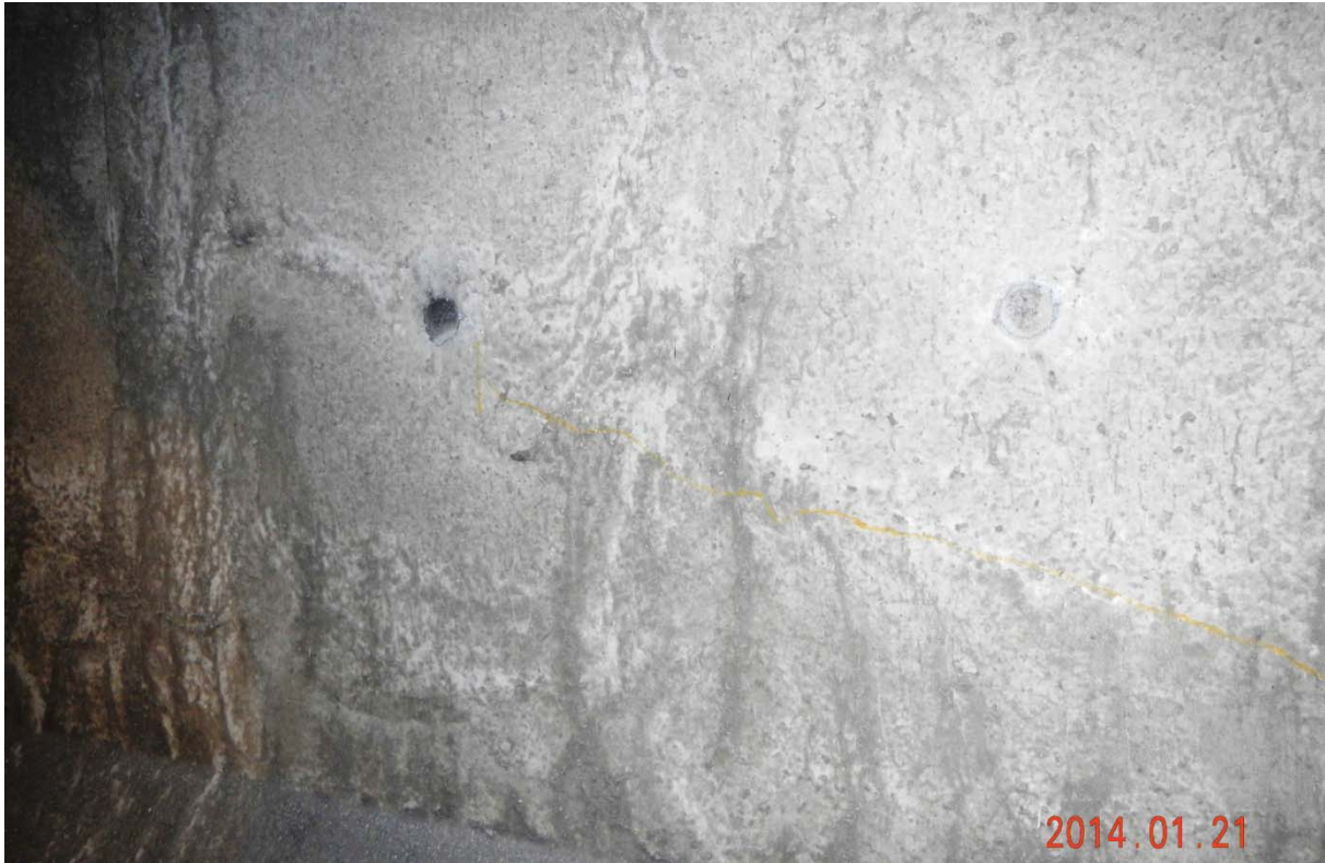
S5.PC.28W-29W.P4.a – 7450 (câble #20 – extrémité ouest face amont)
