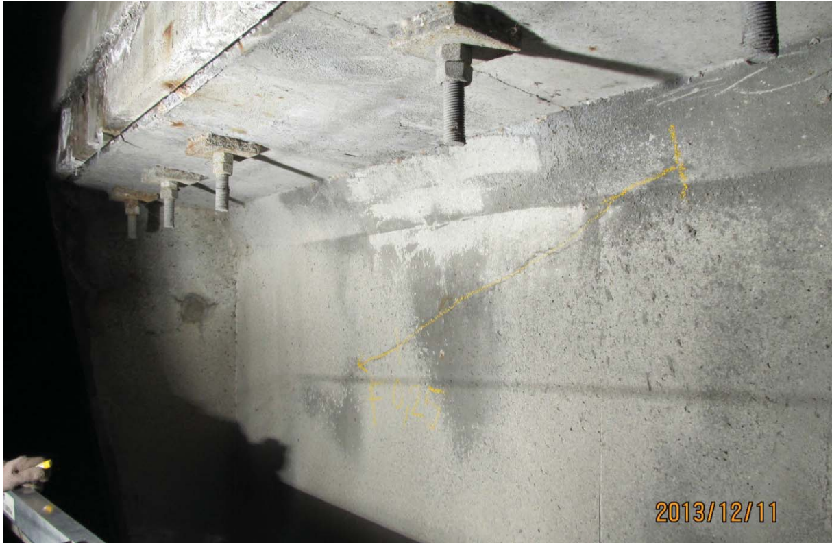
S5.PC.33W-34W.P1.e – 6747 (câble #23 - extrémité ouest face aval)
