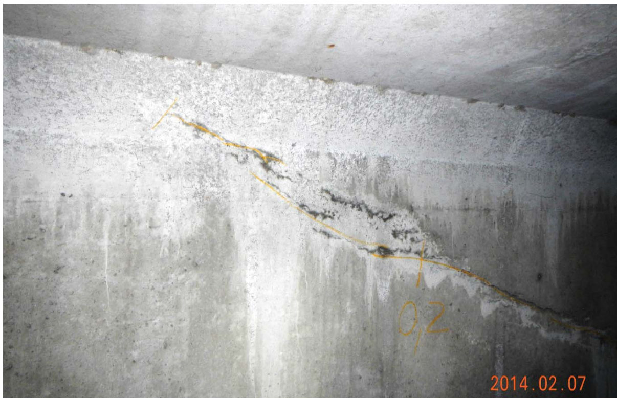
S5.PC.33W-34W.P4.c – 7532 (câble #19 – centre est face aval)
