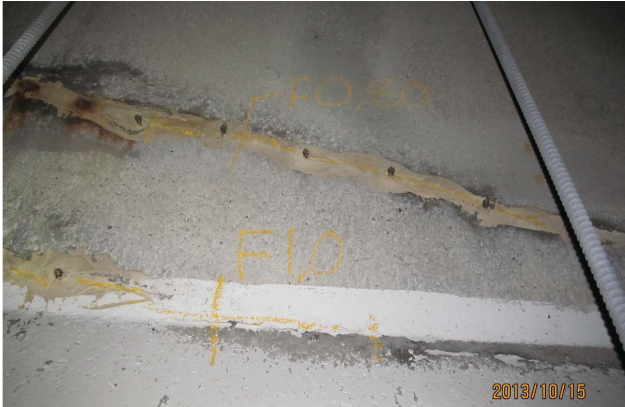
S5.PC.37W-38W.P1.a – 5773 (câbles #19 et #20 - extrémité est face aval)
