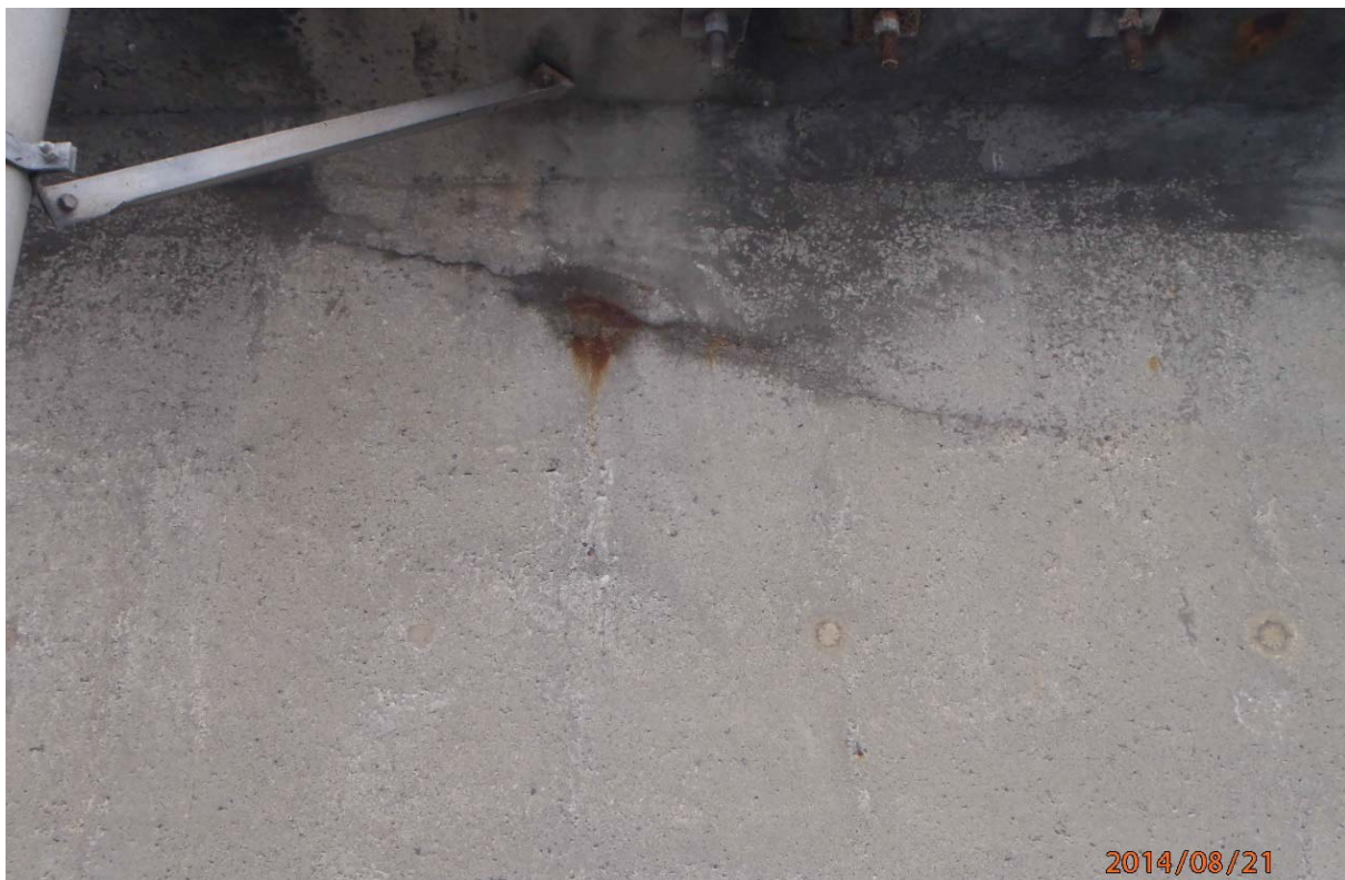
S5.PC.34W-35W.P7.h – PH.20140821_P7_34W-35W_025 (câble #20 - extrémité ouest face amont)
