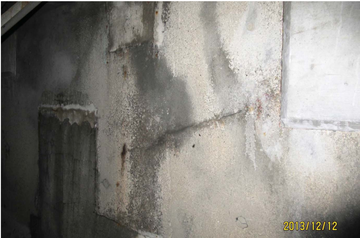
S5.PC.21W-22W.P7.h – 6779 (câble #17 – extrémité est face amont)
