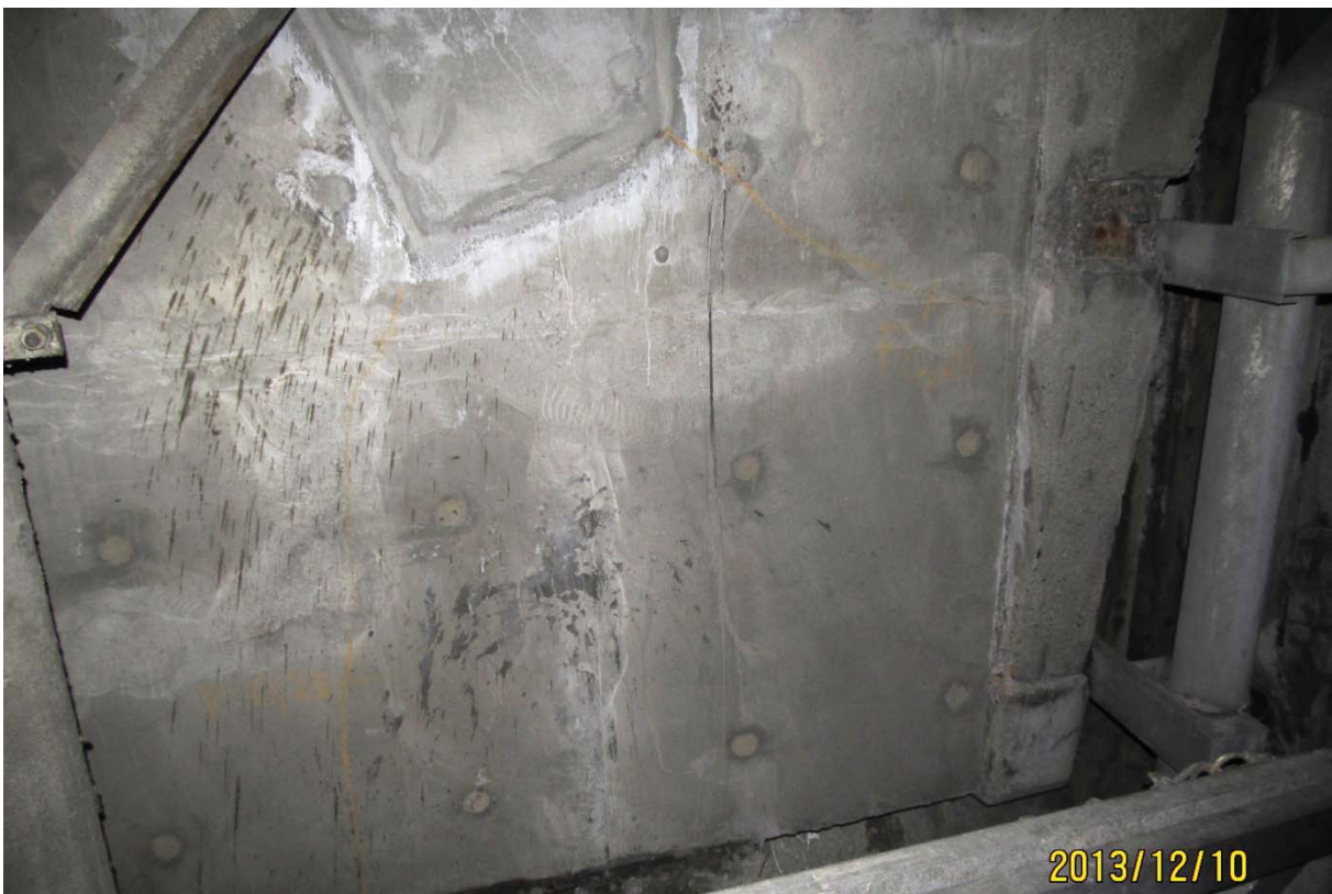
S5.PC.6W-7W.P1.b – 6720 (bloc d'ancrage QP 1.0 extérieur ouest)
