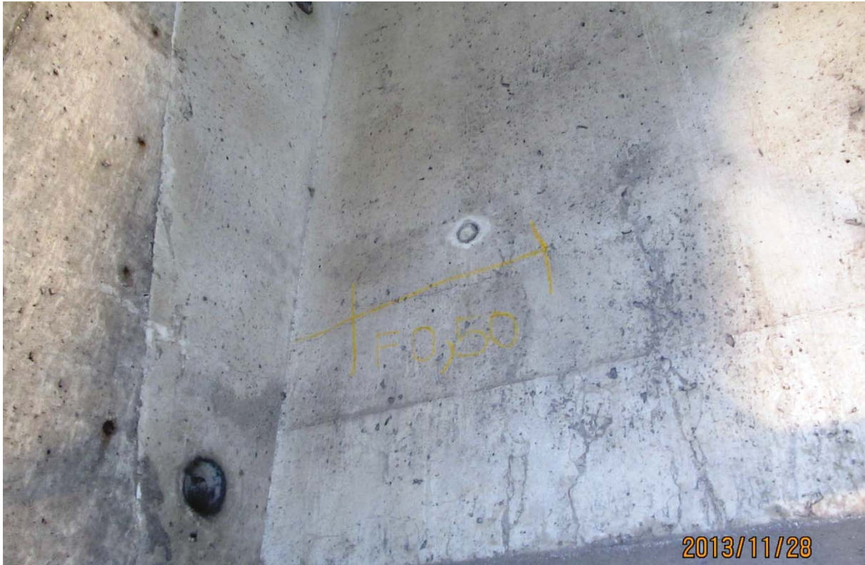
S5.PC.14W-15W.P7.l – 6475 (câble #22 – extrémité ouest face aval)
