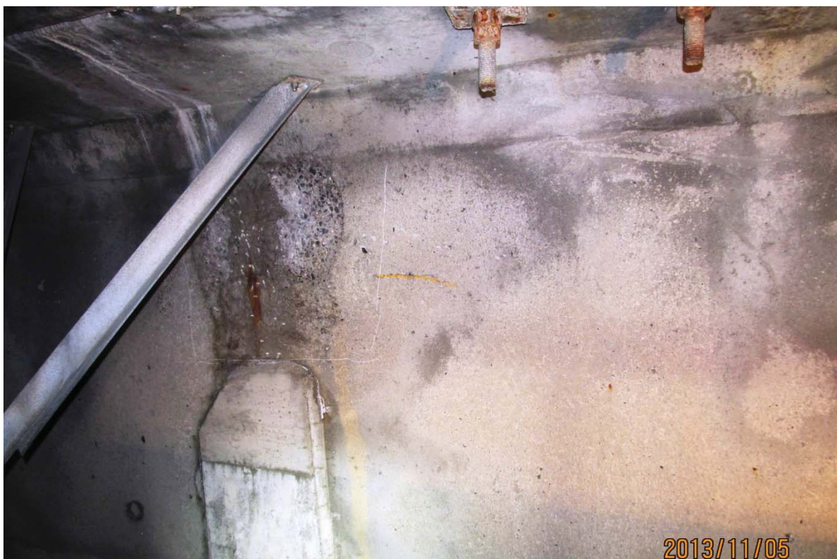
S5.PC.17W-18W.P7.d – 6121 (câble #19 – extrémité ouest face amont)
