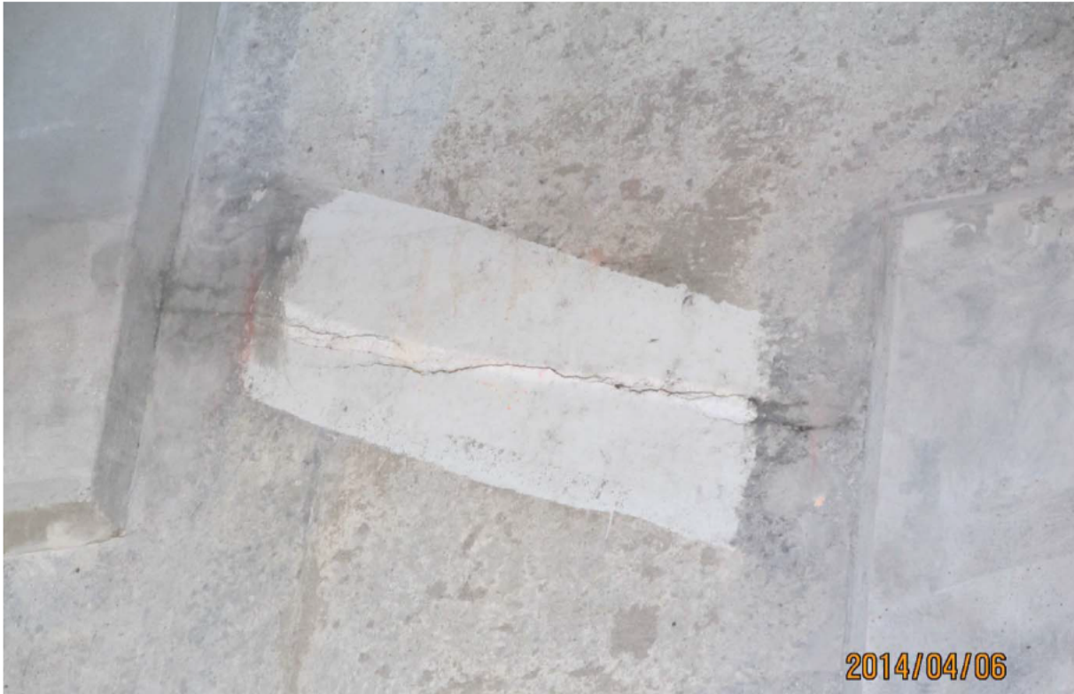
S5.PC.42W-43W.P1.a – 0412 (câble #24 – centre est face aval)
