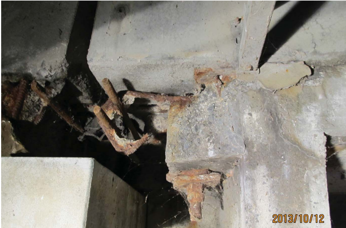
S5.PC.41W-42W.P1.a – 5747 (semelle supérieure - extrémité est face aval)
