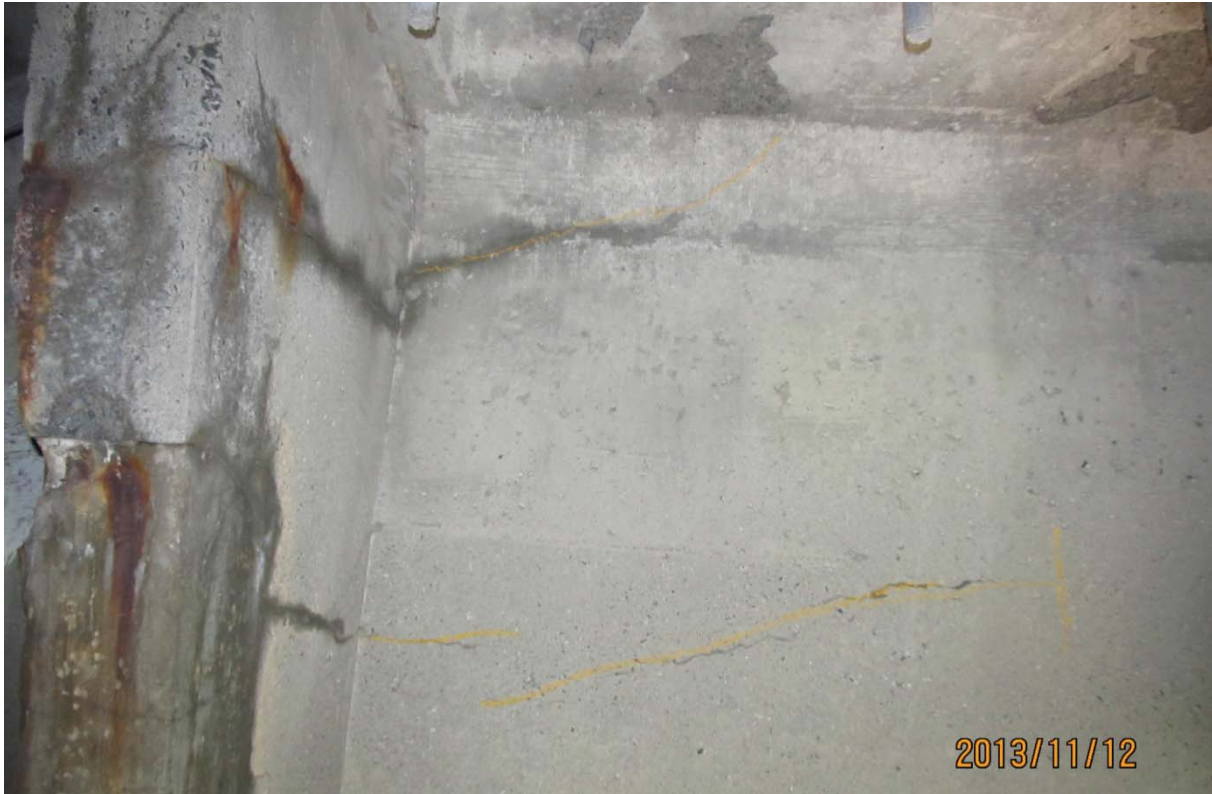
S5.PC.28W-29W.P7.e – 6263 (câbles #24 et #23 – extrémité est face amont)
