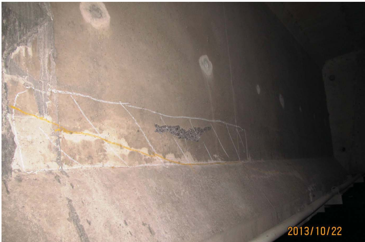
S7.PC.4E-5E.P1.d – 5895 (câble #18 - extrémité ouest face amont)
