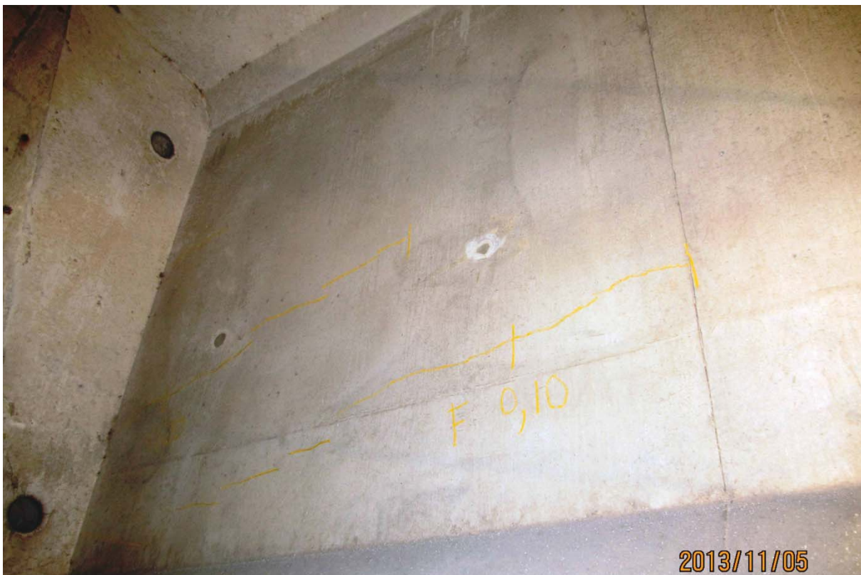
S5.PC.16W-17W.P7.m – 6099 (câbles #22 et #21 – extrémité ouest face aval)
