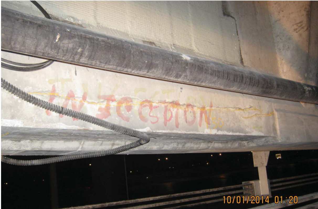
S7.PC.11E-12E.P1.c – 0259 (semelle inférieure – centre est face amont)
