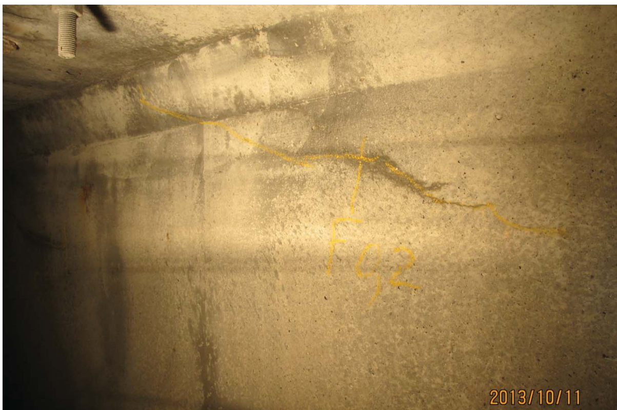
S5.PC.38W-39W.P1.b – 5735 (câble #20 - extrémité est face aval)
