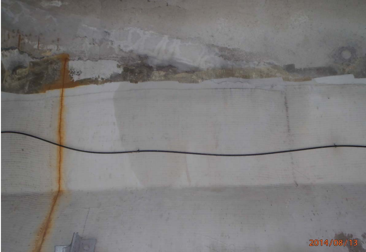
S5.PC.31W-32W.P7.m – PH.20140813_P7_31W-32W_044 (câble #24 - extrémité centre face aval)
