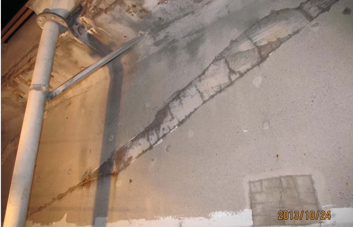
S5.PC.37W-38W.P7.c – 5914 (câble #20 - extrémité est face amont)
