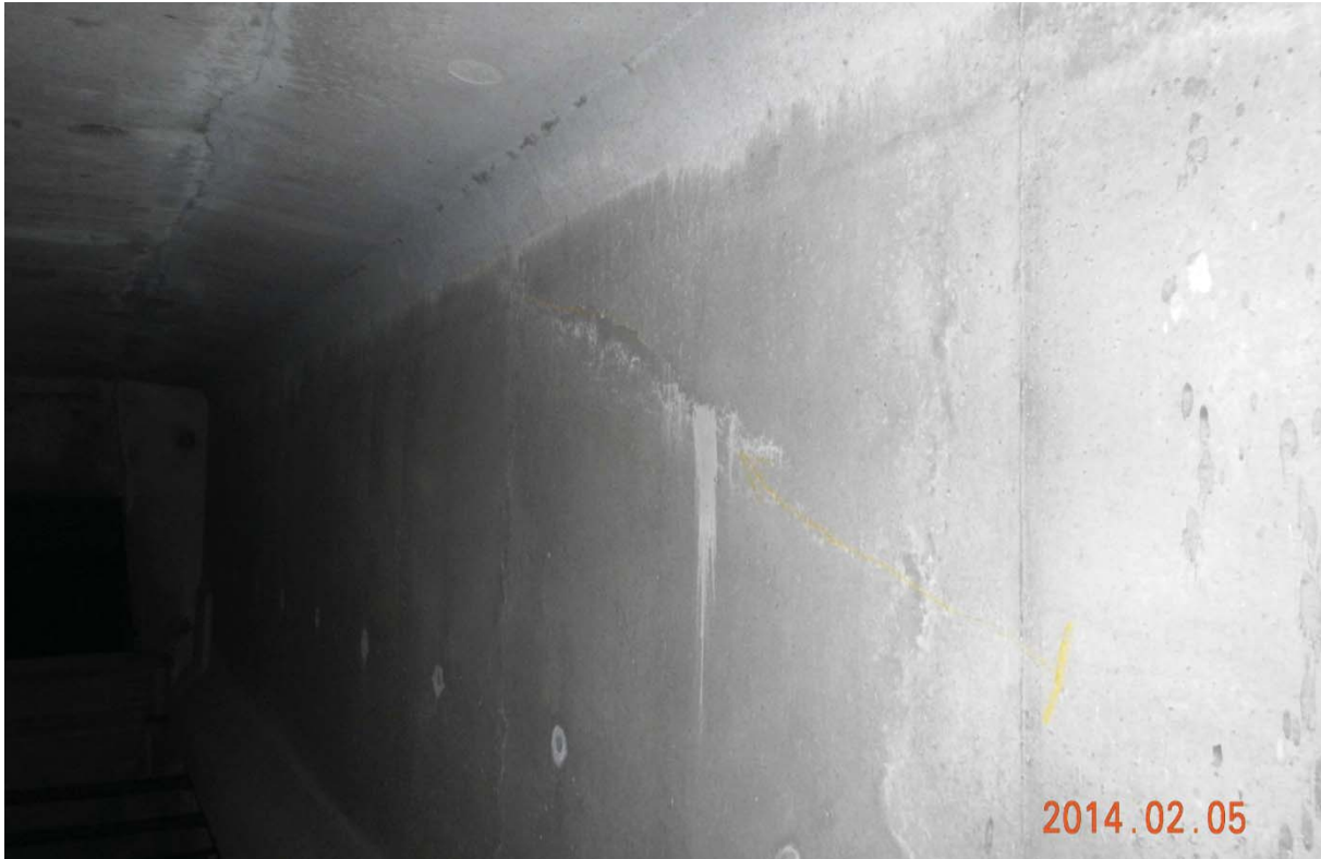
S5.PC.32W-33W.P4.e – 7514 (câble #19 – extrémité est face aval)
