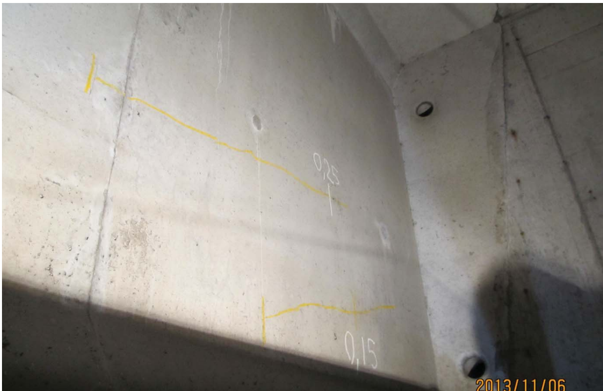
S5.PC.17W-18W.P7.m – 6137 (câbles #23 et #22 – centre ouest face aval)
