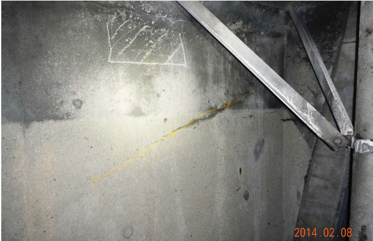
S5.PC.5W-6W.P7.c – 7559 (câble #24 – centre est face amont)
