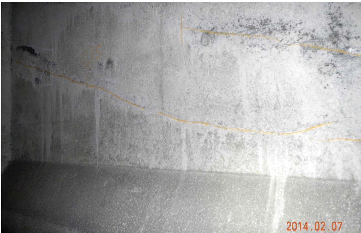
S5.PC.33W-34W.P4.e – 7551 (câbles #23 et #24 – centre est face aval)
