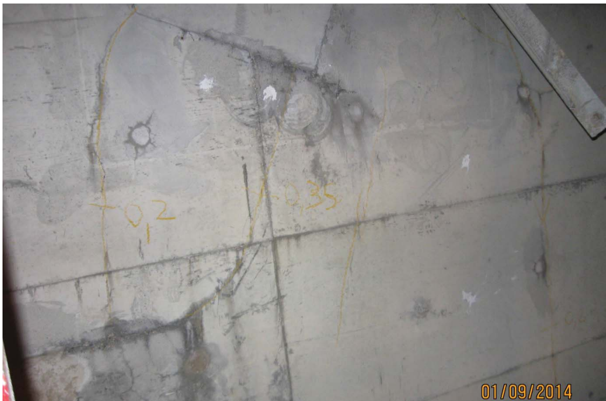
S5.PC.23W-24W.P7.a – 0466 (bloc d'ancrage QP 1.0 extérieur ouest)
