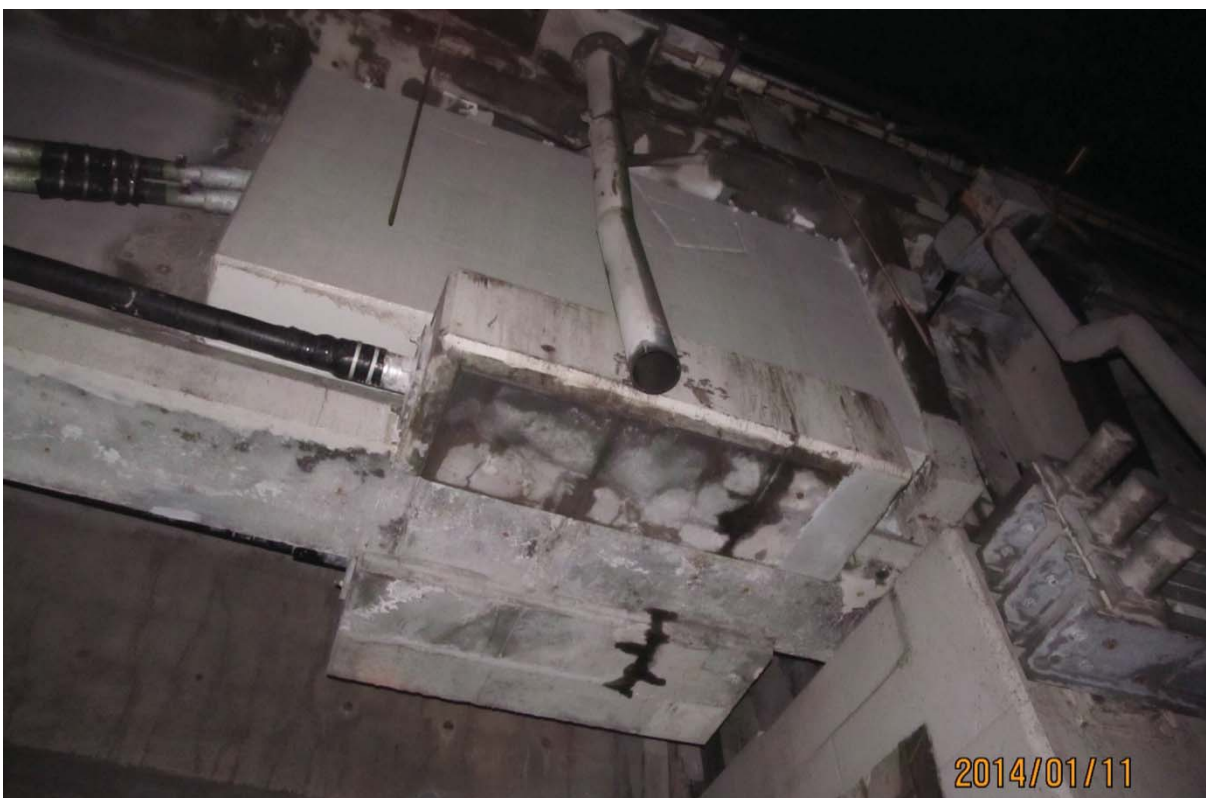
S5.PC.27W-28W.P1.b – 0138 (blocs d'ancrage extérieur et intérieur ouest PTE)
