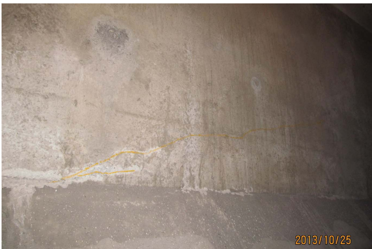
S5.PC.30W-31W.P7.f – 5934 (câble #19 - extrémité ouest face aval)
