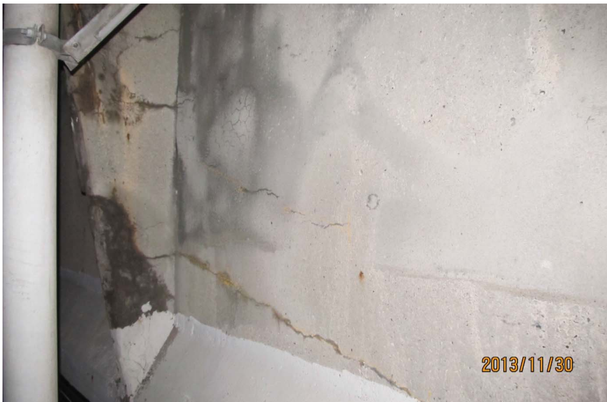
S5.PC.9W-10W.P7.c – 6508 (câbles #22 et #23 – centre ouest face amont)
