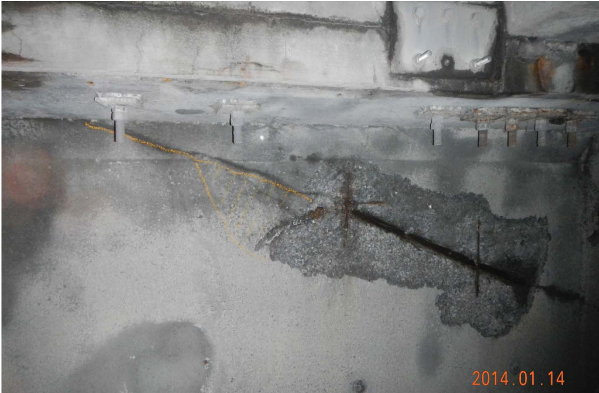
S5.PC.29W-30W.P1.c – 7323 (câble #23 - extrémité est face aval)
