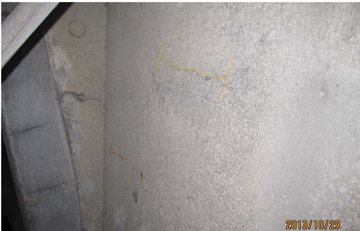
S5.PC.36W-37W.P1.a – 5954 (câbles #23 et #24 - extrémité est face aval)
