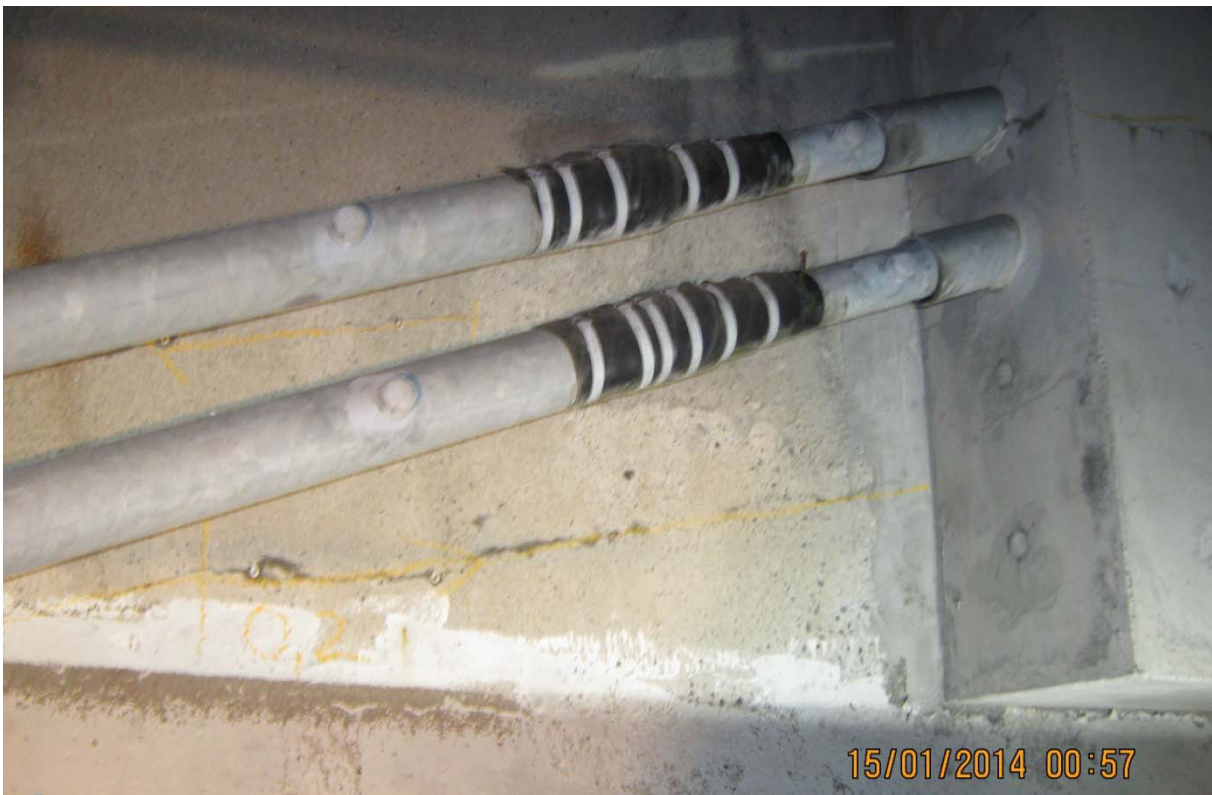
S5.PC.23W-24W.P7.d – 0285 (câble #9 – extrémité est face amont)
