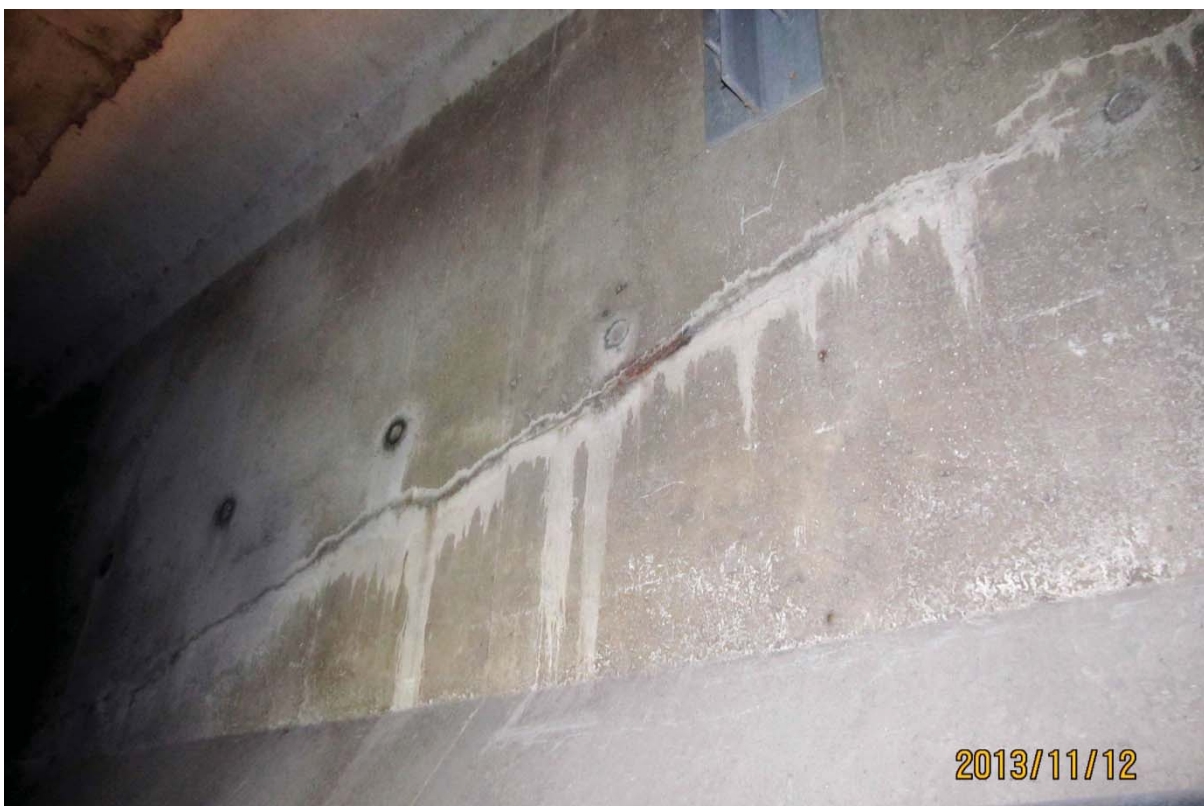
S5.PC.28W-29W.P7.k – 6242 (câble #13 – extrémité ouest face aval)
