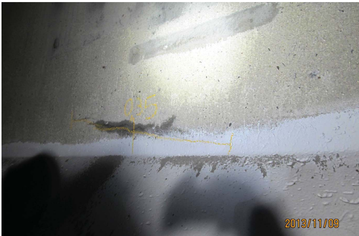
S5.PC.4W-5W.P1.a – 6191 (câble #15 - extrémité est face aval)
