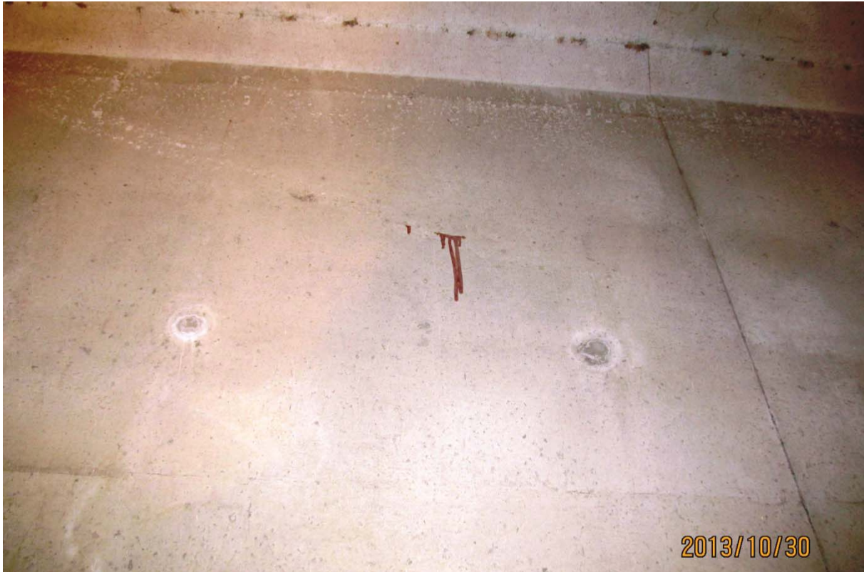
S5.PC.25W-26W.P7.c – 5976 (câble #20 – extrémité est face aval)
