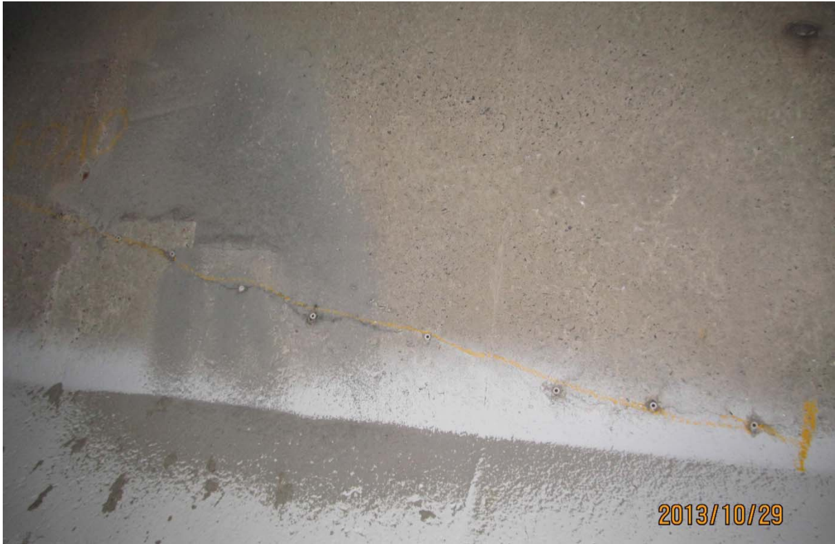
S5.PC.25W-26W.P7.a – 5965 (câble #20 – extrémité ouest face amont)
