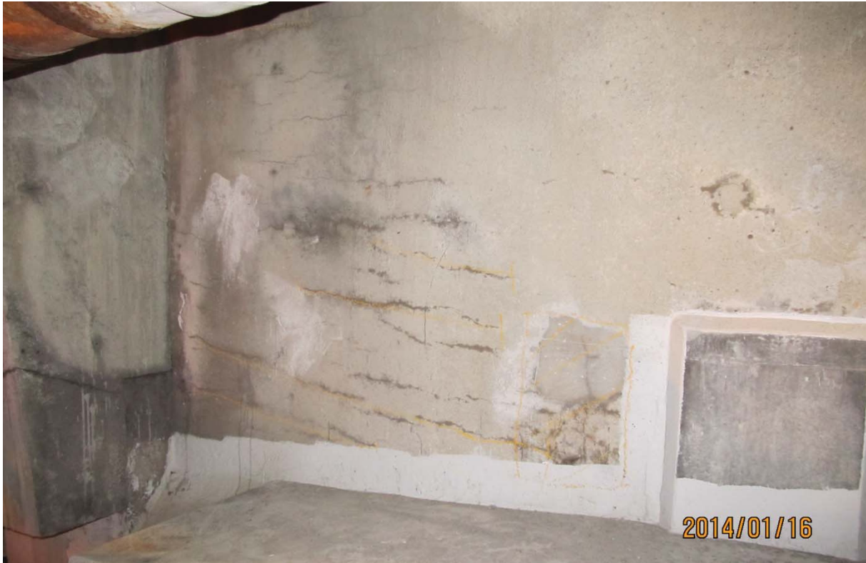
S7.PC.10E-11E.P1.a – 0158 (âme - extrémité est face aval)
