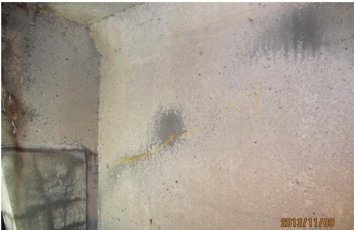
S5.PC.5W-6W.P1.c – 6215 (câble #23 - extrémité ouest face aval)
