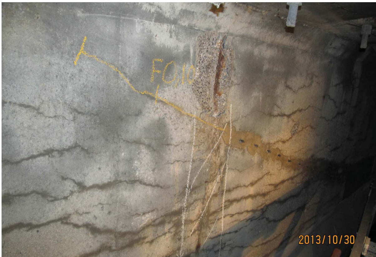
S5.PC.30W-31W.P1.a – 6043 (câble #16 - extrémité est face aval)
