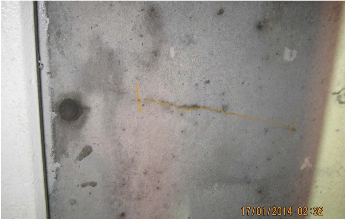
S5.PC.12W-13W.P1.a – 0296 (câble# 23 - centre est face aval)
