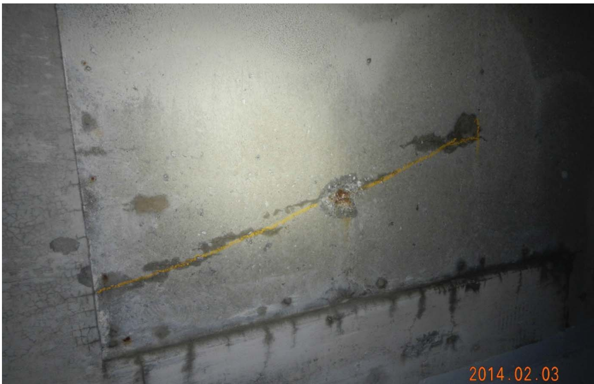
S7.PC.12E-13E.P7.f – 0800 (câbles #20 – extrémité est face amont)
