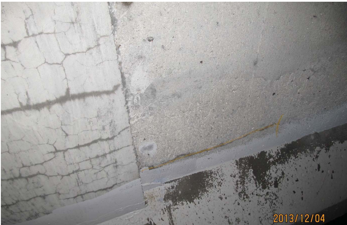
S5.PC.13W-14W.P1.d – 6576 (câble #8 - extrémité est face amont)
