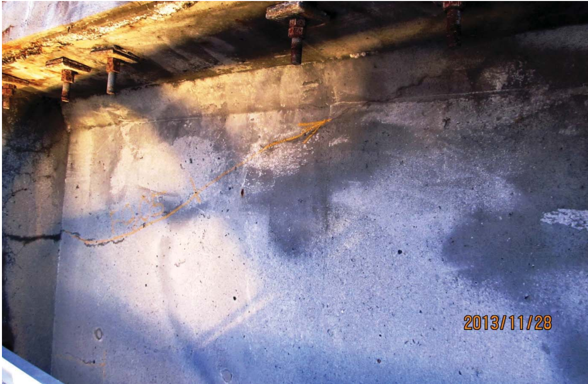
S5.PC.14W-15W.P7.g – 6483 (câbles #22 et #23 – extrémité est face amont)
