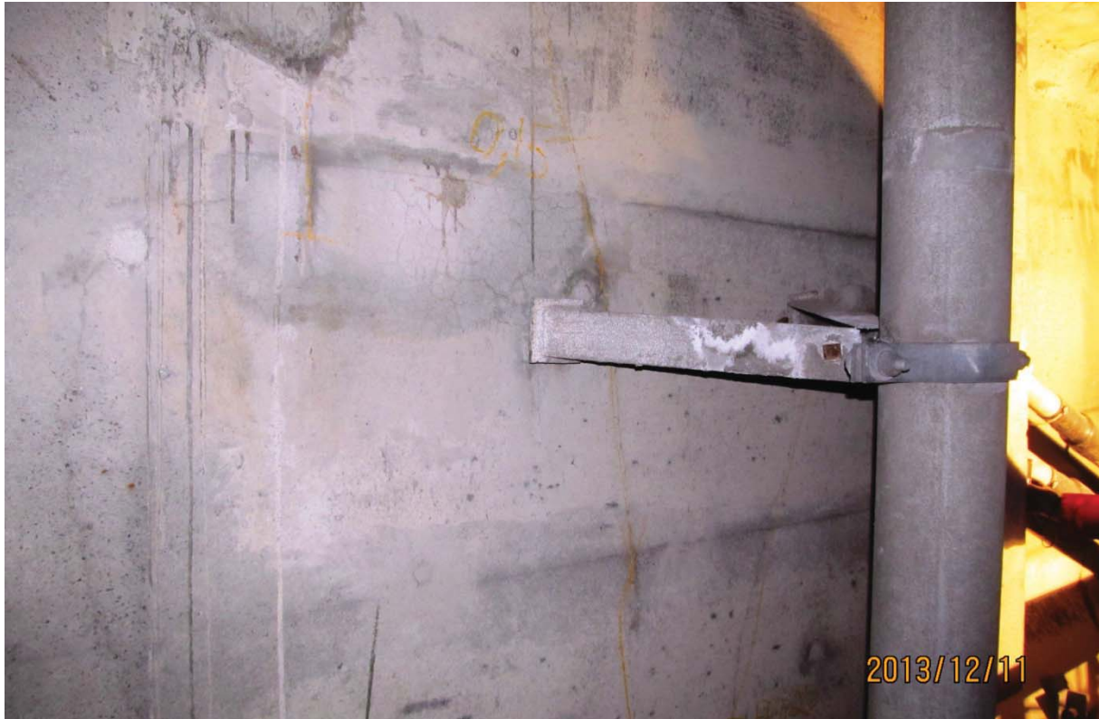
S5.PC.34W-35W.P1.a – 6754 (bloc d'ancrage QP 1.0 extérieur est)
