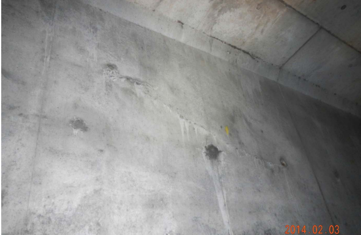
S7.PC.12E-13E.P7.j – 0810 (câble #19 – extrémité est face aval)
