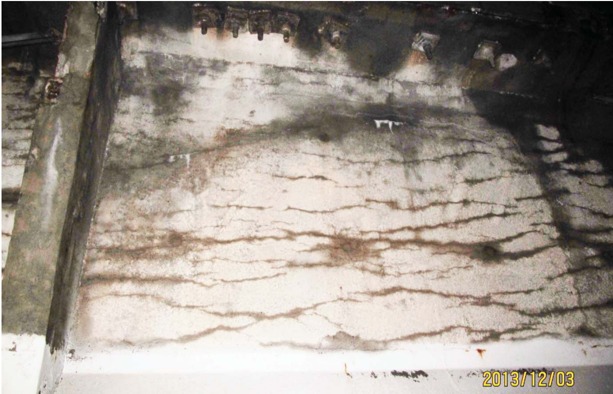
S5.PC.30W-31W.P1.c – 6555 (câble #23 - extrémité ouest face aval)
