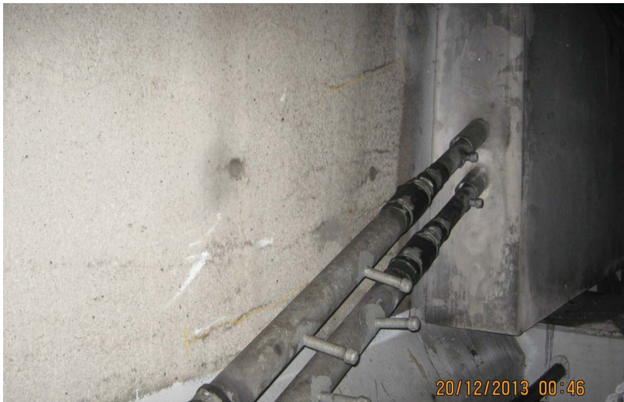
S7.PC.6E-7E.P1.b – 0253 (câbles #15 et #11 - extrémité ouest face aval)
