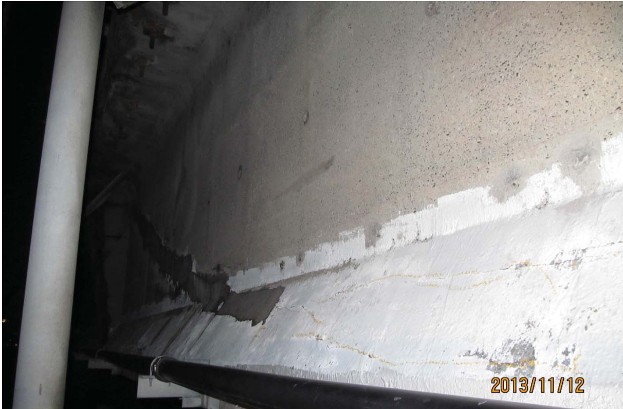
S5.PC.28W-29W.P7.c – 6245 (câble #24 – centre ouest face amont)
