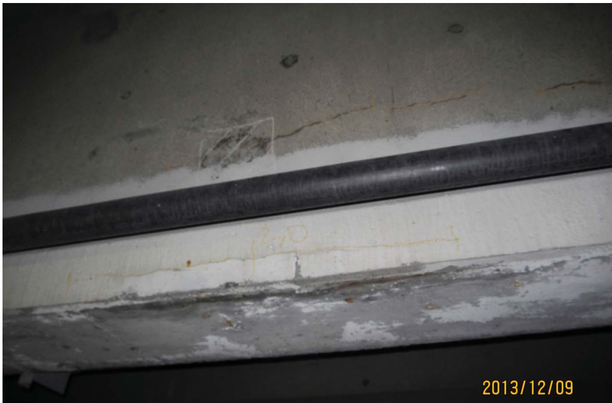
S5.PC.16W-17W.P1.f – 6692 (semelle inférieure – extrémité ouest face aval)
