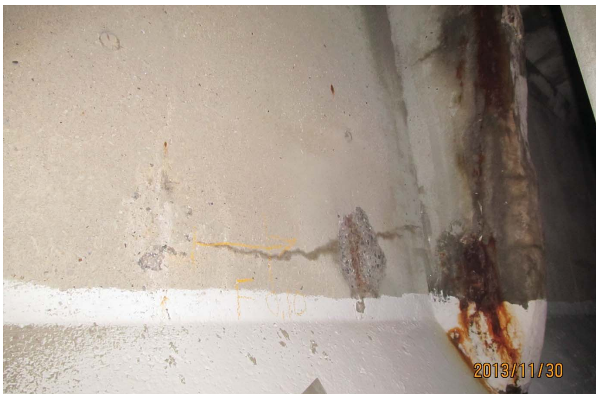
S5.PC.9W-10W.P7.d – 6510 (câble #22 – centre est face amont)
