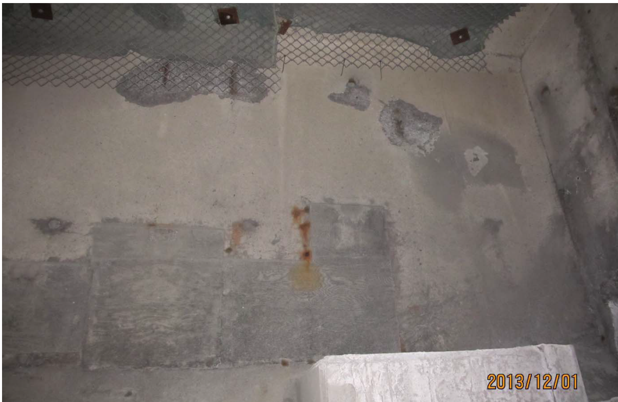
S7.PC.4E-5E.P7.f – 6540 (âme – extrémité ouest face aval)
