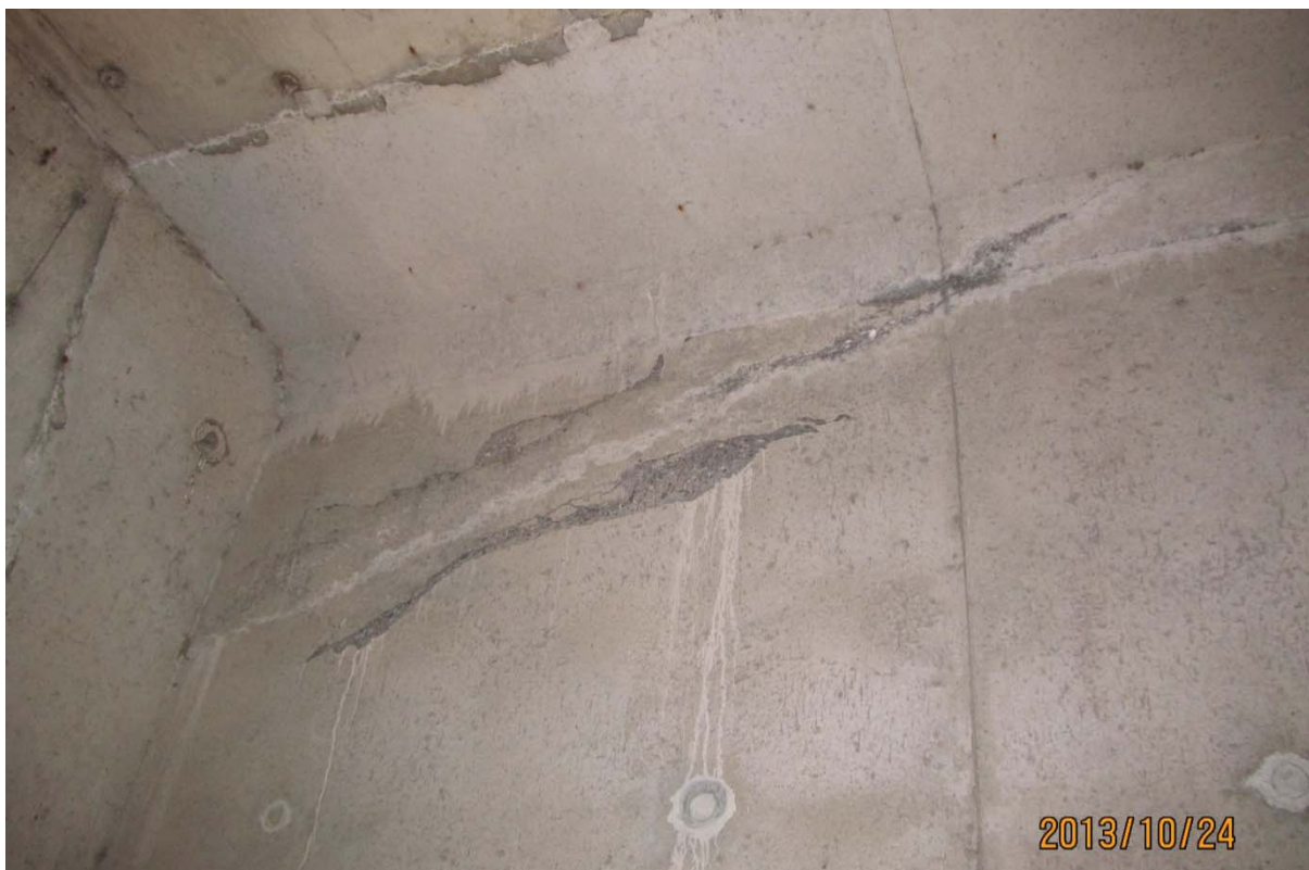
S5.PC.36W-37W.P7.d – 5919 (câble #23 – extrémité ouest face aval)
