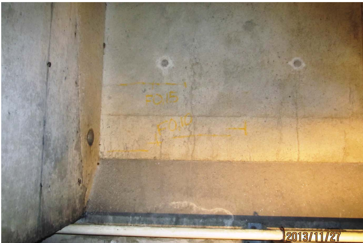
S5.PC.19W-20W.P7.m – 6428 (câbles #22 et #21 – extrémité ouest face aval)
