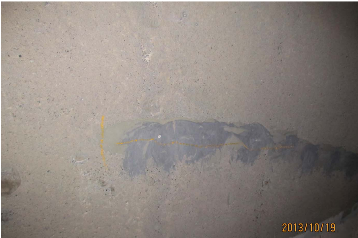
S5.PC.30W-31W.P7.b – 5855 (câble #19 - extrémité ouest face amont)
