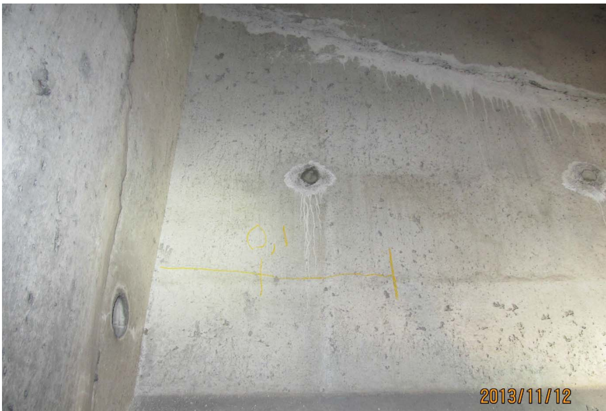
S5.PC.28W-29W.P7.g – 6251 (câbles #22 et #24 – centre est face aval)
