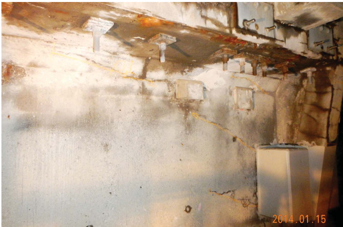
S5.PC. 12W-13W.P7.a – 7357 (câbles #22, #23 et #24 - extrémité ouest face amont)
