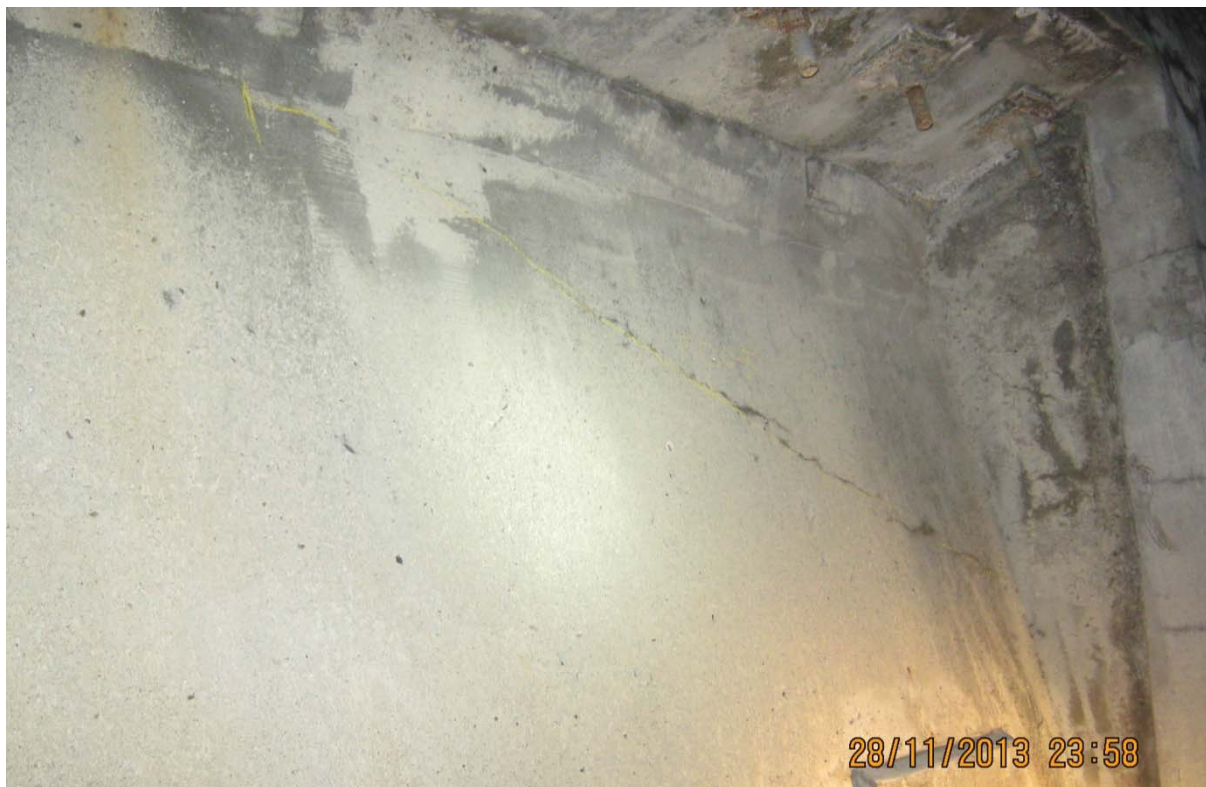
S5.PC.10W-11W.P7.a – 0104 (câble #23 – extrémité ouest face amont)
