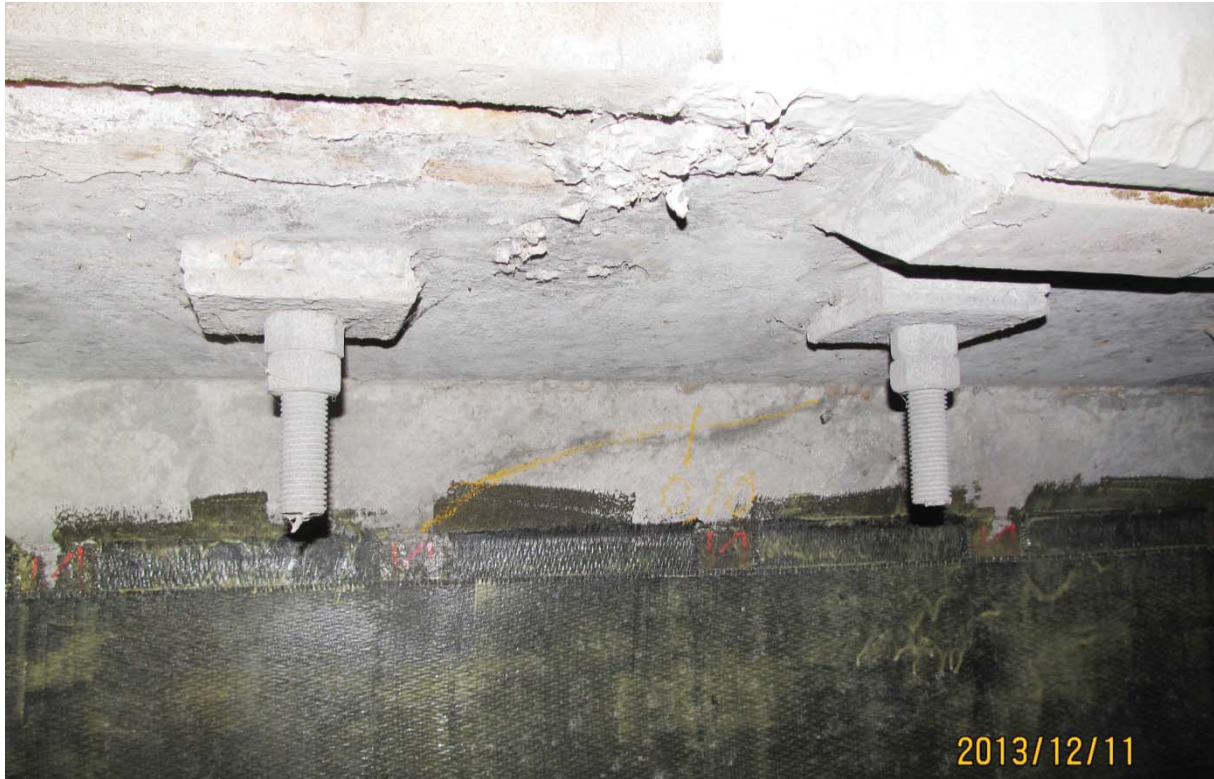
S5.PC.32W-33W.P1.e – 6731 (câble #23 – extrémité ouest face aval)
