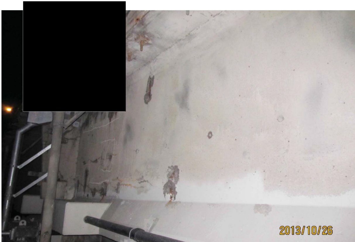
S5.PC.17W-18W.P1.a – 5938 (âme - extrémité est face aval)
