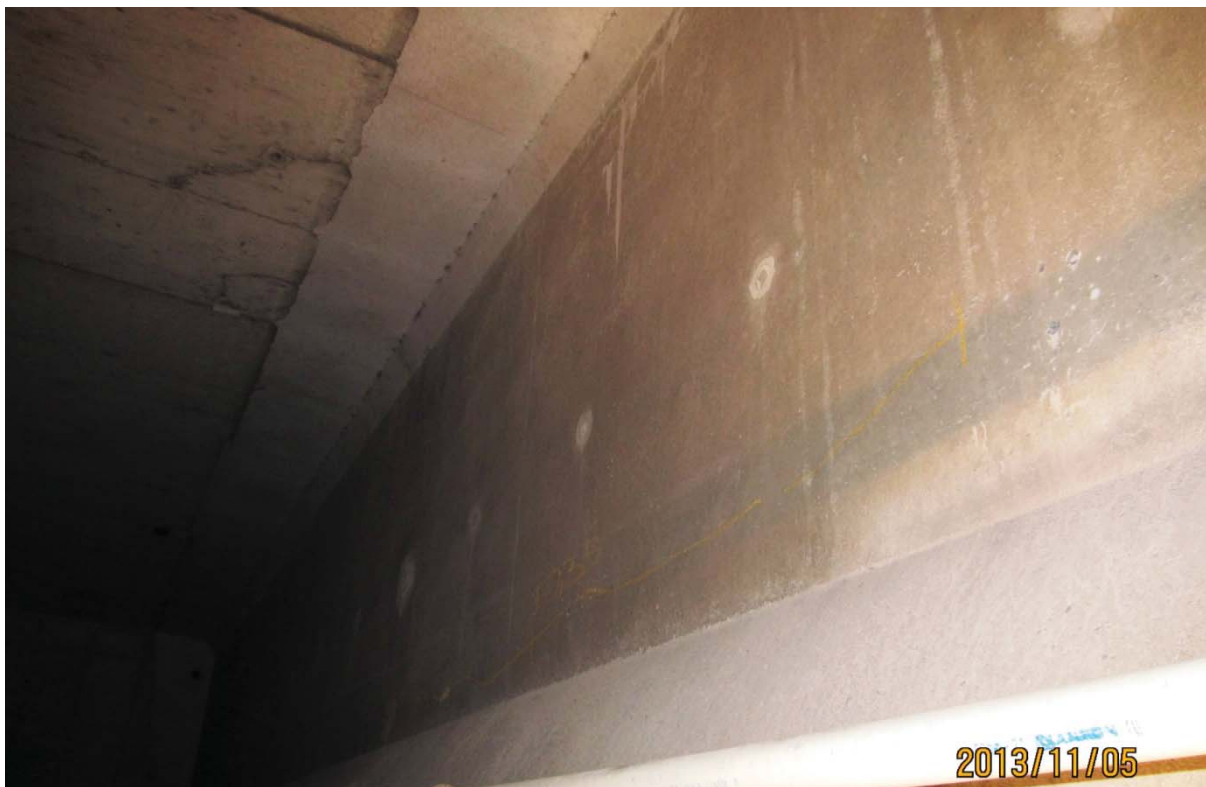
S5.PC.16W-17W.P7.n – 6100 (âme – extrémité ouest face aval)
