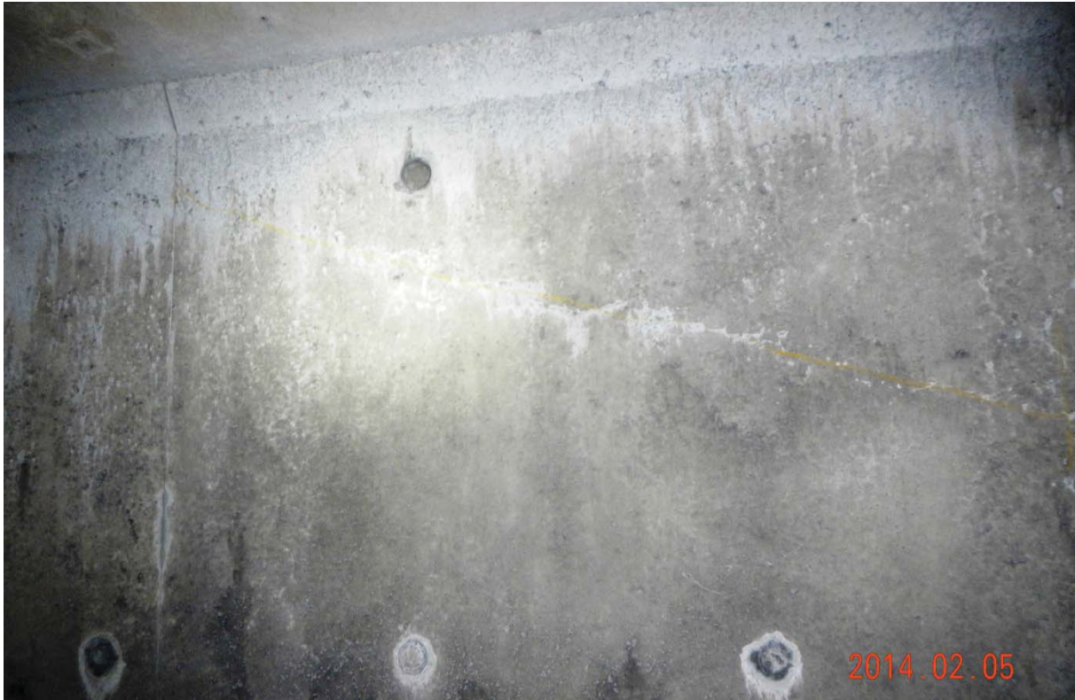
S5.PC.31W-32W.P4.a – 7508 (câble #14 – extrémité ouest face amont)
