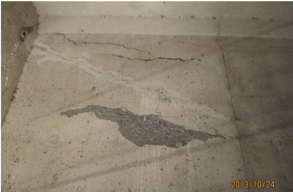
S5.PC.37W-38W.P7.d – 5911 (câble #24 - extrémité est face aval)
