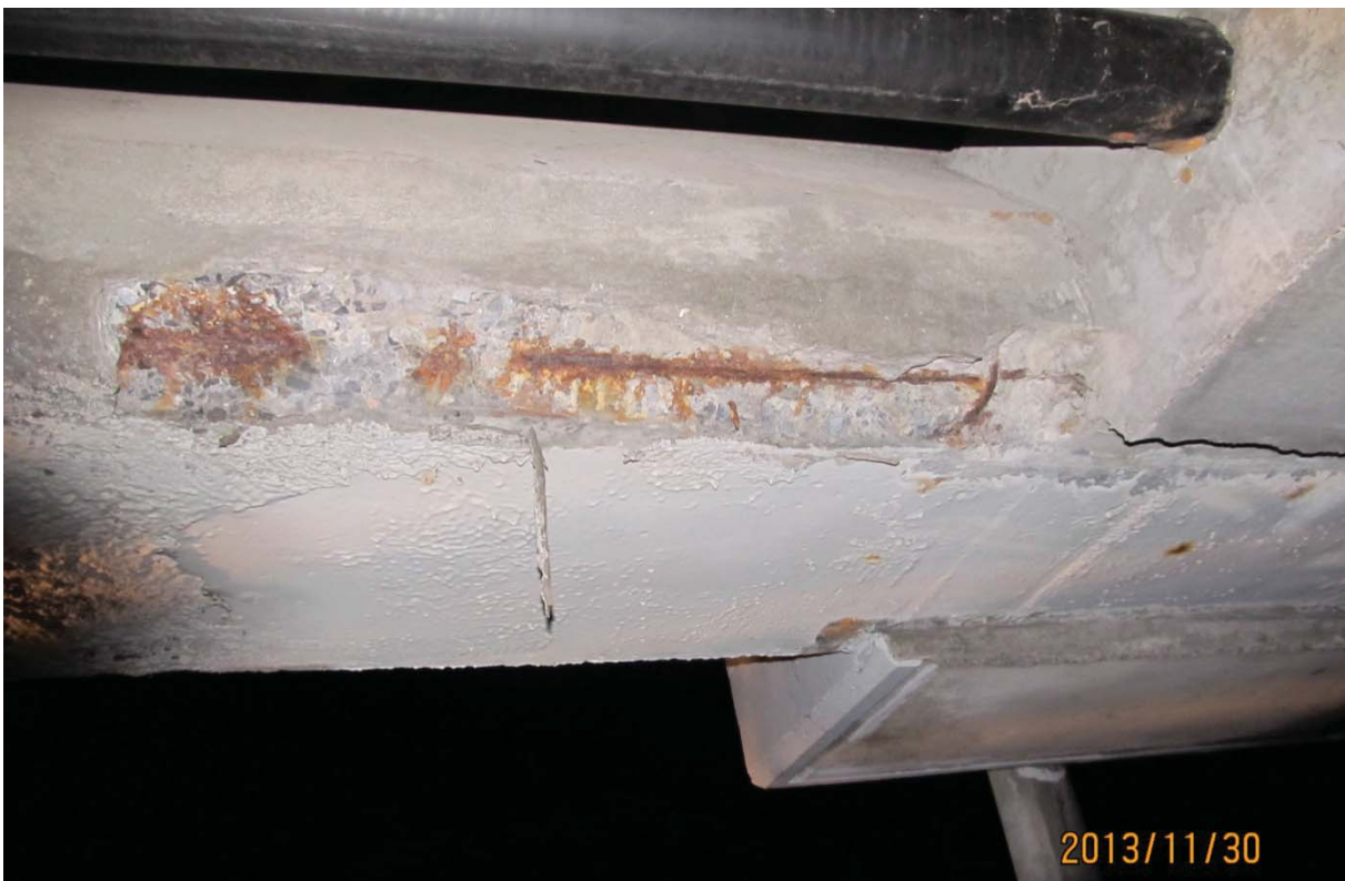
S5.PC.8W-9W.P7.h – 6517 (soffite – extrémité ouest)
