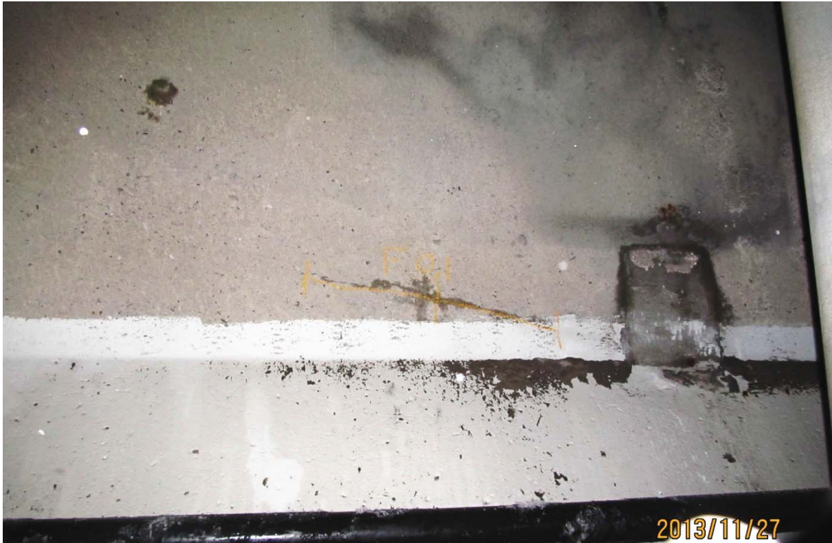
S5.PC.19W-20W.P7.a – 6426 (câble #14 – extrémité ouest face amont)
