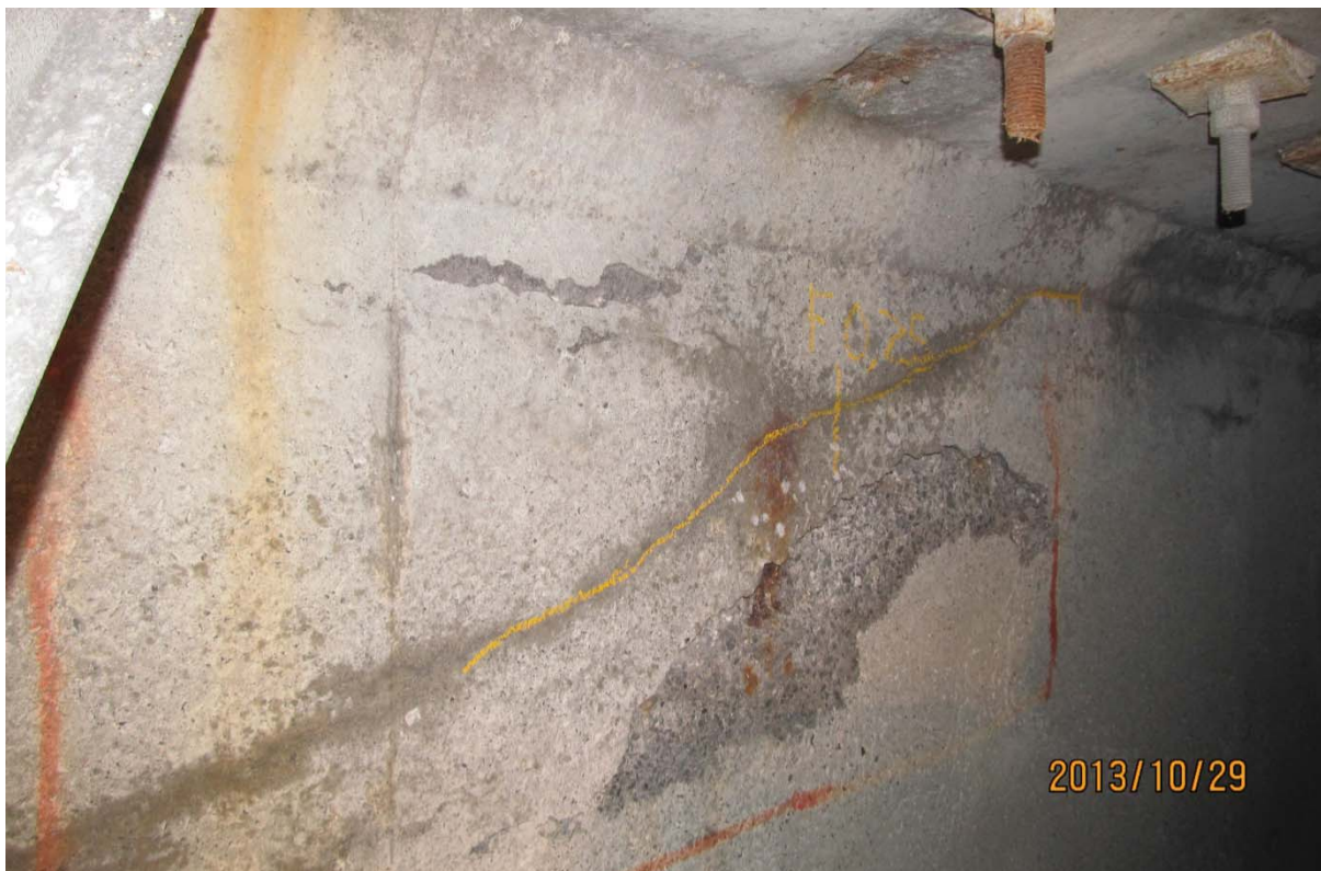
S5.PC.40W-41W.P1.e – 5948 (câble #18 – extrémité ouest face aval)
