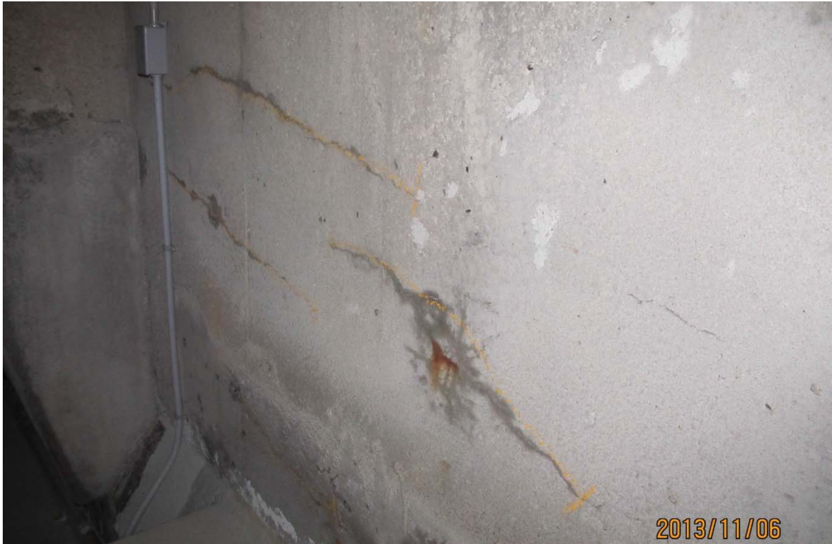
S5.PC.17W-18W.P7.a – 6127 (câble #10 – extrémité ouest face amont)
