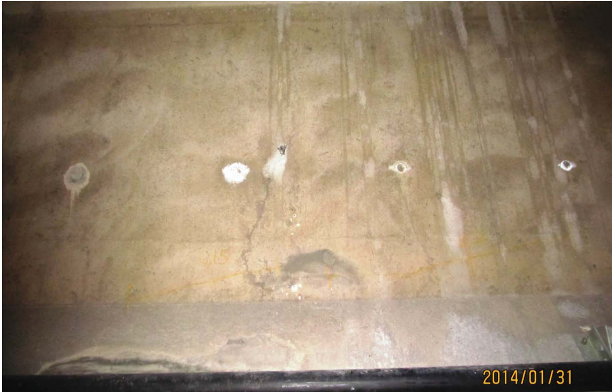
S5.PC.5W-6W.P7.e – 0205 (câbles #16 et #15 – extrémité ouest face aval)
