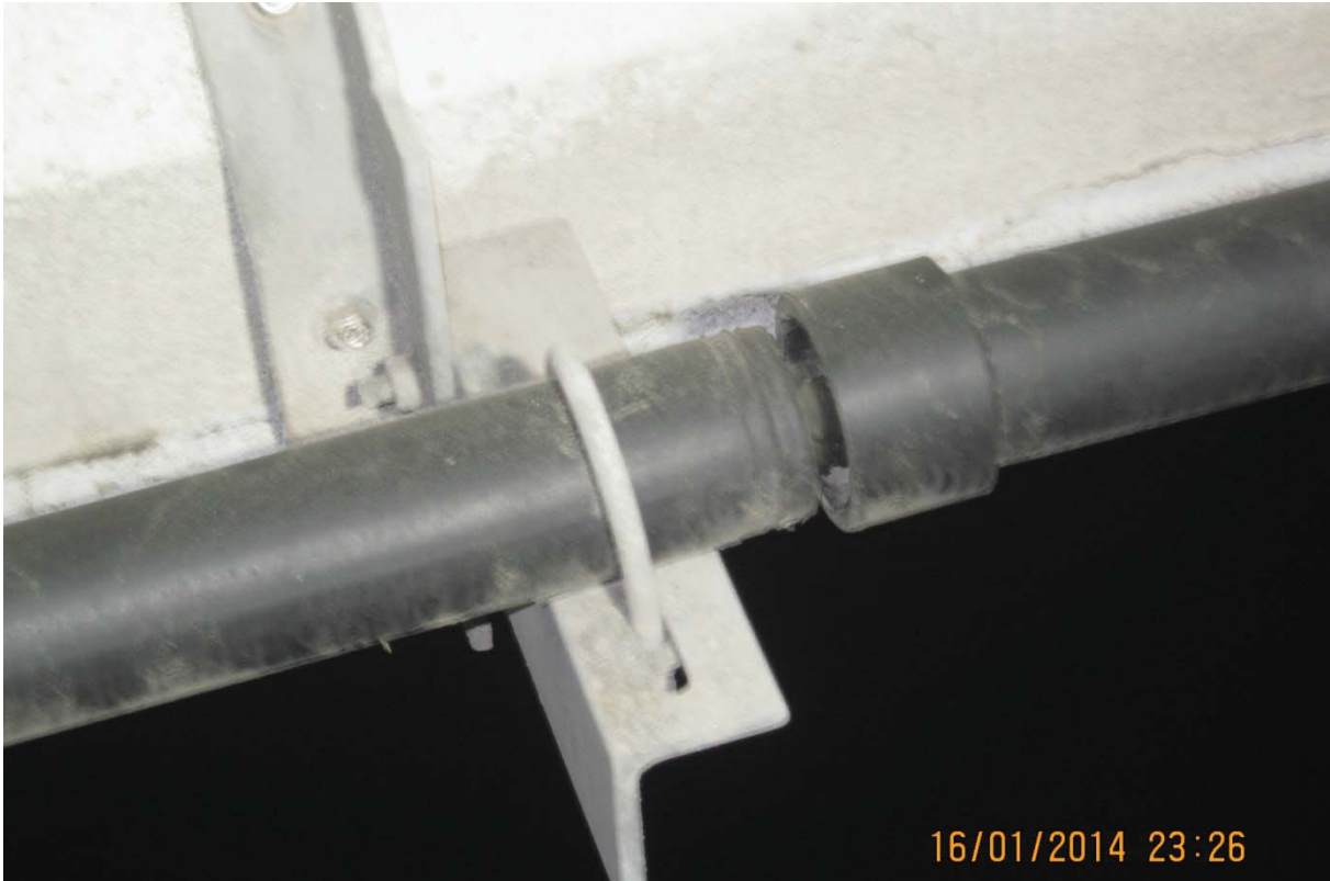
S5.PC.11W-12W.P1.c – 0289 (Gaine déconnectée – centre est face aval)
