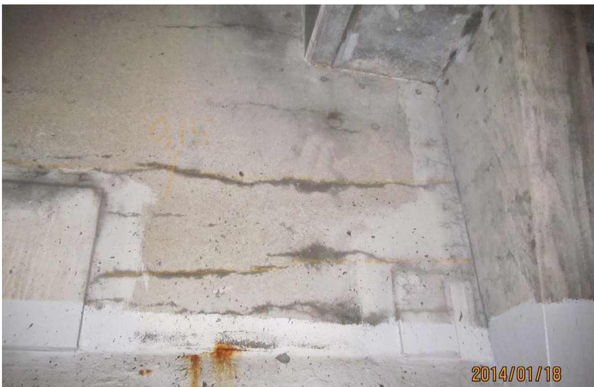
S7.PC.12E-13E.P1.b – 0180 (âme - centre est face aval)
