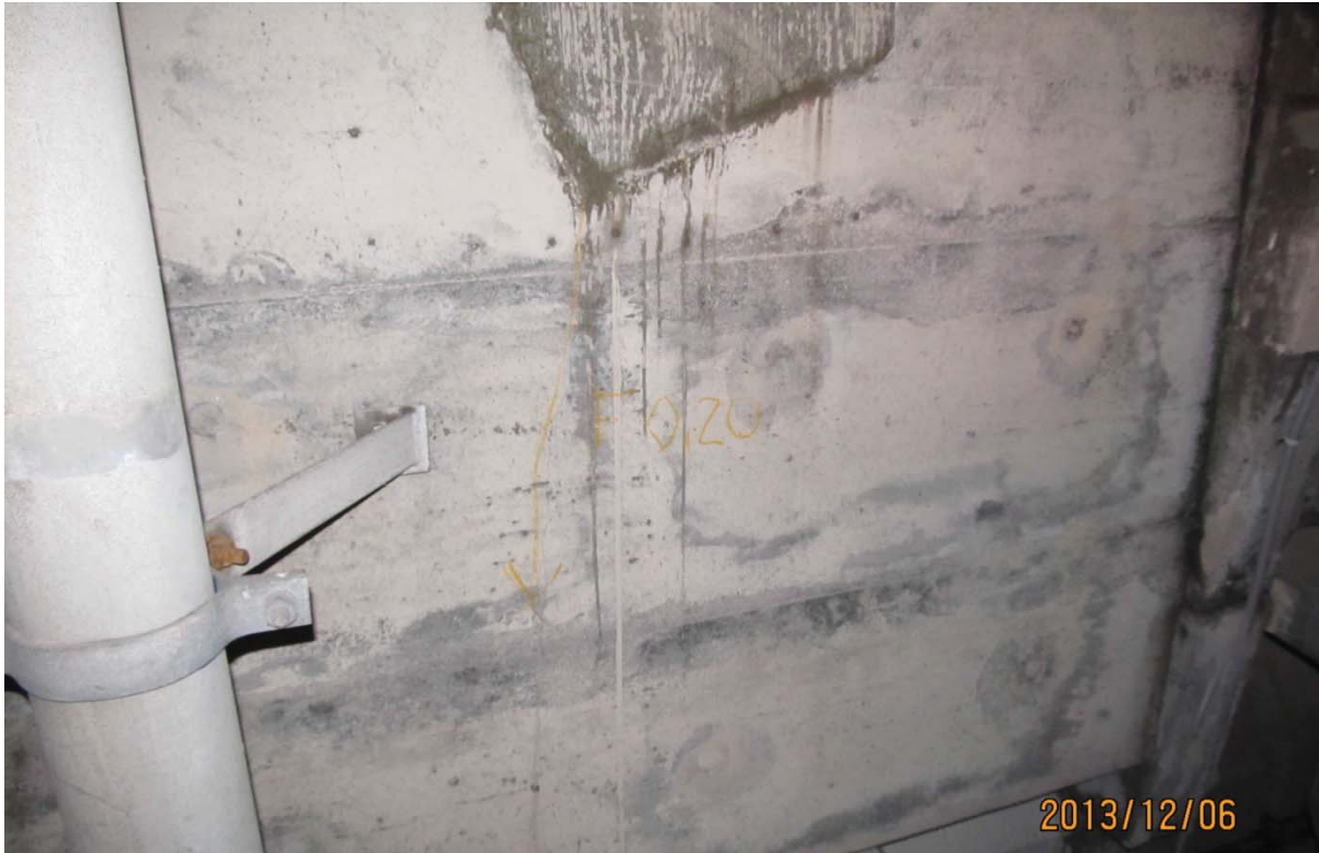
S5.PC.34W-35W.P7.a – 6635 (bloc d'ancrage QP 1.0 extérieur est)
