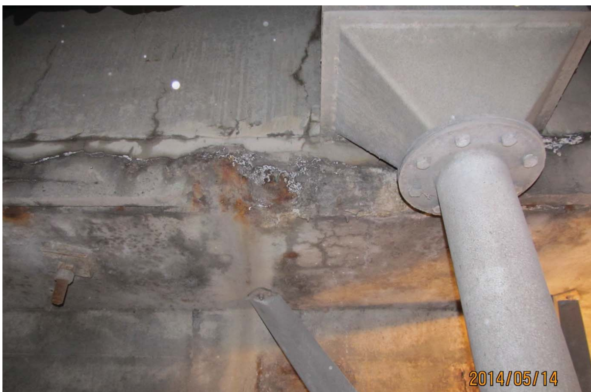
S5.PC.23W-24W.P1.d – 0483 (cachetage semelle supérieure - extrémité est face aval)
