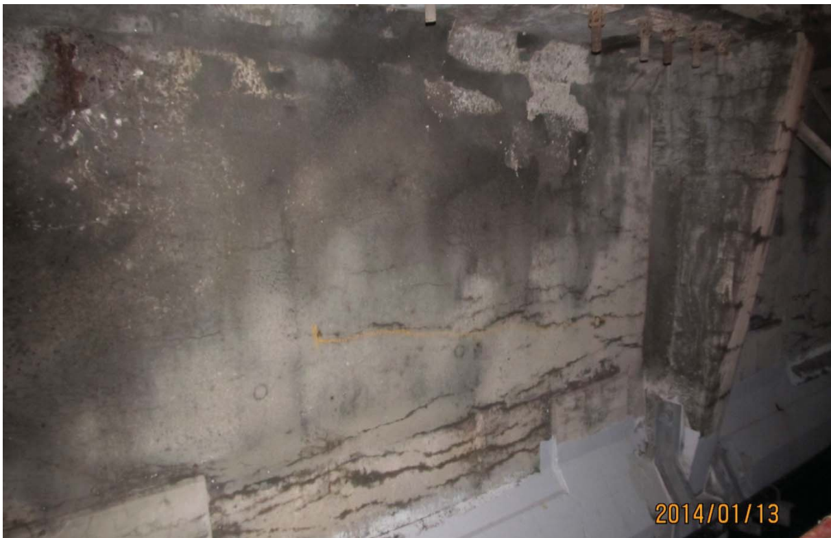
S7.PC.5E-6E.P7.b – 0149 (câble #22 - extrémité ouest face amont)
