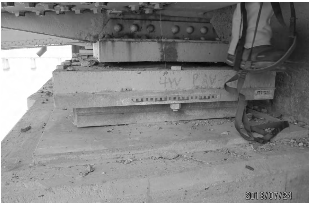
S6.PC.2.1.e – 5019 – Axe 4W (intérieur aval)
