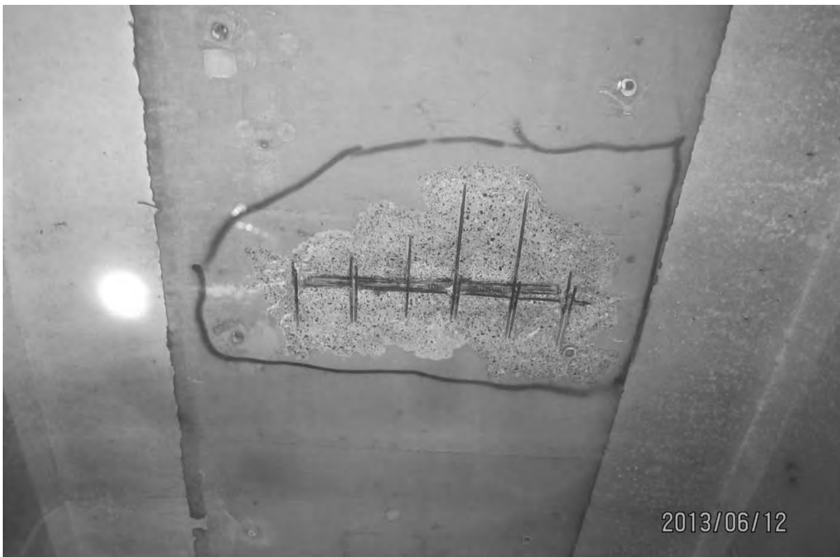
S7.PC.3.4.b – 4279 - Travée 7E-8E (entre P5-P6)
