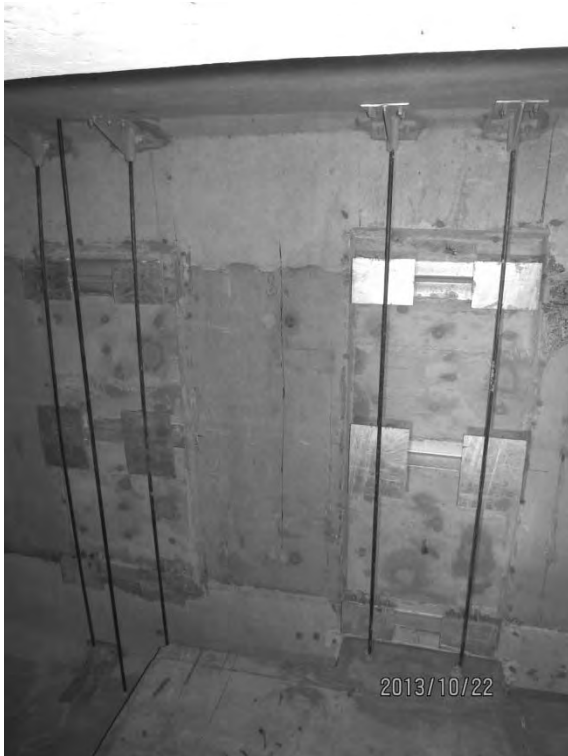
S7.PC.3.2.a – 5877 - Travée 5E-6E (entre P1-P2)
