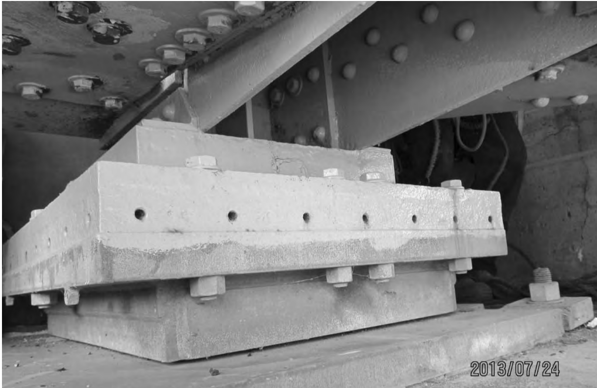
S6.PC.2.2.e – 4934 – Axe 2W (intérieur aval)
