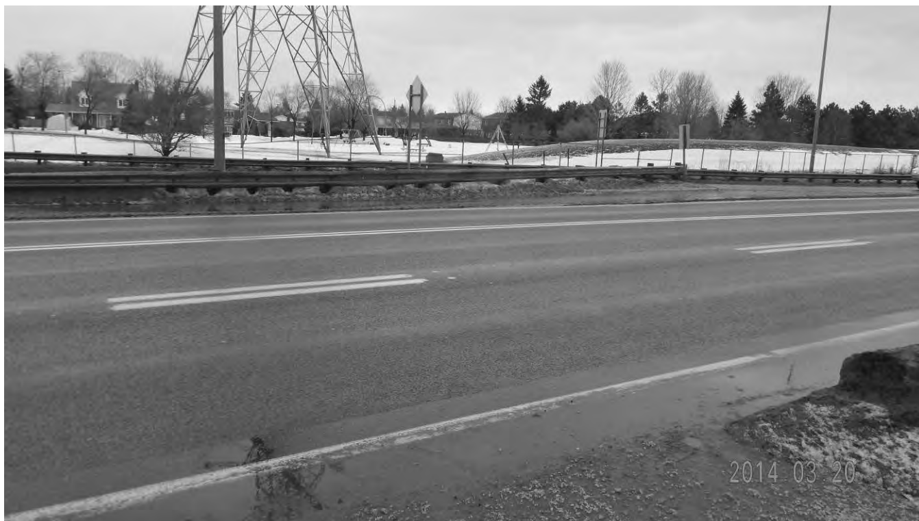
S8.PP.1.b – 0307 – Ponceau, dessus des voies de circulation direction Montréal
