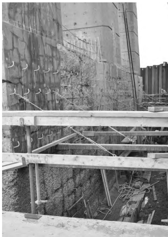
S6.PC.1.5.e – 5272 – Pile 3E (face ouest)
