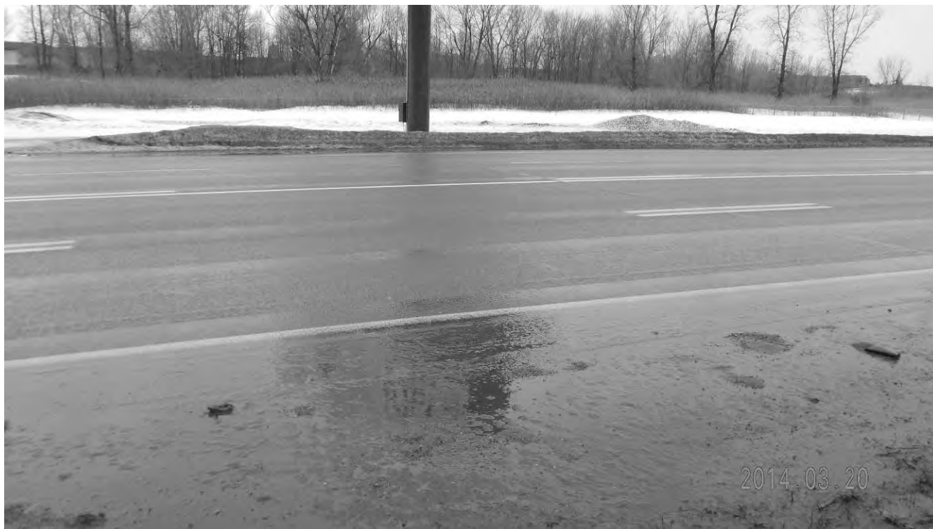
S8.PP.1.a – 0301 – Ponceau, dessus des voies de circulation direction Brossard
