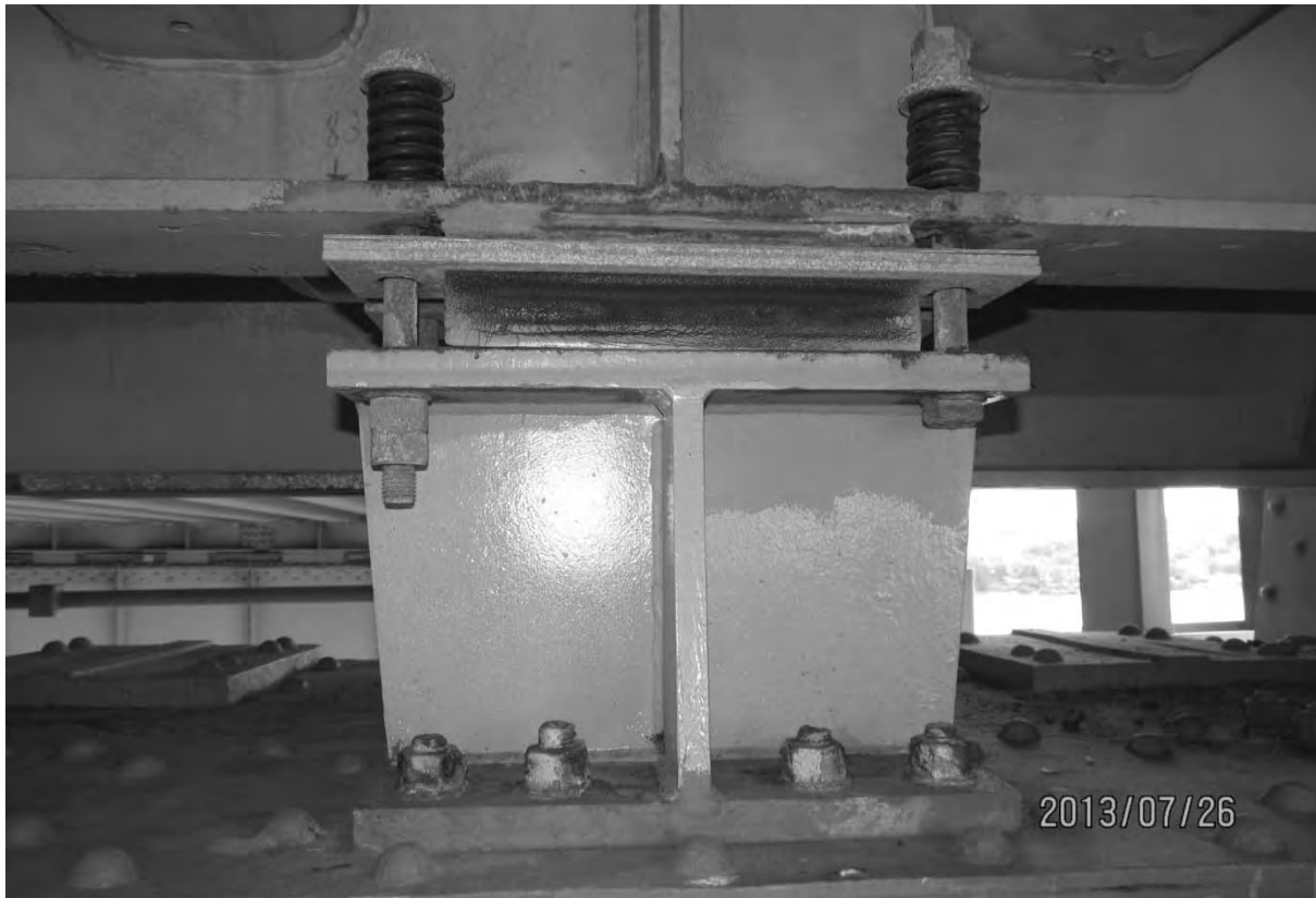
S6.PC.2.3.1.18 – 5267 – Axe 0.5E (appareil ouest #18 - amont)
