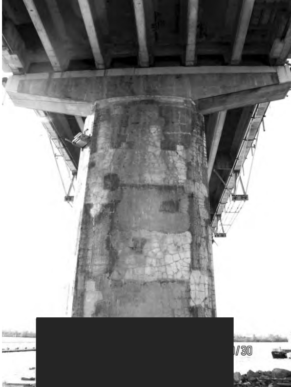
S7.PC.1.5.a – 6035 – Pile 6E (face est)
