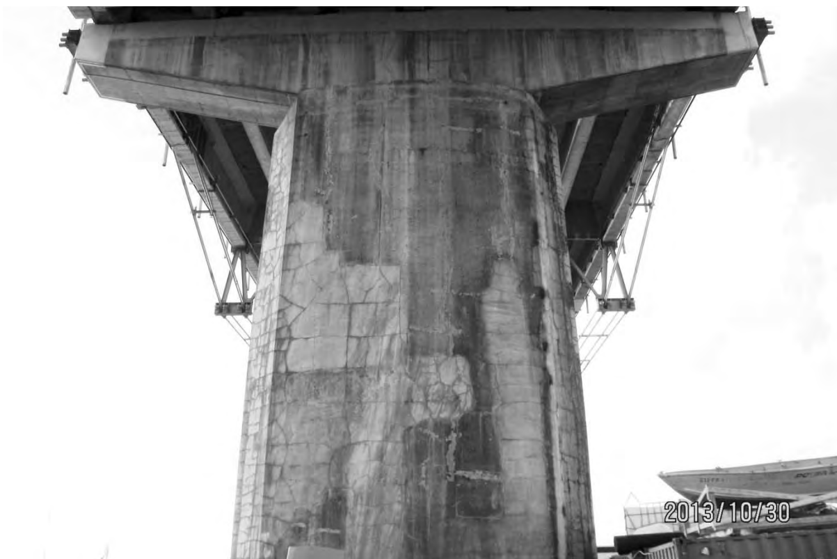
S7.PC.1.4.a – 6024 – Pile 7E (face est)
