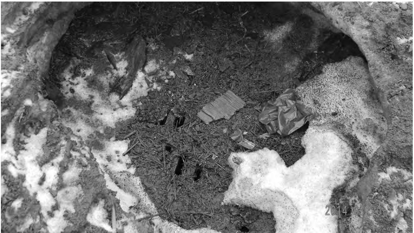
S8.Dr.4.d – 0312 – Drainage terre-plein à la fin de la glissière médiane
