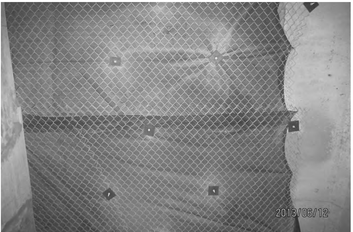
S7.PC.3.3.b – 4265 - Travée 6E-7E (entre P6-P7)
