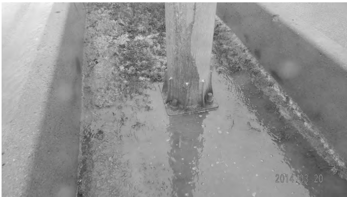
S8.Dr.4.b – 0291 – Drainage terre-plein à la structure LS-0
