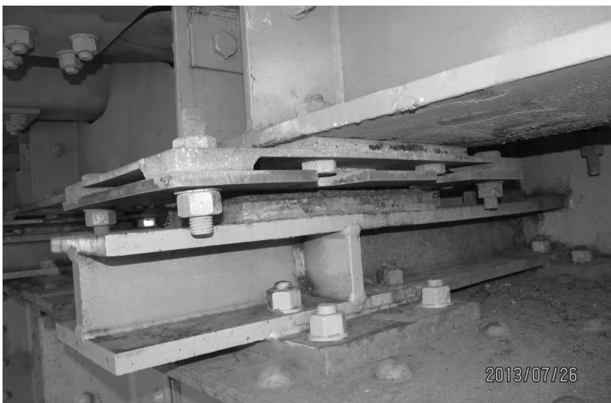
S6.PC.2.3.2.18 – 5235 – Axe 0.5E (appareil est #18 - amont)
