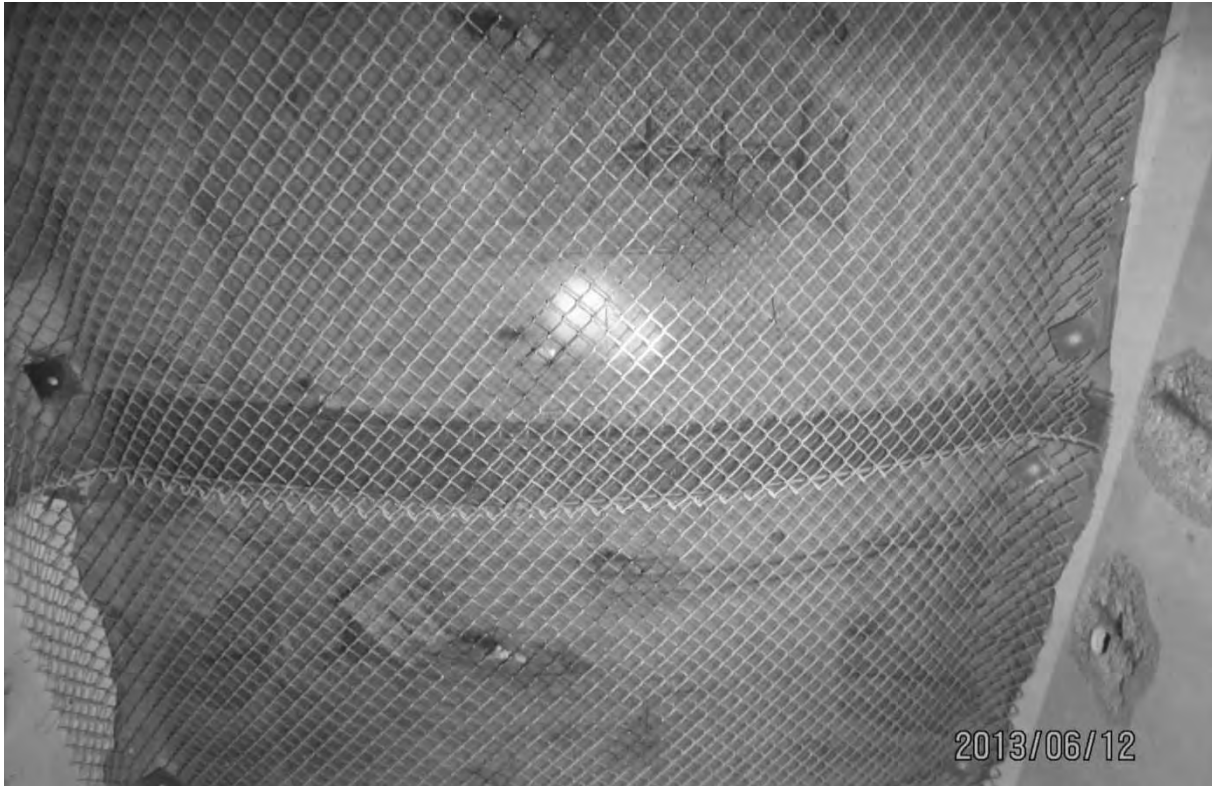
S7.PC.3.1.d – 4256 - Travée 4E-5E (entre P6-P7)
