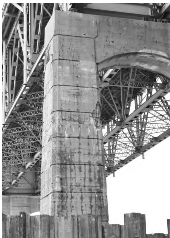
S6.PC.1.5.d – 5269 – Pile 3E (face ouest)
