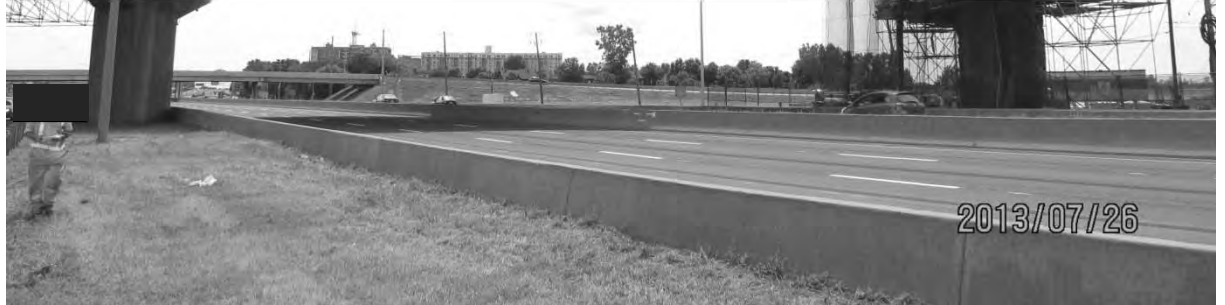
S7.PC.4.4.a – 5489 – Poutre 1 (Aval)
