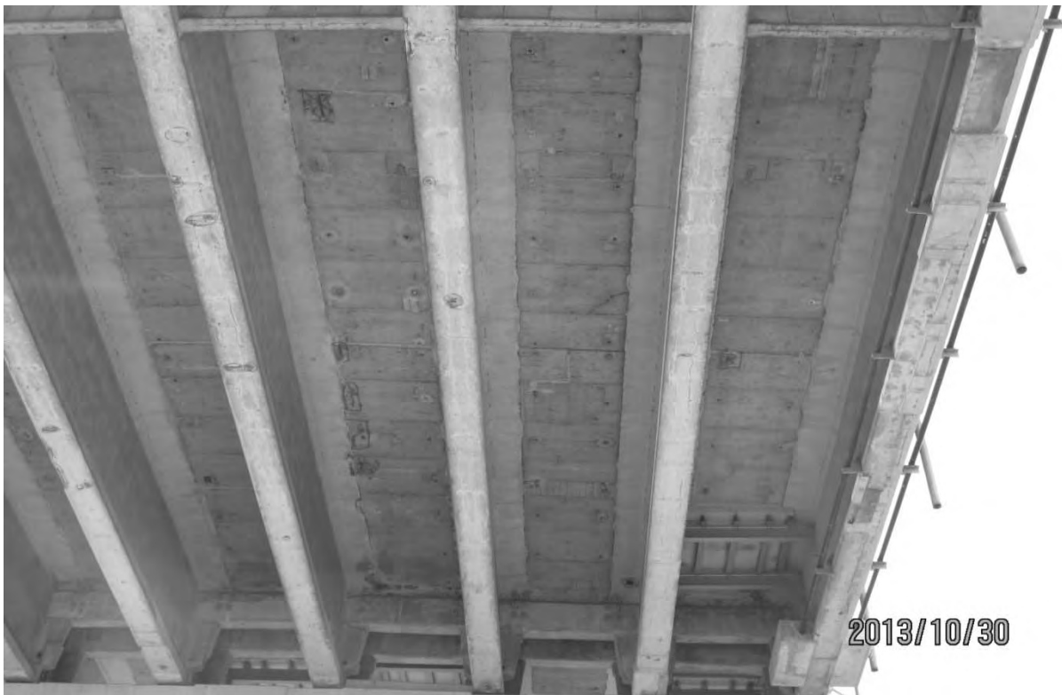
S7.PC.3.5.b – 6013 - Travée 8E-9E (vue générale – extrémité ouest)
