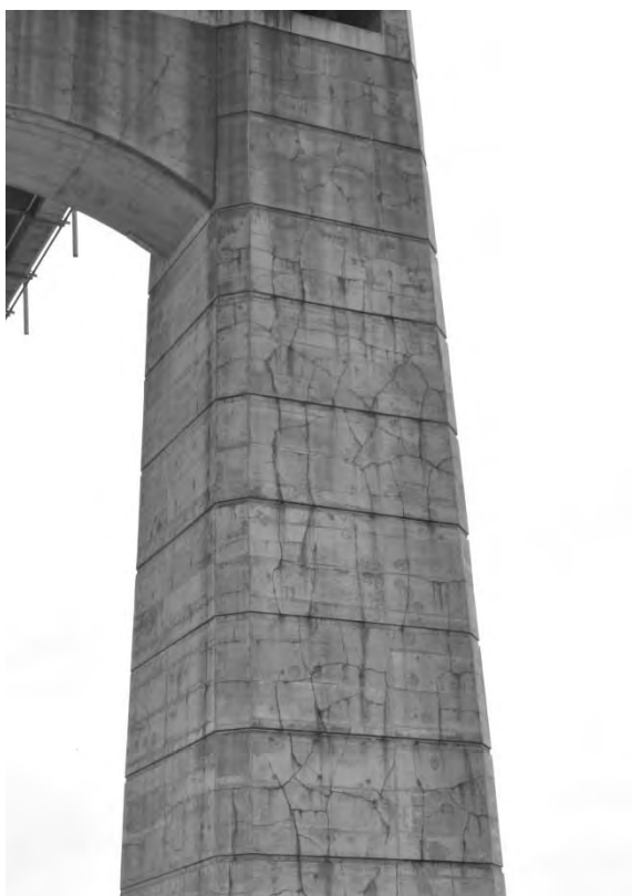
S6.PC.1.6.e – 5303 – Pile 4E (face ouest)
