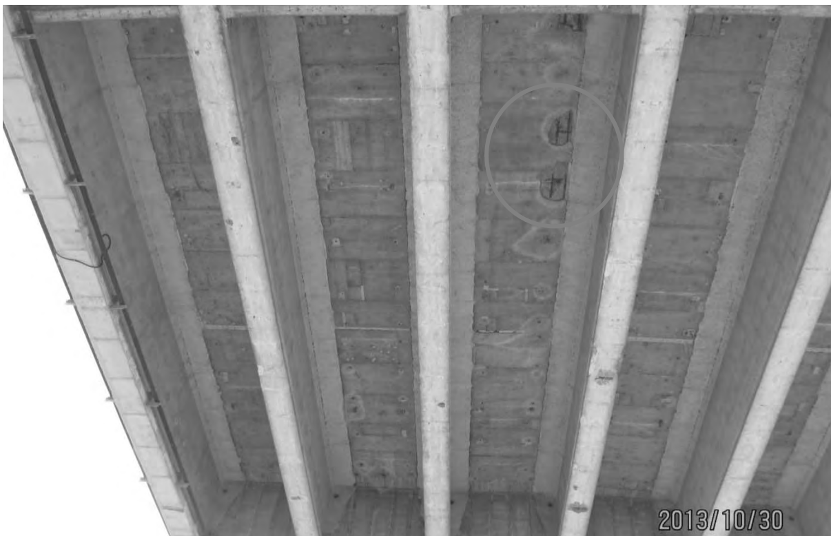
S7.PC.3.6.a – 6000 - Travée 9E-10E (vue générale – partie centrale)
