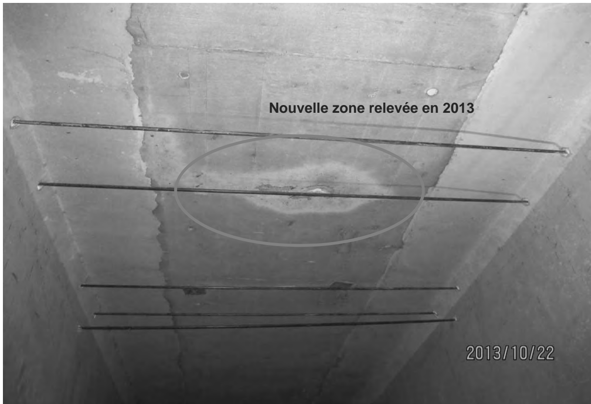
S7.PC.3.2.c – 5876 - Travée 5E-6E (entre P2-P3)
