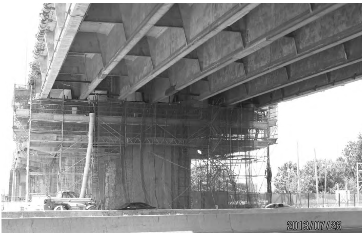
S7.PC.1.1.a – 5497 – Pile 10E (face est)
