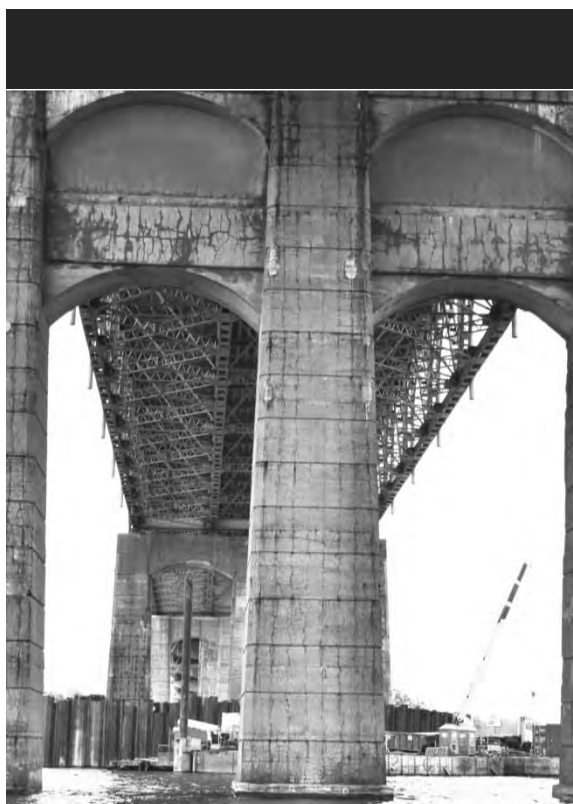
S6.PC.1.4.g – 5225 – Pile 2E (face ouest)
