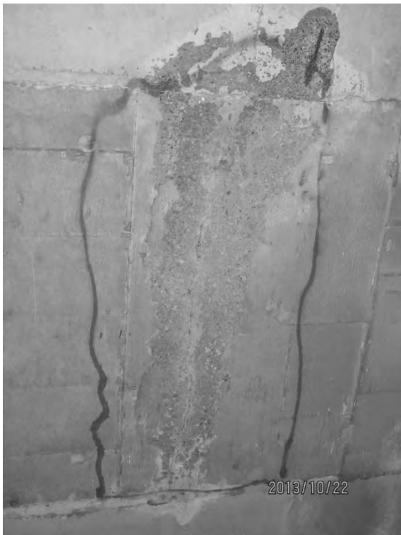
S7.PC.3.1.a – 5887 - Travée 4E-5E (entre P1-P2)
