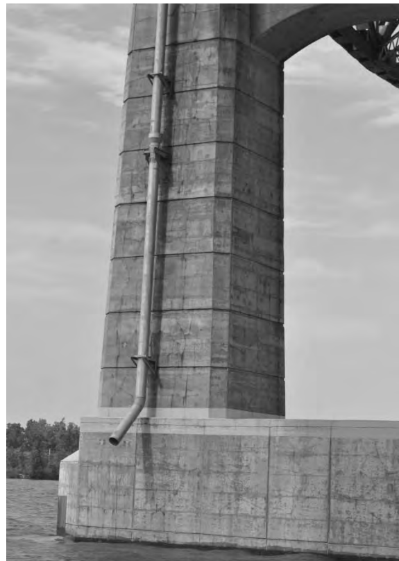
S6.PC.1.6.c – 5322 – Pile 4E (face est)
