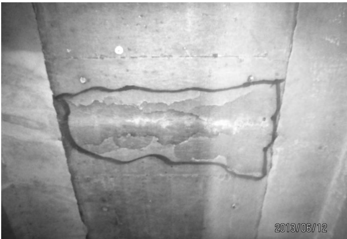
S7.PC.3.1.c – 4260 - Travée 4E-5E (entre P5-P6)
