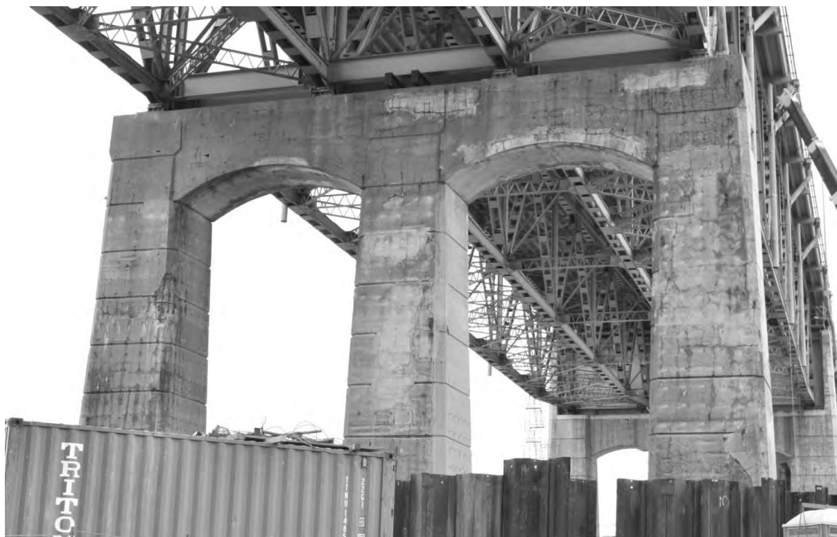
S6.PC.1.5.c – 5264 – Pile 3E (face ouest)
