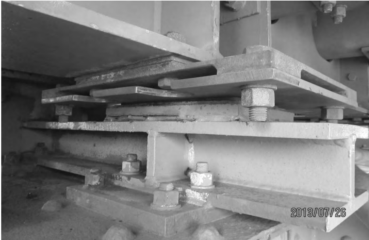
S6.PC.2.3.2.1 – 5153 – Axe 0.5E (appareil est #1 - aval)
