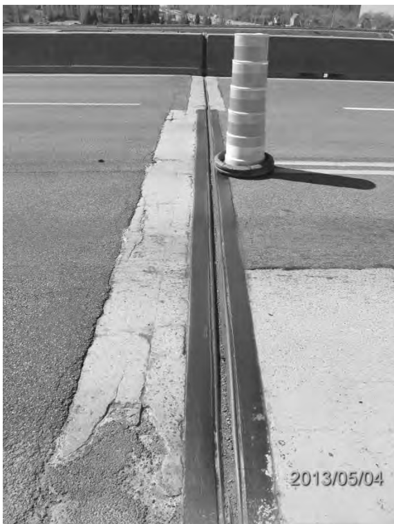
S7.PC.3.1.a – 4038 – Joint 14E (Amont)
