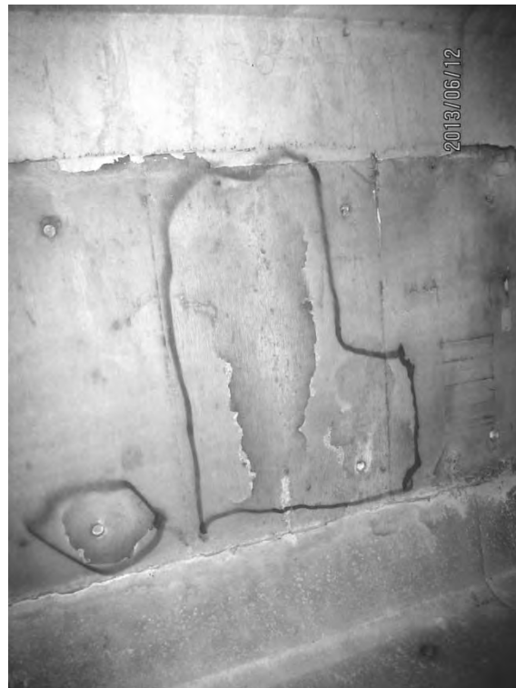
S7.PC.3.1.b – 4259 - Travée 4E-5E (entre P4-P5)
