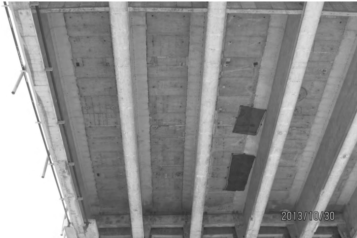
S7.PC.3.5.a – 6008 - Travée 8E-9E (vue générale – extrémité est)
