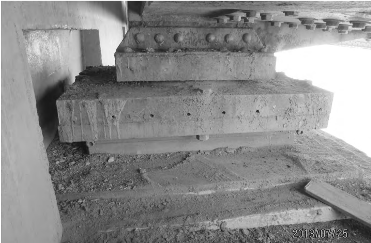
S6.PC.2.4.e – 5094 – Axe 4E (intérieur aval)
