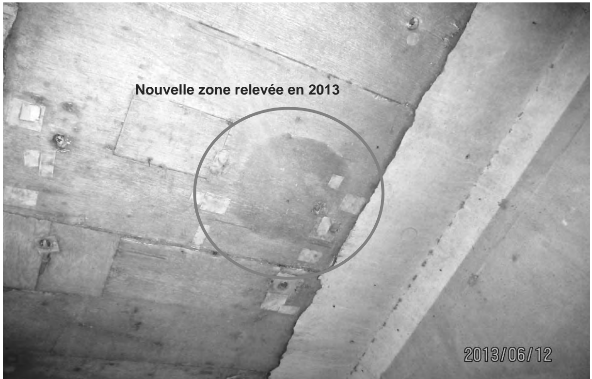
S7.PC.3.3.a – 4273 - Travée 6E-7E (entre P5-P6)
