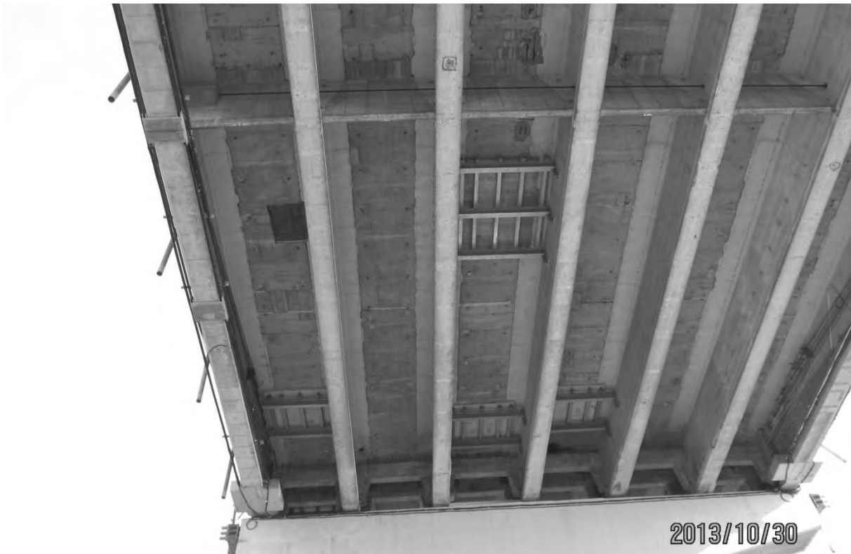
S7.PC.3.4.a – 6018 - Travée 7E-8E (vue générale – extrémité est)
