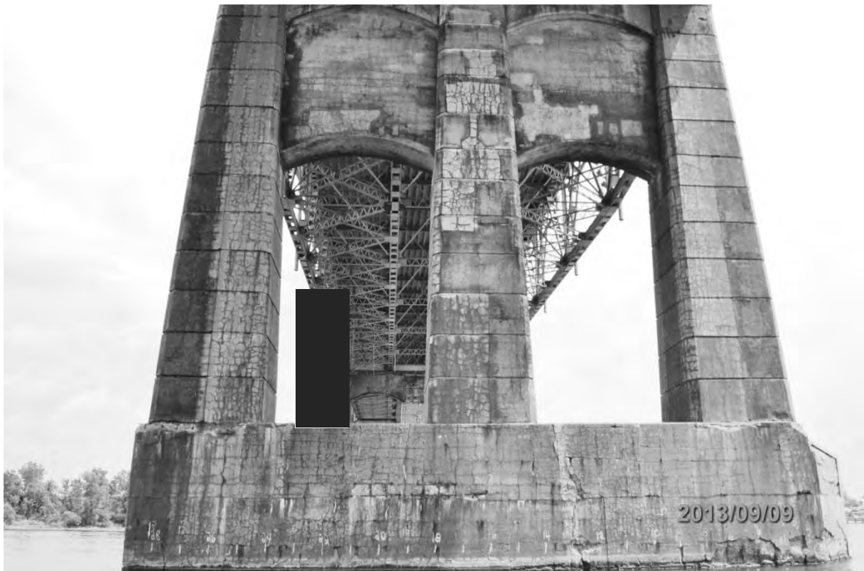
S6.PC.1.1.b – 5063 – Pile 4W (face ouest)
