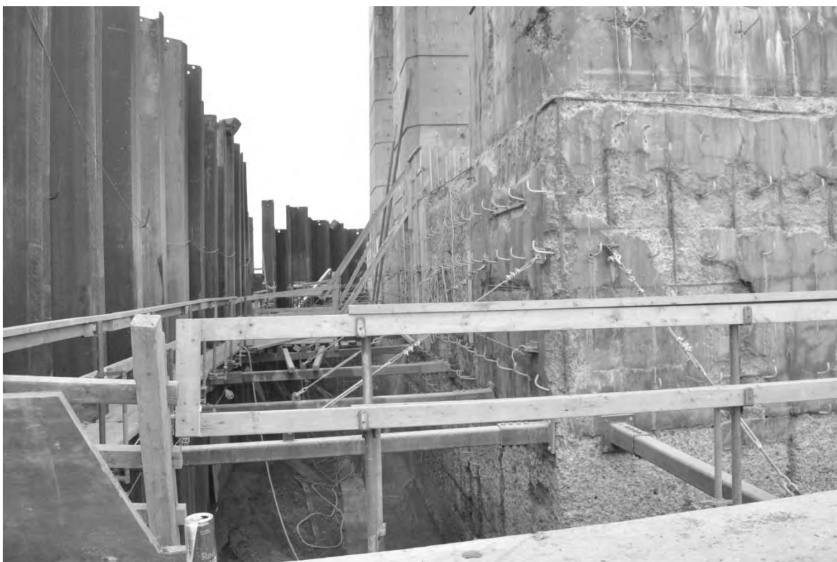
S6.PC.1.5.b – 5274 – Pile 3E (face est)
