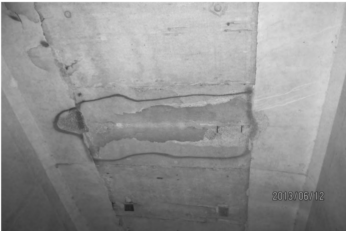
S7.PC.3.1.e – 4261 - Travée 4E-5E (entre P6-P7)
