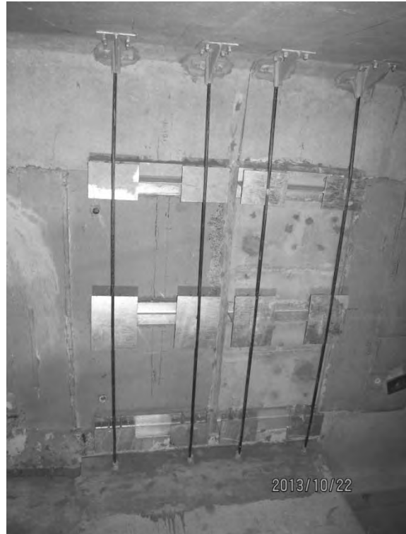
S7.PC.3.2.b – 5884 - Travée 5E-6E (entre P1-P2)
