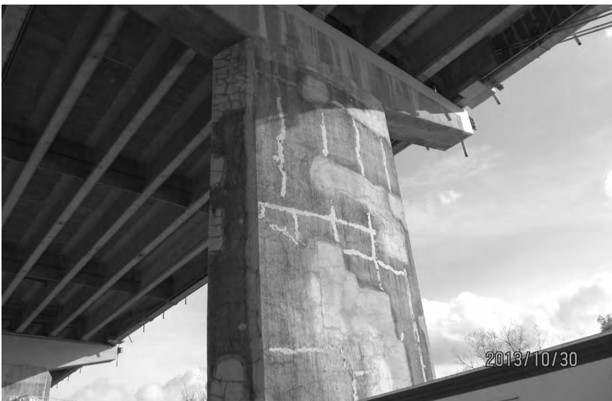
S7.PC.1.4.b – 6026 – Pile 7E (face ouest)
