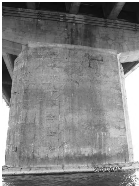
S5.PC.1.6.b – 4743 – Pile 38W (face ouest)
