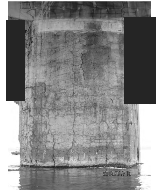
S5.PC.1.11.b – 4800 – Pile 33W (face ouest)
