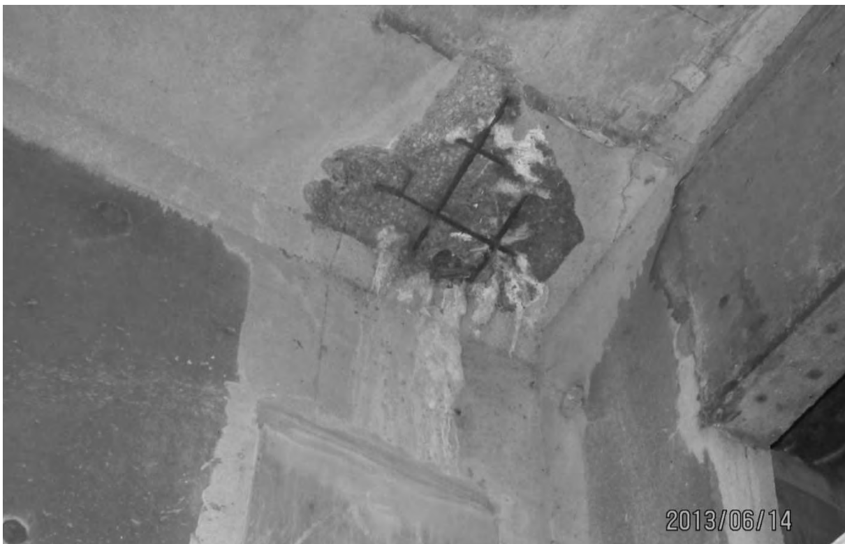
S5.PC.3.21.b – 4326 - 21W-20W (entre P4-P5 Poutre P4)
