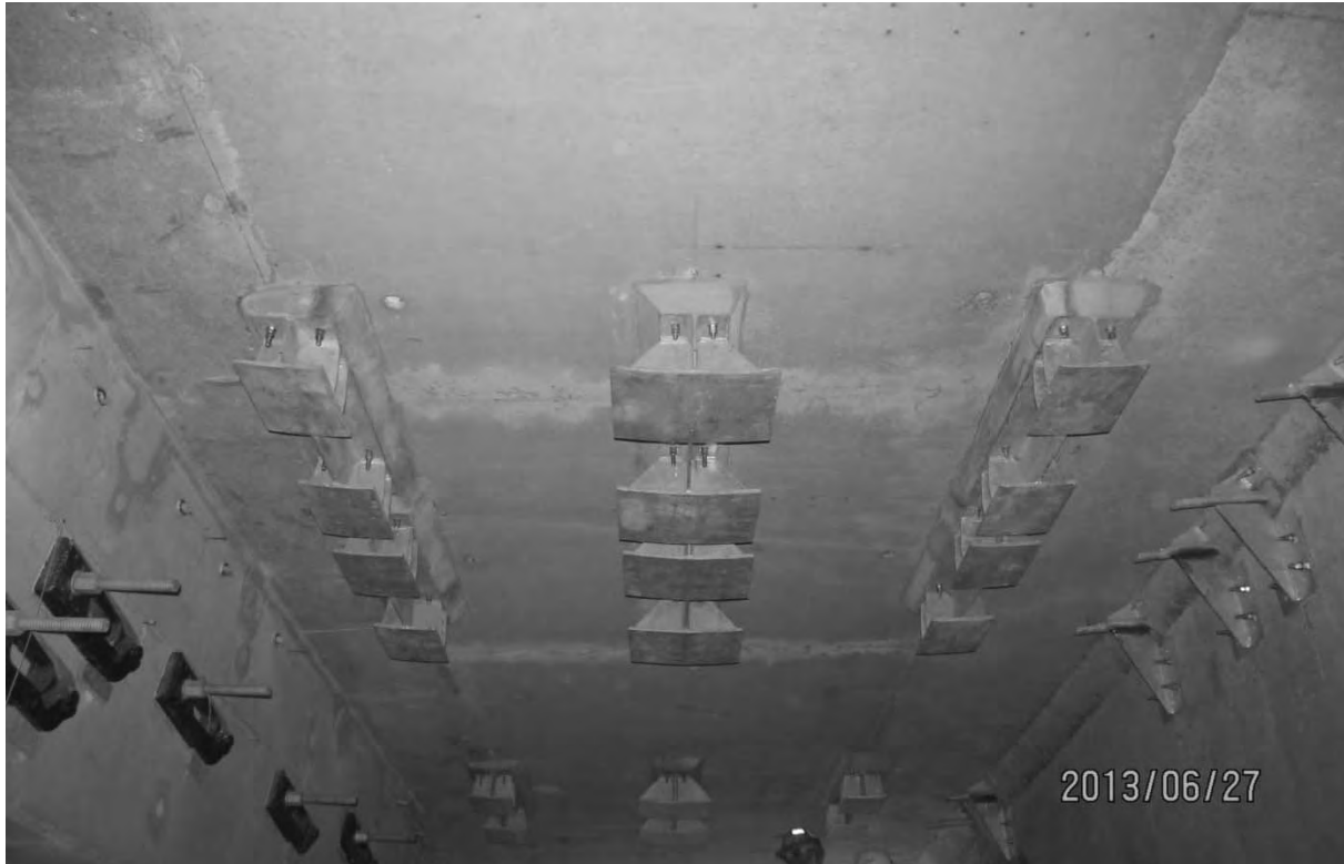
S5.PC.3.1.a – 4570 - Travée 44W-43W (entre P1-P2)
