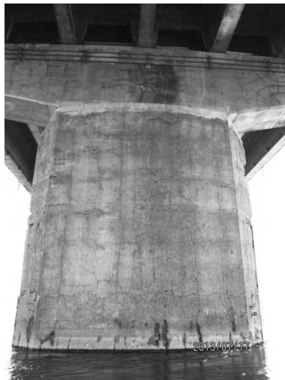
S5.PC.1.7.b – 4751 – Pile 37W (face ouest)
