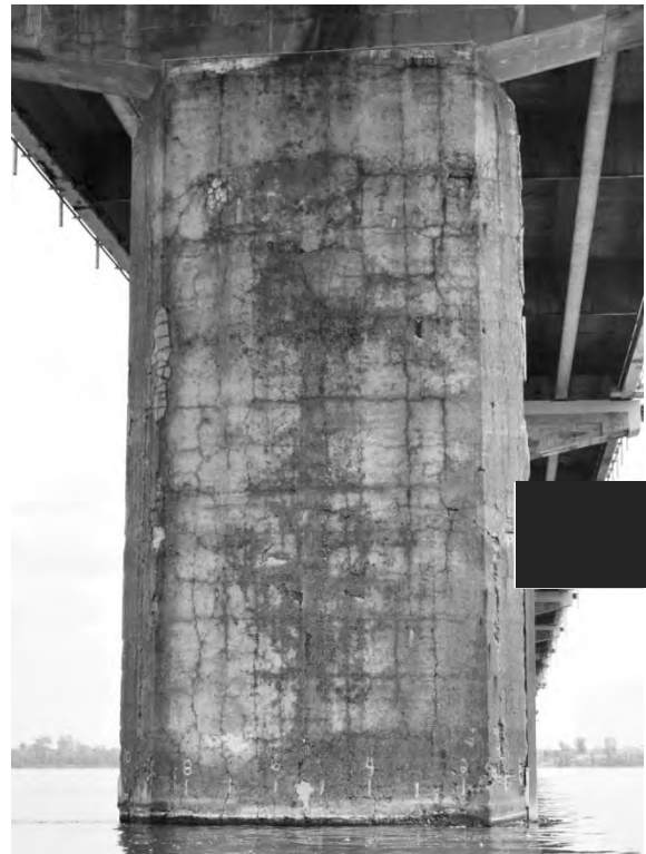
S5.PC.1.25.b – 4931 – Pile 19W (face ouest)
