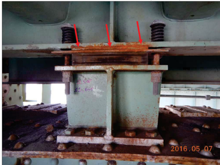
Photo 20150507 [REDACTED] 3882 : Axe 0.5W, Appareil d'appui à ressorts, groupe amont, série Est Appareil d'appui à la 1 re position à partir de la ferme amont, face Est, vue générale
