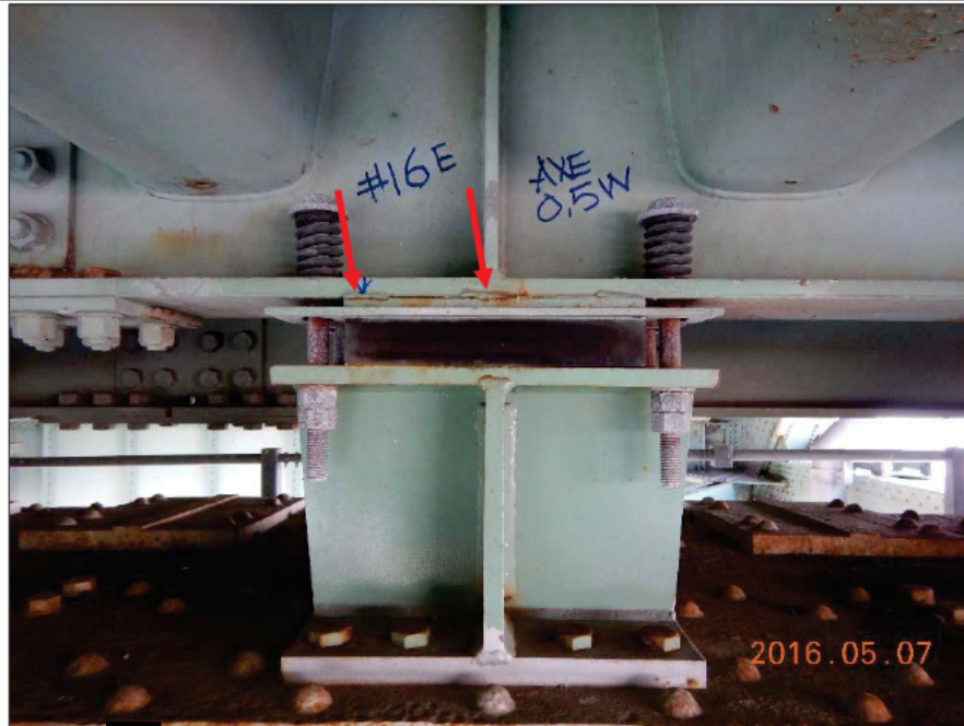
Photo 20150507 [REDACTED]_3895 : Axe 0.5W, Appareil d'appui à ressorts, groupe aval, série Est Appareil d'appui à la 16 e position à partir de la ferme amont, face Est, vue générale
