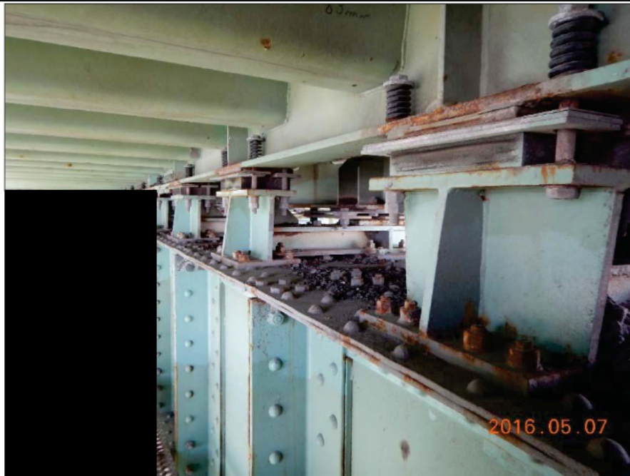
Photo 20150507 [redacted] 3857 : Axe 0.5E, Appareil d'appui à ressorts, groupe amont, série Ouest Vue générale des neuf (9) appareils d'appui
