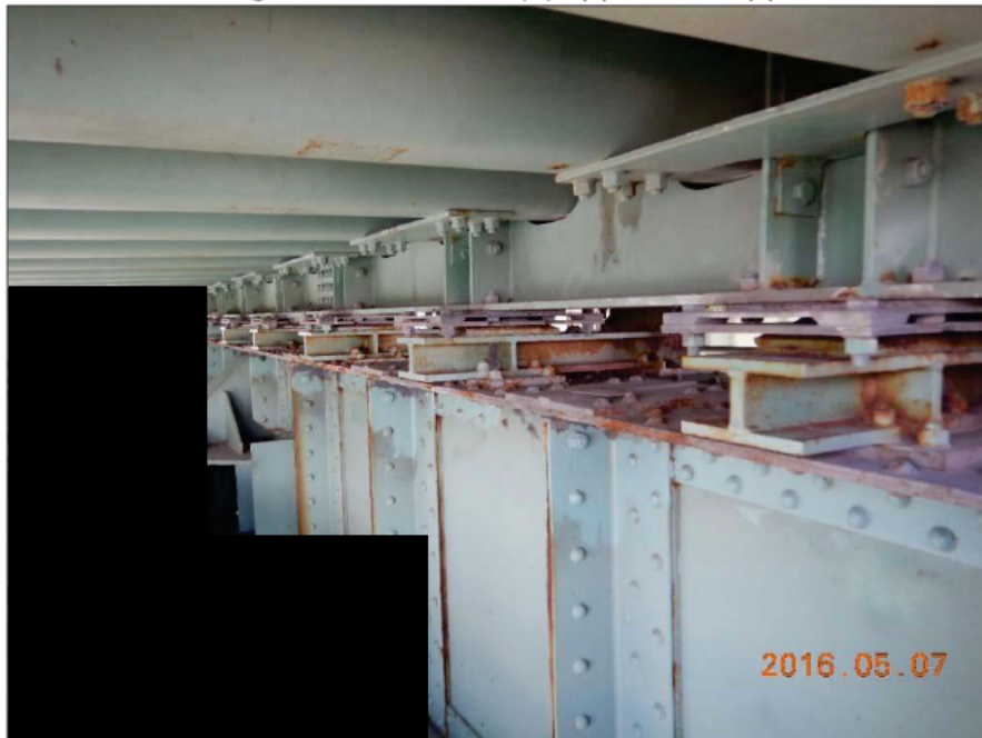
Photo 20150507 [redacted] E, Appareil d'appui mobile, groupe aval, série Est Vue générale des neuf (9) appareils d'appui
