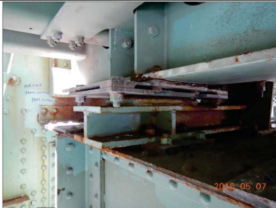
Photo 2015050 [REDACTED] 3853 : Axe 0.5E, Appareil d'appui mobile, groupe aval, série Est Appareil d'appui à la 10 e position à partir de la ferme amont, vue générale
