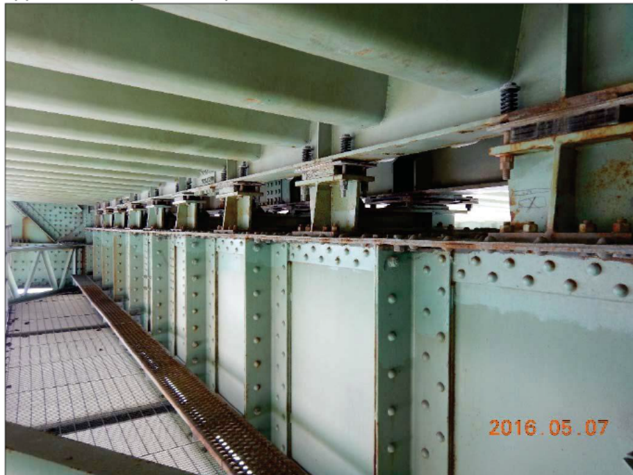
Photo 20150507 [REDACTED] 3865 : Axe 0.5E, Appareil d'appui à ressorts, groupe aval, série Ouest Vue générale des neuf (9) appareils d'appui
