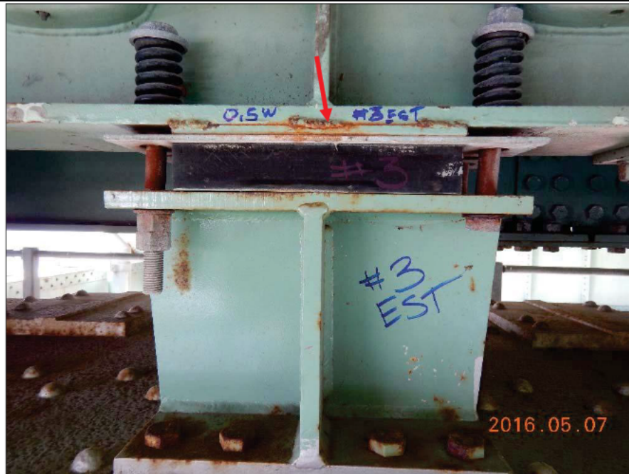
Photo 20150507 3889 : Axe 0.5W, Appareil d'appui à ressorts, groupe amont, série Est Appareil d'appui à la 3 e position à partir de la ferme amont, face Est, vue générale
