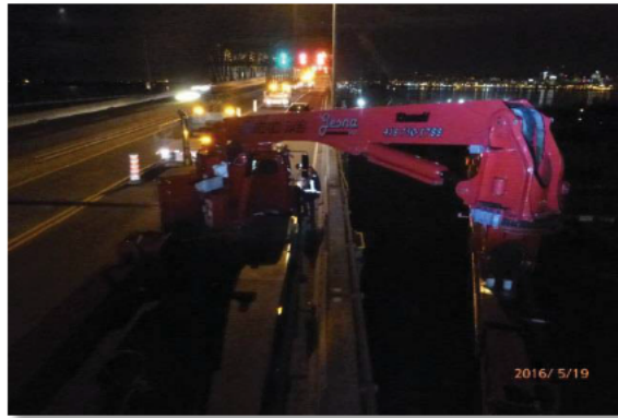
Figure 2 : Exemple d'inspection détaillée des joints et des éléments sensibles, en camion-nacelle sur le tablier
