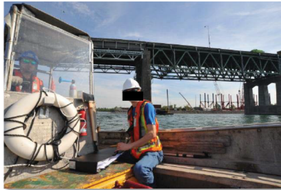
Figure 3 : Exemple d'inspection visuelle à partir de la surface de l'eau
