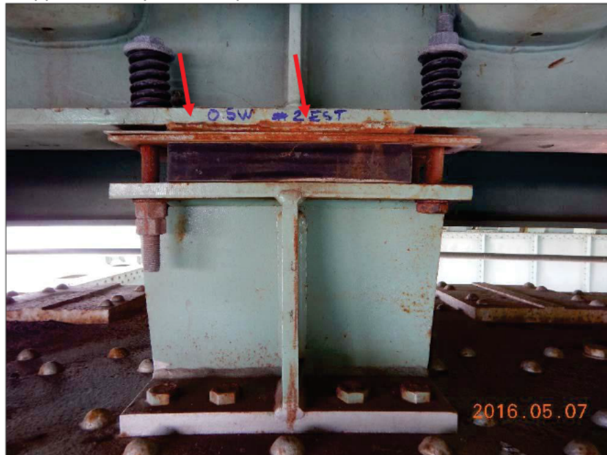
Photo 20150507 [REDACTED] 3886 : Axe 0.5W, Appareil d'appui à ressorts, groupe amont, série Est Appareil d'appui à la 2 e position à partir de la ferme amont, face Est, vue générale
