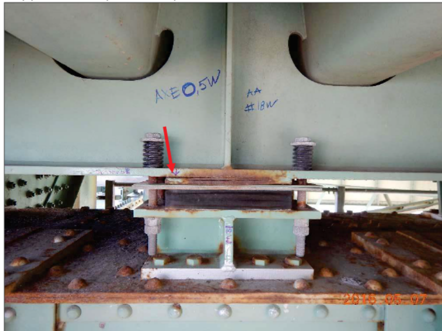
Photo 20150507 [redacted] 3913 : Axe 0.5W, Appareil d'appui à ressorts, groupe aval, série Ouest Appareil d'appui à la 18 e position à partir de la ferme amont, face Est, vue générale
