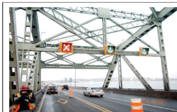
Figure 1 : Exemple d'inspection générale des feux de voies, exécutée à pied à partir de la surface de roulement du tablier
