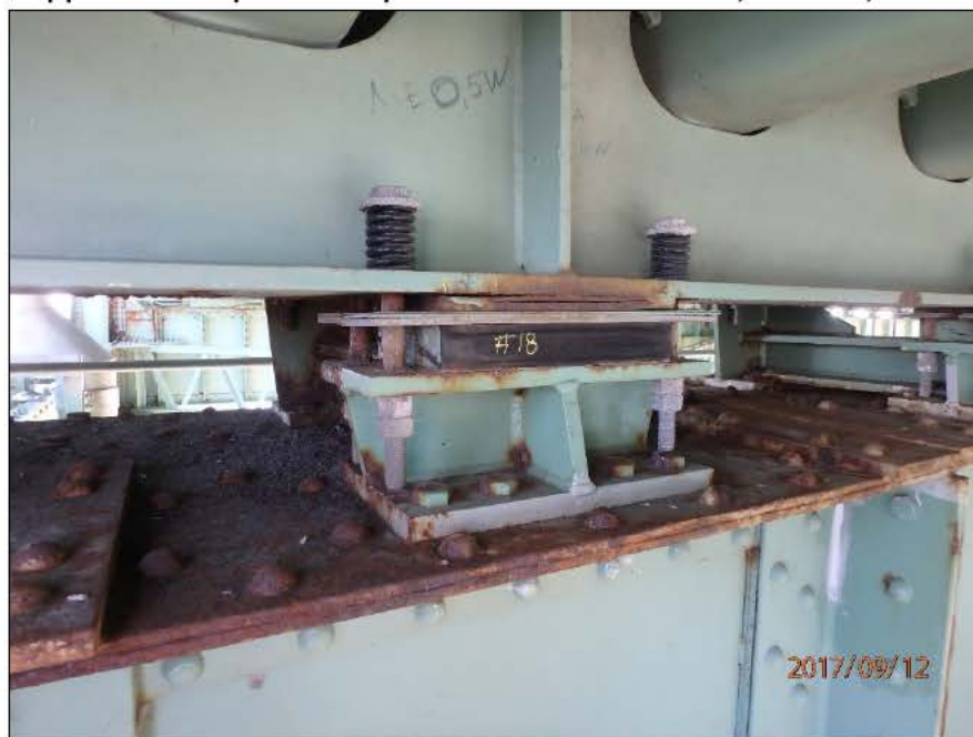
Photo 20170912_AF_1246 : Axe 0.5W, Appareil d'appui à ressorts, groupe aval, série Ouest Appareil d'appui à la 18 e position à partir de la ferme amont, face Est, vue générale
