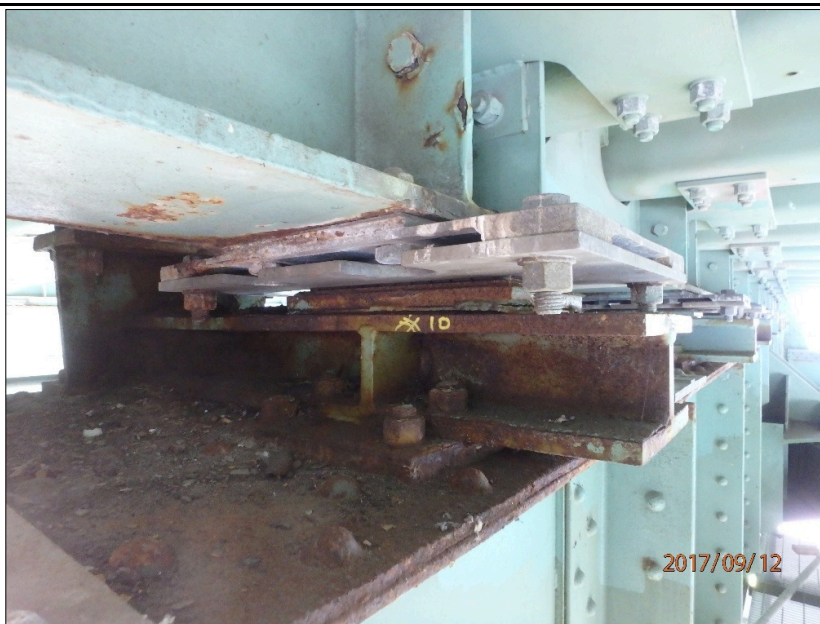
Photo 20170912_AF_1206 : Axe 0.5E, Appareil d'appui mobile, groupe aval, série Est Appareil d'appui à la 10 e position à partir de la ferme amont, vue générale
