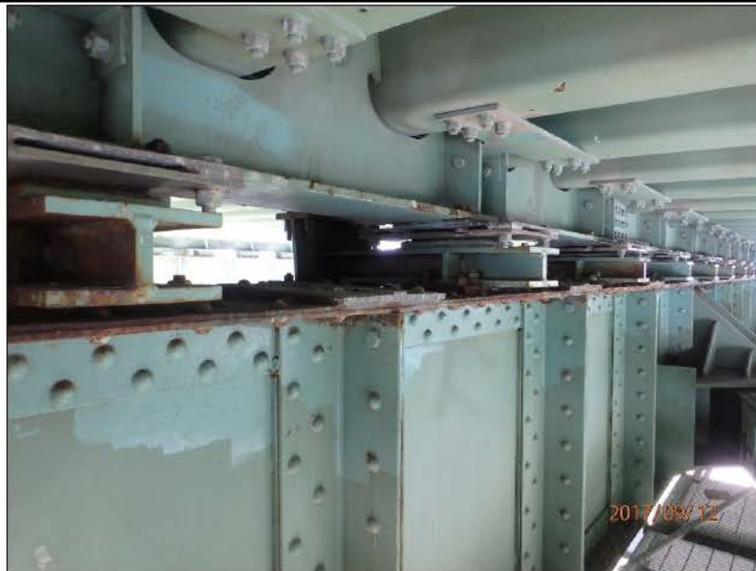
Photo 20170912_AF_1208 : Axe 0.5E, Appareil d'appui mobile, groupe aval, série Est Vue générale des neuf (9) appareils d'appui
