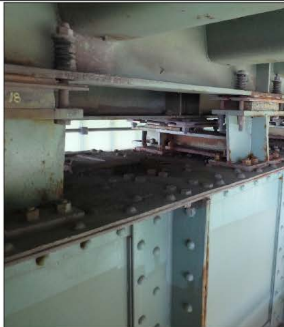
Photo 20170912_AF_1223 : Axe 0.5E, Appareil d'appui à ressorts, groupe aval, série Ouest Vue générale des neuf (9) appareils d'appui
