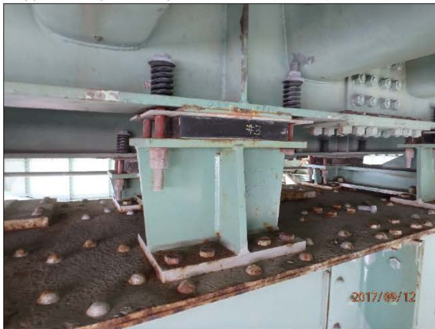
Photo 20170912_AF_1229: Axe 0.5W, Appareil d'appui à ressorts, groupe amont, série Est Appareil d'appui à la 3 e position à partir de la ferme amont, face Est, vue générale
