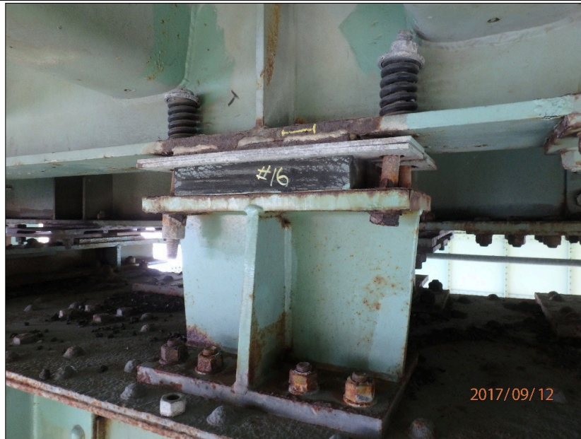
Photo 20170912_AF_1217 : Axe 0.5E, Appareil d'appui à ressorts, groupe aval, série Ouest Appareil d'appui à la 16 e position à partir de la ferme amont, face Ouest, vue générale
