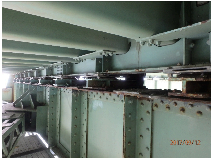
Photo 20170912_AF_1205 : Axé 0.5E, Appareil d'appui mobile, groupe amont, série Est Vue générale des neuf (9) appareils d'appui
