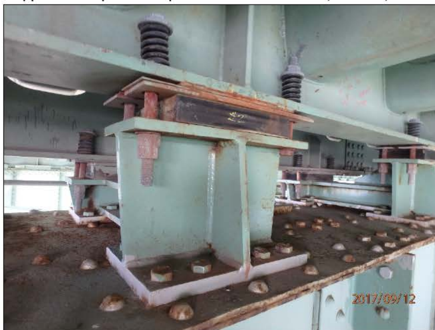
Photo 20170912_AF_1227 : Axe 0.5W, Appareil d'appui à ressorts, groupe amont, série Est Appareil d'appui à la 2 e position à partir de la ferme amont, face Est, vue générale
