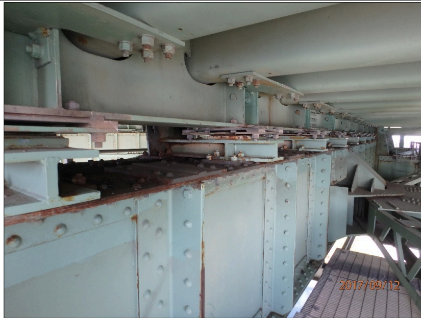
Photo 20170912_AF_1202: Axé 0.5E, Appareil d'appui mobile, groupe amont, série Est Vue générale des neuf (9) appareils d'appui
