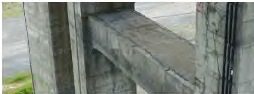
DESSUS POUTRE DE LIAISON ENTRE COLONNES A ET B
