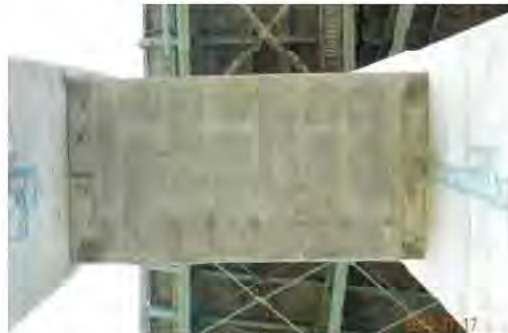
DESSOUS POUTRE DE LIAISON ENTRE COLONNES A ET B
