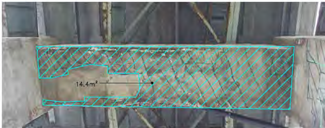
DESSOUS CHEVÊTRE ENTRE COLONNES A ET B
