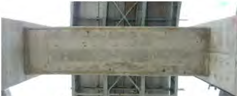
DESSOUS POUTRE DE LIAISON ENTRE COLONNES A ET B
