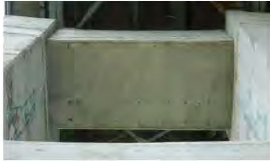
DESSOUS CHEVÊTRE ENTRE COLONNES A ET B
