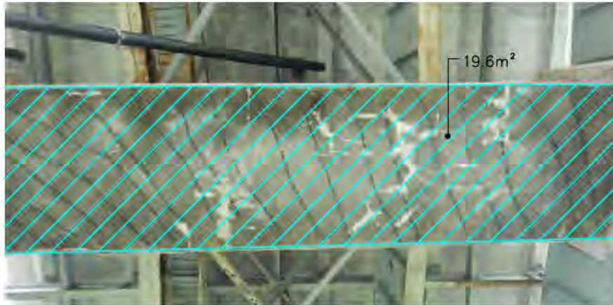
DESSOUS CHEVÊTRE ENTRE COLONNES A ET B
