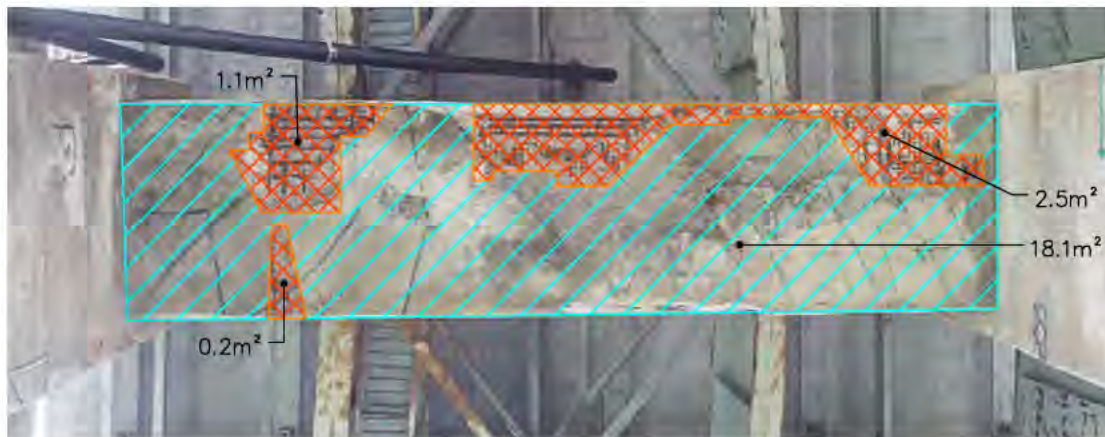
DESSOUS CHEVÊTRE ENTRE COLONNES A ET B
