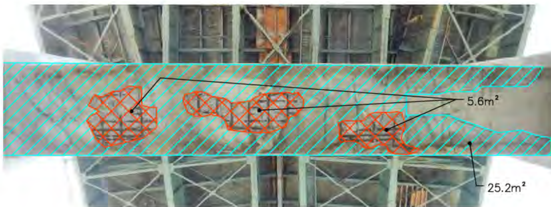
DESSOUS POUTRE DE LIAISON ENTRE COLONNES B ET C
