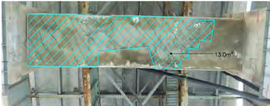
DESSOUS CHEVÊTRE ENTRE COLONNES A ET B
