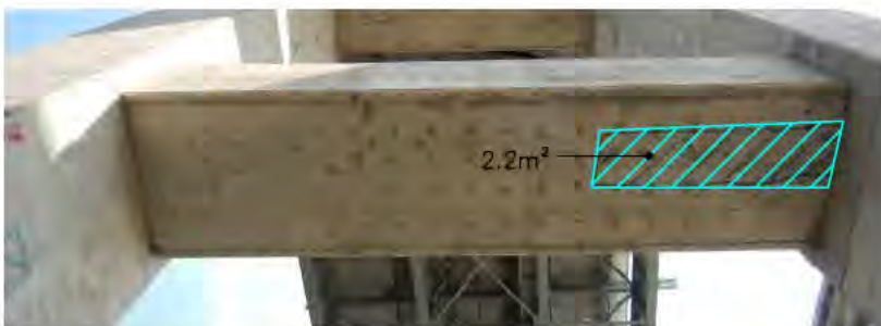
DESSOUS POUTRE DE LIAISON ENTRE COLONNES A ET B
