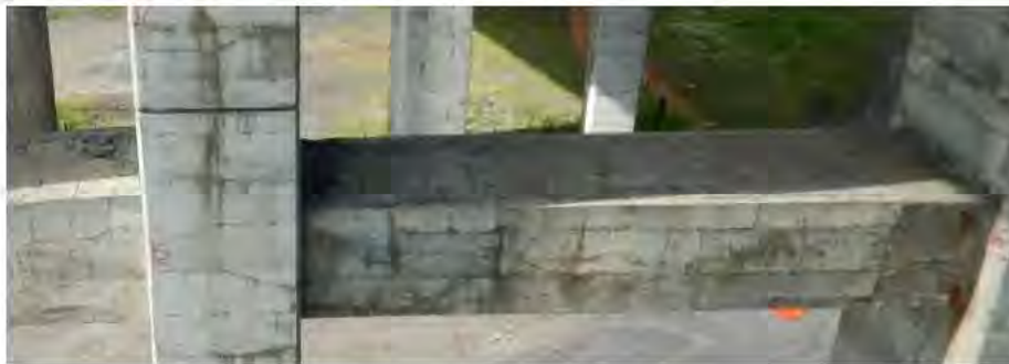
DESSUS POUTRE DE LIAISON ENTRE COLONNES B ET C
