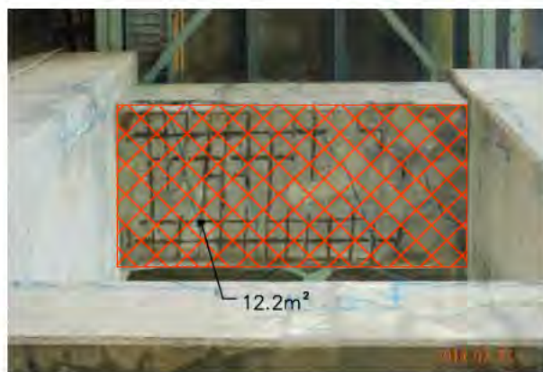
DESSOUS CHEVÊTRE ENTRE COLONNES C ET D
