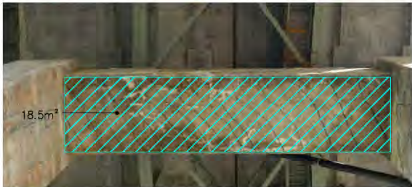
DESSOUS CHEVÊTRE ENTRE COLONNES A ET B
