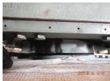
Photo 1: Appareil d'appui côté AV JC_8_170303_JM_8836
