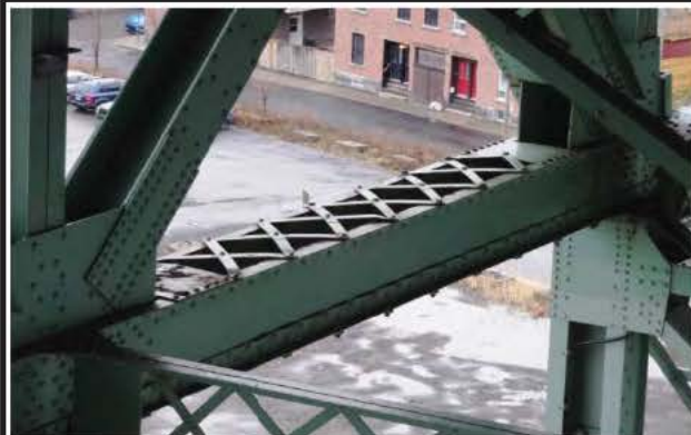
Photo 1: Corde inférieure JC_8_20151214 3682
