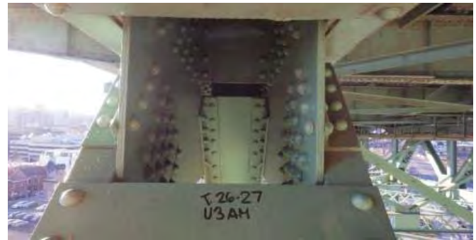
Photo plaque amont, face intérieure:
