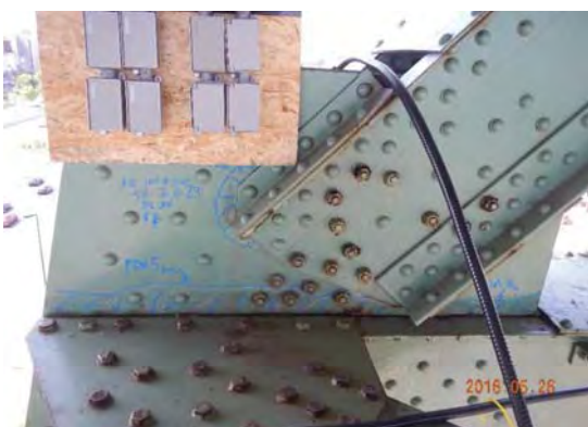
Photo plaque aval, face extérieure :
