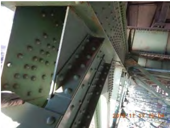
Photo plaque aval, face extérieure :
