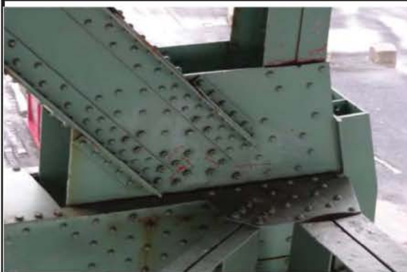
Photo 1: Assemblage inférieur JC_8_20151214_3677
