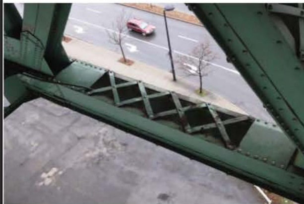
Photo 1: Corde inférieure JC_8_20151214_3714
