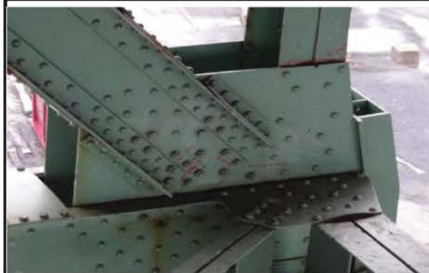
Photo 1: Assemblage inférieur JC_8_20151214_3677
