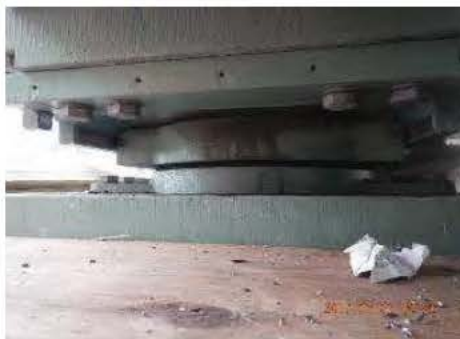
Photo 1: Appareil d'appui côté AV JC_8_170303_JM_8834
