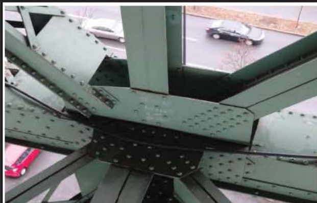
Photo 1: Assemblage inférieur JC_8_20151214_3706
