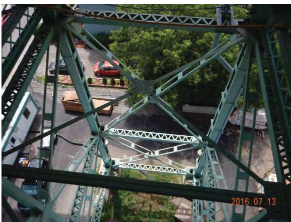
Photo 2 - Vue générale, banc en acier typique
