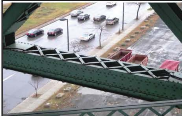
Photo 1: Corde inférieure JC_8_20151214_3713
