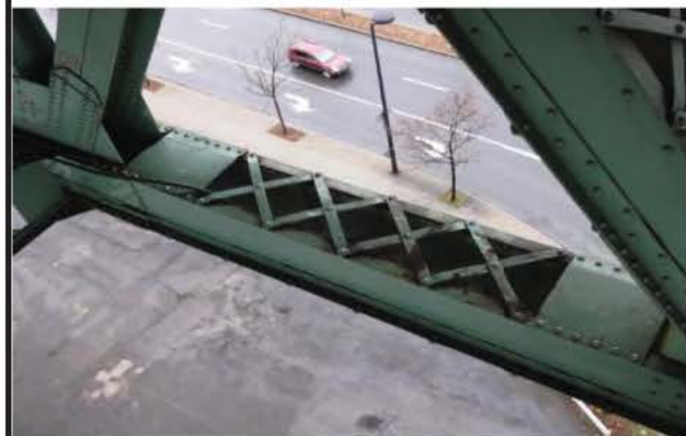
Photo 1: Corde inférieure JC_8_20151214 3714
