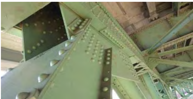
Photo plaque aval, face extérieure :
