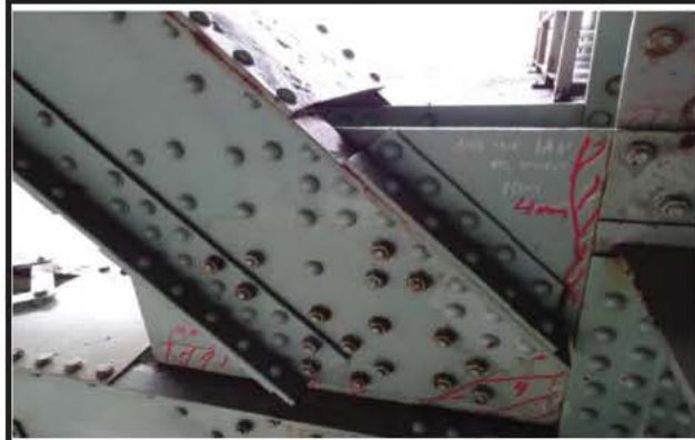
Photo 1: Assemblage inférieur JC_8_20151214_3651
