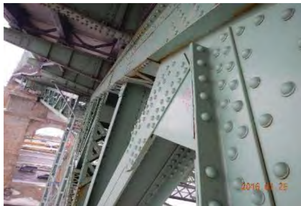
Photo plaque aval, face extérieure :
