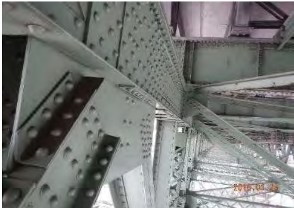
Photo plaque aval, face extérieure :
