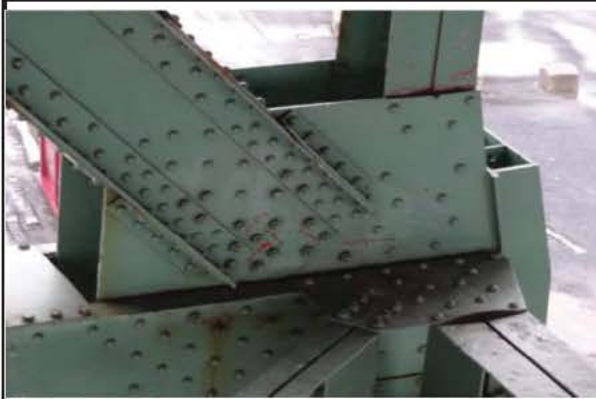
Photo 1: Assemblage inférieur JC_8_20151214_3677
