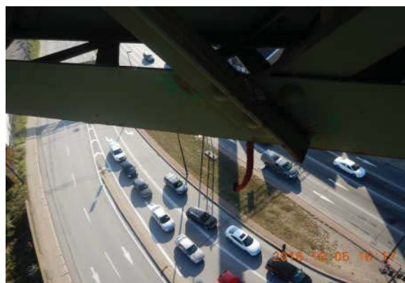
Photo cornière inférieure sud
