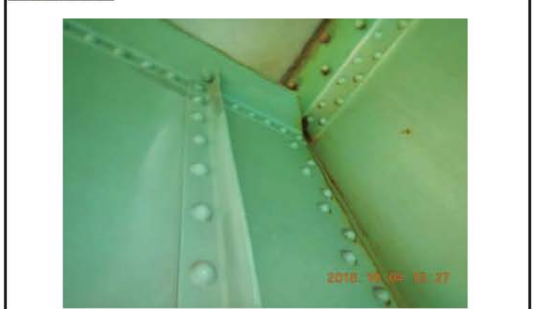
Photo nord aval
