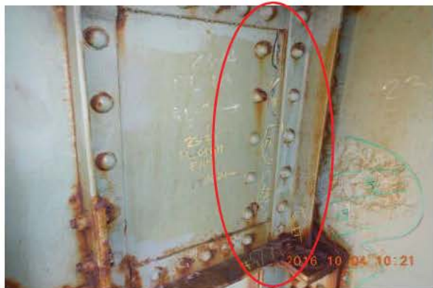
Photo sud amont
