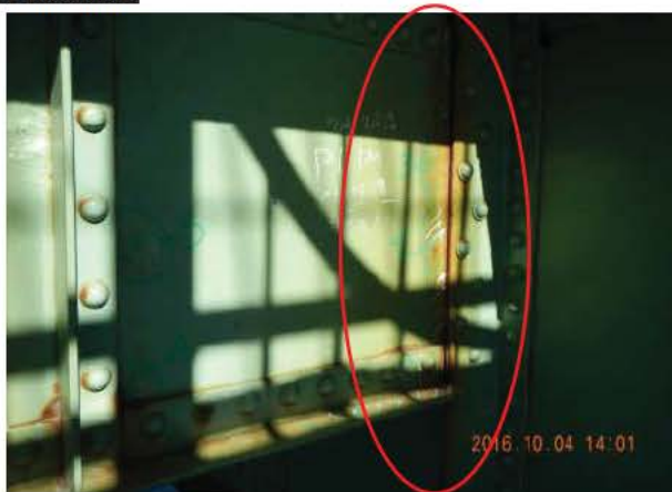
Photo sud amont
