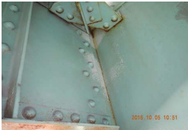
Photo sud amont
