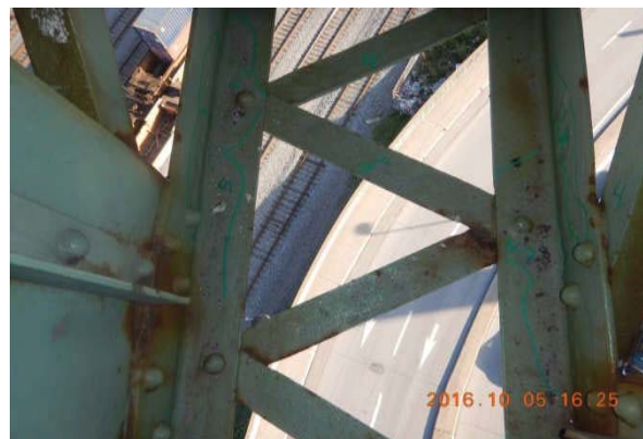
Photo des cornières inférieures
