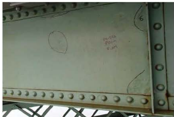
Photo nord aval
