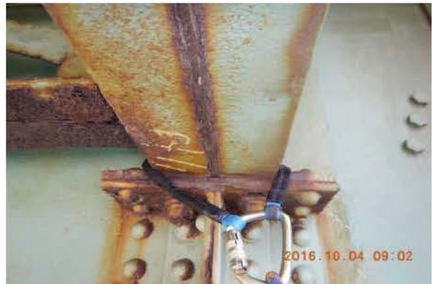
Photo sud dessous
