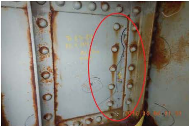
Photo sud amont
