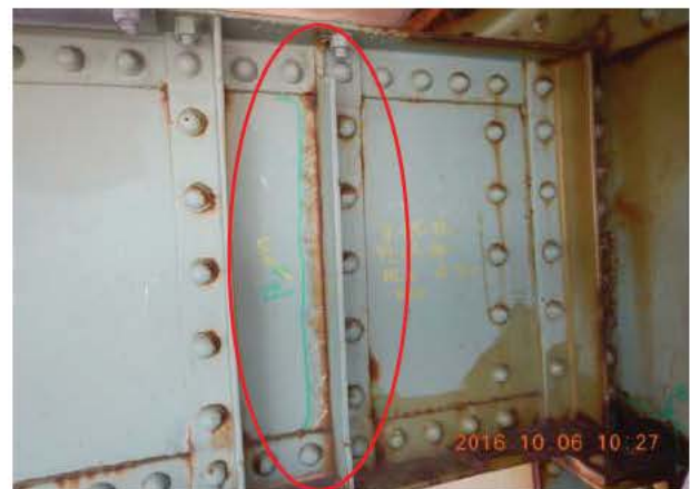
Photo nord aval
