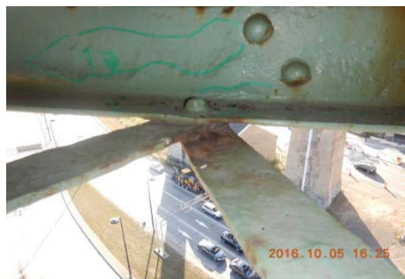
Photo cornière inférieure nord
