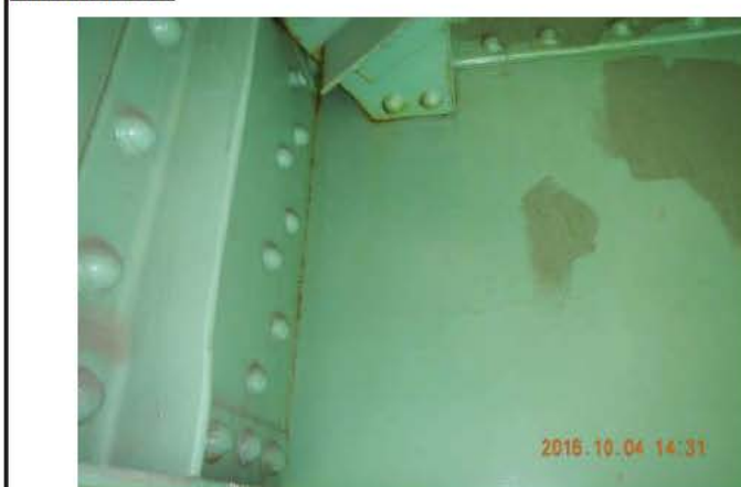
Photo nord aval
