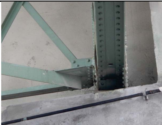
Photo 1: Assemblage L4, ferme Sud JC_5_20160126_JM_8551
