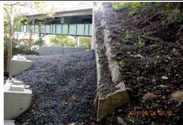
Photo 2: Extrémité du mur
