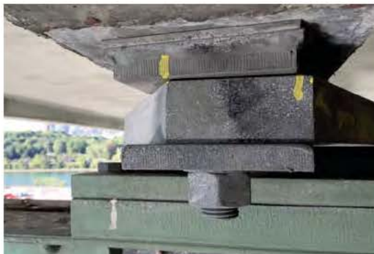
Photo 1: Appareil d'appui à platine JC_4_160916_EM_3178
