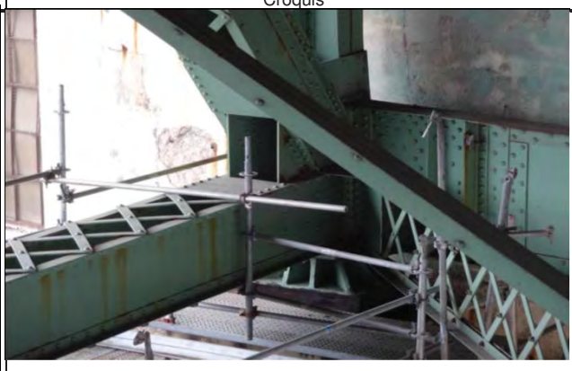
Photo 2: Élément inaccessible JC_4_20151210_3615
