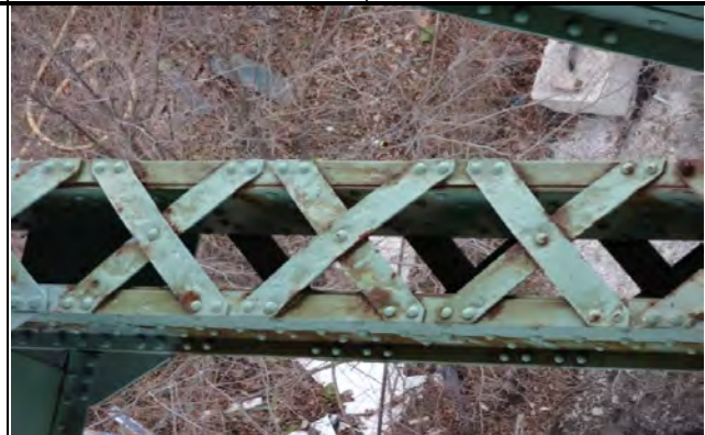
Photo 2: Corde inférieure JC_4_20151209_3321
