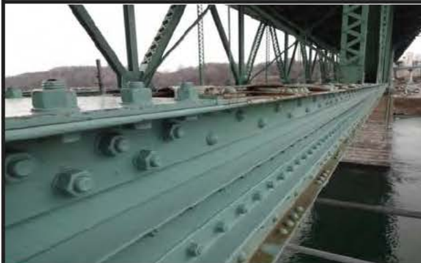
Photo 1: Corde inférieure JC_4_20151209_3401
