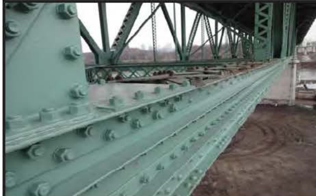
Photo 1: Corde inférieure JC_4_20151209_3343
