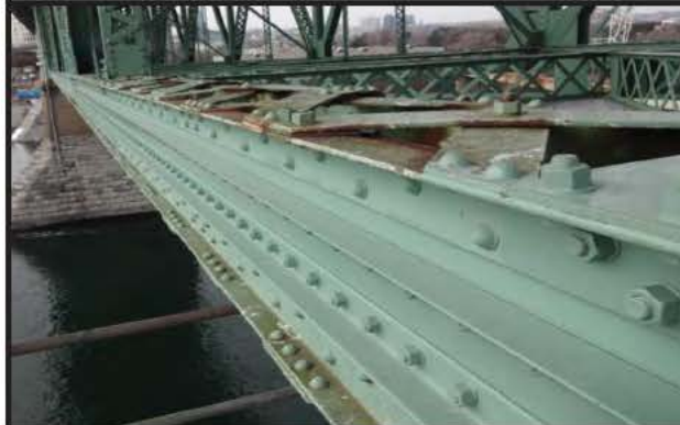
Photo 1: Corde inférieure JC_4_20151209_3407
