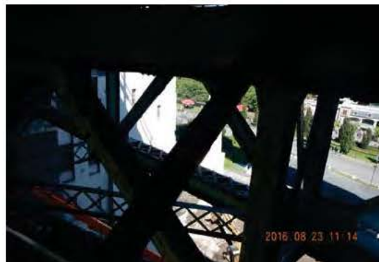
Photo 2: Corde inférieure JC_4_160823_JM_0769
