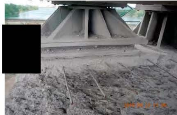
Photo 2: Appareil d'appui N-E JC_4_160822_JM_0576
