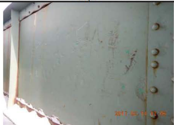
Photo 2: Poutre de levage L10 JC_4_170214_EM_7449
