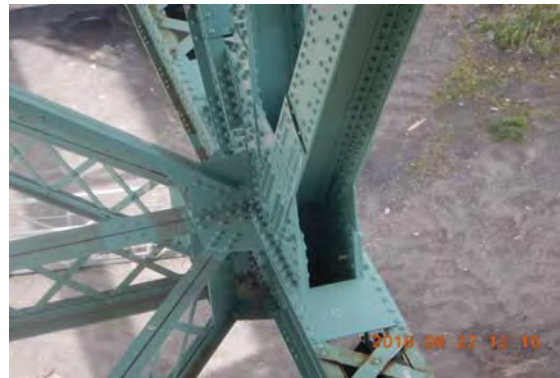
Photo 2: Assemblage inférieur JC_4_160822_EM_9006
