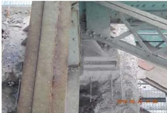
Photo 1: Appareil. d'appui N-O JC_4_160822_JM_0575
