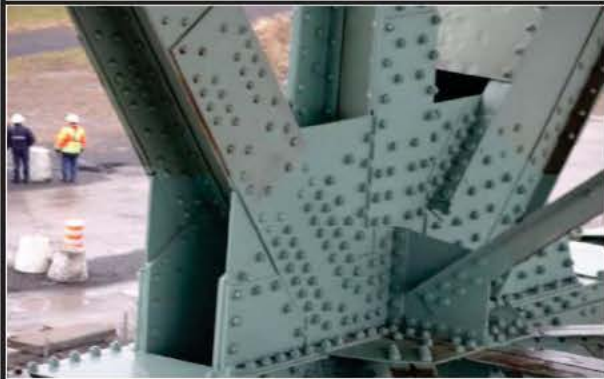
Photo 1: Assemblage inférieur JC_4_20151210_3508
