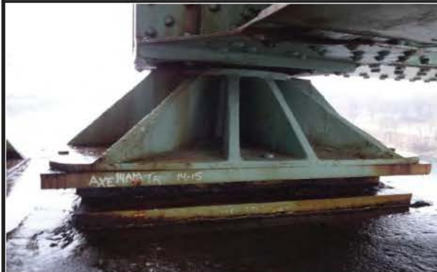
Photo 1: Appareil d'appui JC_4_20151210_MF_3464
