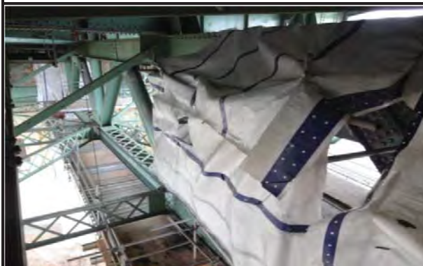
Photo 1: Travaux en cours JC_4_20151210_3606
