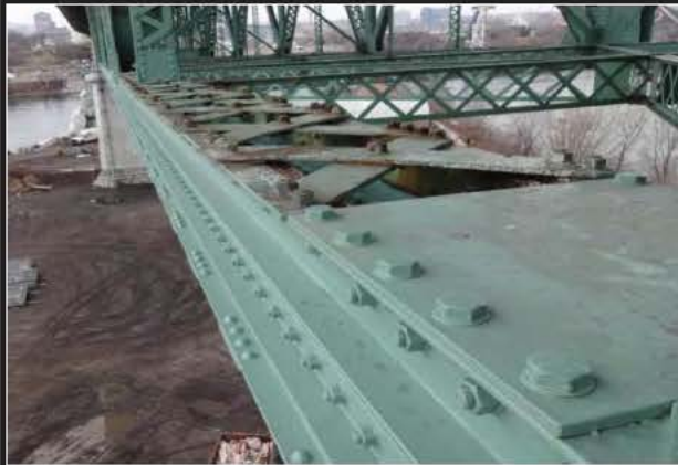
Photo 1: Corde inférieure JC_4_20151209_3340
