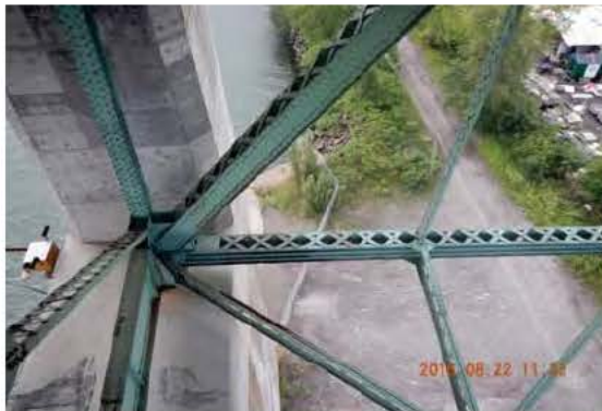
Photo 1: Corde inférieure L0-L2 JC_4_160822_JM_0495
