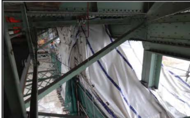
Photo 1: Travaux en cours JC_4_20151210_3594
