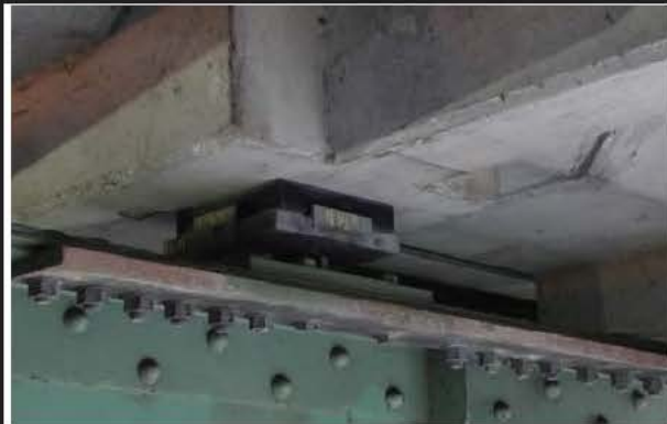
Photo 1: Appareil d'appui à platine JC_4_20151209_3311
