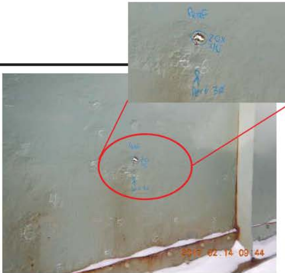
Photo 1: Poutre de levage L0 JC_4_170214_EM_7379
