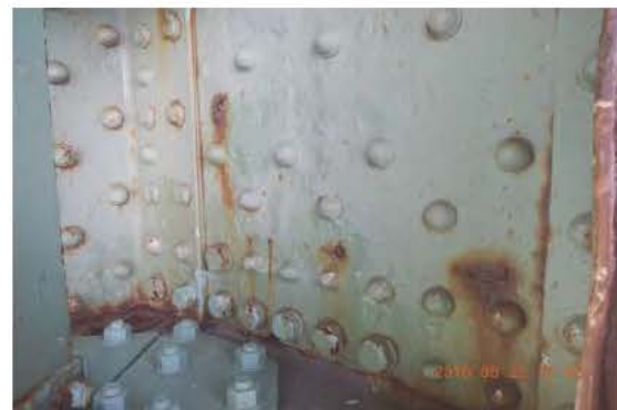
Photo 2: Poutre de levage 1
