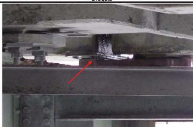
Photo 2: Infiltration d'eau
