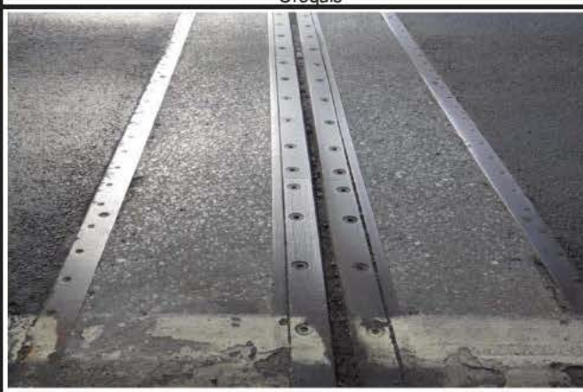
Photo 1: Joint de dilatation voie 1 JC_2_20151126_MF_9261
