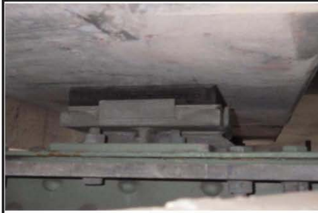
Photo 1: App. appui à platine JC 2 20151127 MF 9357
