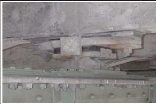
Photo 2: App. appui à platine JC 2 20151127 MF 9358
