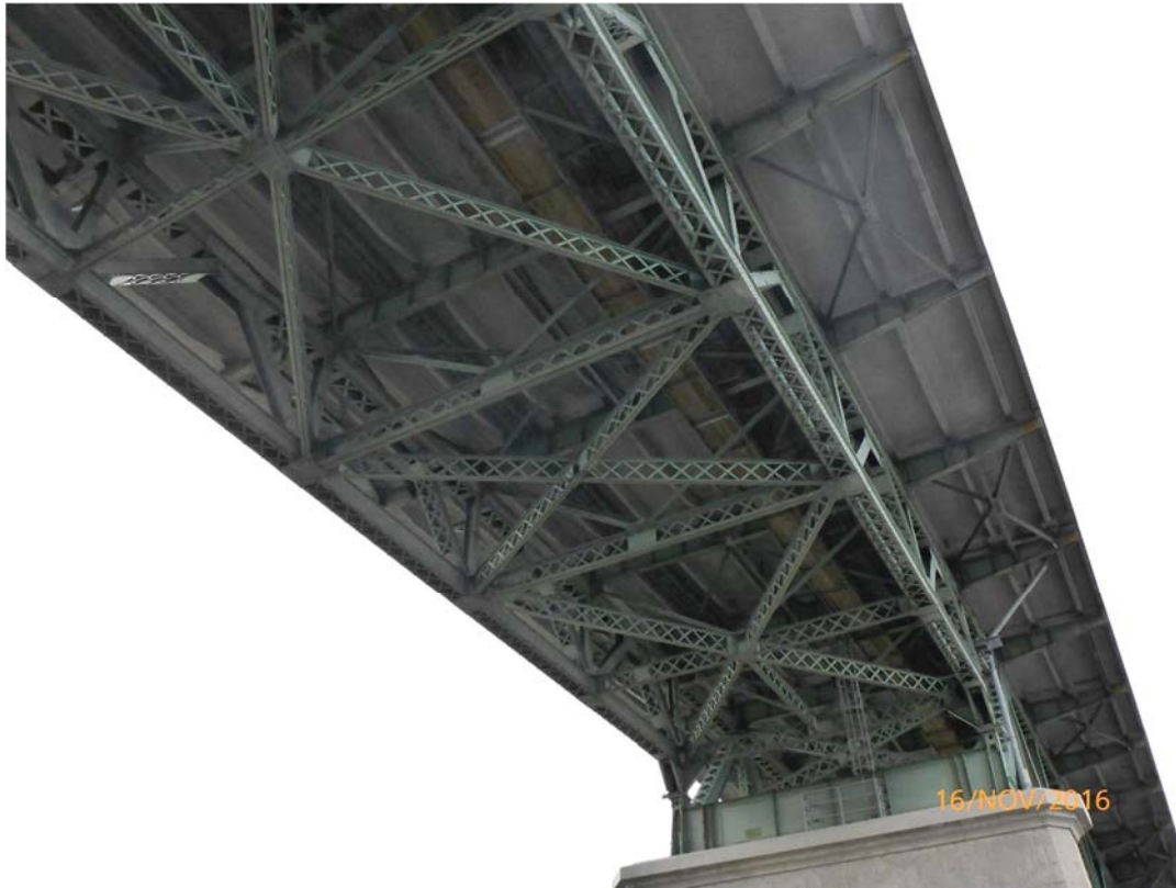
Photo 2 : Vue générale du dessous de tablier (travée 2-3)
