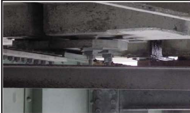
Photo 1: App. appui à platine
