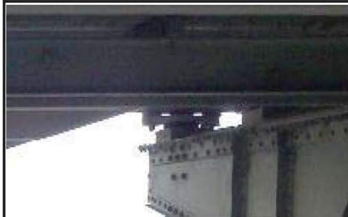
Photo 1: App. Appui à platine
