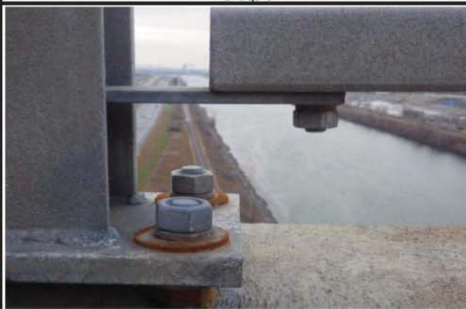
Photo 2: Dispositif de retenue
