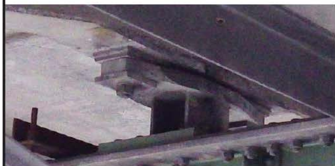
Photo 1: App. Appui à platine
