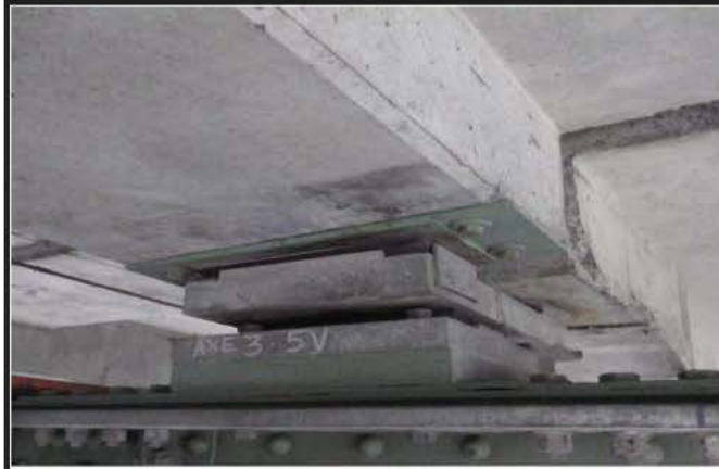
Photo 1: App. Appui à platine
