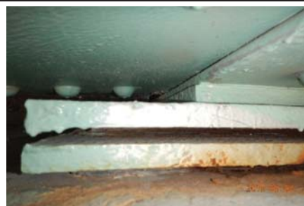
Photographie 2 - axe A poutre 3 #JC_1_150908_RE_3723
