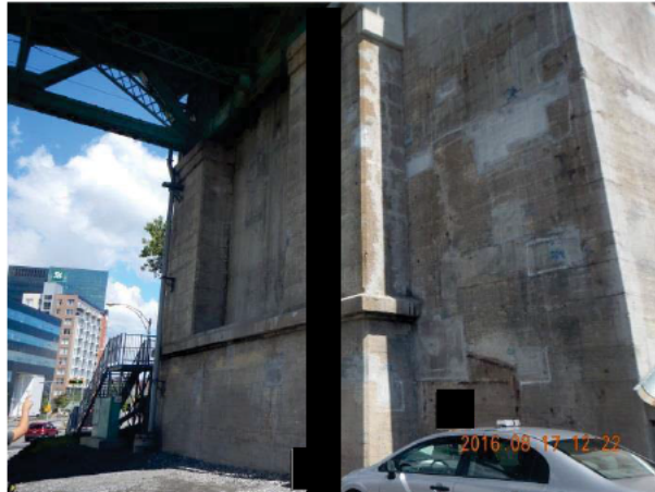
Photo 1 – Vue générale – axe 0, côté nord
