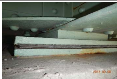
Photographie 1 - axe A poutre 4 #JC_1_150908_RE_3720
