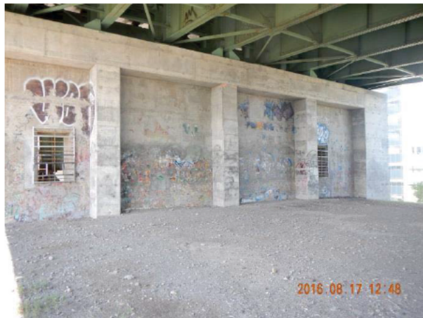
Photo 2 – Vue générale – axe 0, côté sud
