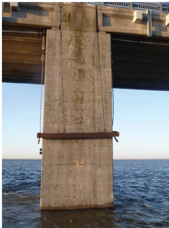
Figure 10 : Paroi aval / Pile 13 (ES13-AV)
