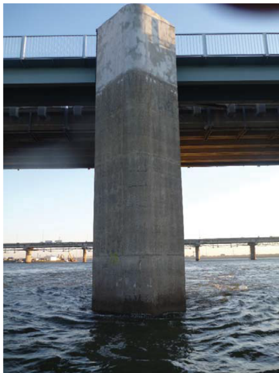
Figure 8 : Paroi amont / Pile 13 (ES13-AM)
