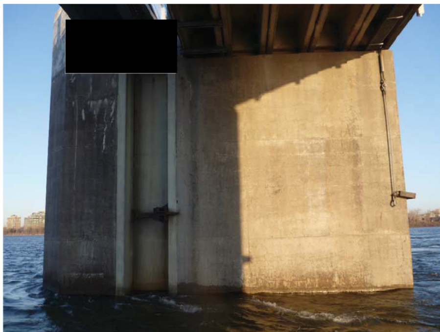
Figure 11 : Paroi droite / Pile 13 (ES13-PD)
