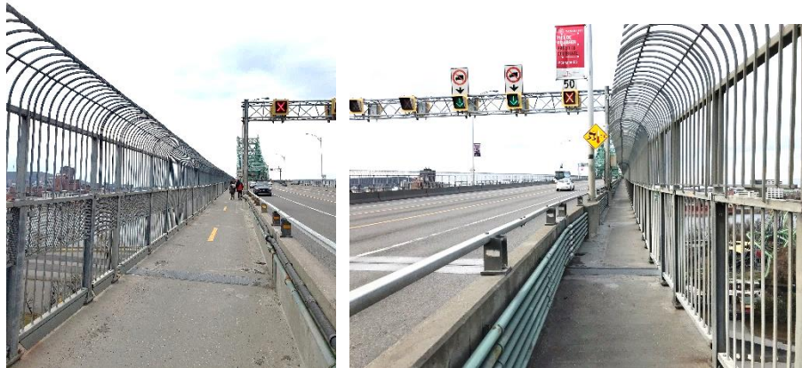
Figure 3 : Vue générale de la piste multifonctionnelle et du trottoir
