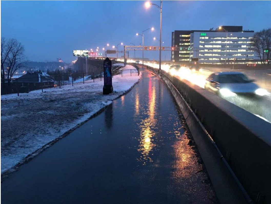
Figure 20 : Flaque d'eau à la section 1 du pont
