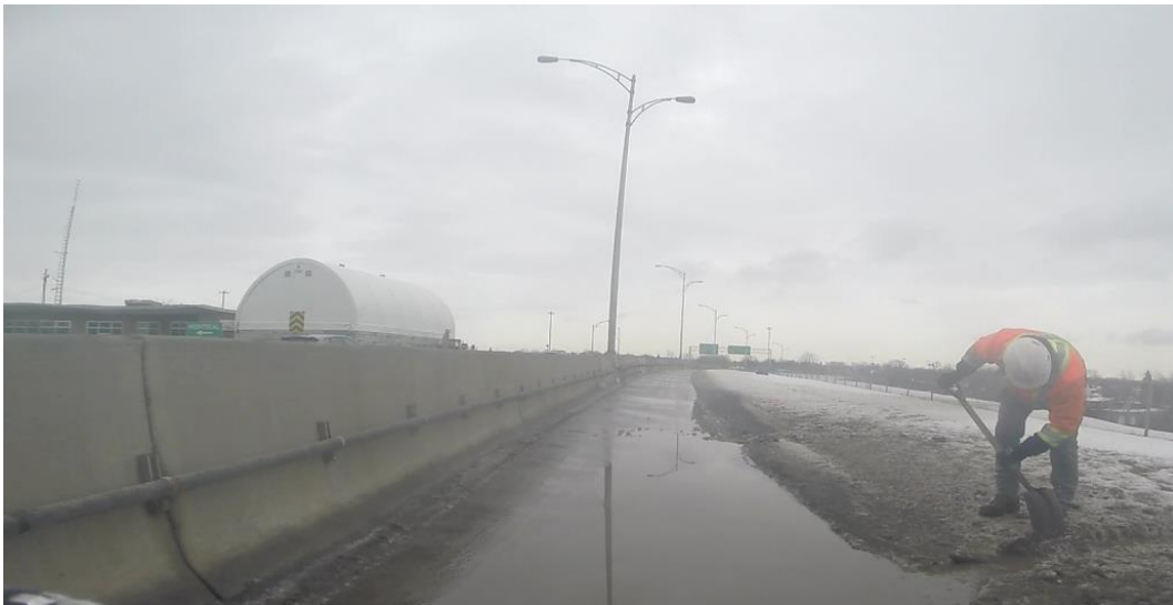
Figure 21 : Un ouvrier crée un chemin pour évacuer l'eau de la piste
