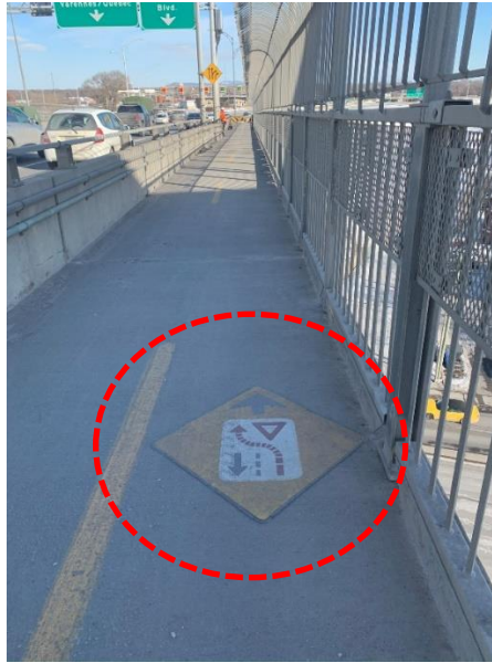
Figure 3 : marquage de signalisation avancé de danger de cédez le passage à la chicane (Source : Arup, 2020-01-05)
