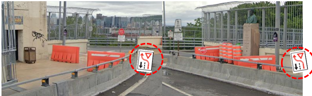
Chicanes installées en été (source : Google Streetview, Juin 2019)
