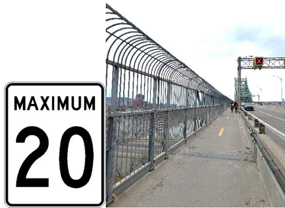
Figure 39 : Ajout de panneau de signalisation 20 km/h
